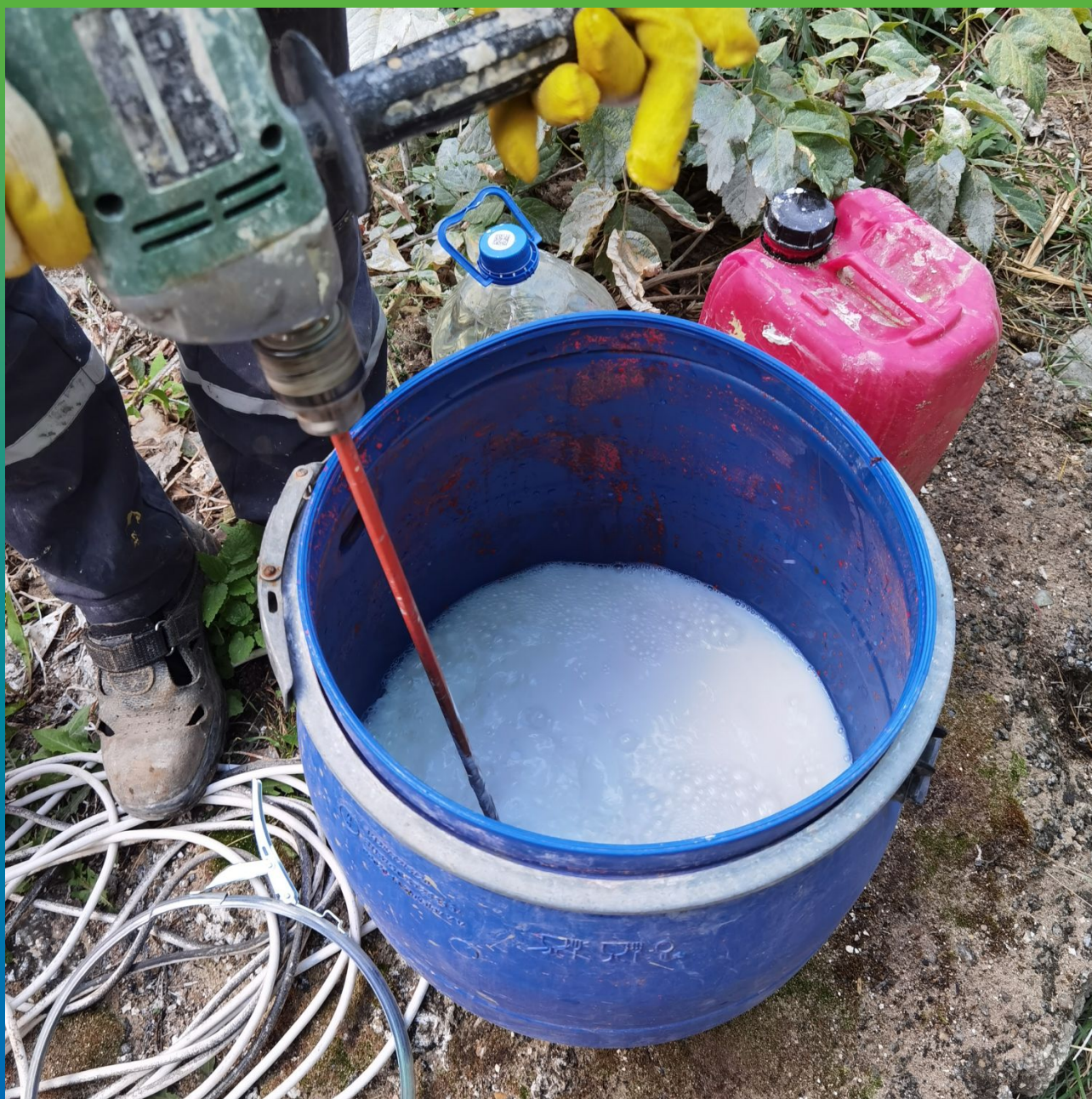
Эмульсия Маноксан 150 в пропорции 1 к 15 с водой
