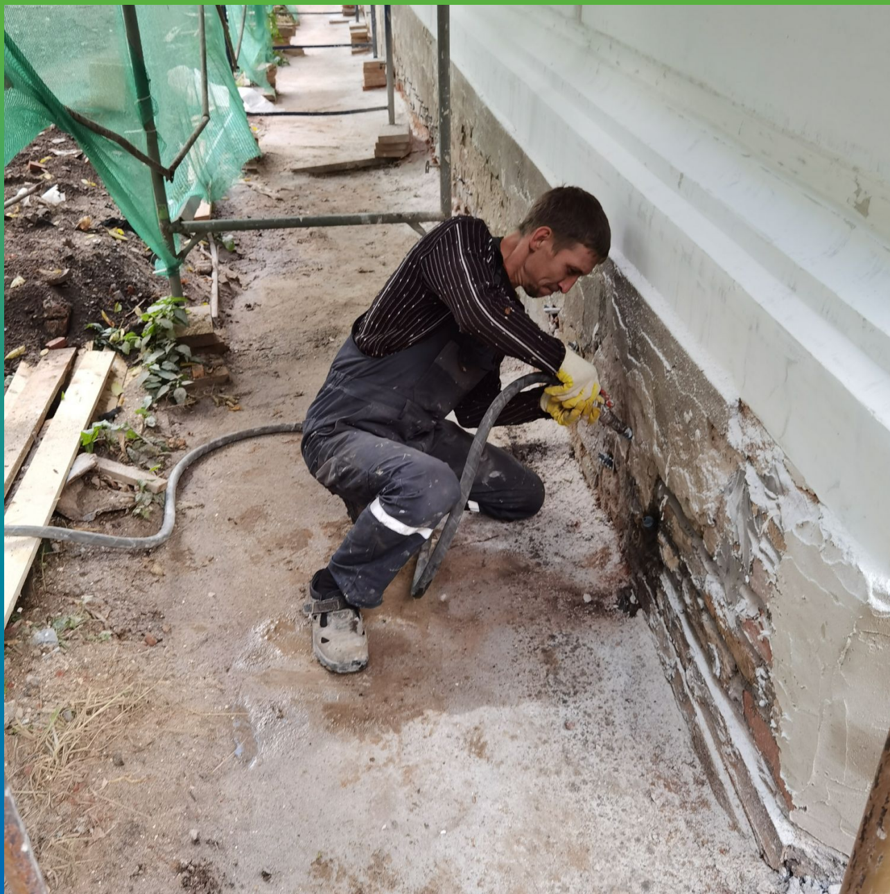
Инъектирование в конструкцию эмульсии Маноксан 150
