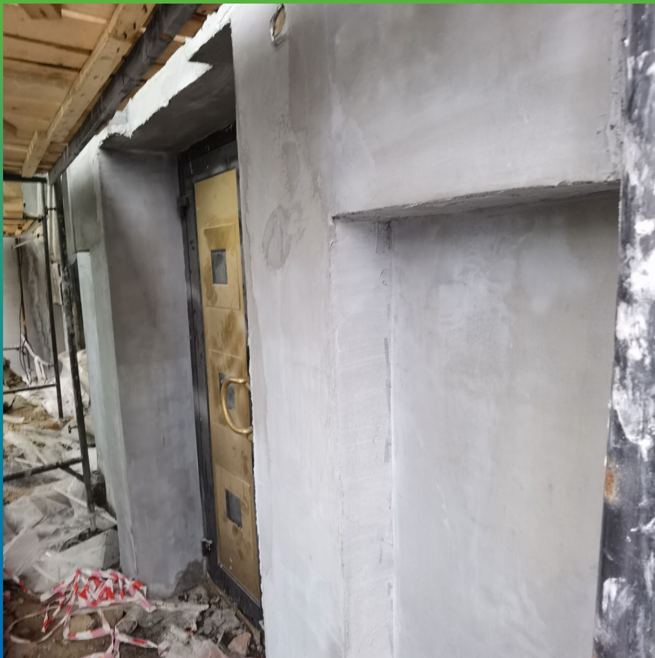
Нанесение Стармекс РМ2
