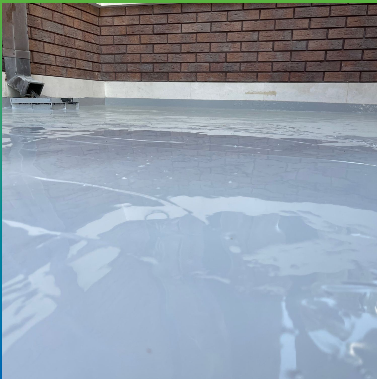
Вид нанесенного первого слоя ДенТоп МС 351 2-ой зоны
