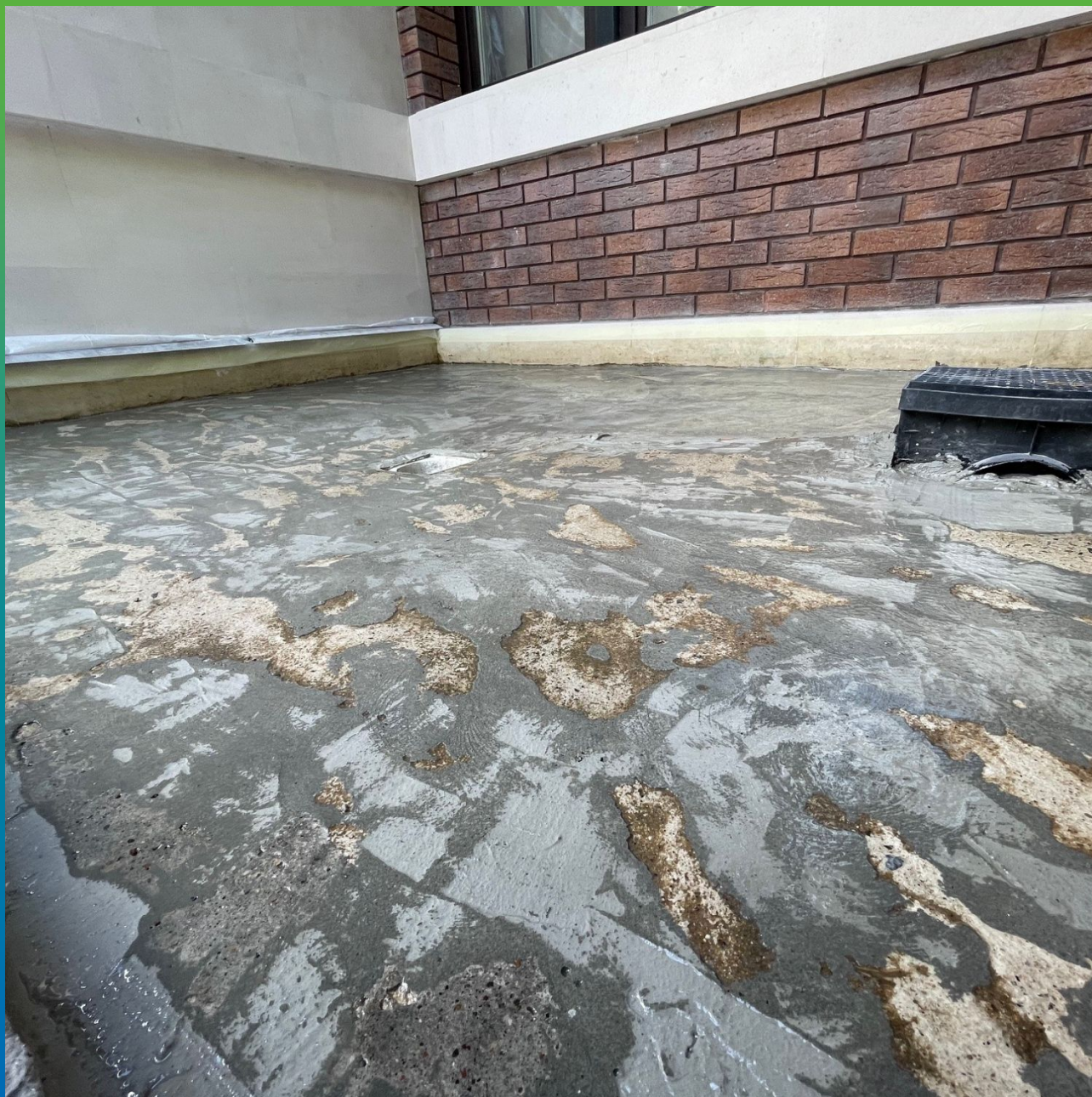
Вид нанесенного грунта 1-ой зоны
