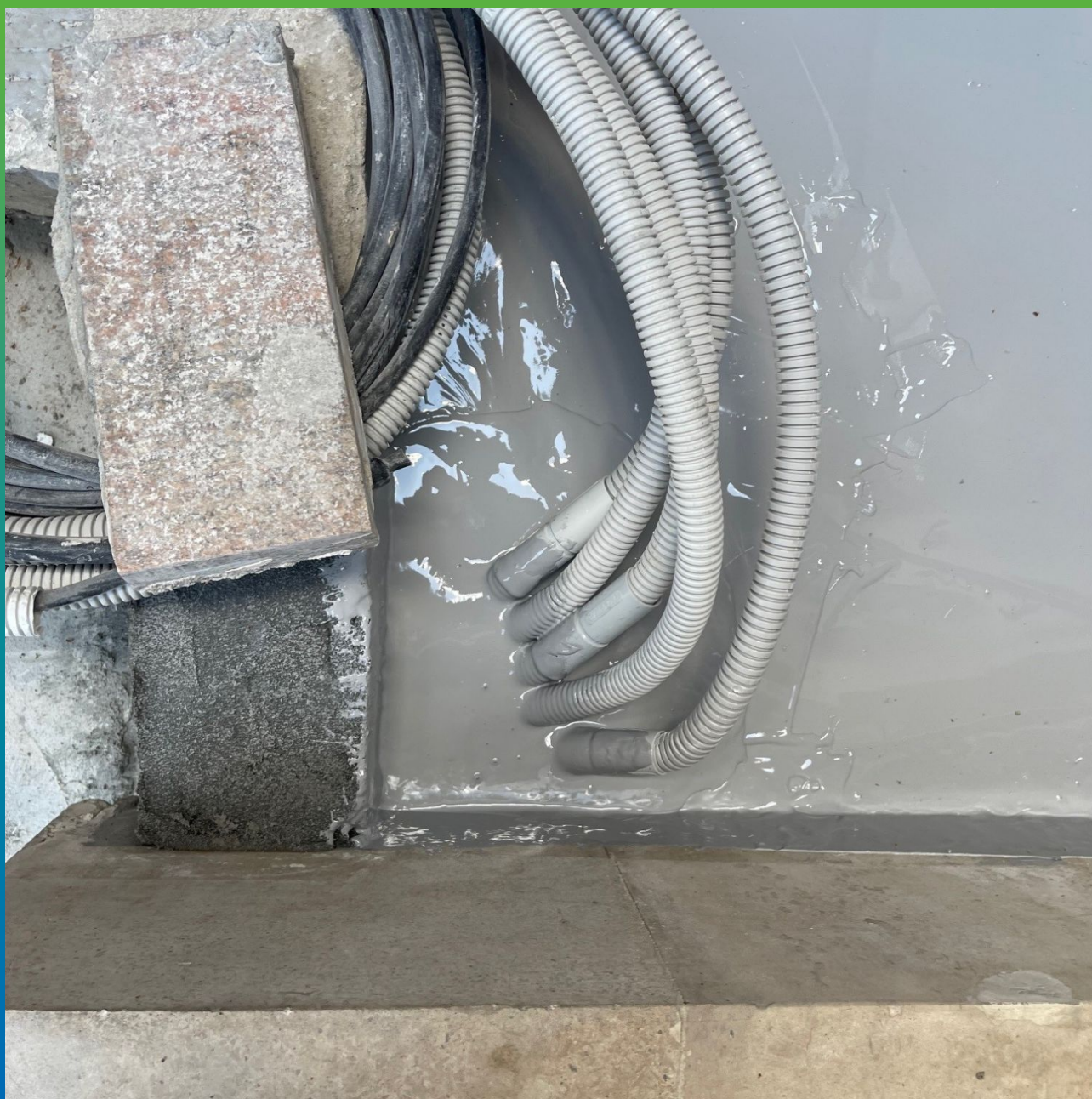
Вид устройства гидроизоляции ДенТоп МС 351 вводов коммуникаций
