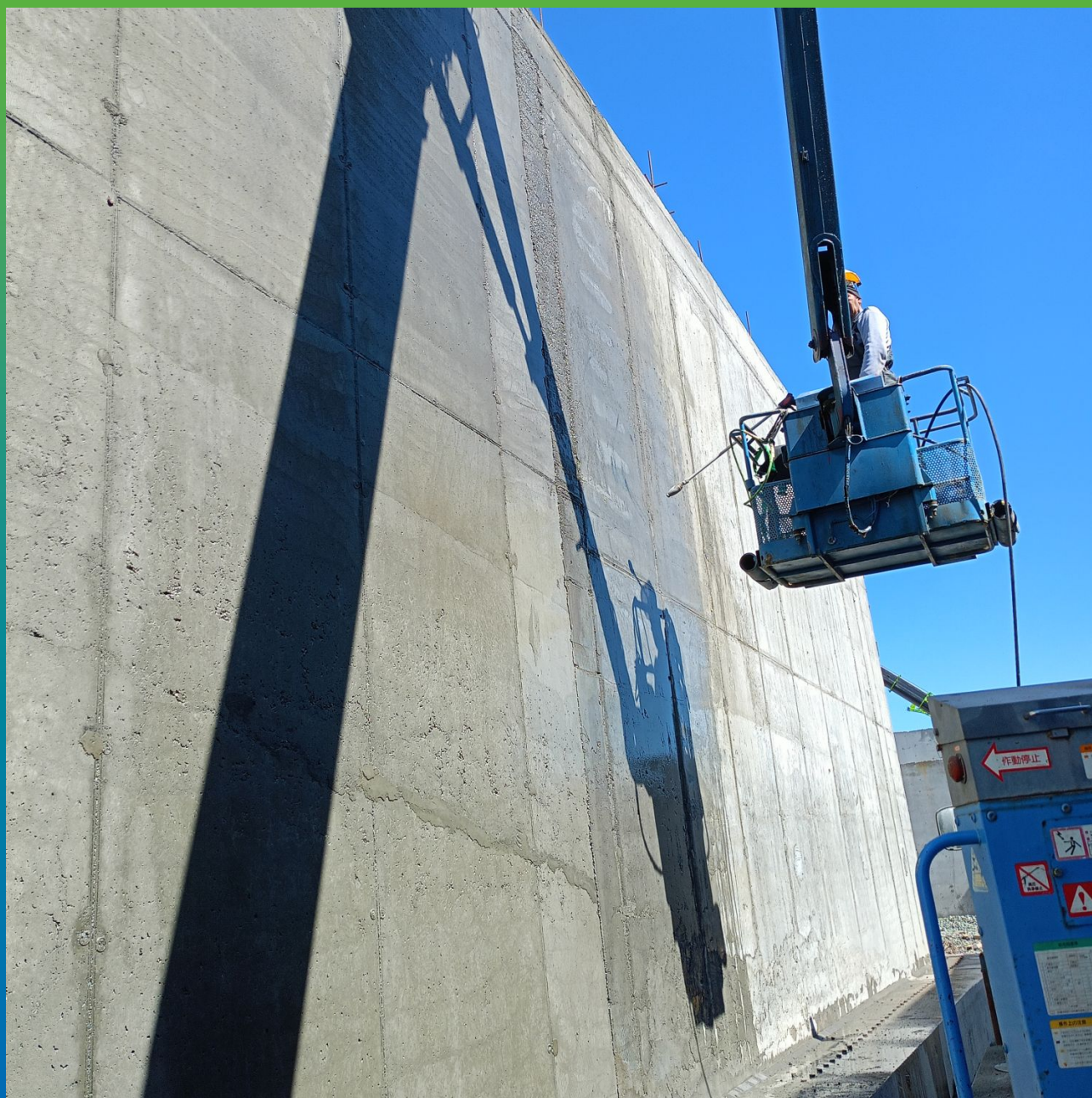
Подготовка основания, гидроструйная очистка
