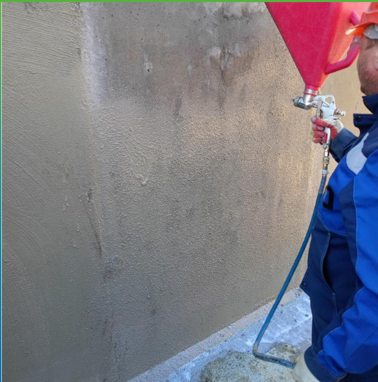
Механическое нанесение 1 слоя
