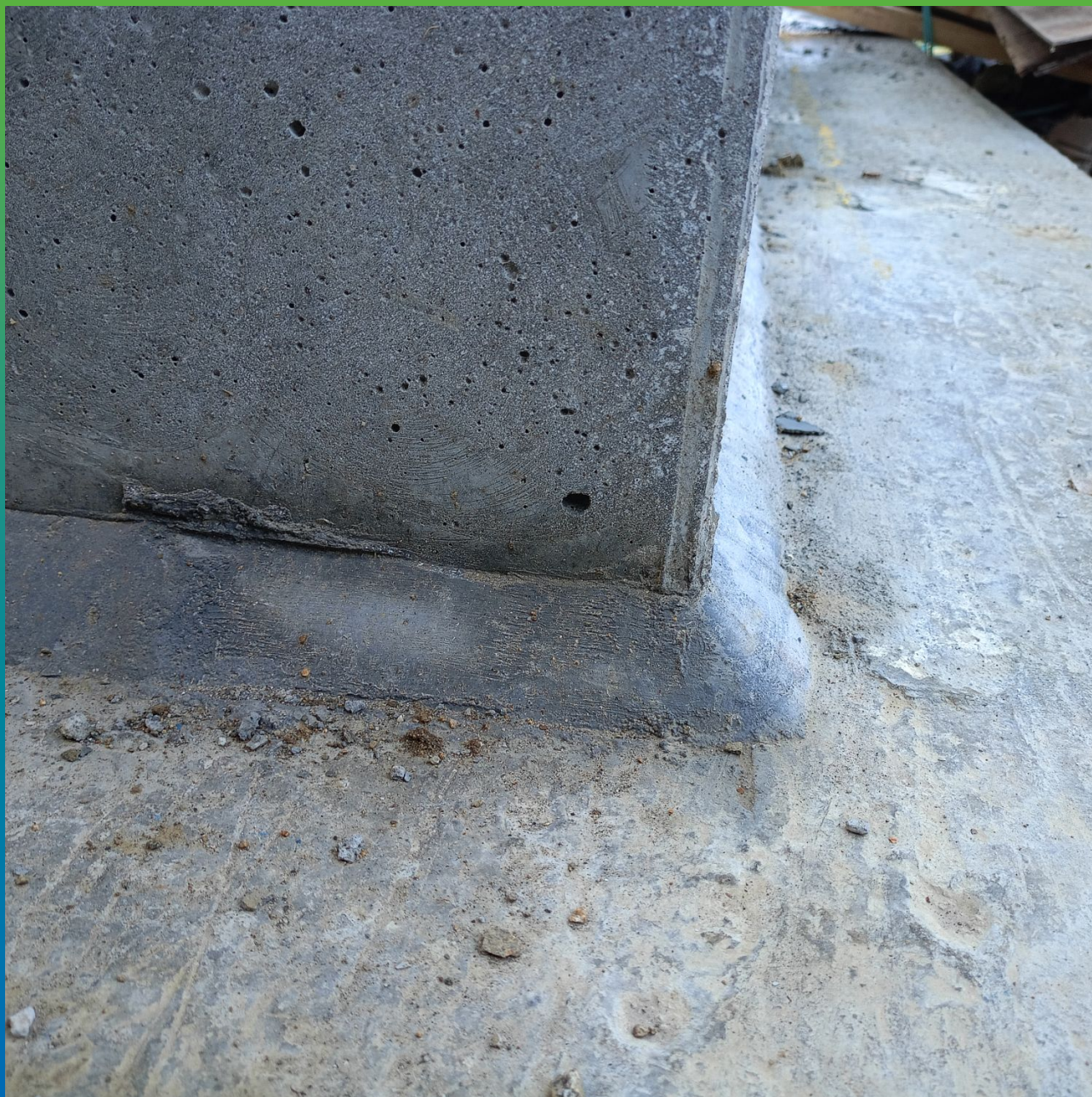
Внешний вид галтели из ремонтного состава Стармекс РМЗ
