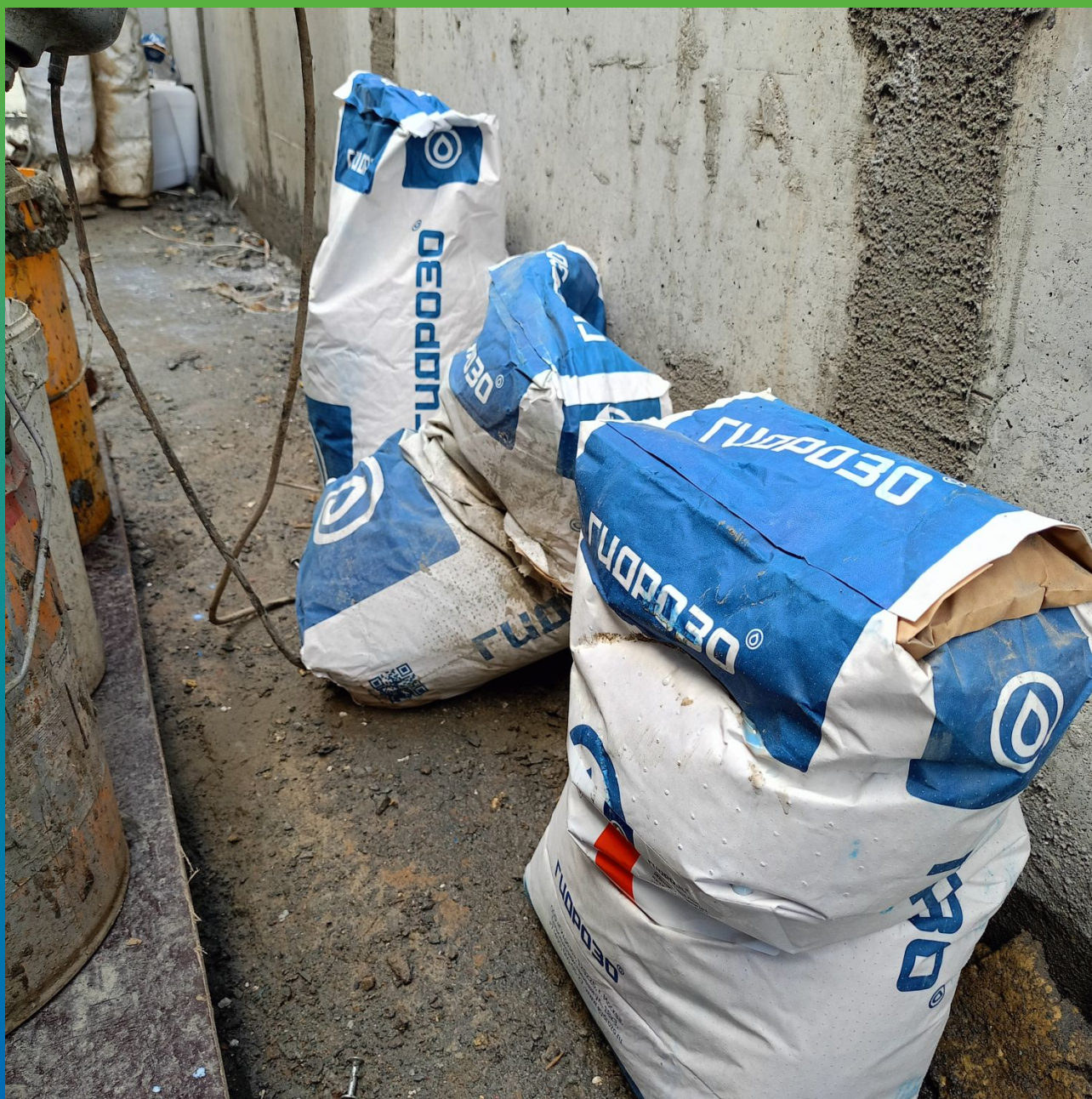
Эластичная гидроизоляция Стармекс Эласт на объекте
