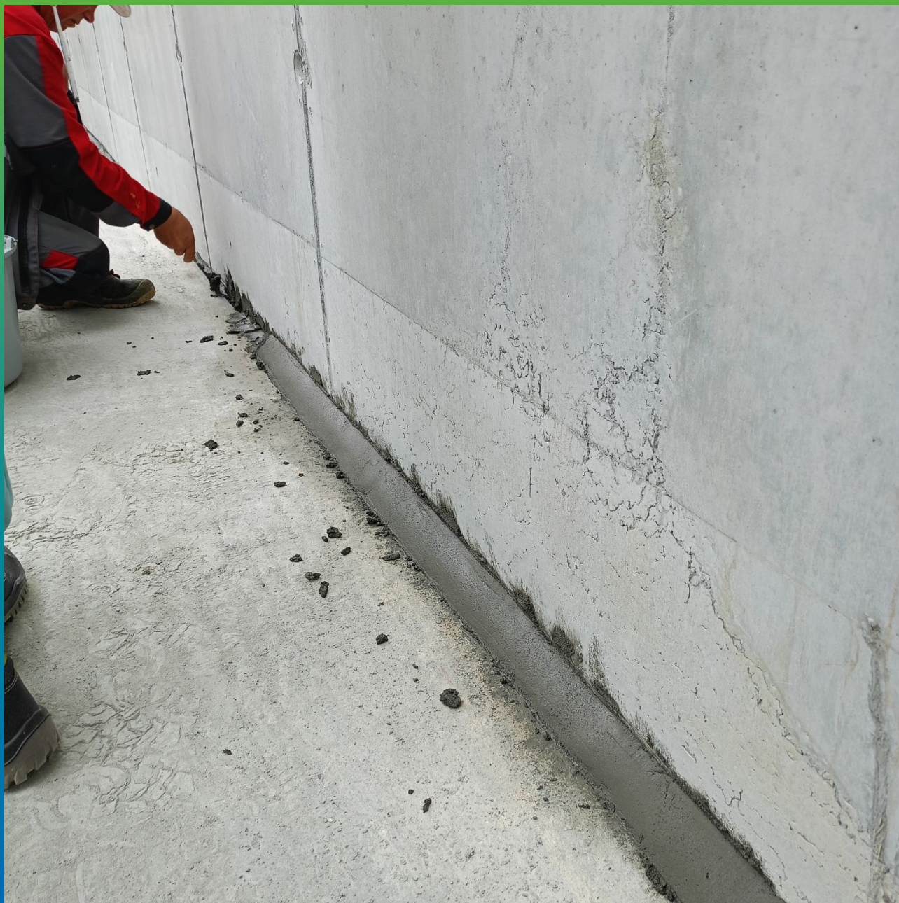
Устройство галтели по периметру резервуара, Стармекс РМЗ
