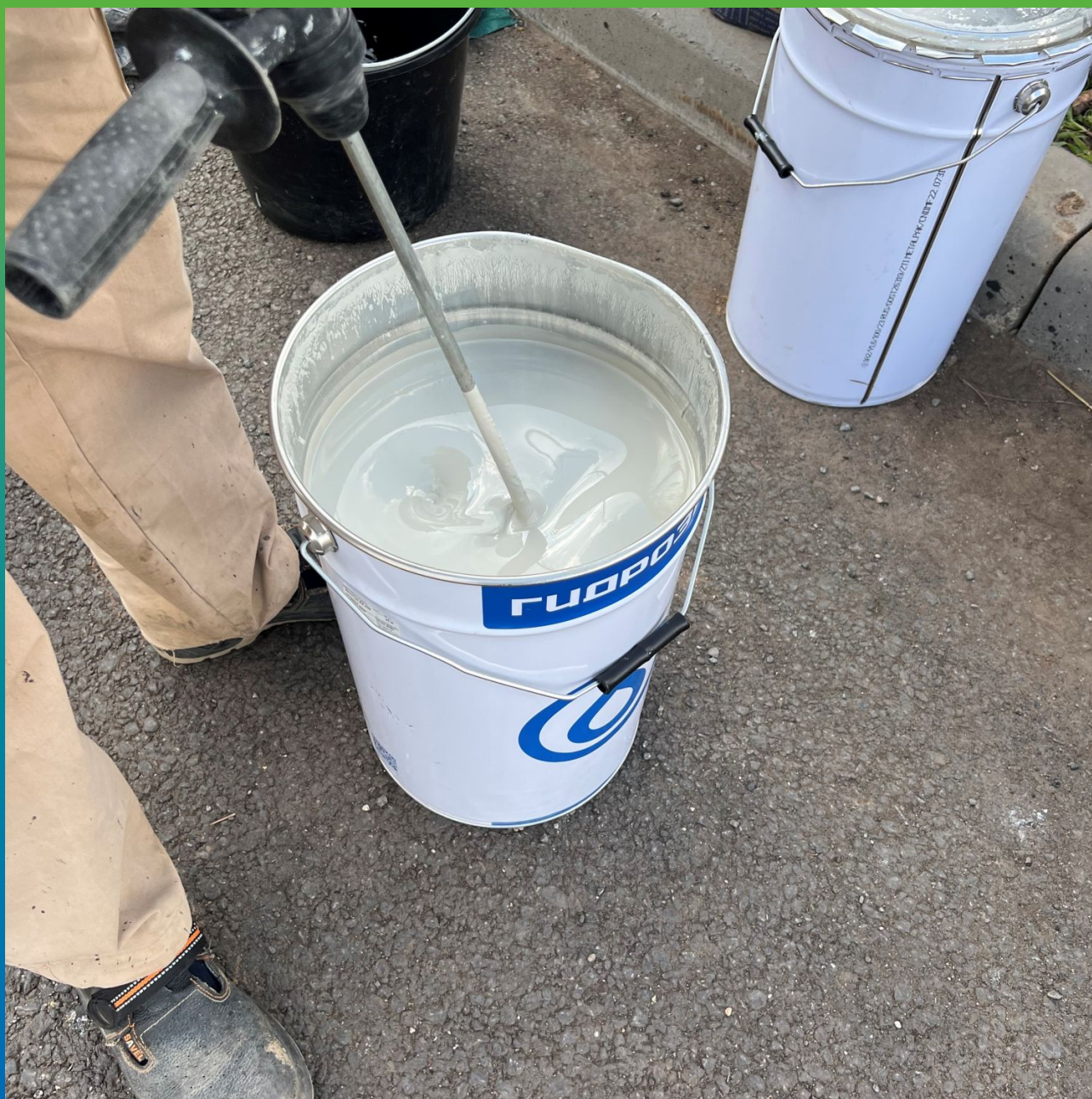
Смешивание двухкомпонентного полиуретанового состава ДенТоп ПУ 500
