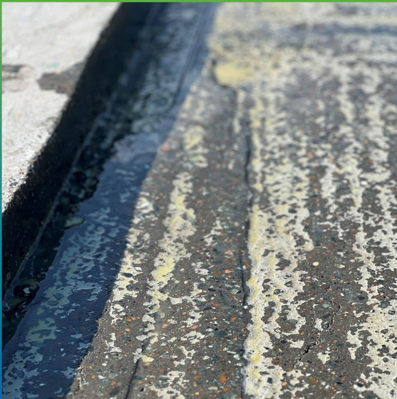
Грунтование основания под нанесение ДенсТоп ПУ 500
