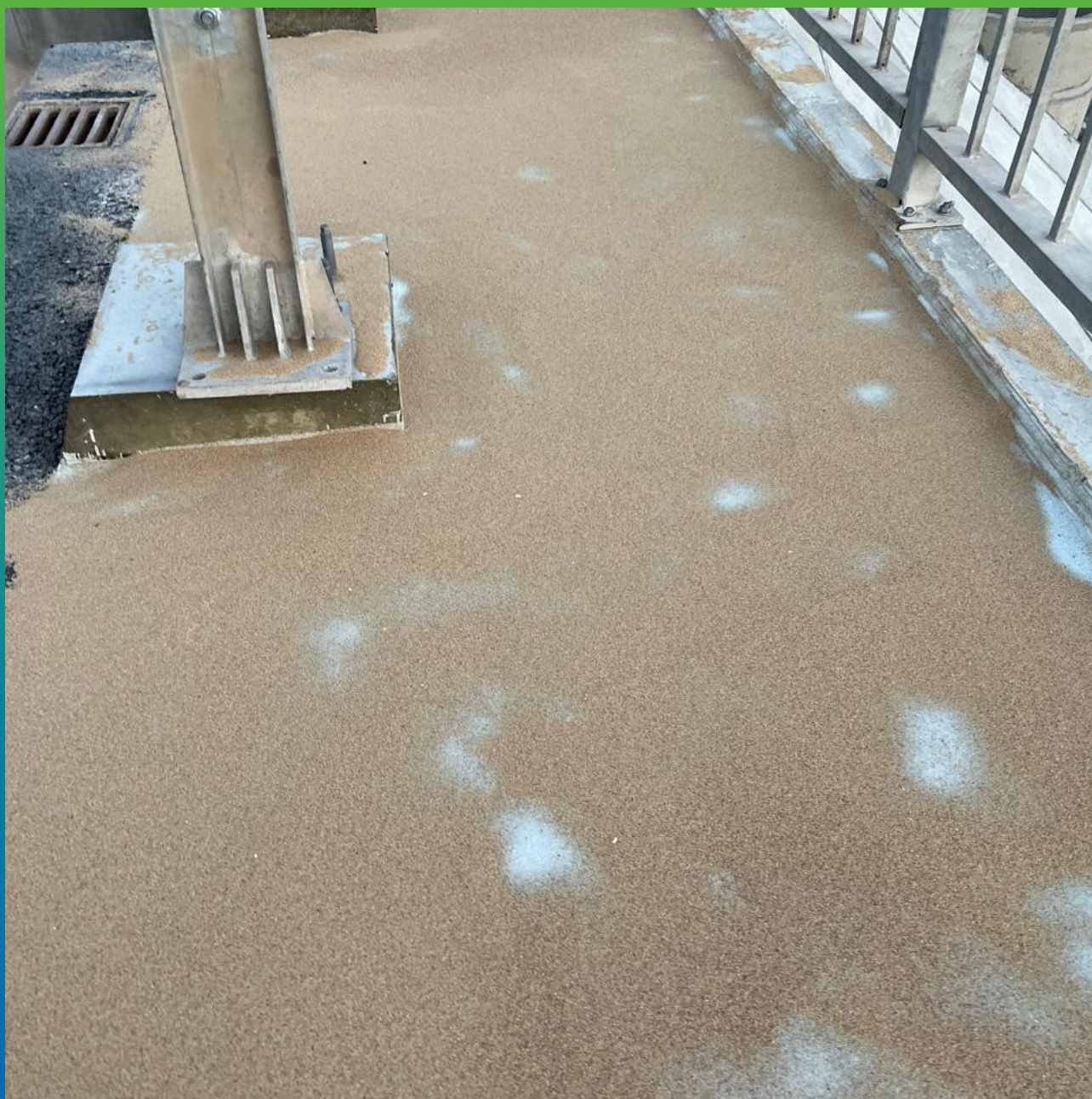
Нанесение первого слоя ДенсТоп ПУ 500 с просыпкой ДенсТоп Филлер 01 "под шубу"
