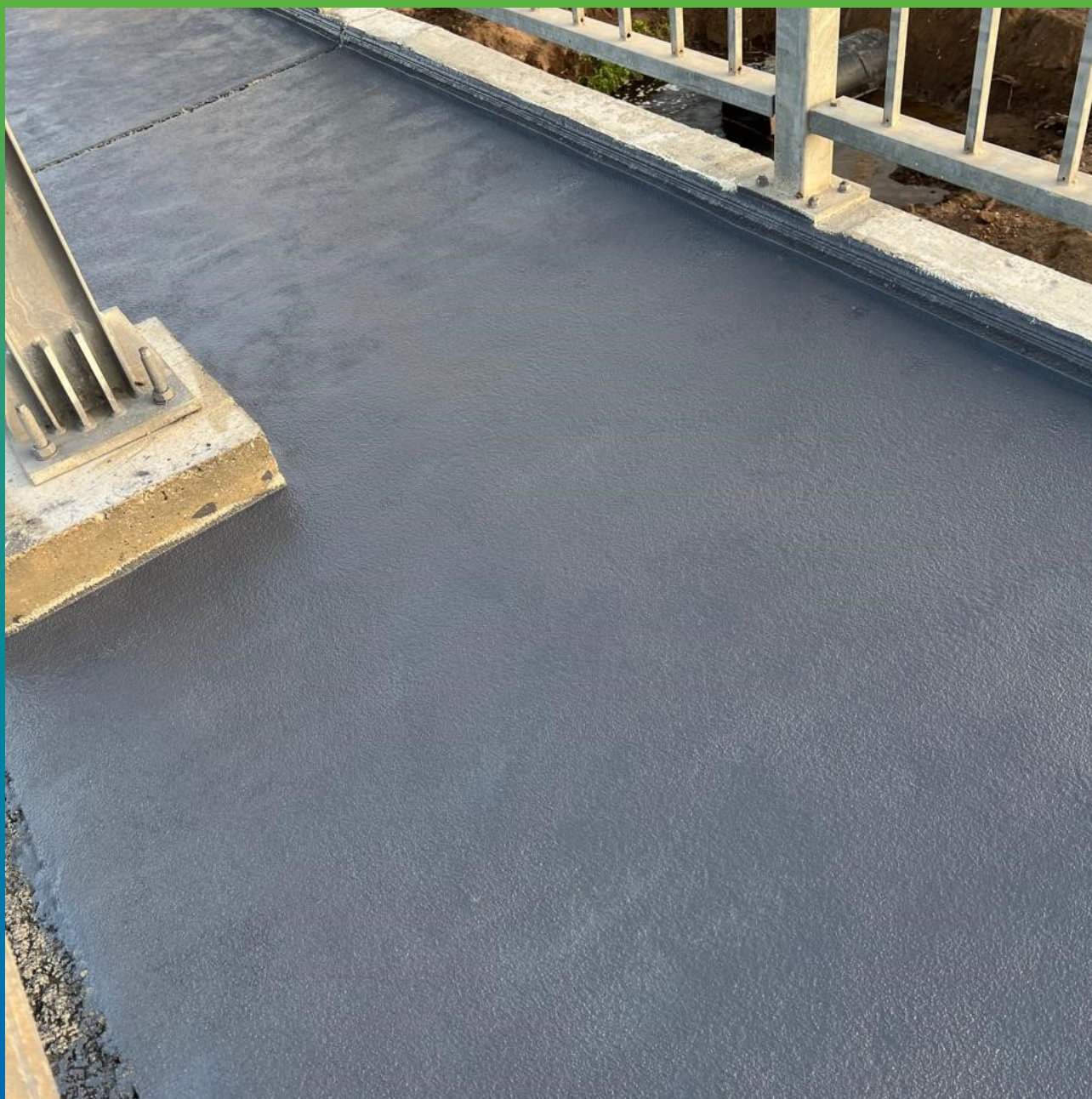
Внешний вид готового покрытия
