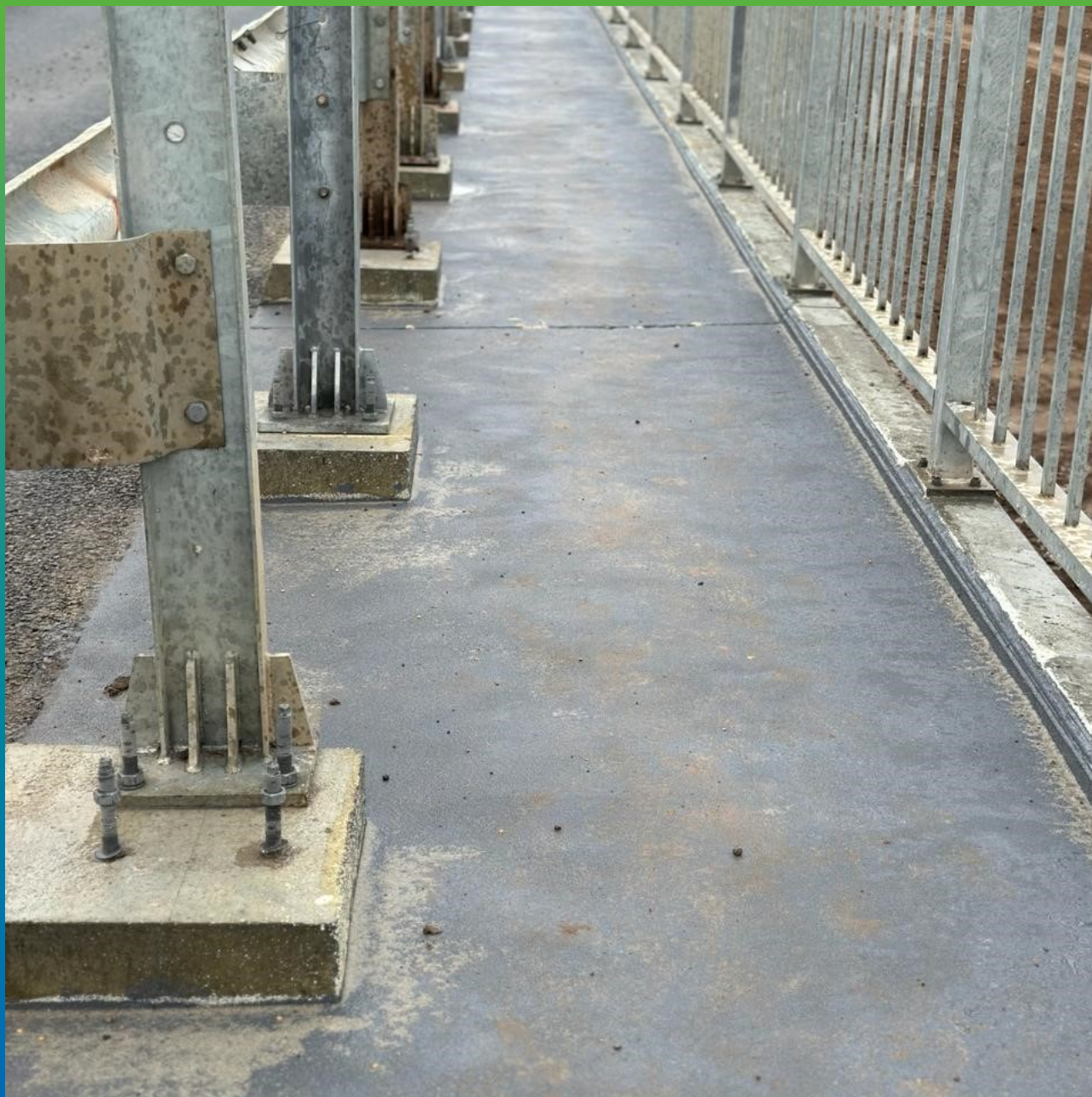
Пешеходная зона моста через год эксплуатации
