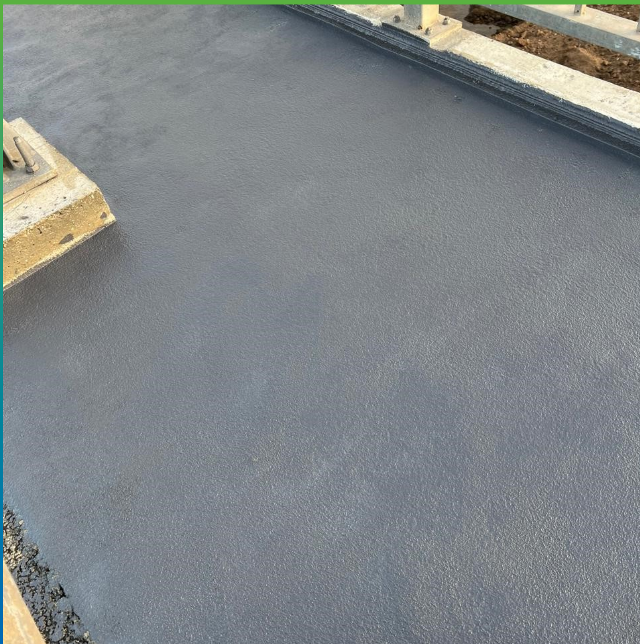
Внешний вид готового покрытия
