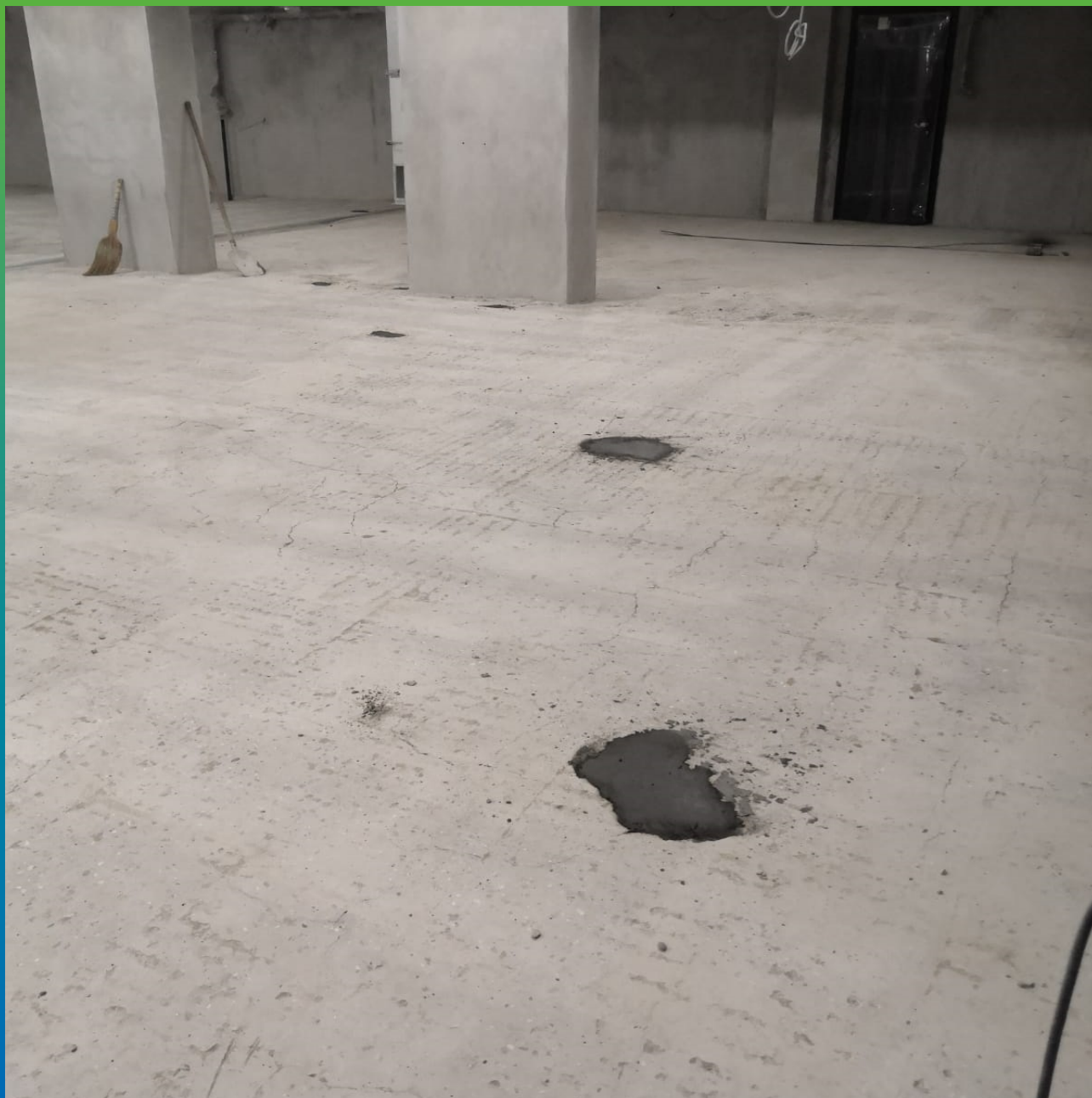
Отремонтированные дефекты пола составом Стармекс РМЗ
