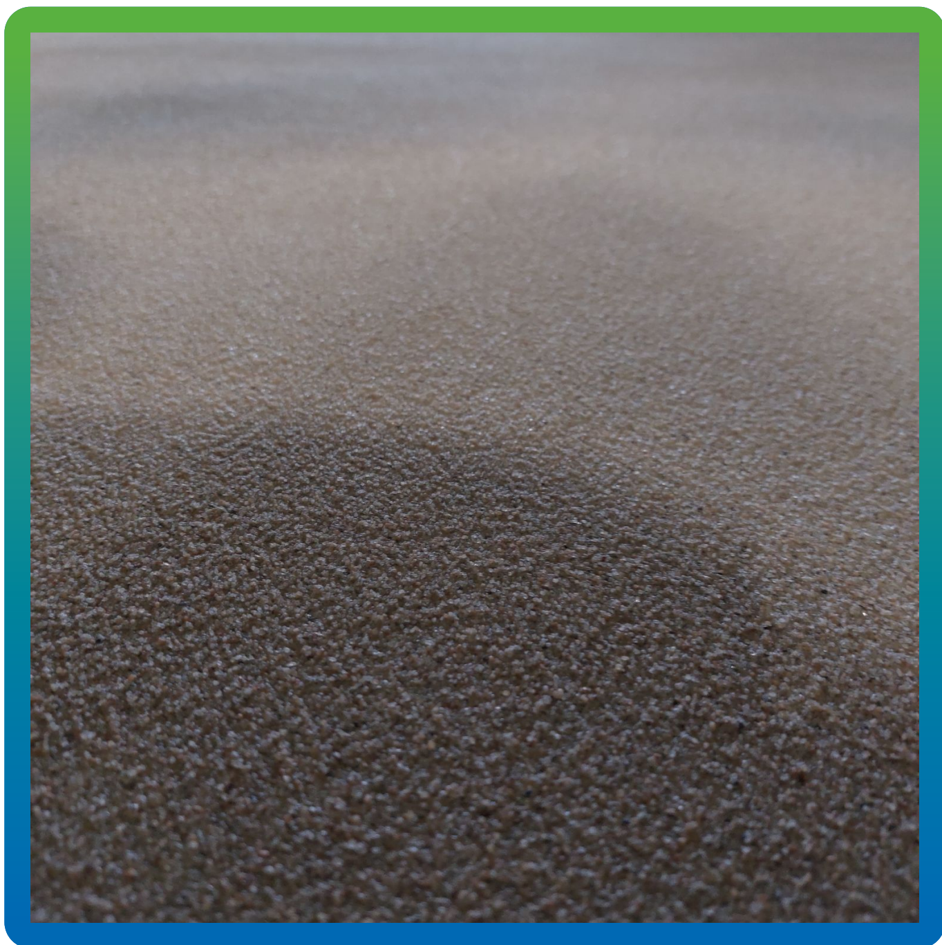
Рампа с нескользящим покрытием, состоящим из засыпки ДенсТоп Филлер 01 с последующей запечаткой ДенсТоп ЭП 501
