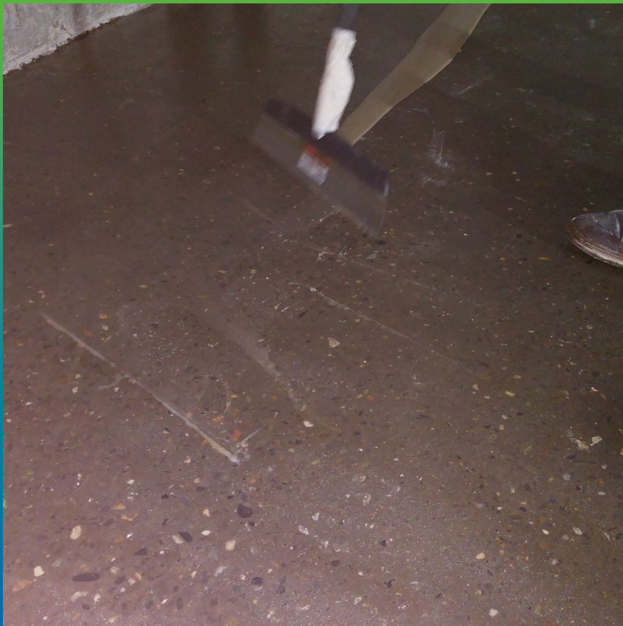
Распределение грунтовочного состава ДенсТоп ЭП 100 с песком ДенсТоп Филлер 004 на сдир шпателем
