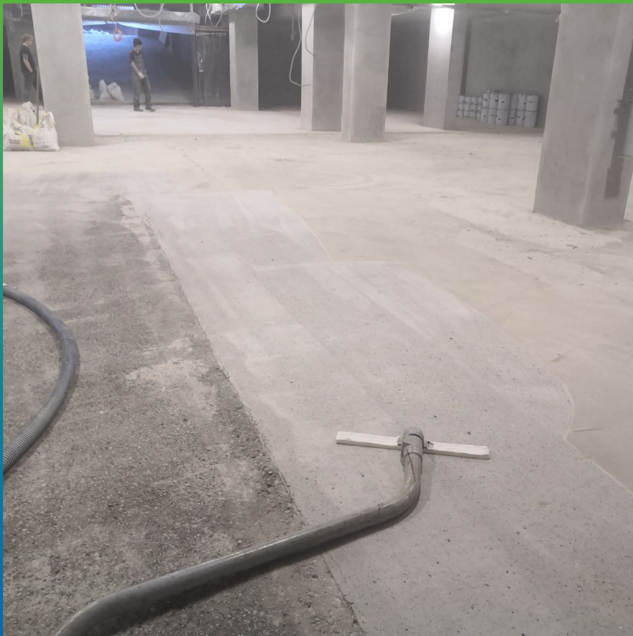
Обеспыливание промышленным пылесосом
