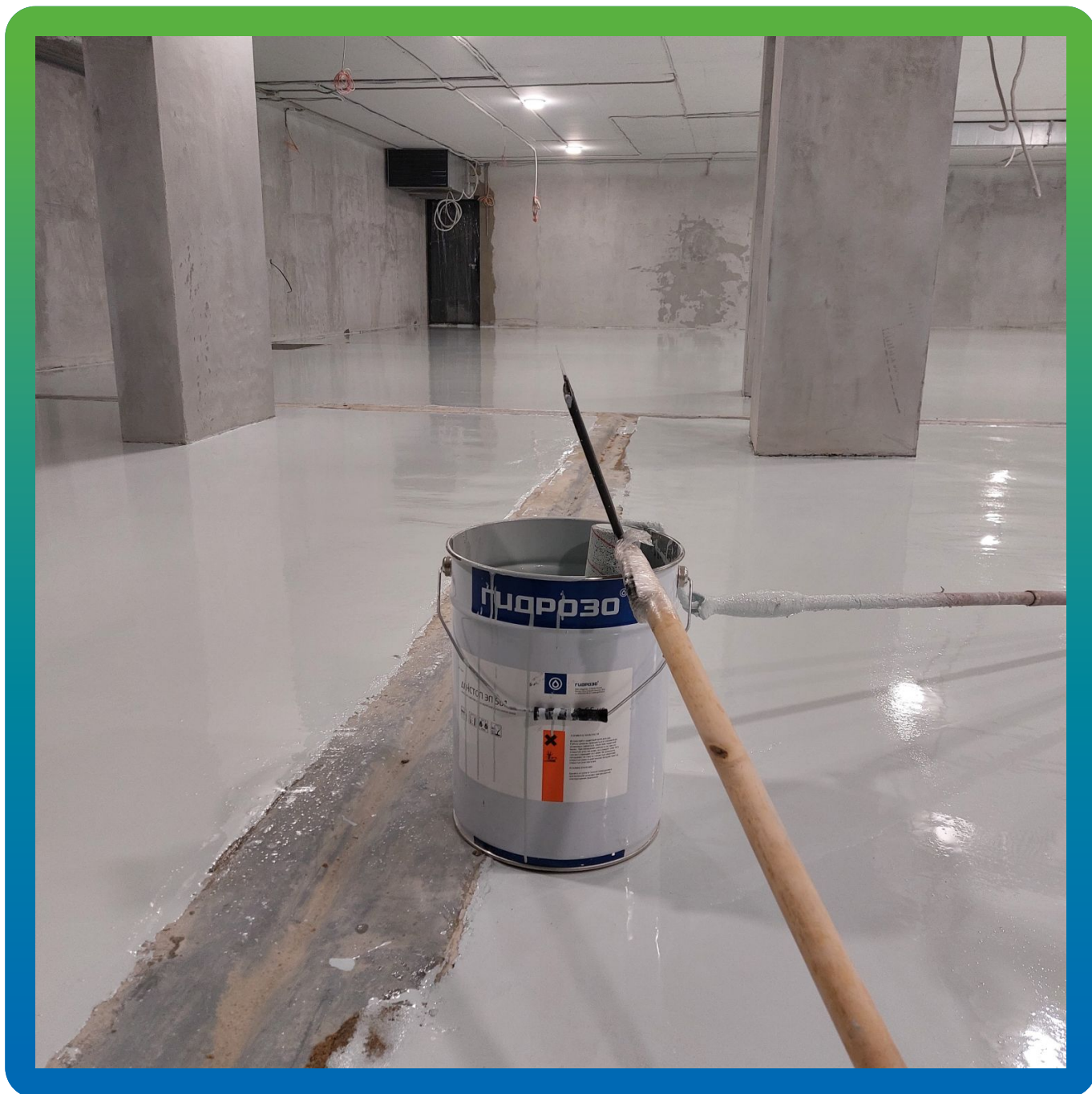
Финишный вид после нанесения эпоксидного покрытия ДенТоп ЭП 501
