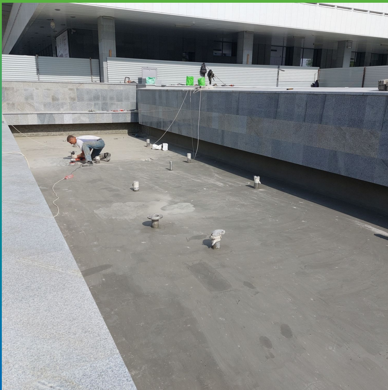
Шлифовка наплывов
