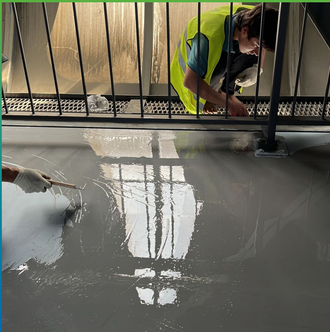
Нанесение первого слоя покрытия ДенТоп ПУ 500
