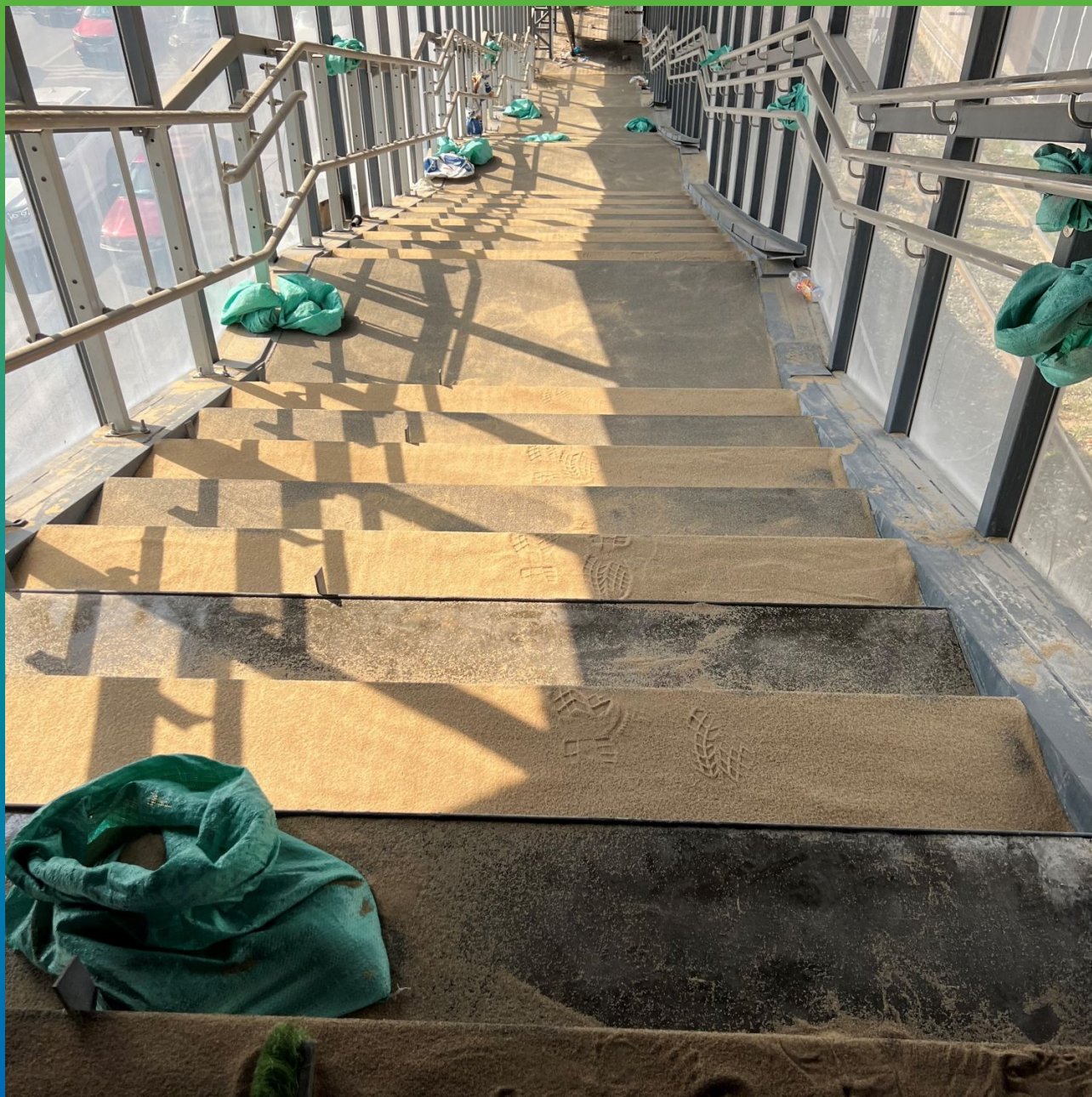
Просыпка лестничных пролетов ДенсТоп Филлер 01
