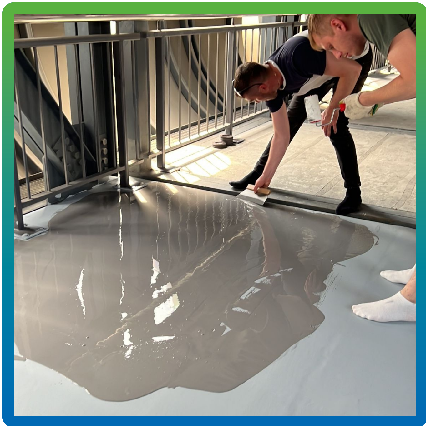
Нанесение первого слоя полиуретанового покрытия
