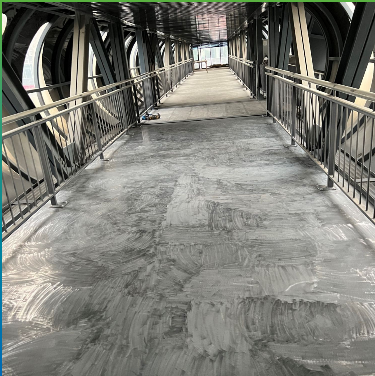
Шлифовка металлических пролетов
