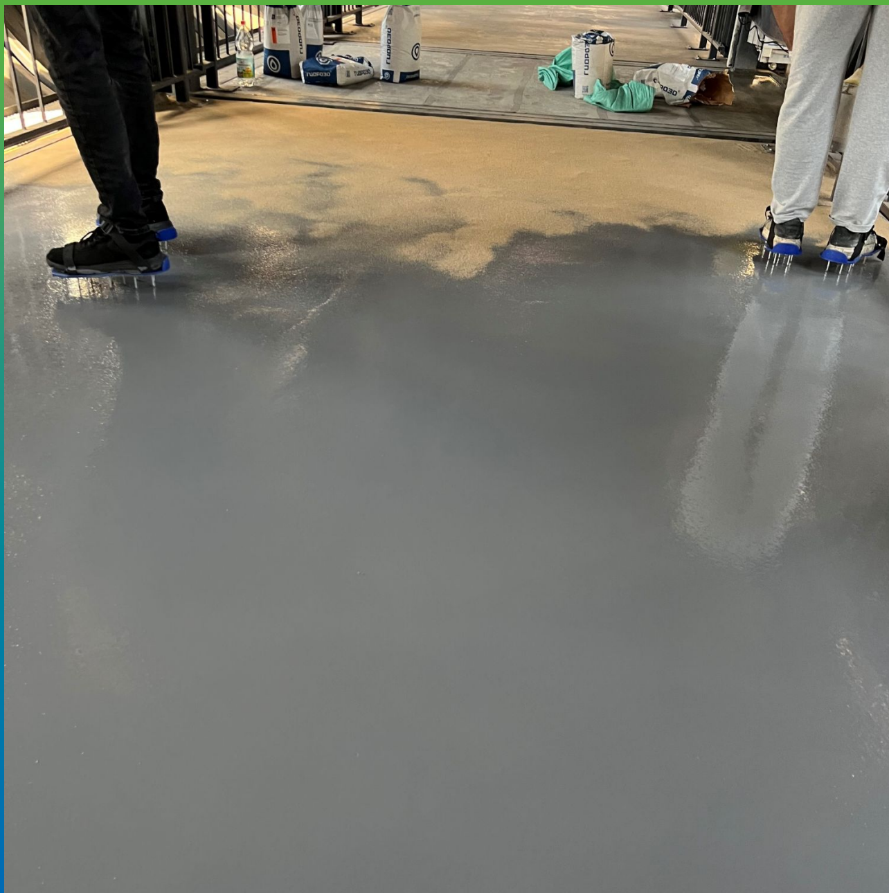
Просыпка первого слоя покрытия ДенТоп Филлер 01
