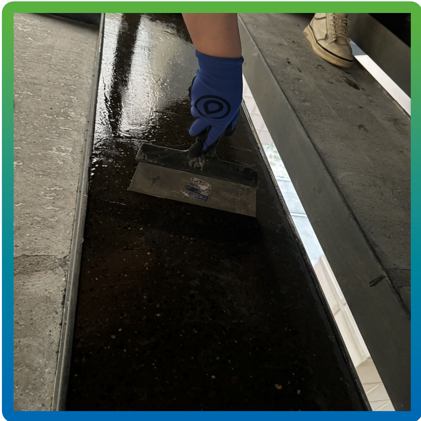
Грунтование бетонного основания эпоксидным составом ДенсТоп ЭП 106
