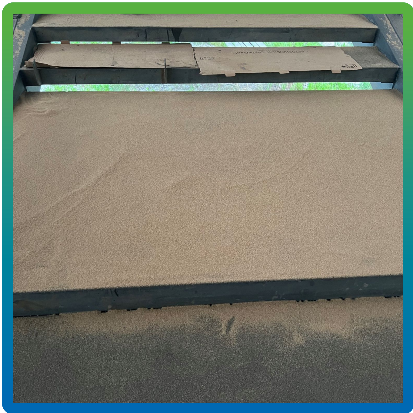
Просыпка лестничных пролетов ДенсТоп Филлер 01
