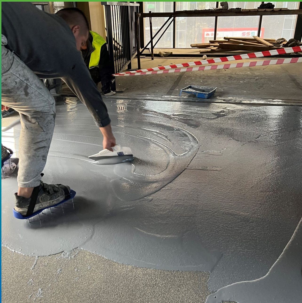
Нанесение второго слоя ДенсТоп ПУ 500
