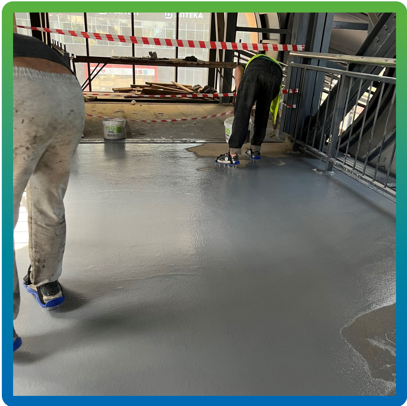
Нанесение второго слоя ДенТоп ПУ 500
