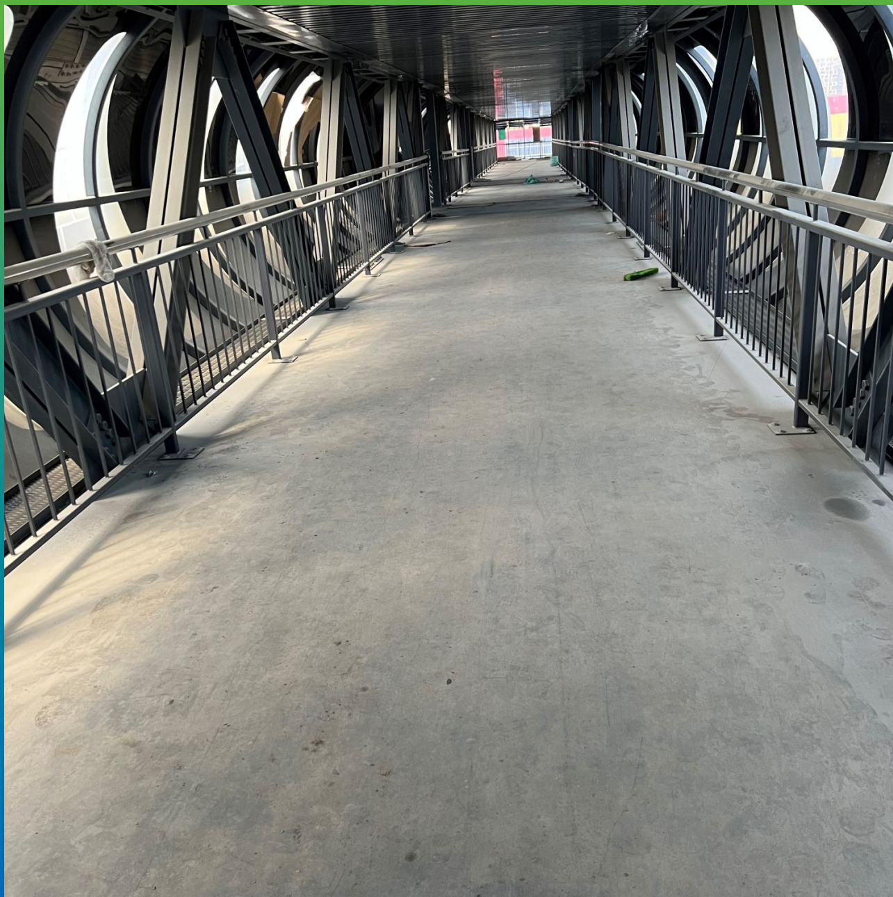
Основание до начала работ. Металл.
