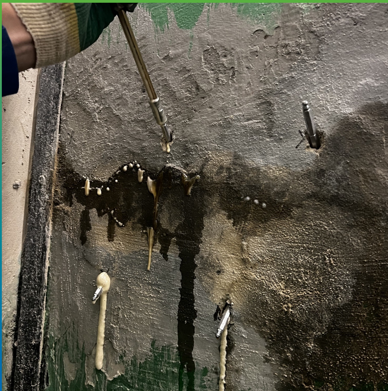
Проведение второй стадии инъектирования
