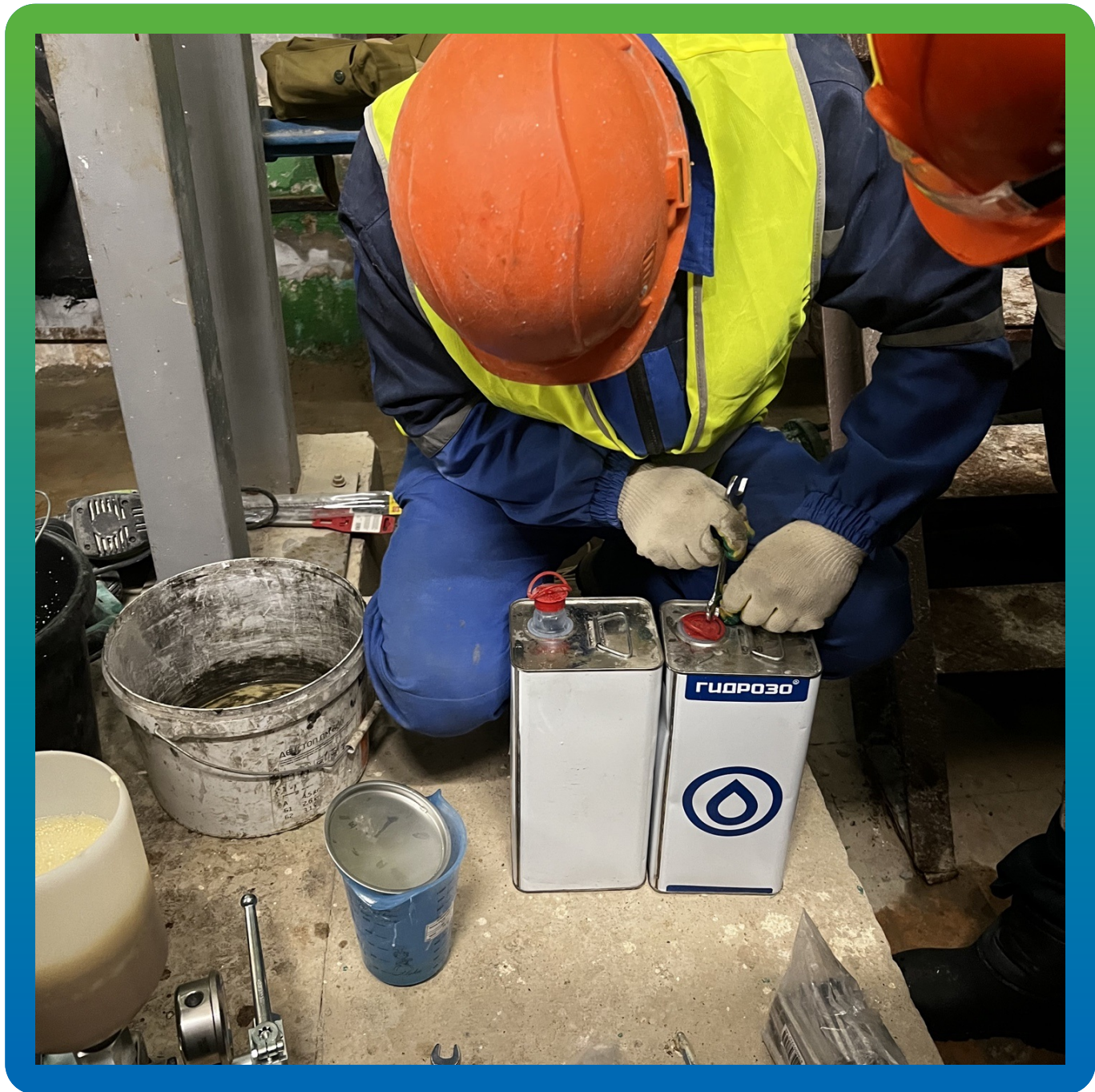
Подготовка материала Манопур 143 для проведения второй стадии инъектирования
