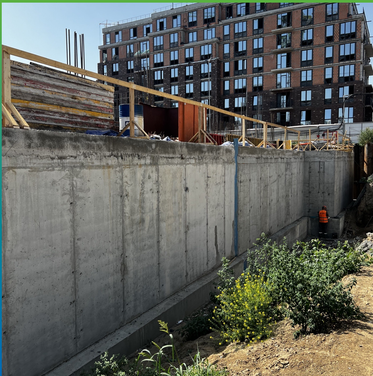
Стены заглубленного паркинга
