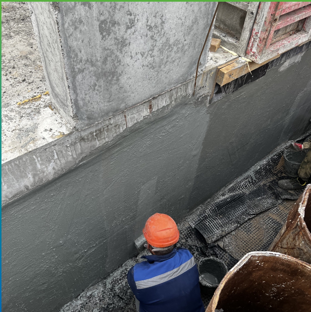
Нанесение второго слоя Стармекс Сил Флекс
