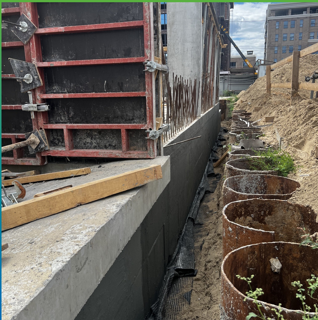
Стармекс Сил Флекс, нанесенный на стены
