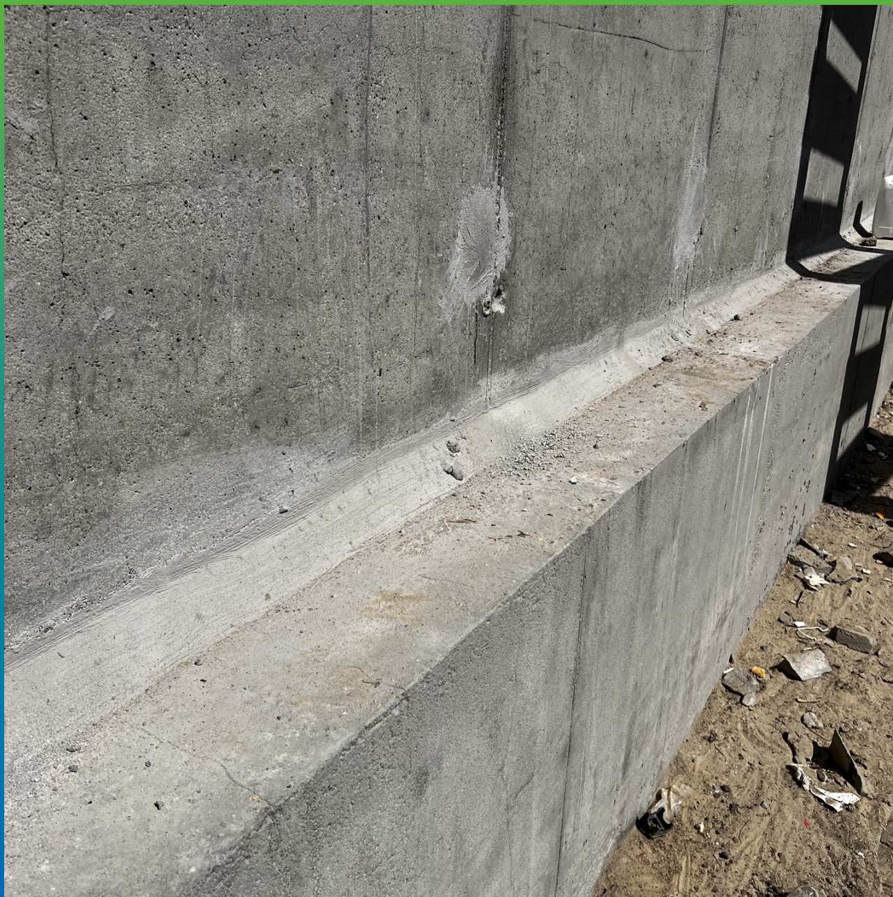
Штроба, заполненная составом Стамрекс Чекан
