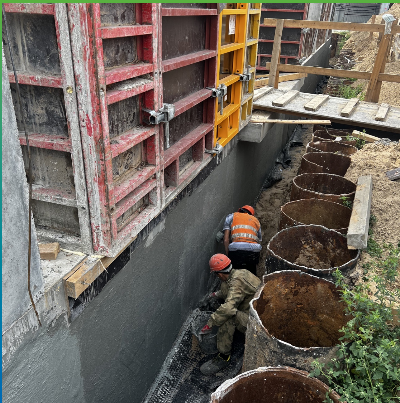
Нанесение второго слоя Стармекс Сил Флекс
