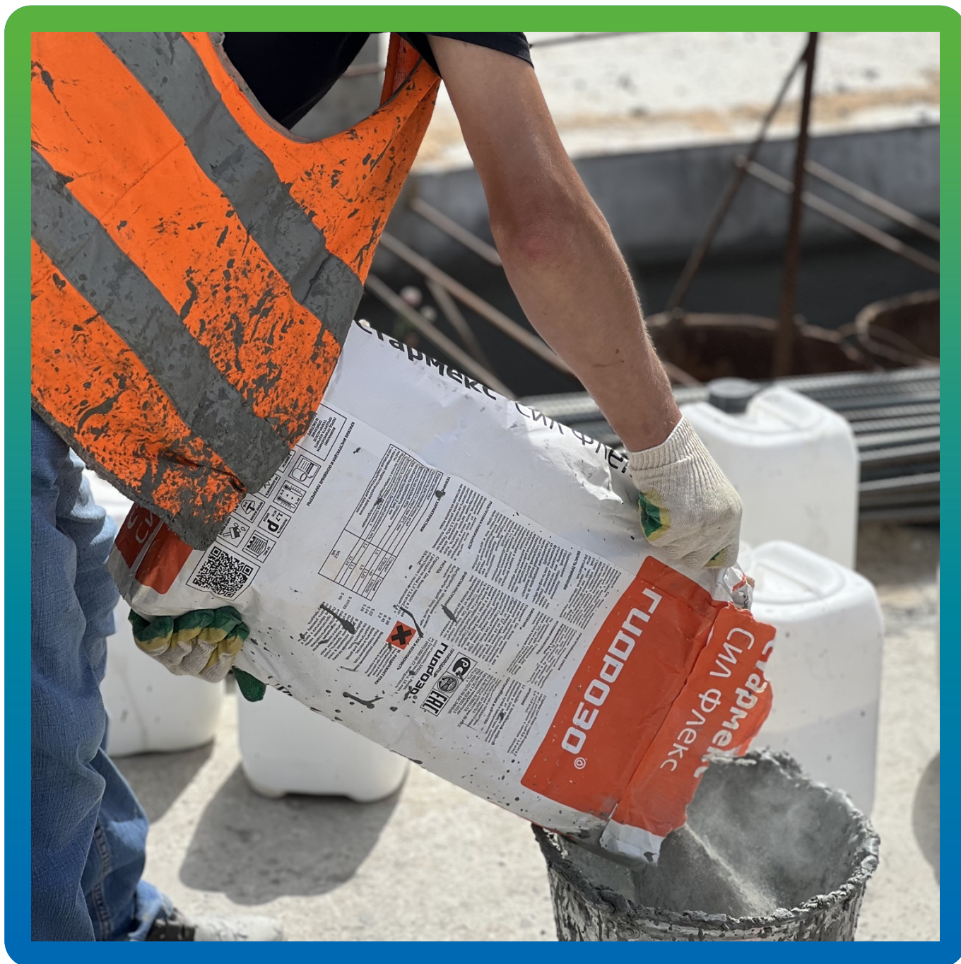
Замешивание состава Стармекс Сил Флекс
