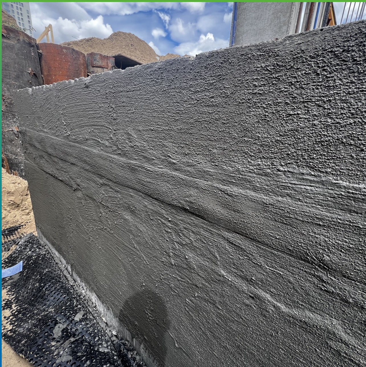
Стармекс Сил Флекс, нанесенный на стены
