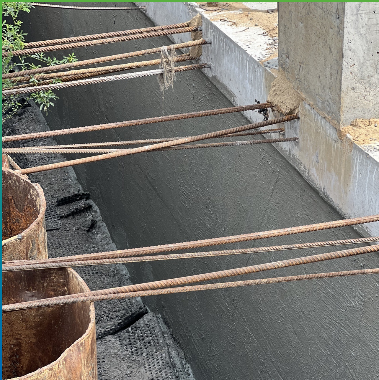
Стармекс Сил Флекс, нанесенный на стены
