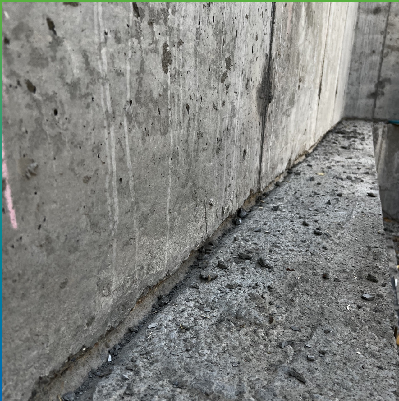
Расшивка штробы для последующего заполнения составом Стамрекс Чекан
