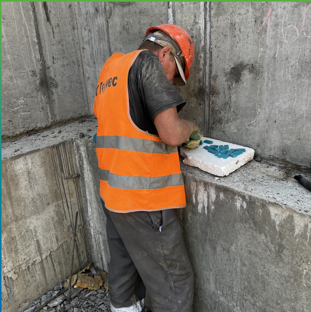
Нарезка гидрофильного профиля Манодил Свелл для последующего монтажа в опалубочные отверстия
