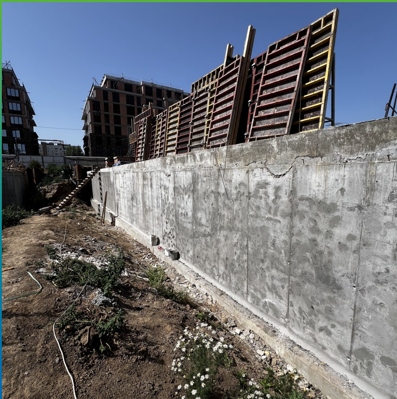
Стены заглубленного паркинга
