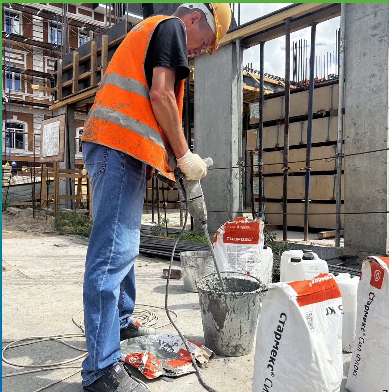
Замешивание состава Стармекс Сил Флекс
