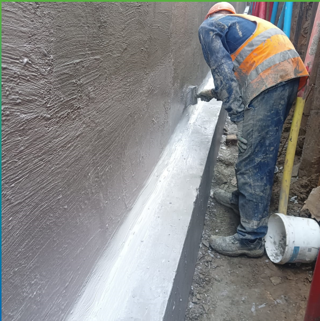
Нанесение первого слоя гидроизоляционного состава Стармекс Сил Флекс
