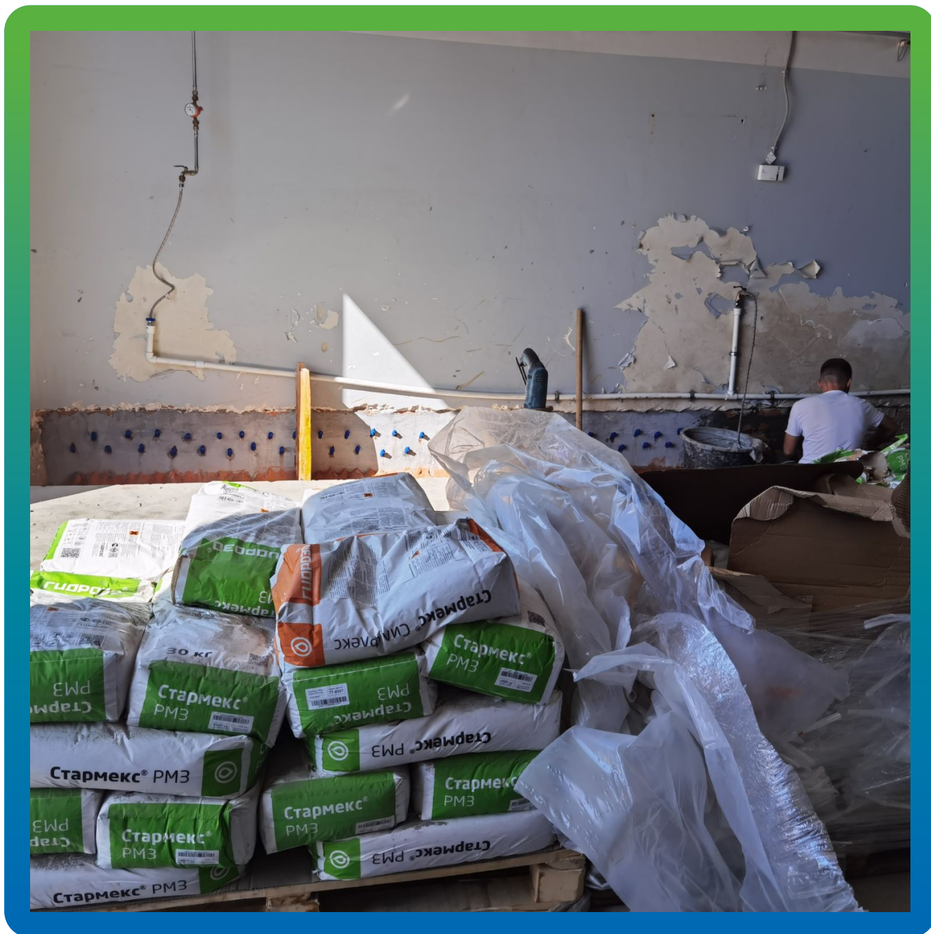
Материалы производства ООО «ГИДРОЗО» на объекте
