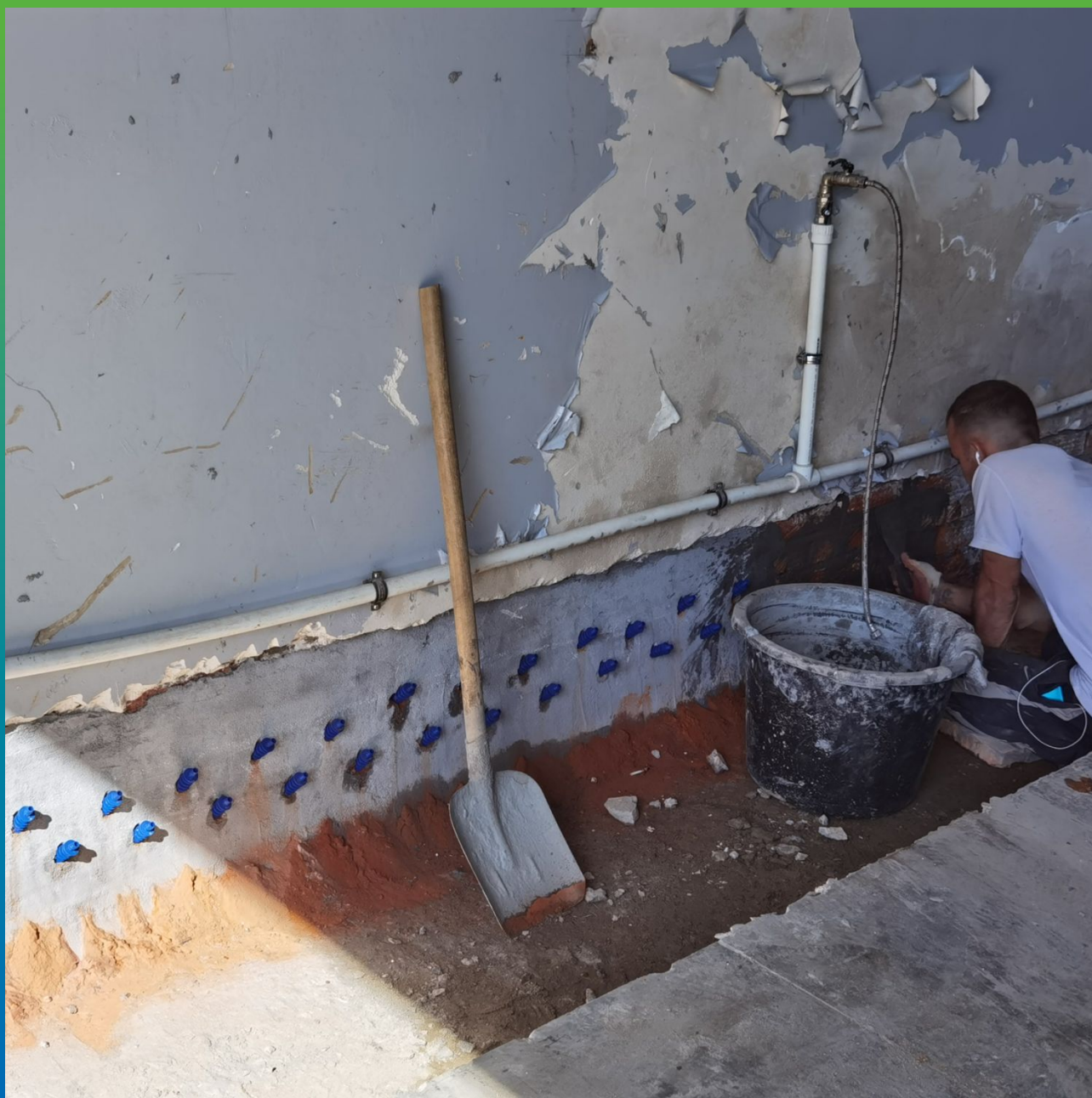
Установка пакеров БМ 2839 в пробуренные шпура с нанесением эластичной гидроизоляции Стармекс Сил Флекс
