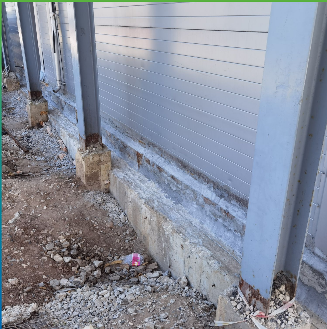
Вид конструкции после проведения работ
