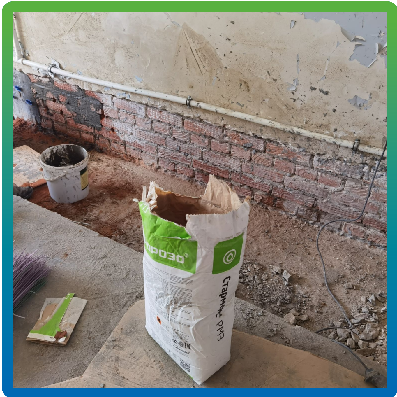
Ремонт швов кладки Стармекс РМЗ
