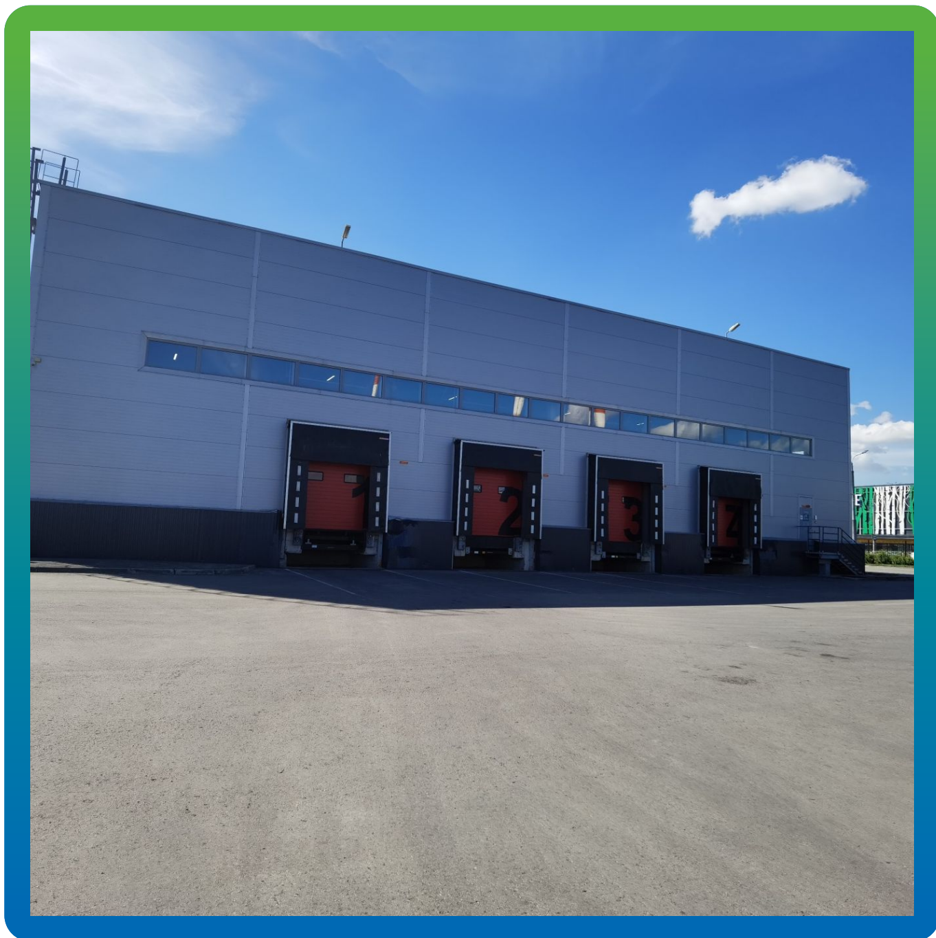
Вид объекта после работ
