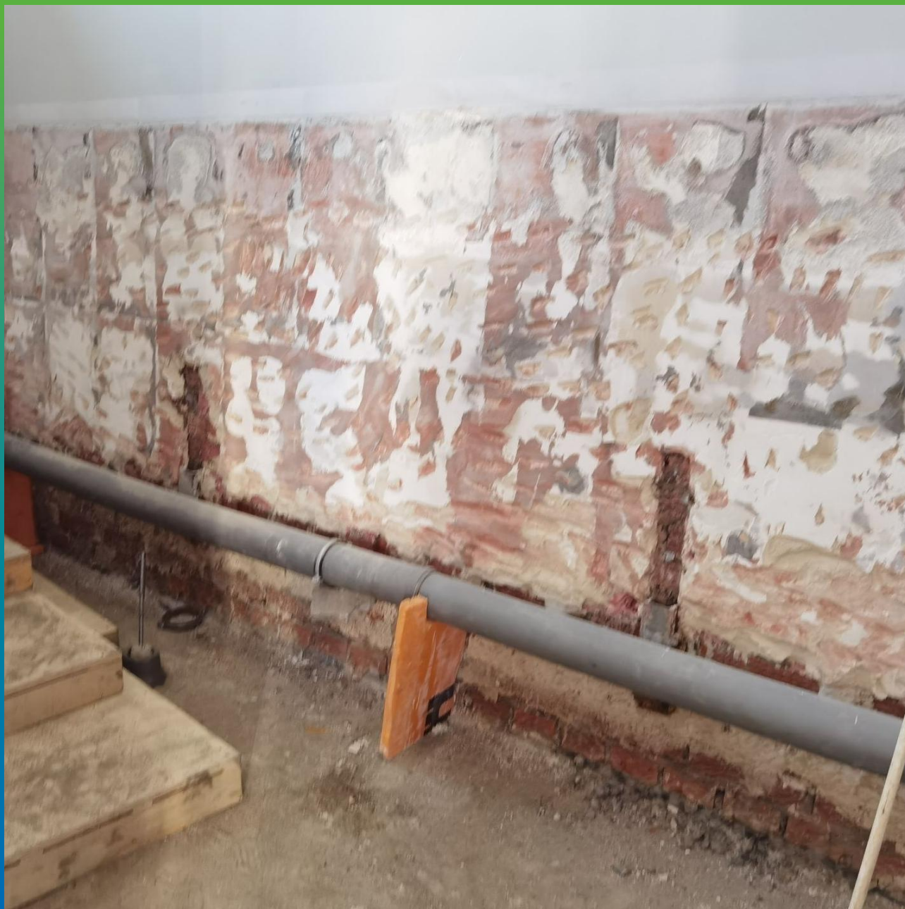
Отбивка старой штукатурки, удаление дефектной краски
