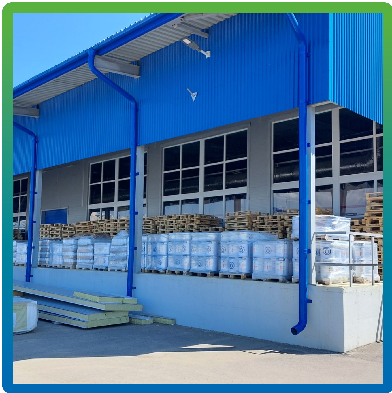
Материалы Гидрозо на объекте
