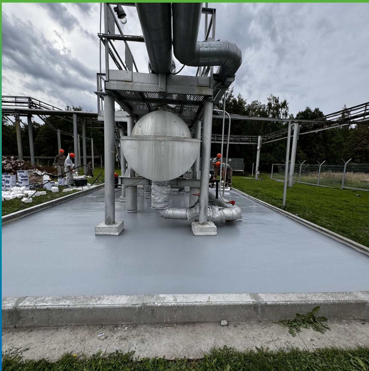
Внешний вид готового покрытия площадки
