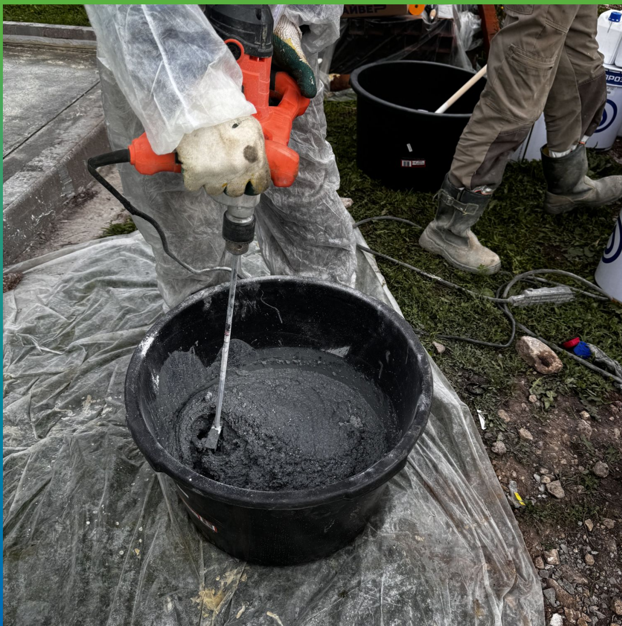
Промешивание всех компонентов состава Денстоп ПМ 605 Тровел
