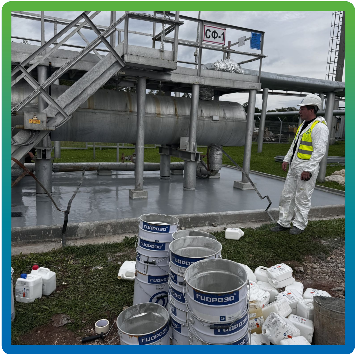
Внешний вид готового покрытия площадки
