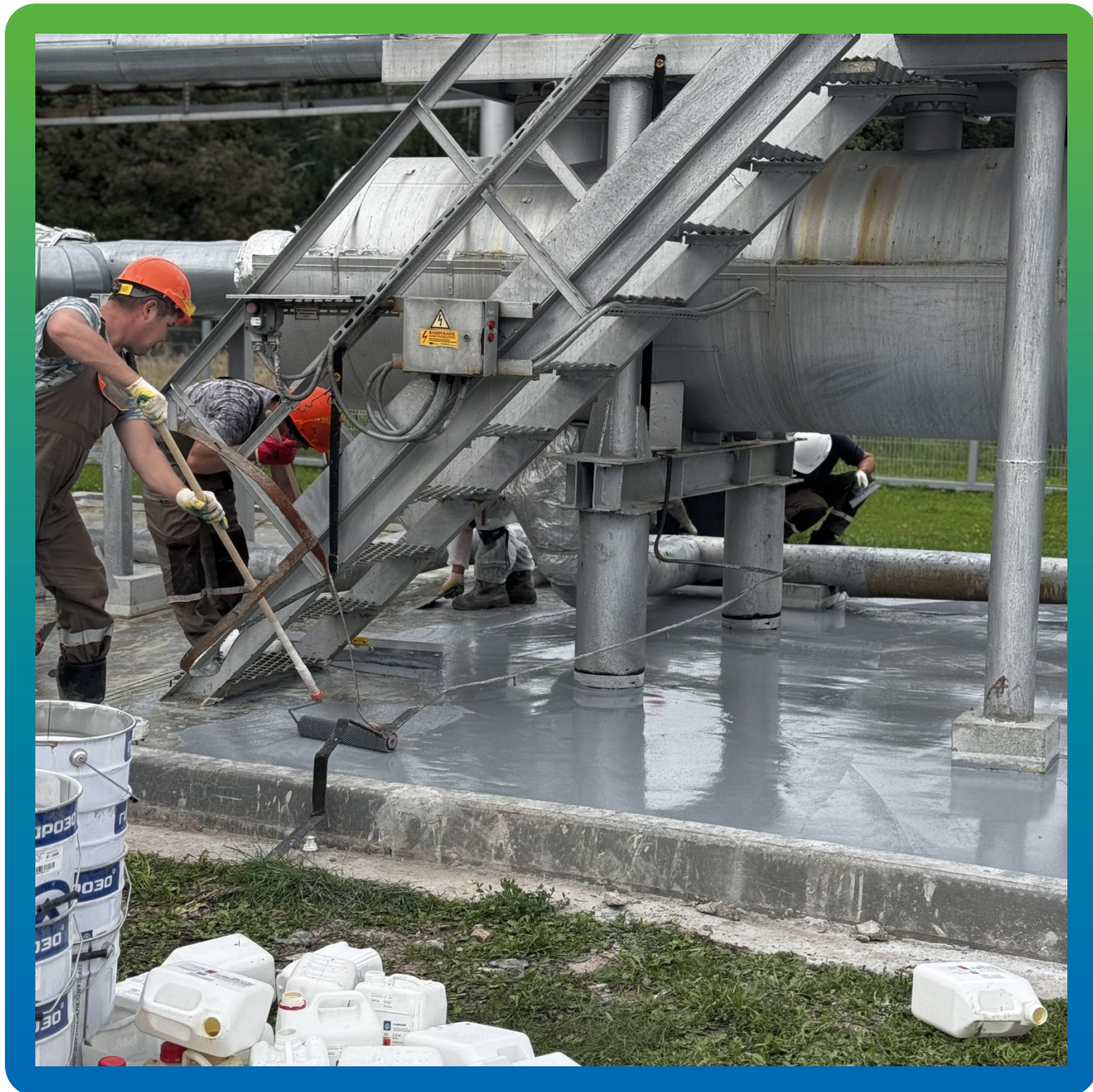
Укладка покрытия по всей площади
