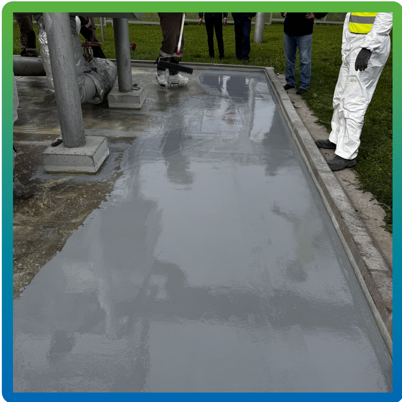
Укладка покрытия по всей площади
