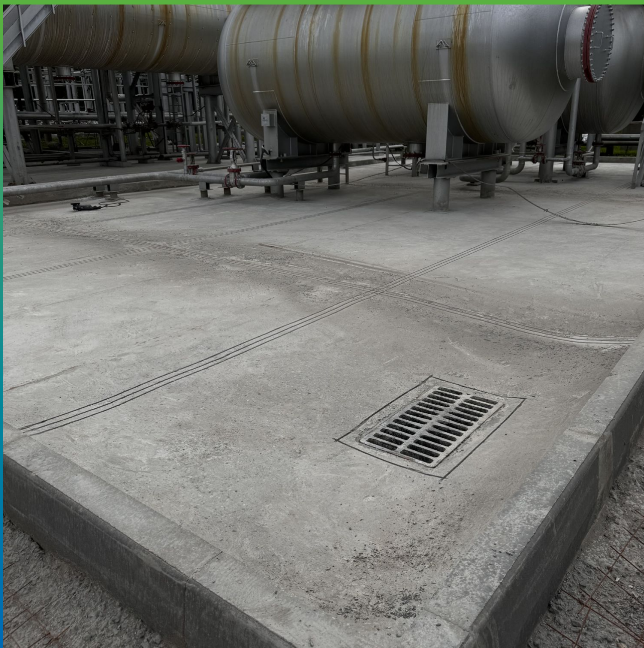
Площадка насосной станции до начала работ по устройству защитного покрытия
