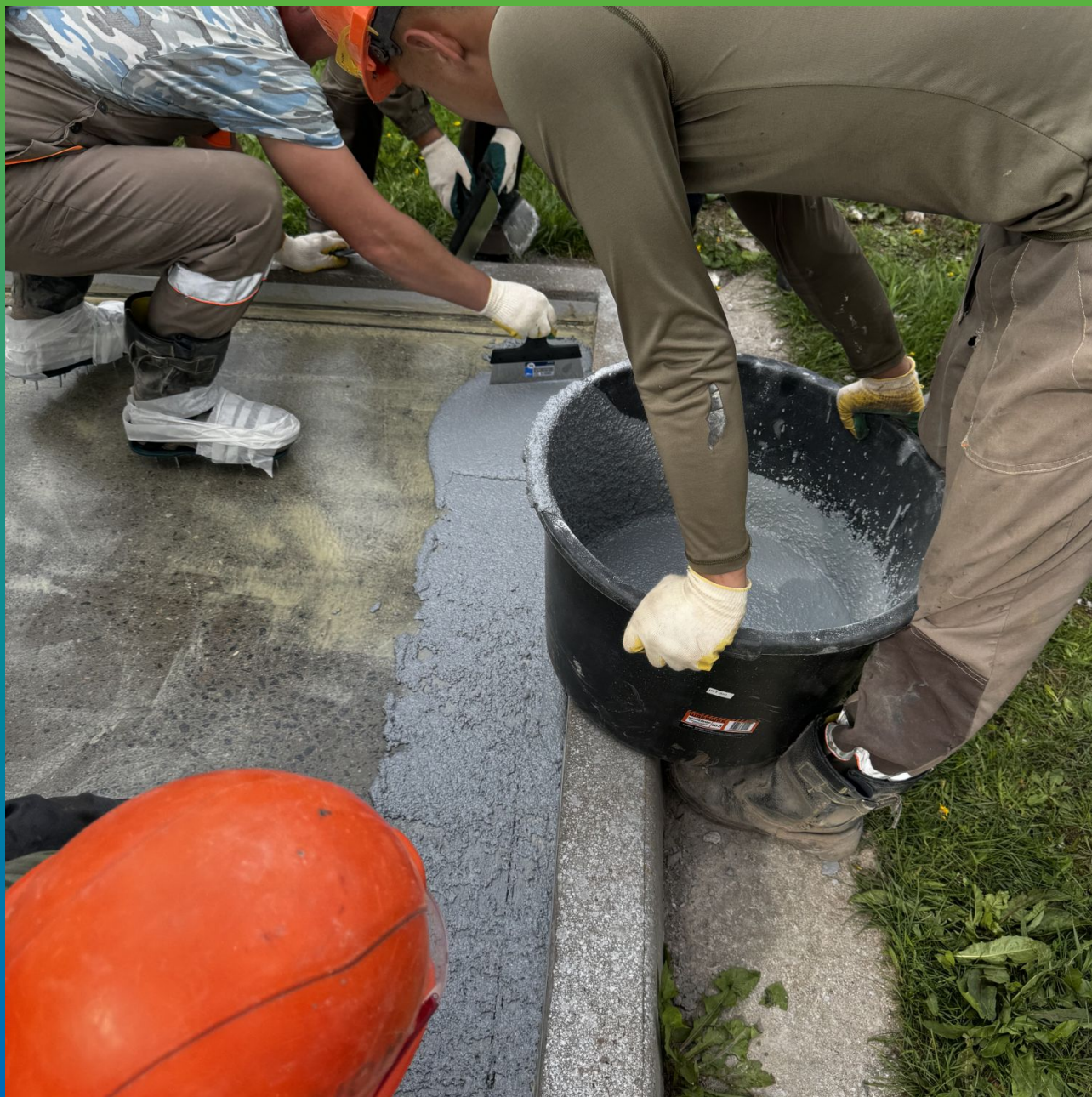
Нанесение Денстоп ПМ 605 Тровел на поверхность
