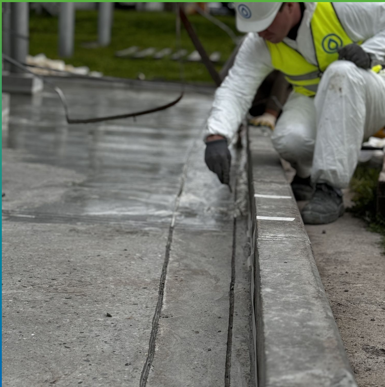
Грунтование основания и анкерных пропилов
