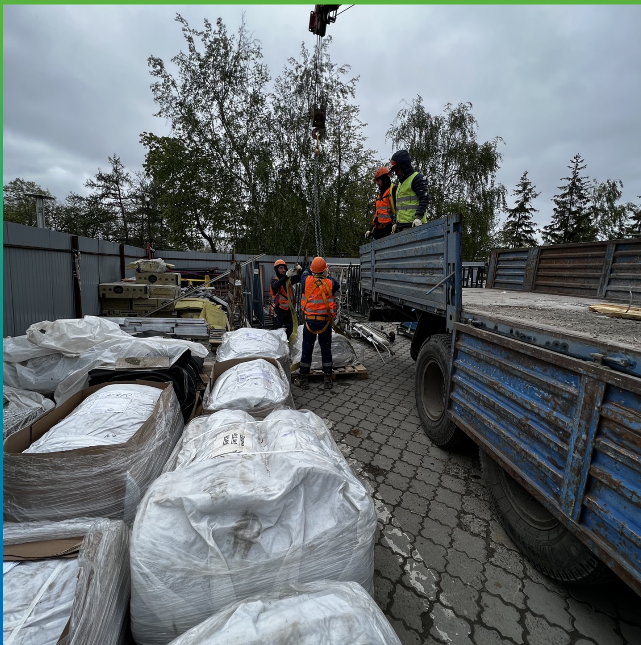
Поставка заранее вулканизированных полотен Прелести СТ на объект
