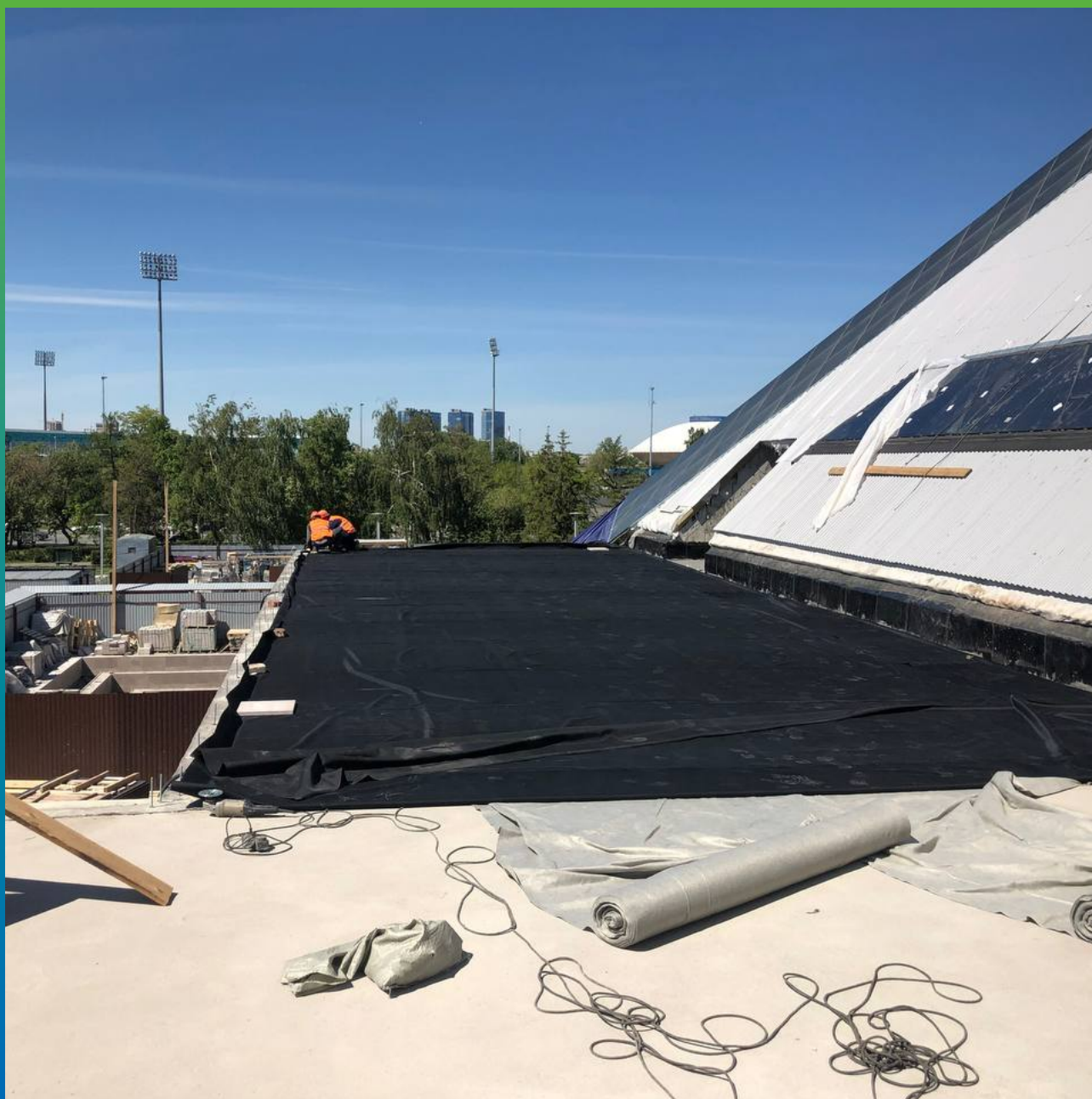
Раскладка полотен ЭПДМ мембраны Преласта СТ на объекте
