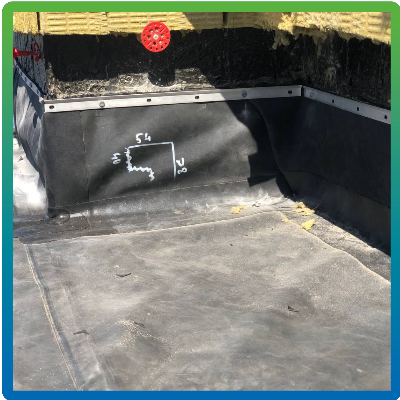
Мембрана, закрепленная на прижимную рейку
