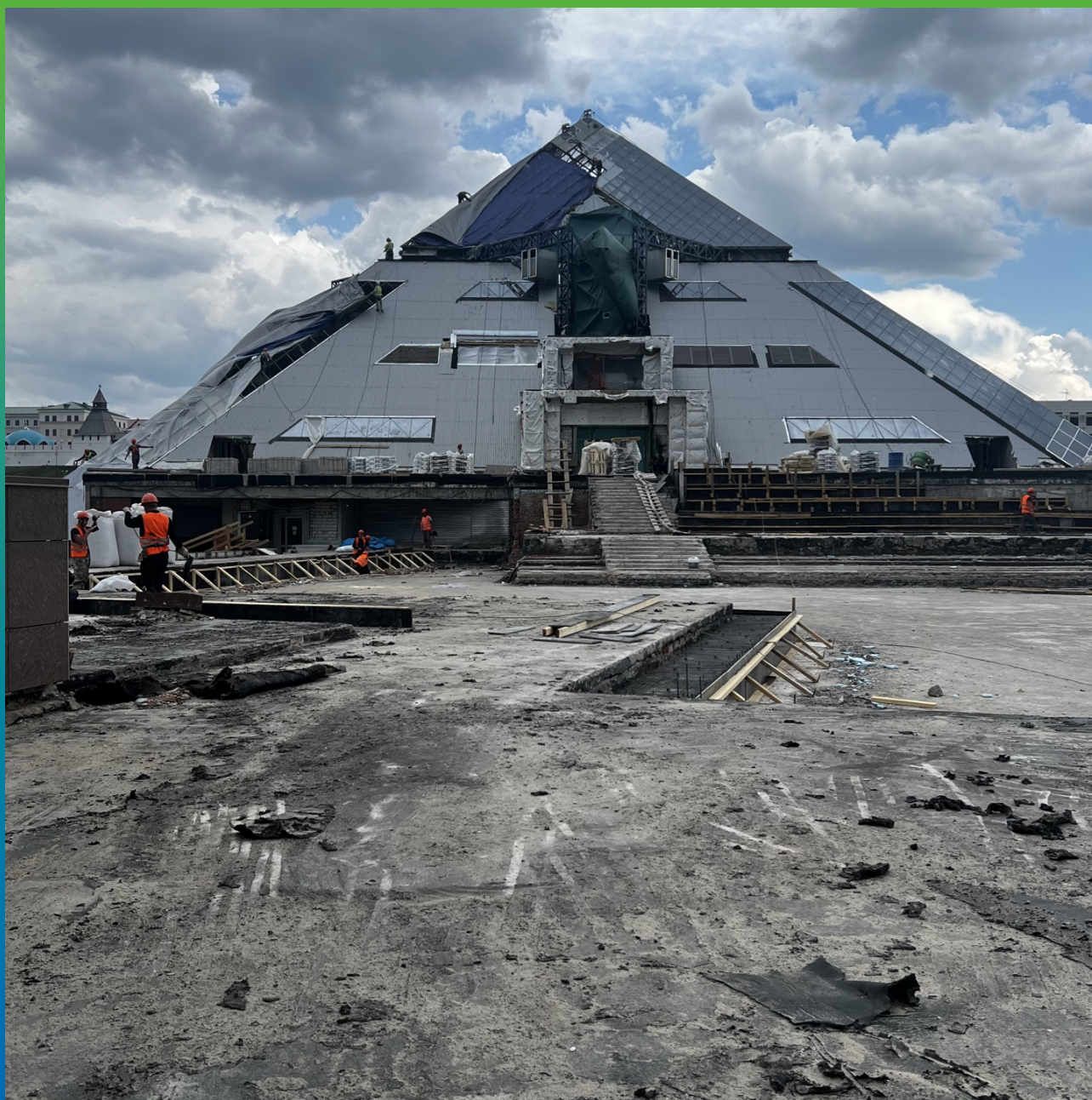
Демонтаж существующего благоустройства и кровельного пирога террас
