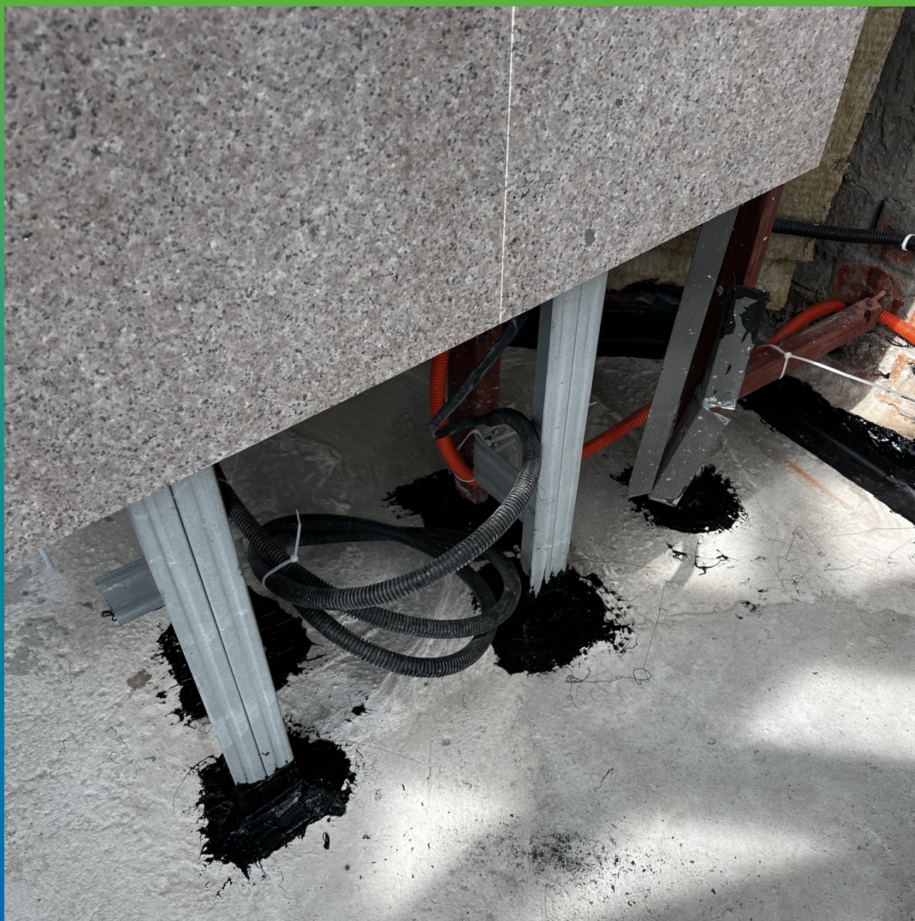
Точечная герметизация элементов, входящих в кровельный пирог
