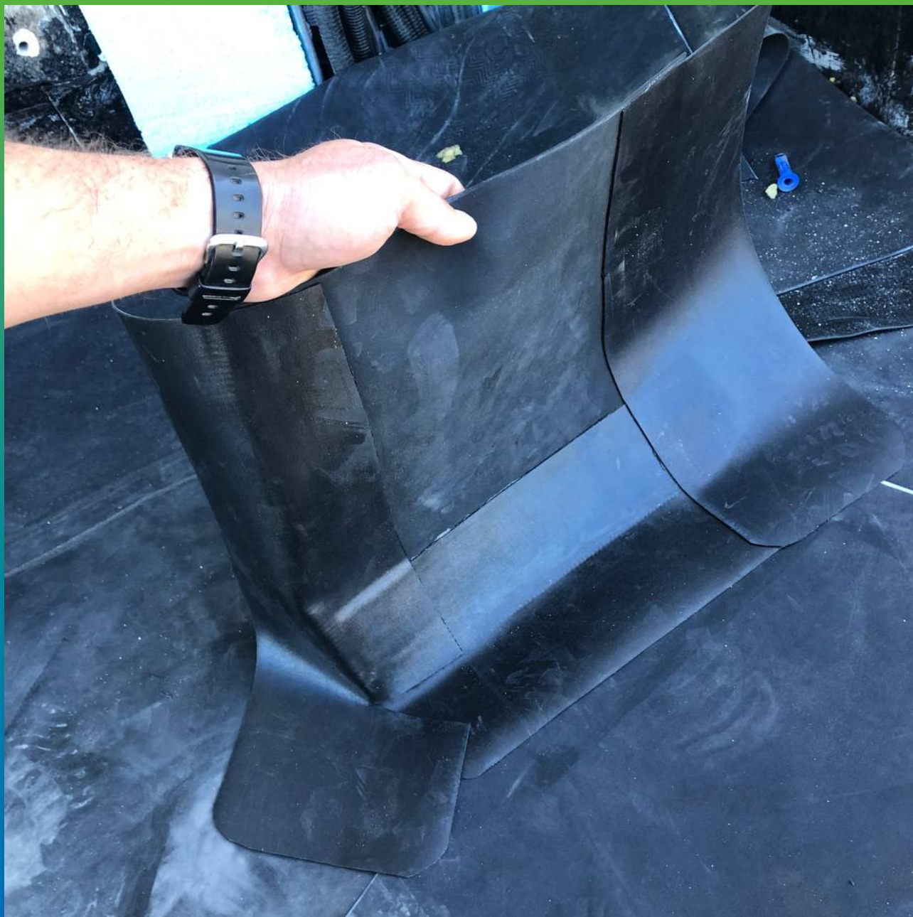
Примерка и обвод углов террас
