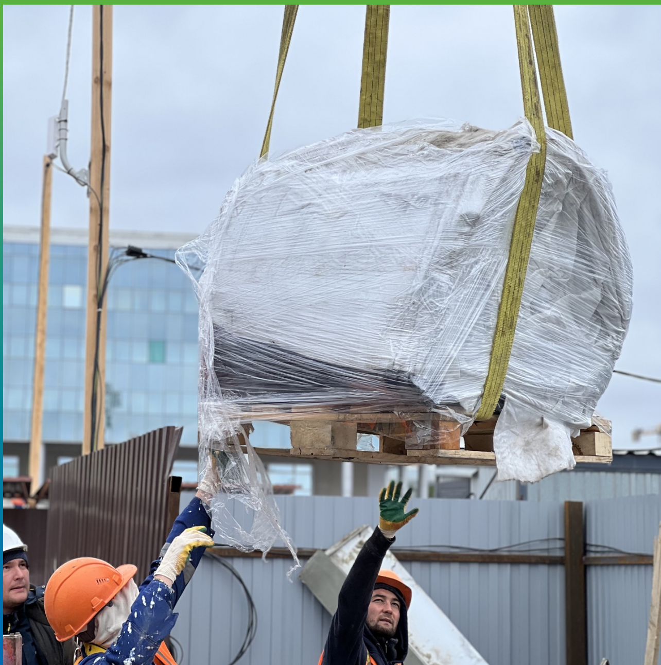
Вулканизированные полотна Преласты СТ на объекте
