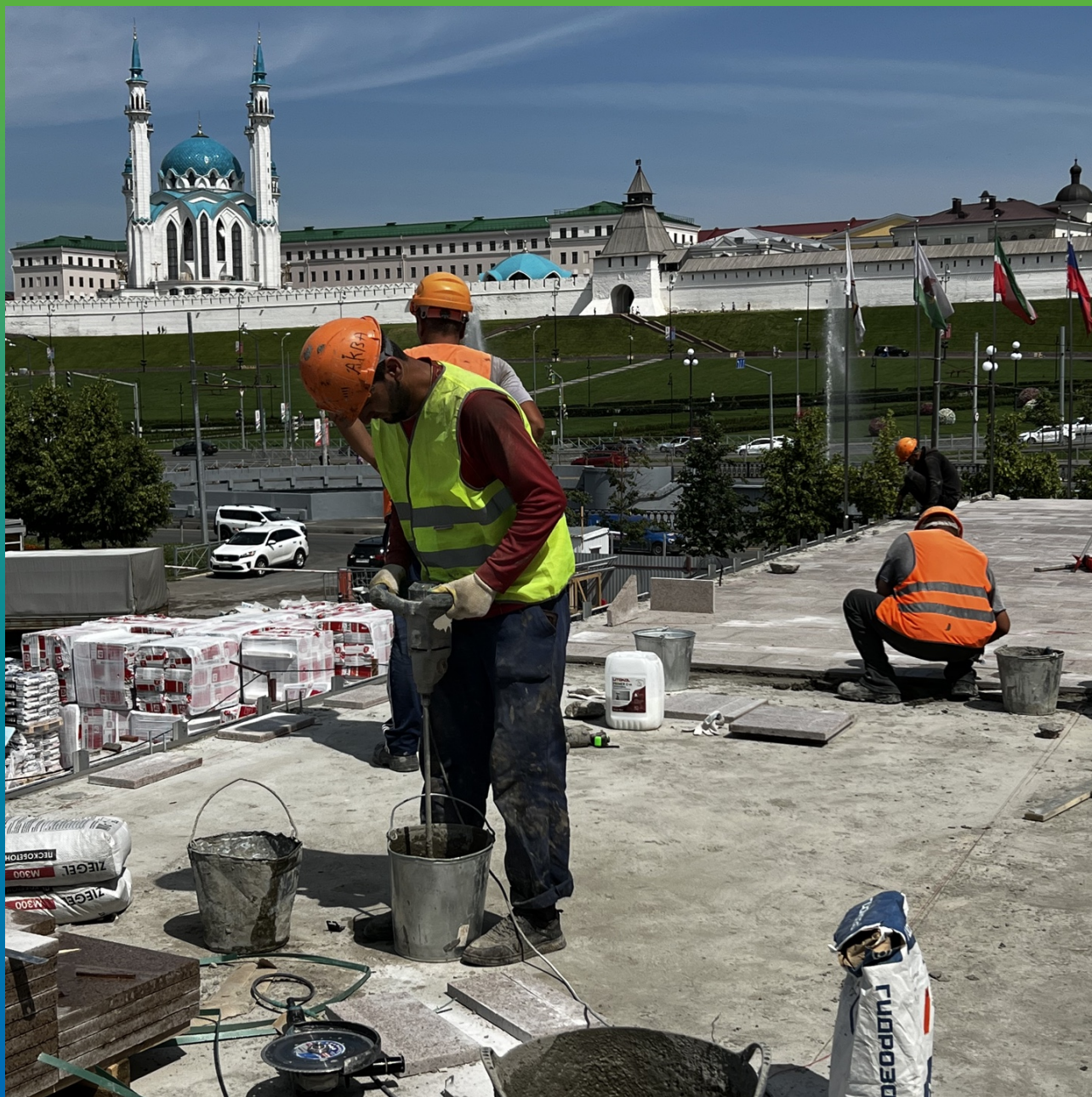
Замешивание эластичного плиточного клея Стармекс Керамо
