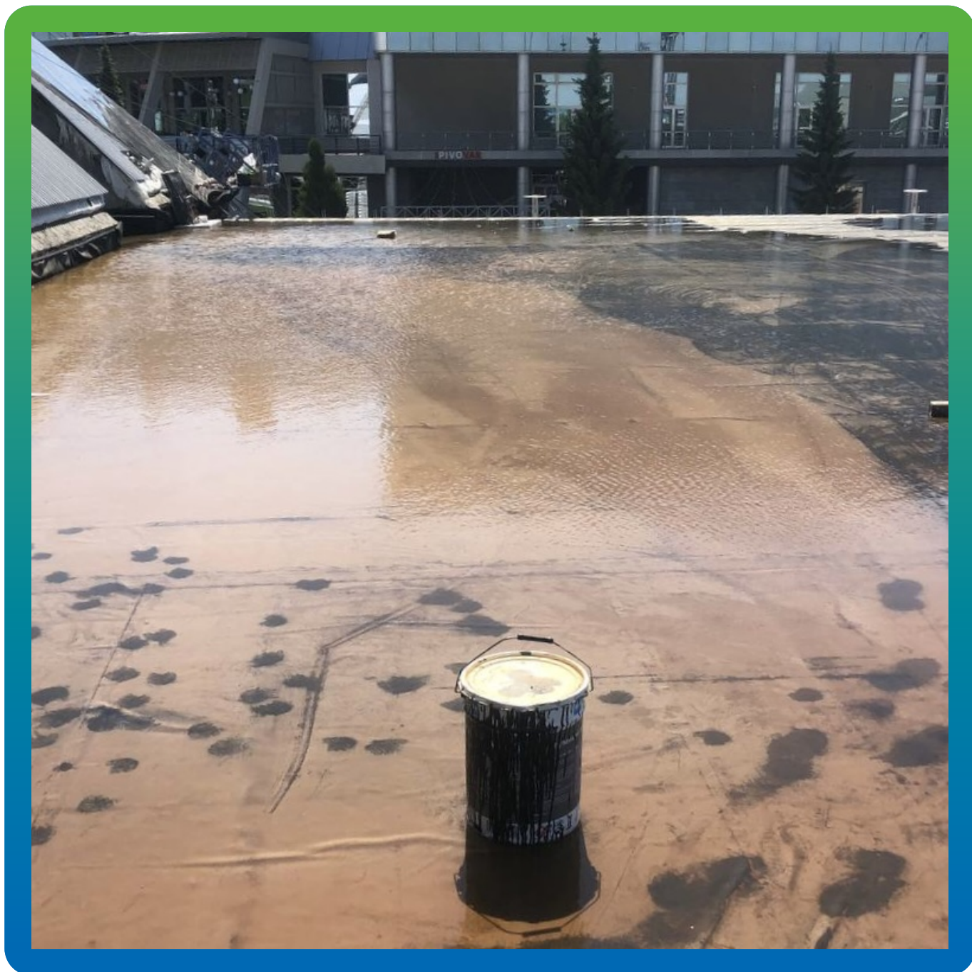
Проведение гидроиспытаний
