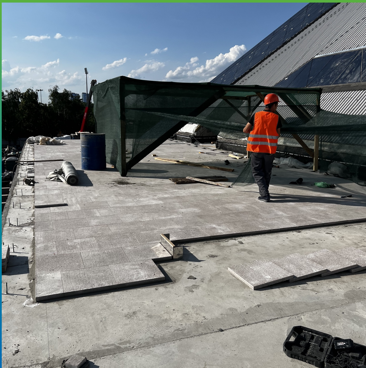
Гранит, уложенный на эластичный плиточный клей Стармекс Керамо
