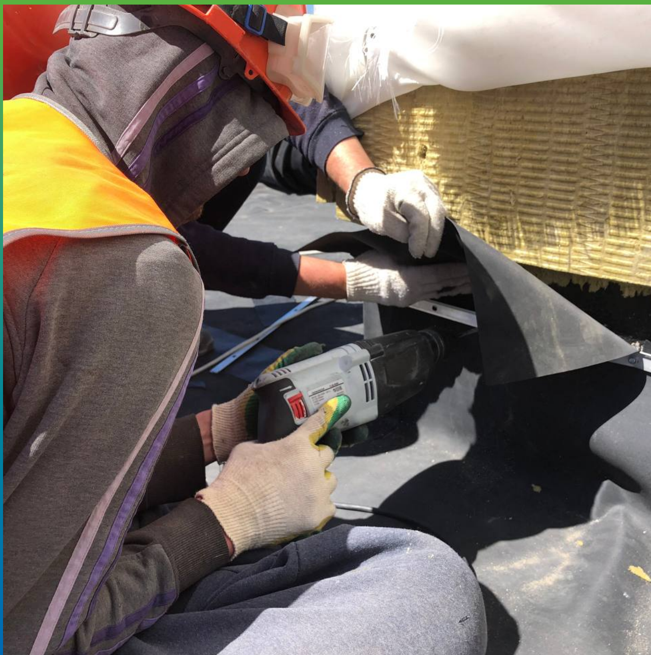
Крепление полотен мембраны на прижимную рейку
