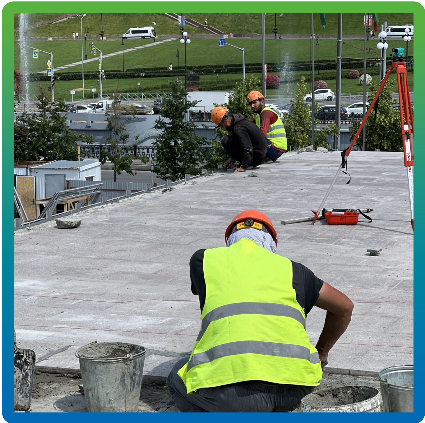
Укладка гранита на клей Стармекс Керамо
