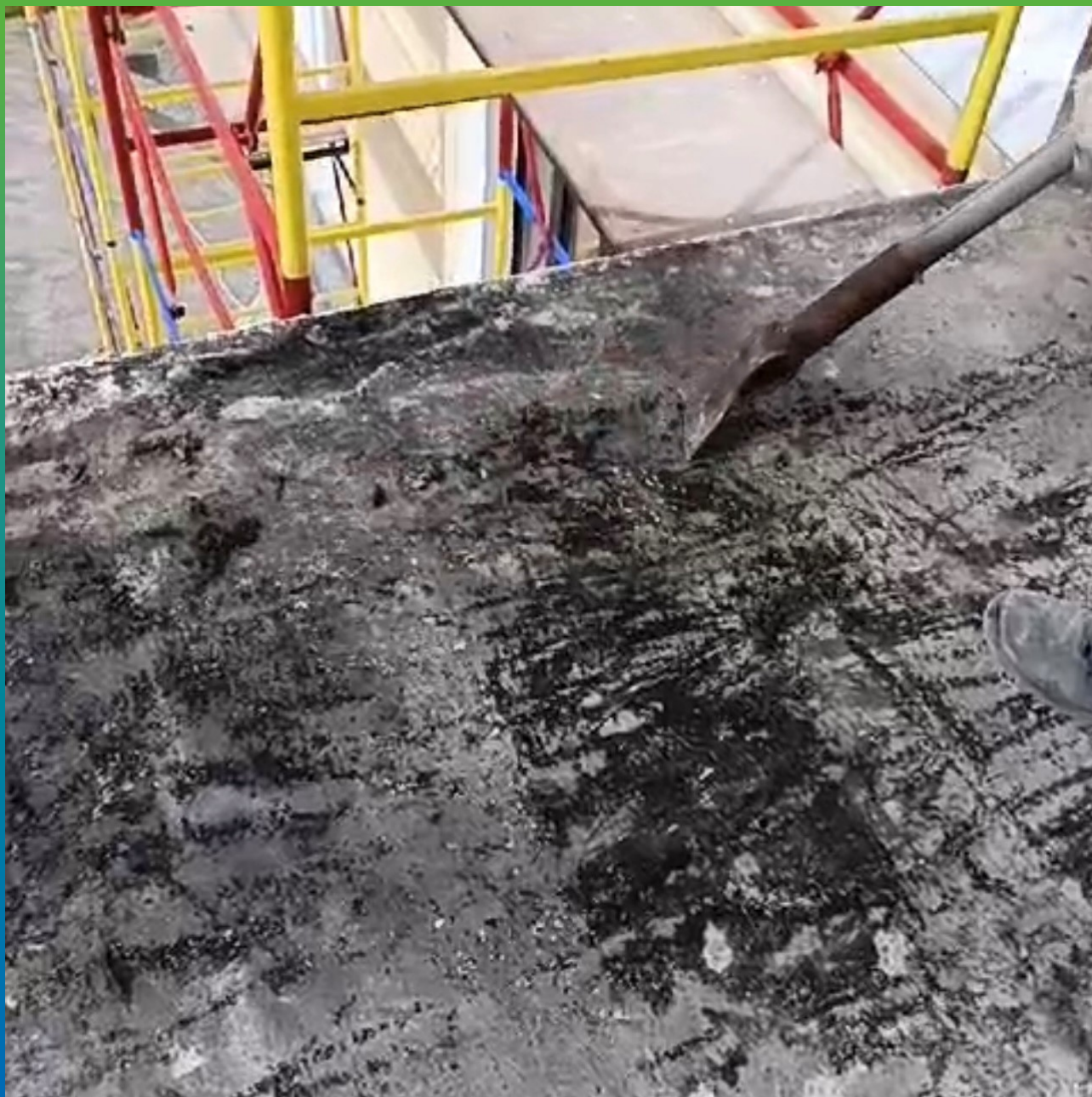
Очистка от битумного праймера, впитавшегося в основание.
