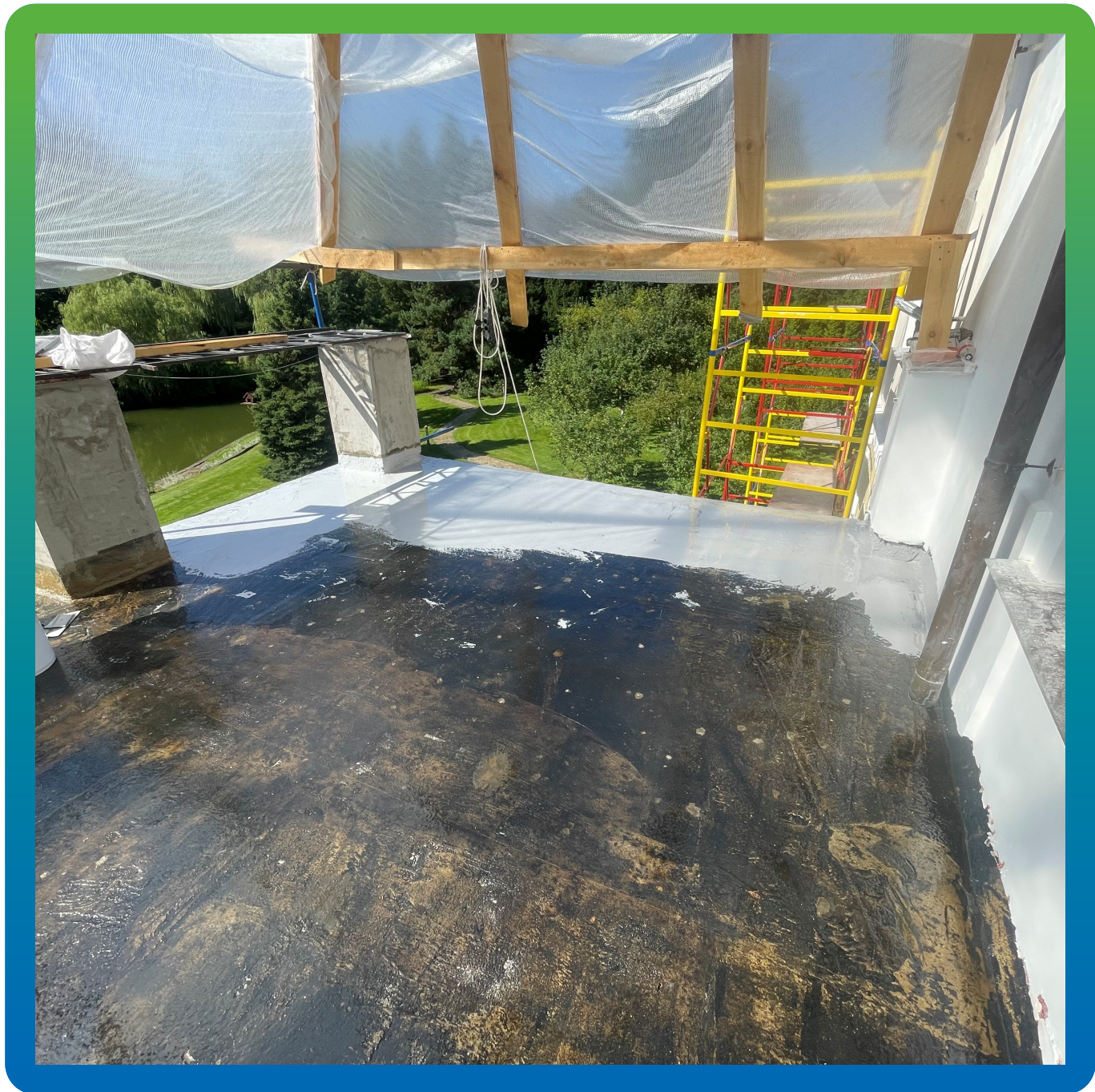
Нанесение первого слоя гидроизоляционного покрытия Денстоп МС 351.
