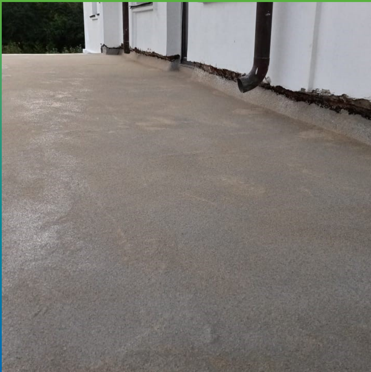
Вид на смонтированную систему ДенсТоп ЭП 106 + ДенсТоп Филлер + Денстоп МС 351.
