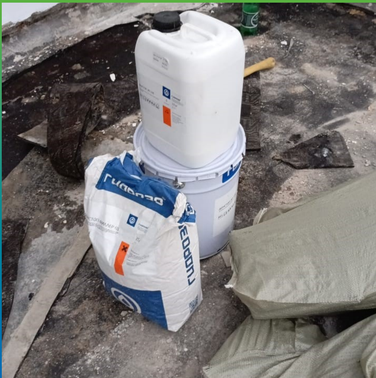
Материалы Гидрозо на объекте.
