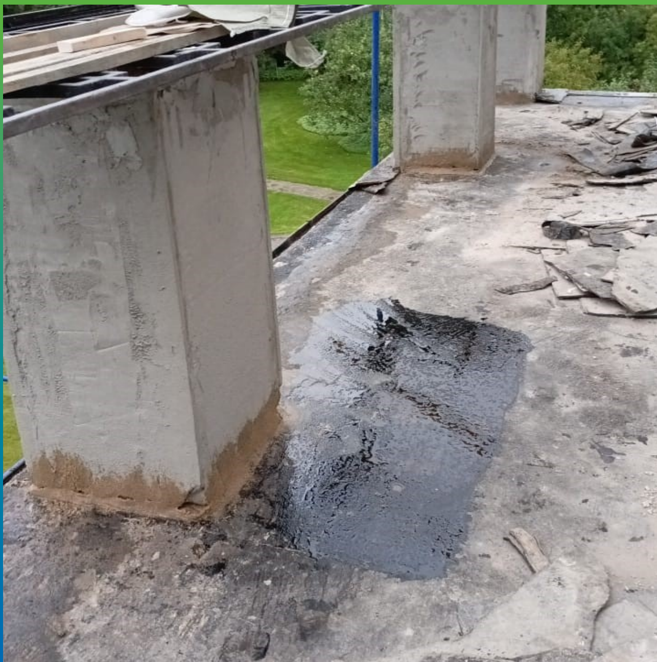
Ремонт примыканий к колоннам при помощи смеси материалов ДенсТоп Филлер 01 / ДенсТоп ЭП 106 в пропорции 4/1.
