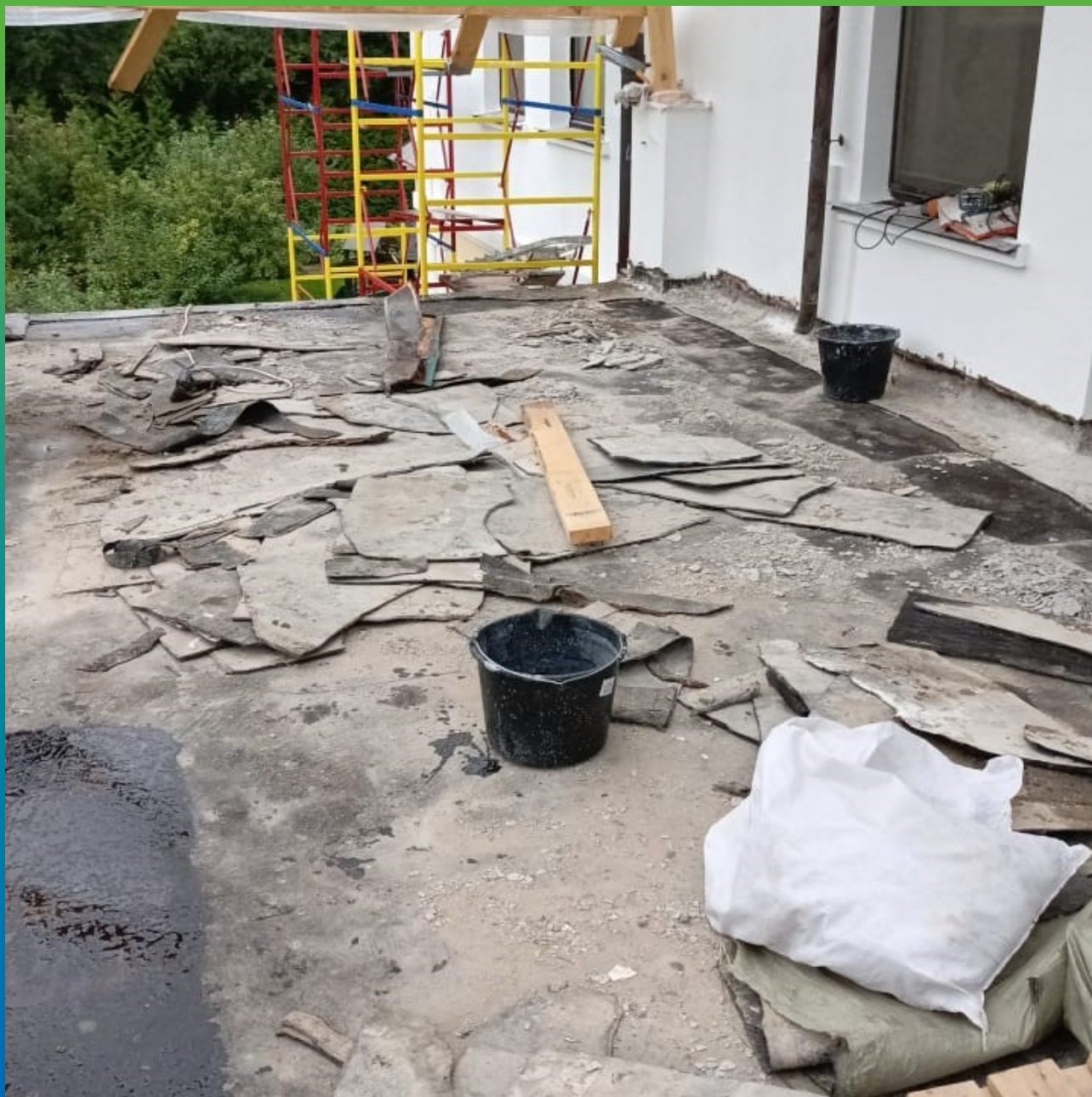
Вид основания до начала производства работ по гидроизоляции.
