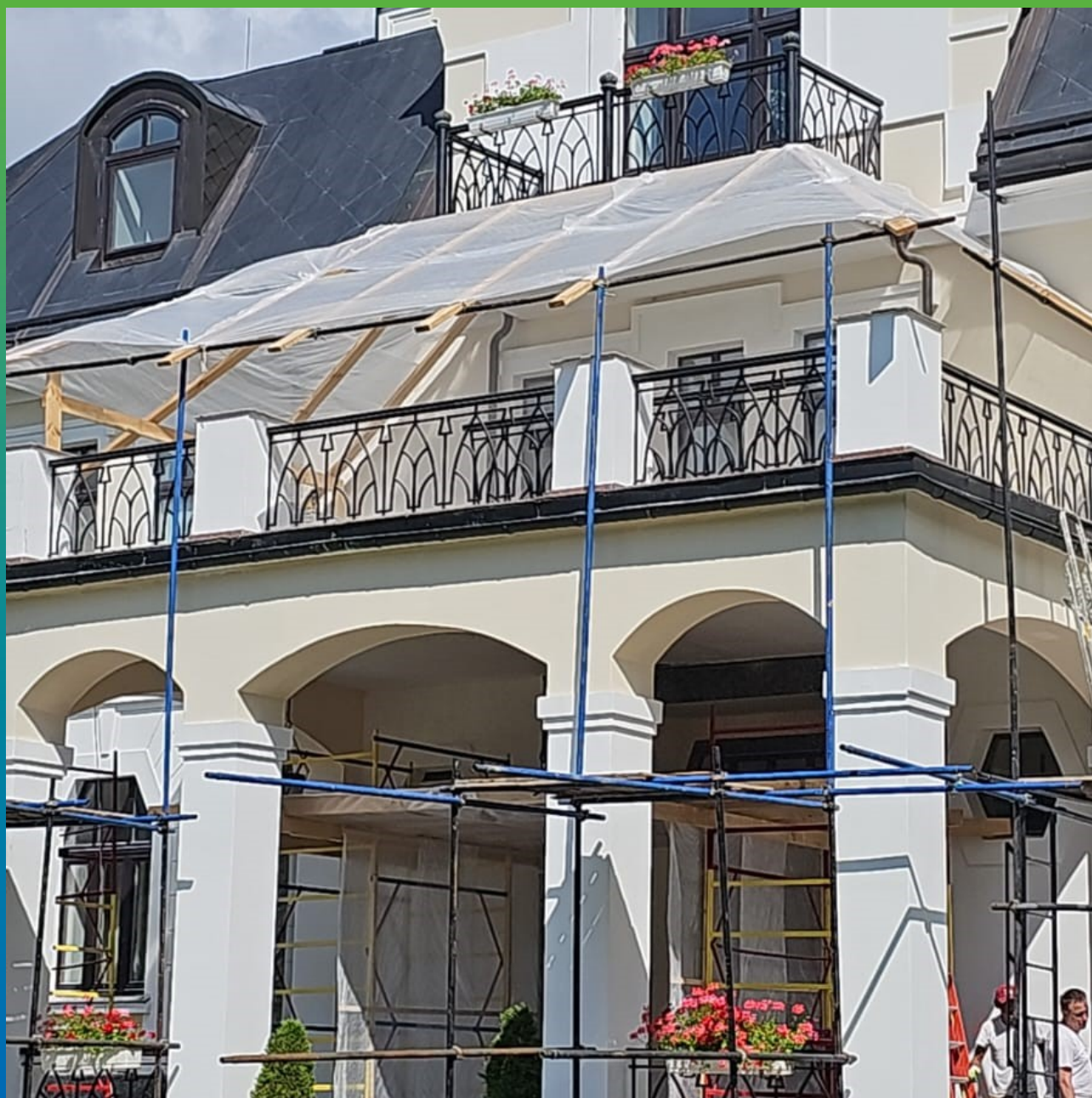
Общий вид на фасад объекта.
