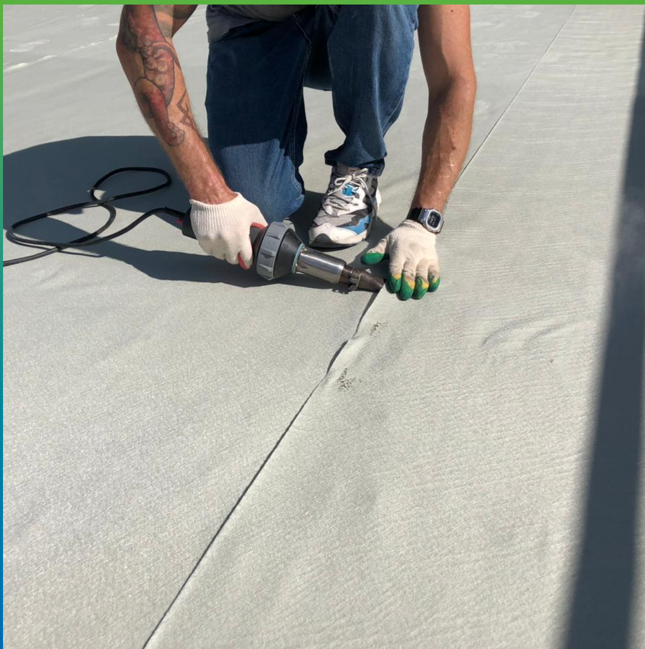
Уложенный слой геотекстиля и сварка полотен геотекстиля между собой
