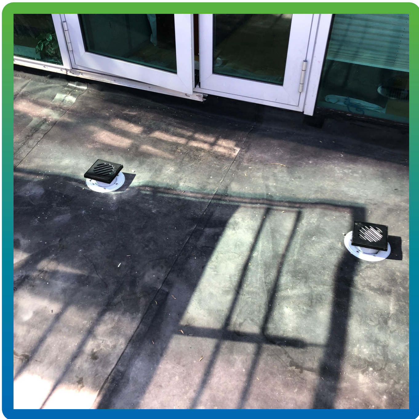
Формирование водосливных воронок перед последующей заливкой стяжки
