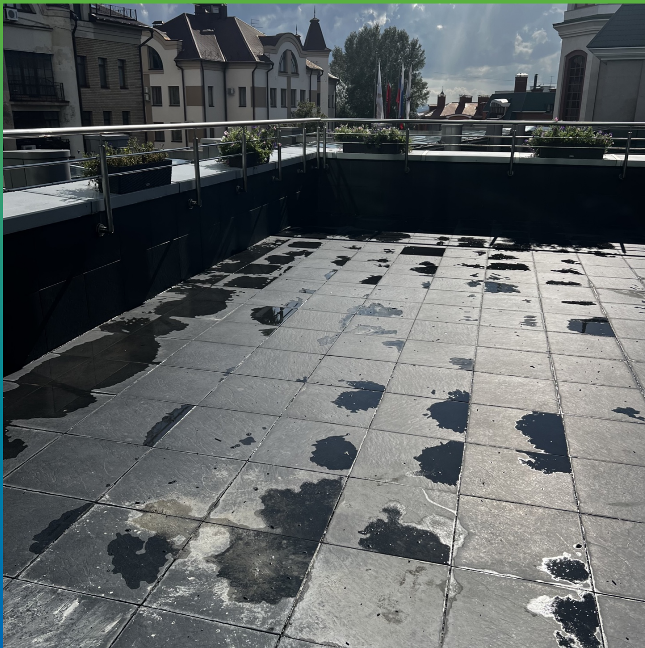
Вид террасы до проведения ремонтных работ
