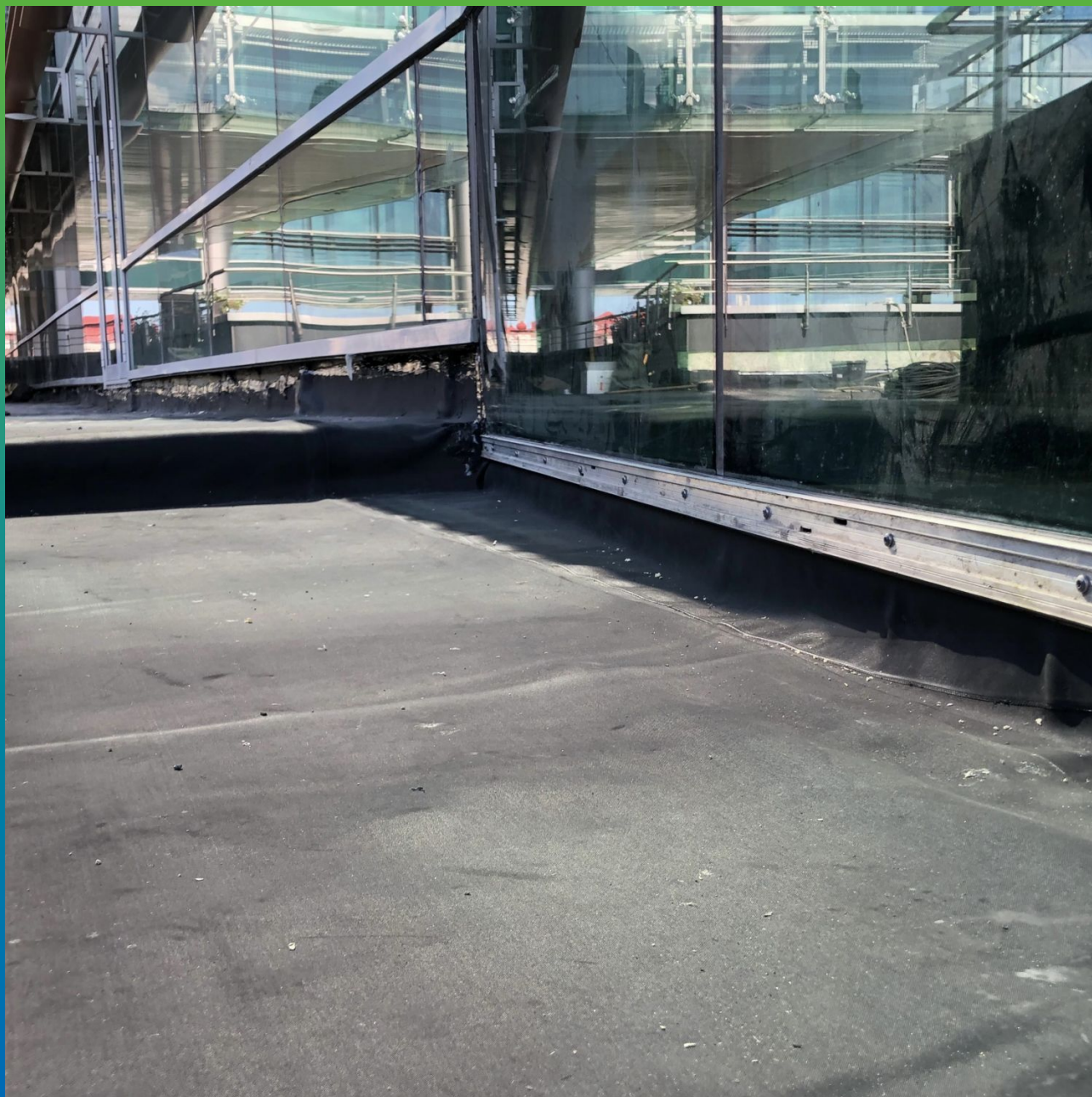
Примыкания, герметизированные Манодил Бонд Ф
