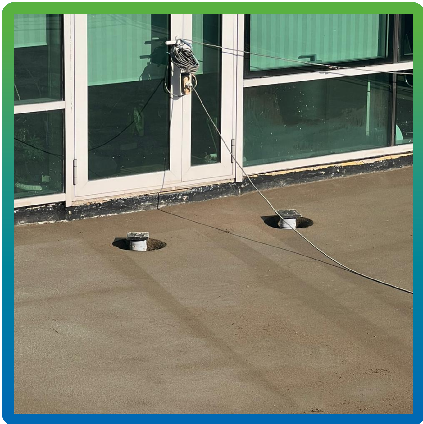
Стяжка, выполненная поверх ЭПДМ мембраны Преласта СТ
