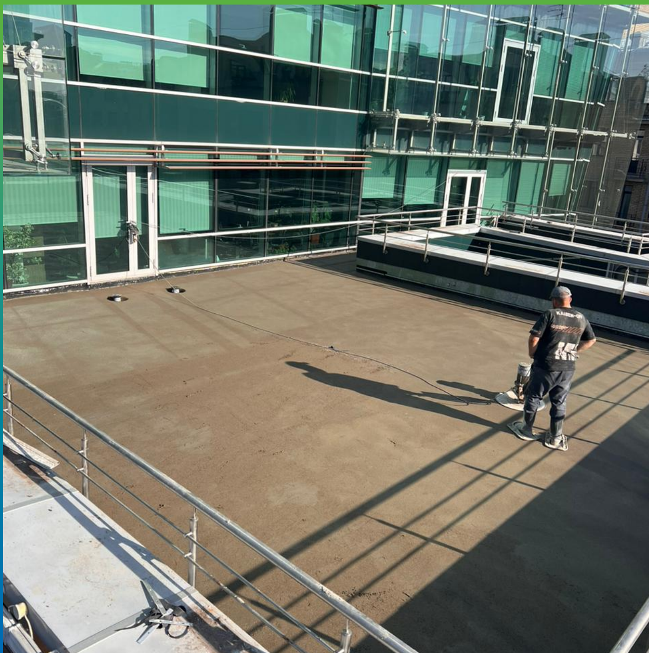
Стяжка, выполненная поверх ЭПДМ мембраны Прелести СТ
