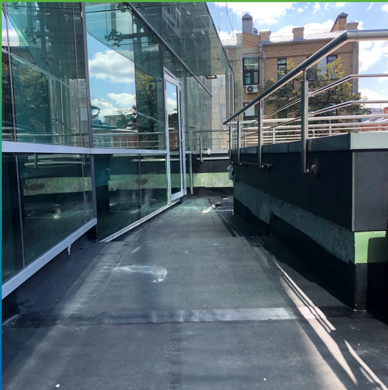
Завершение работ перед заливкой стяжки
