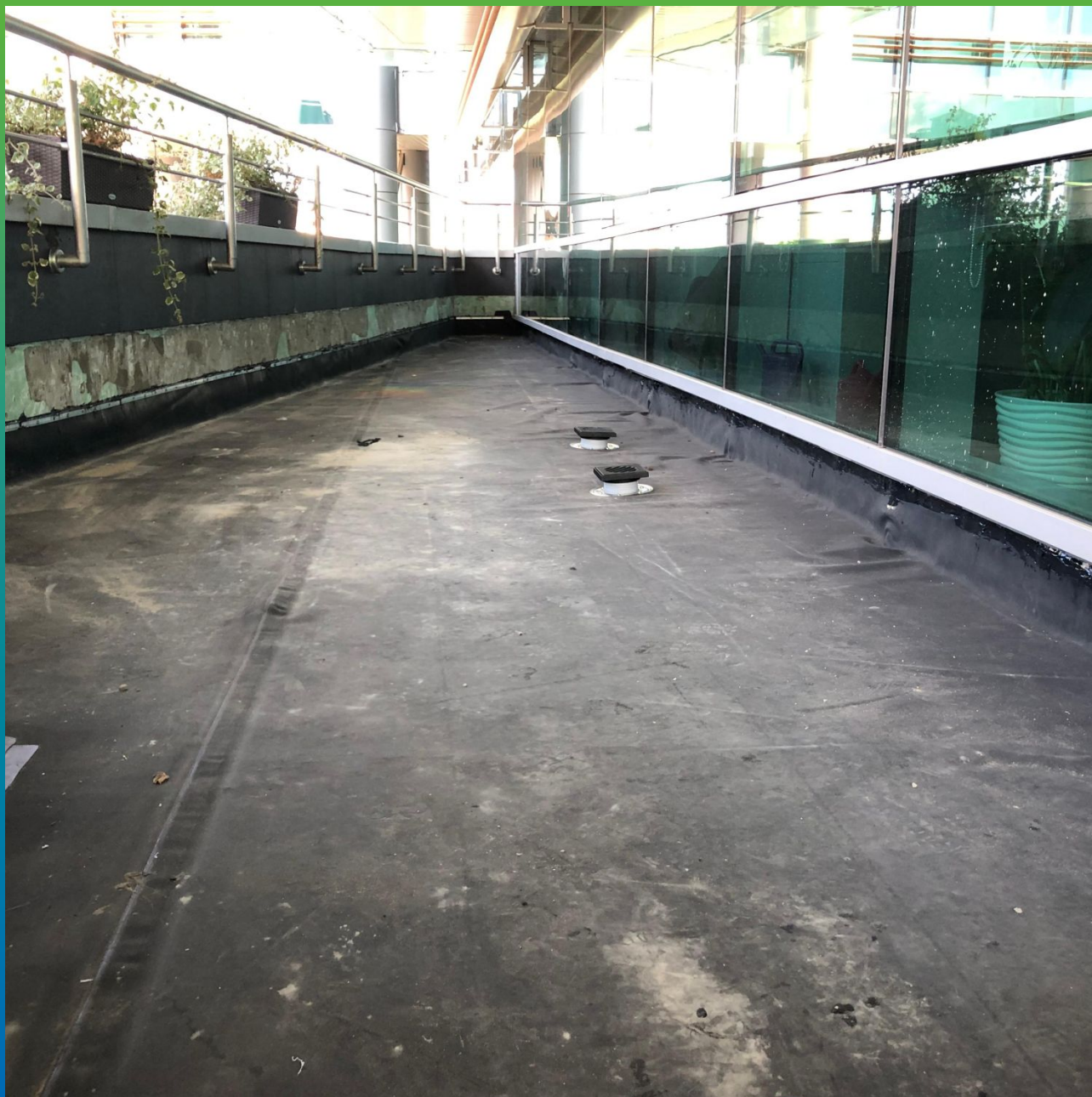
Завершение работ перед заливкой стяжки
