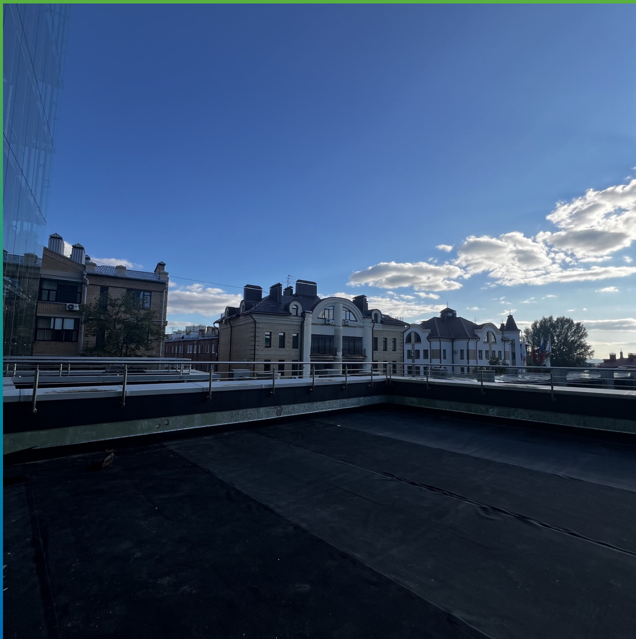
Завершение работ перед заливкой стяжки
