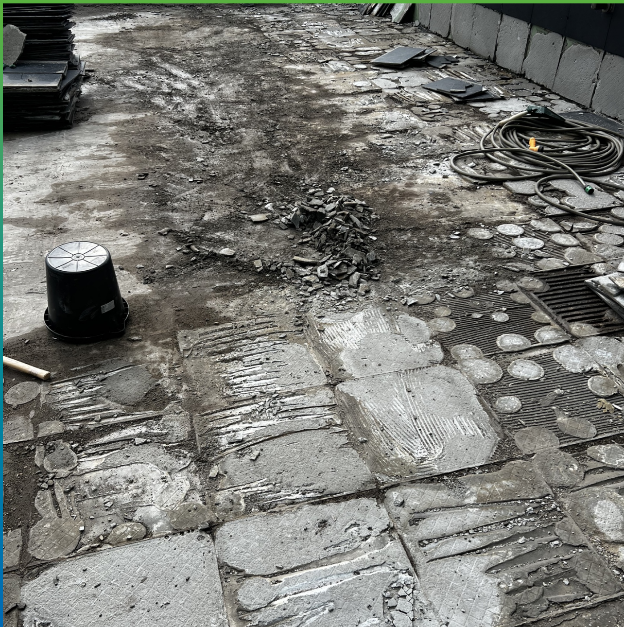
Демонтаж плитки и плиточного клея
