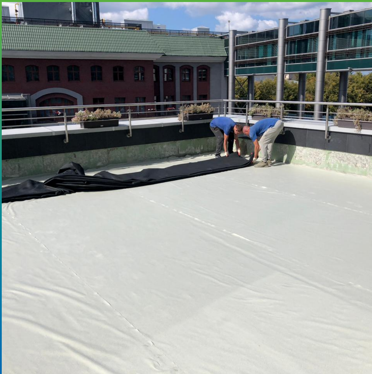
Укладка заранее вулканизированных полотен ЭПДМ мембраны Прелести СТ
