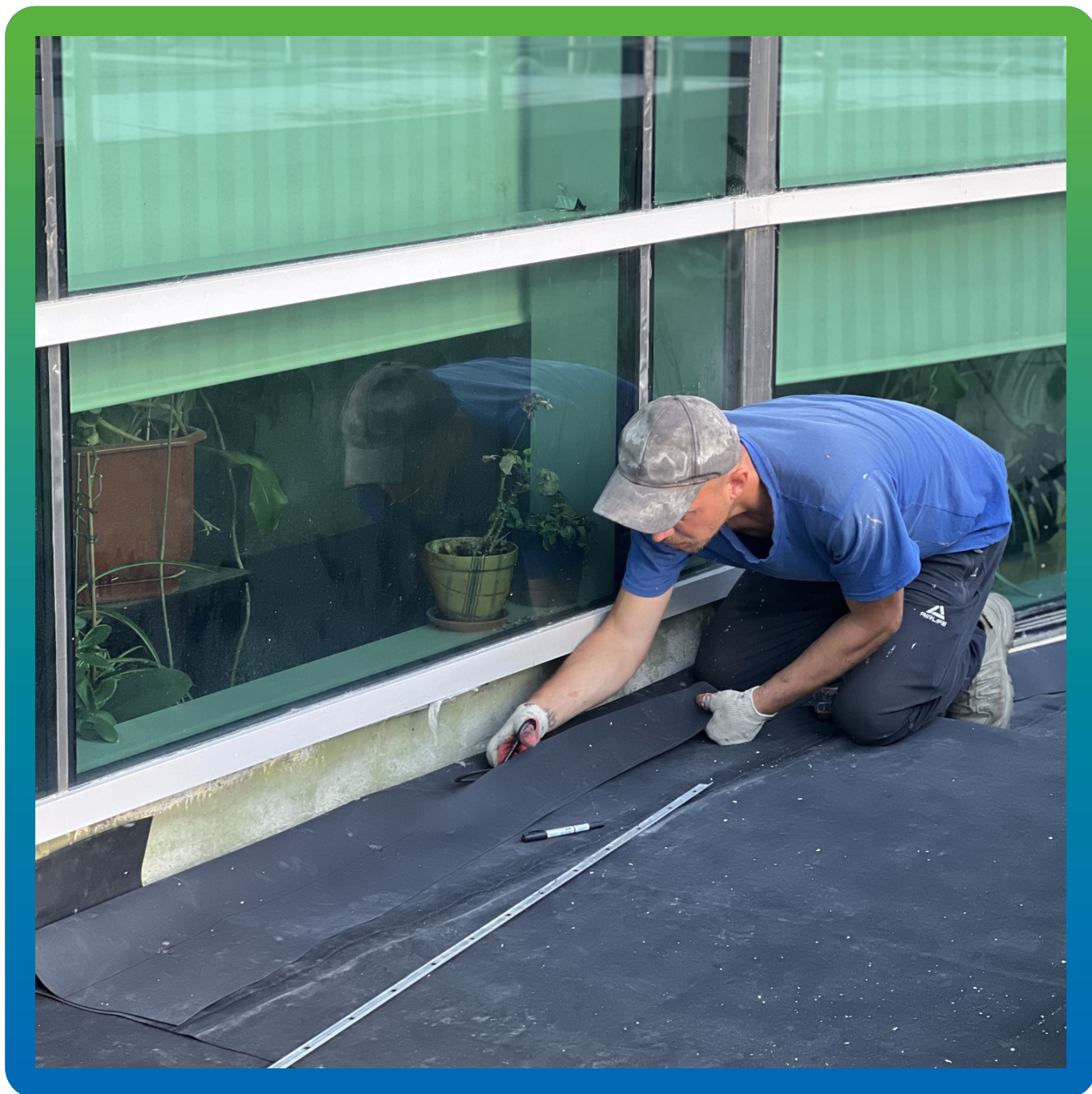
Подгонка краев для крепления на прижимную планку
