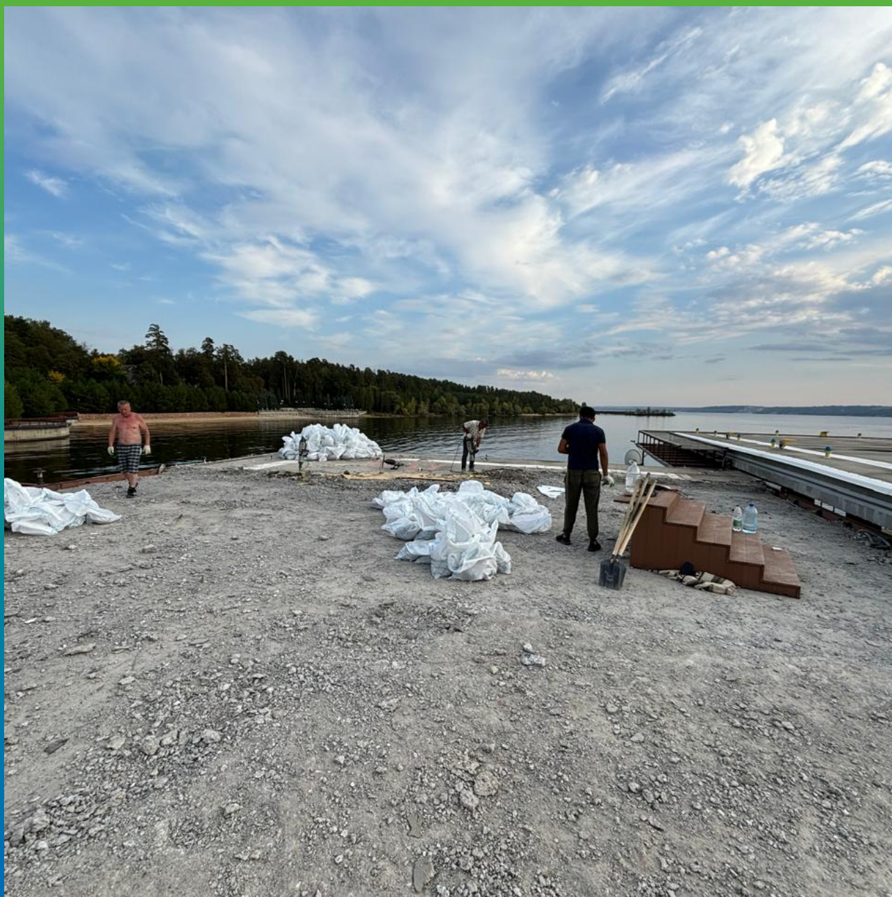
Вид вертолетной площадки при демонтаже старой стяжки
