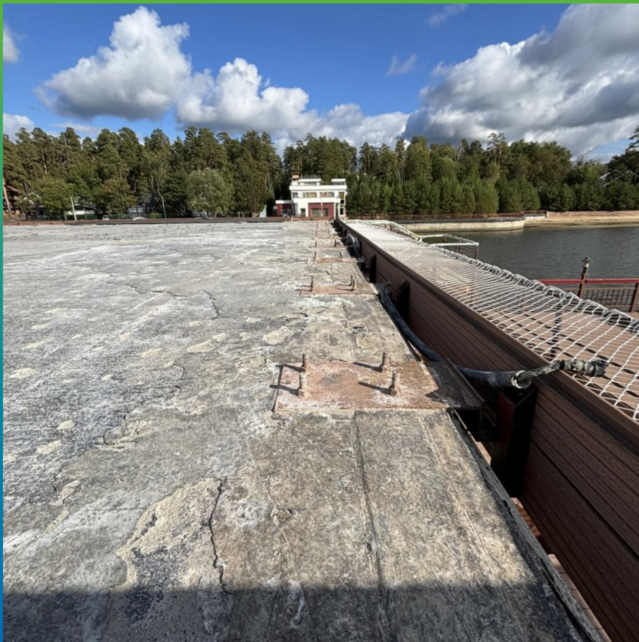
Вид вертолетной площадки при демонтаже старой стяжки
