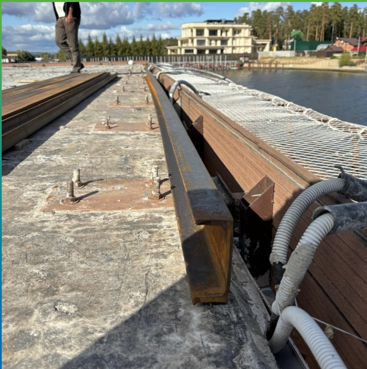
Монтаж металлического уголка-ограничителя
