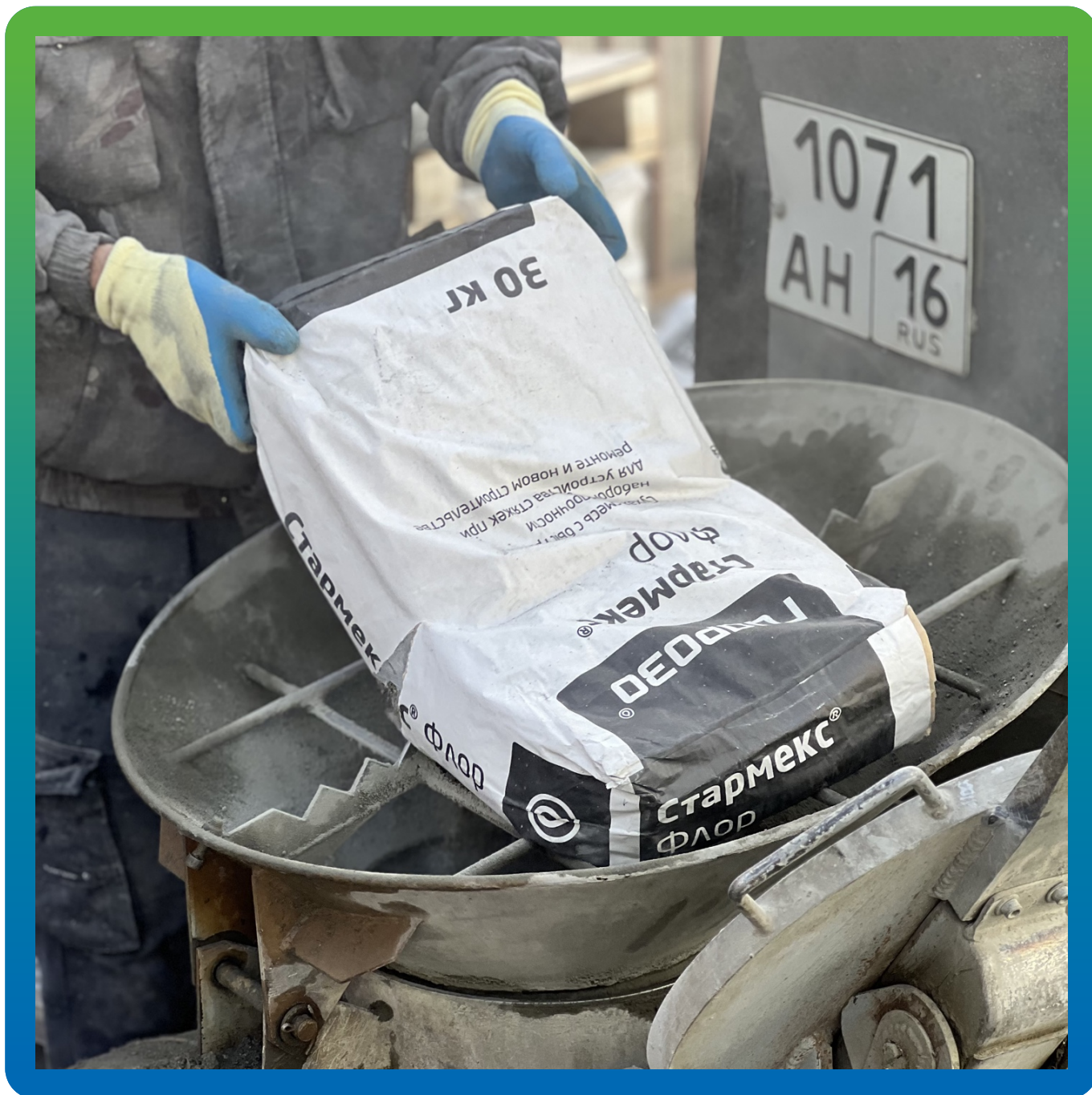
Приготовление состава Стармекс Флор в стационарном бетононасосе
