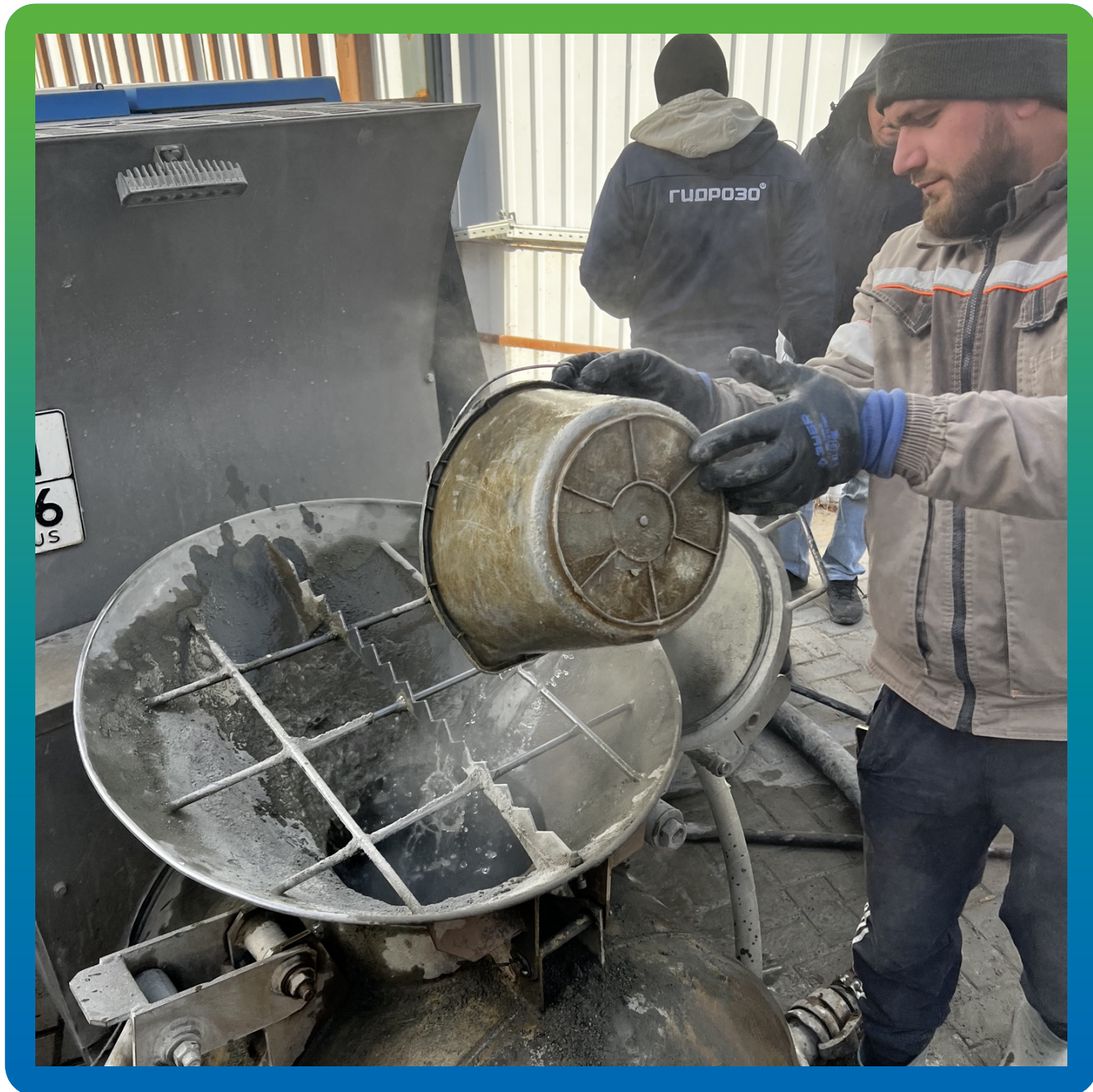
Затворение состава водой
