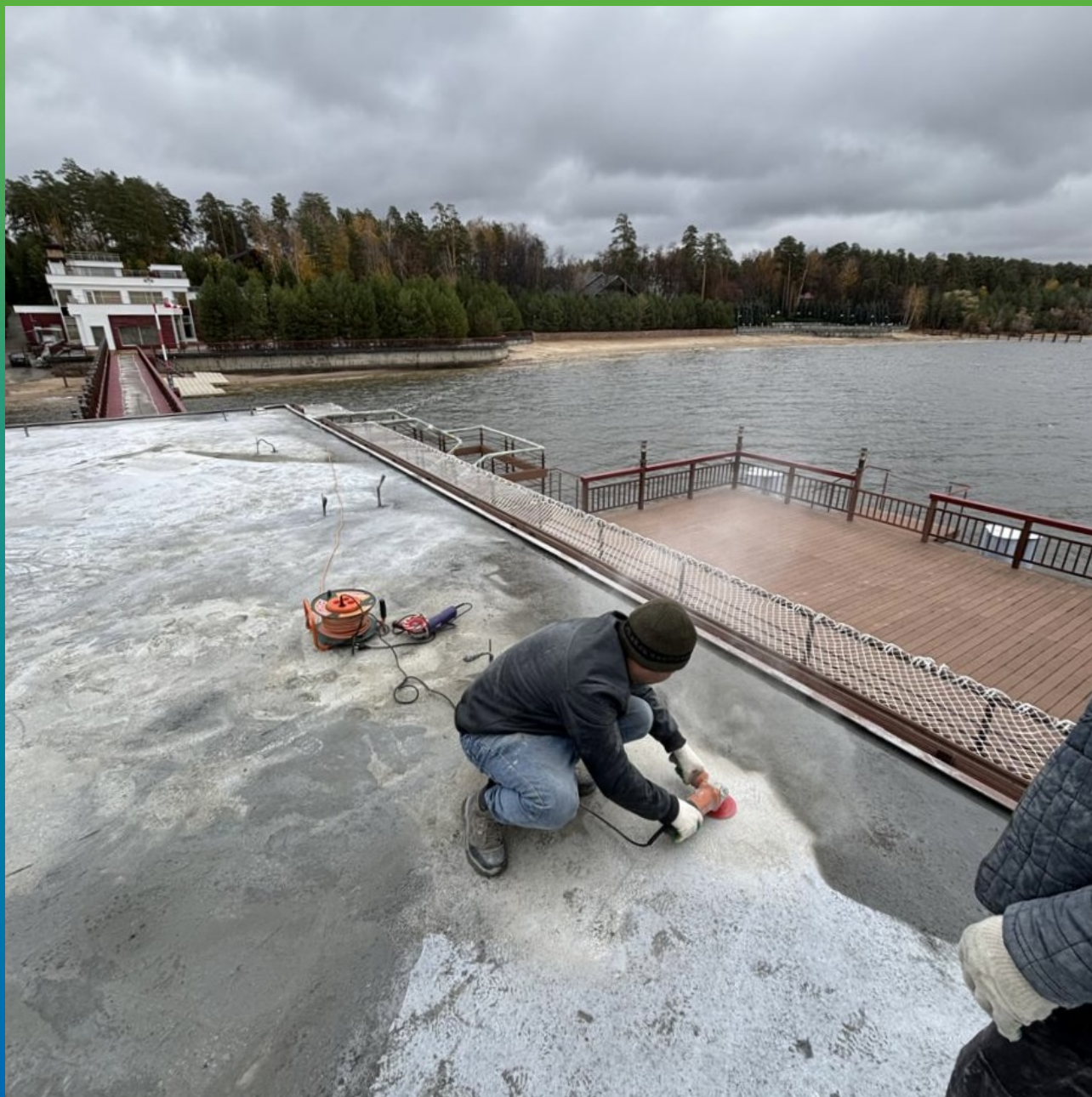
Шлифовка поверхности
