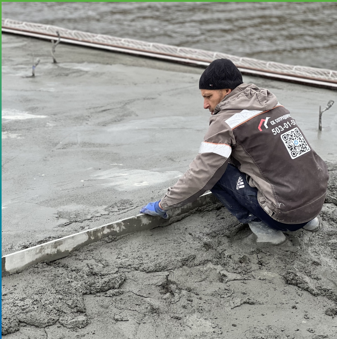
Вытягивание состава и создание уклона
