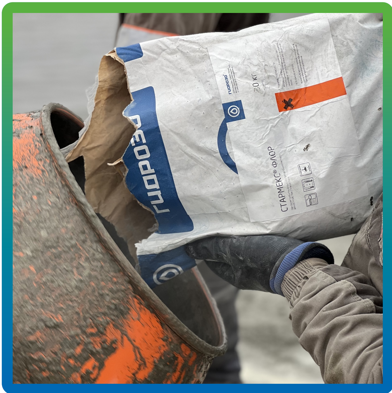
Замешивание состава в мобильной мешалке
