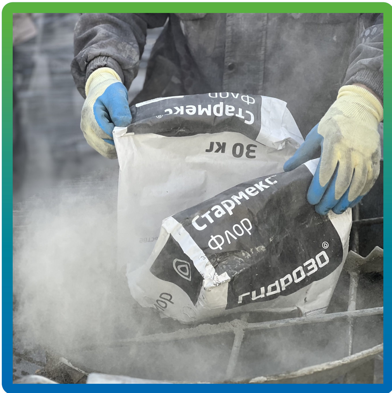
Приготовление состава Стармекс Флор в стационарном бетононасосе
