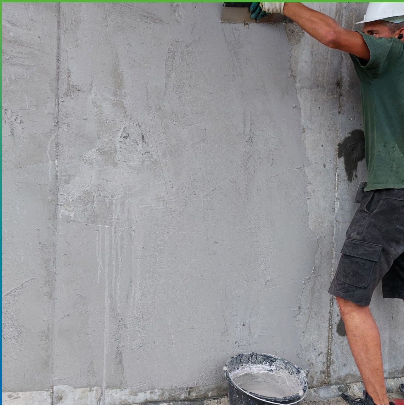
Нанесение шпателем эластичной гидроизоляции Стармекс Сил Флекс
