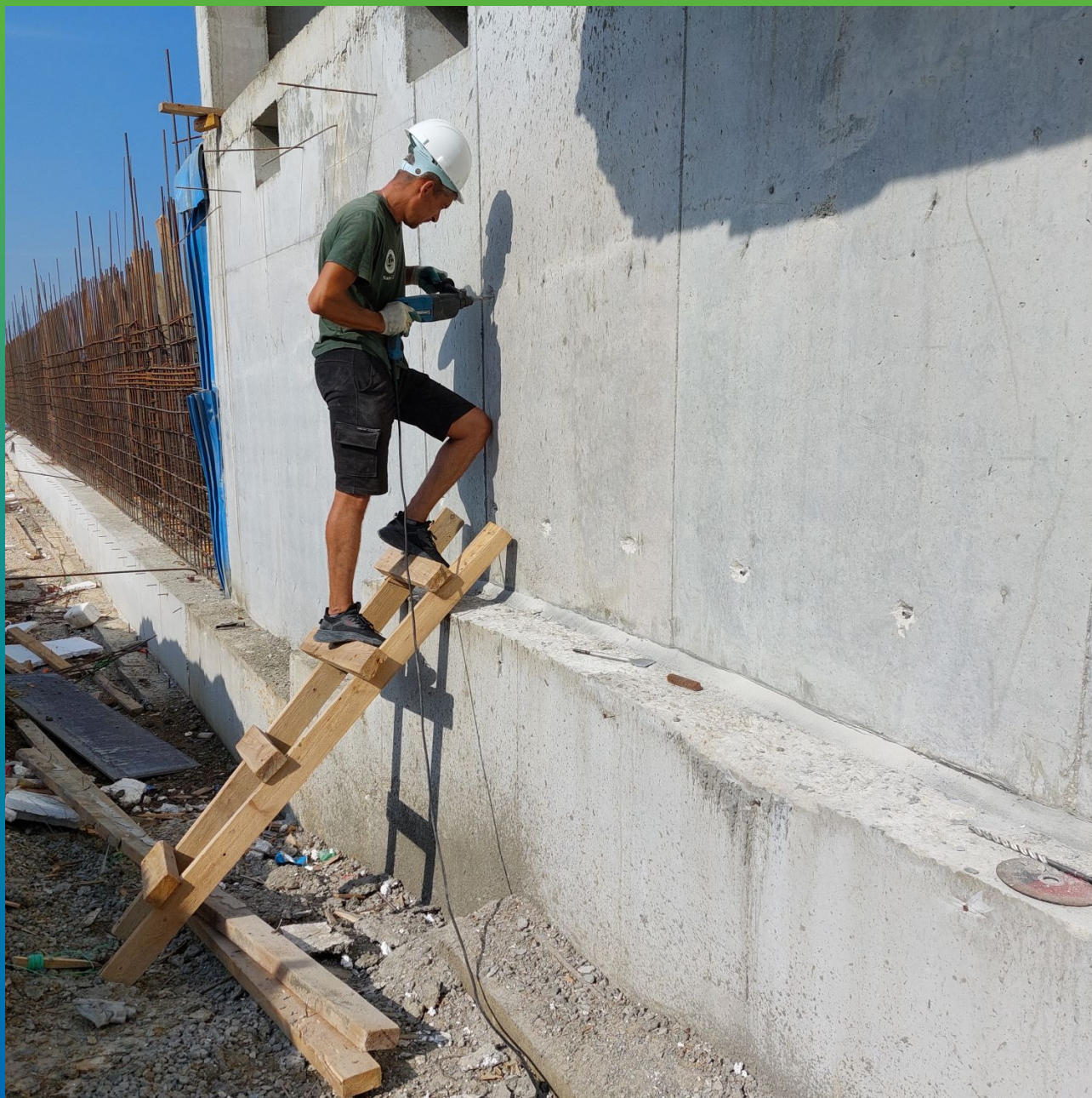
Расшивка отверстий из под шпилек
