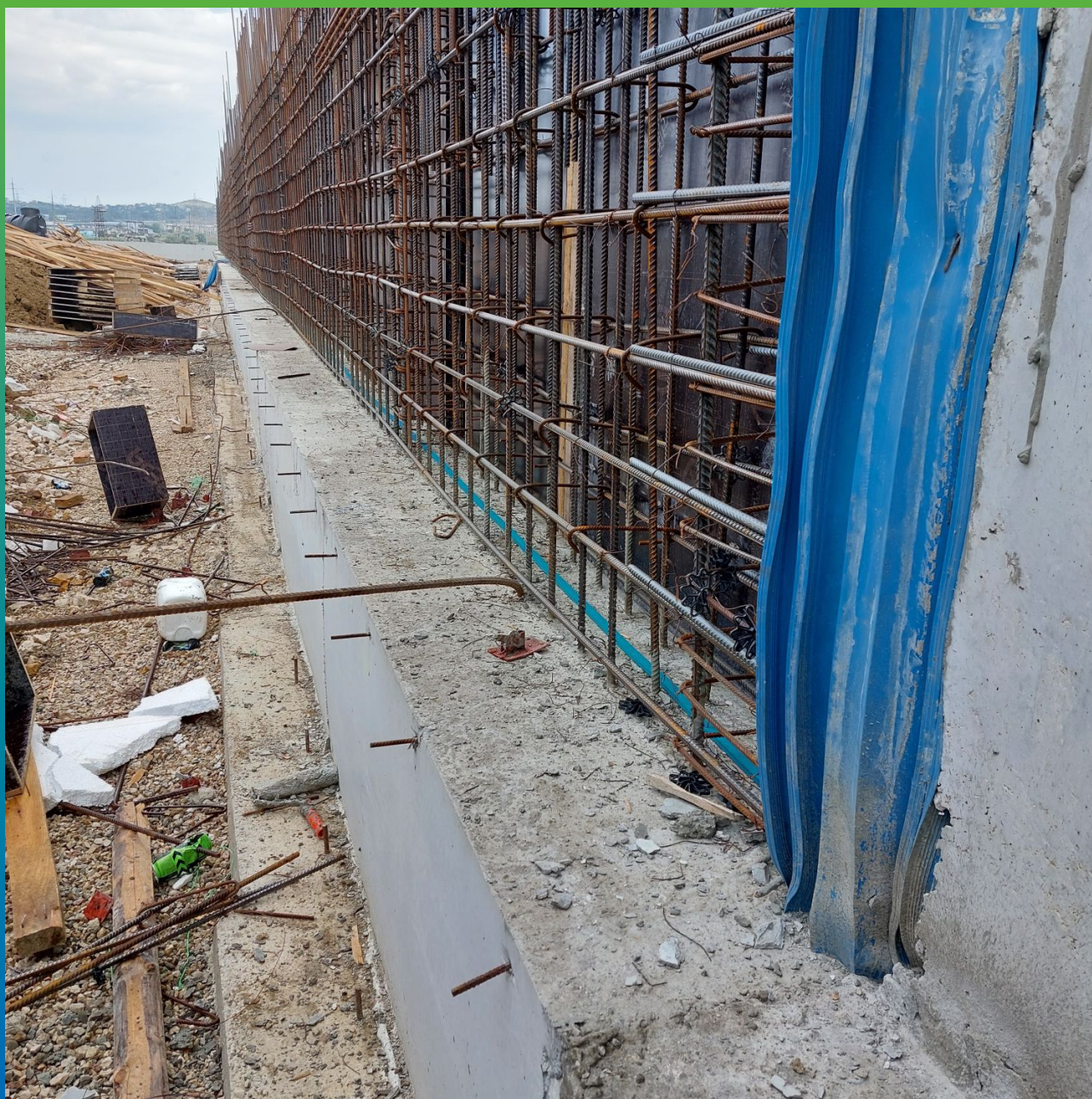
Уложенный шнур Манодил Свелл X-2010 в холодном шве перед бетонированием
