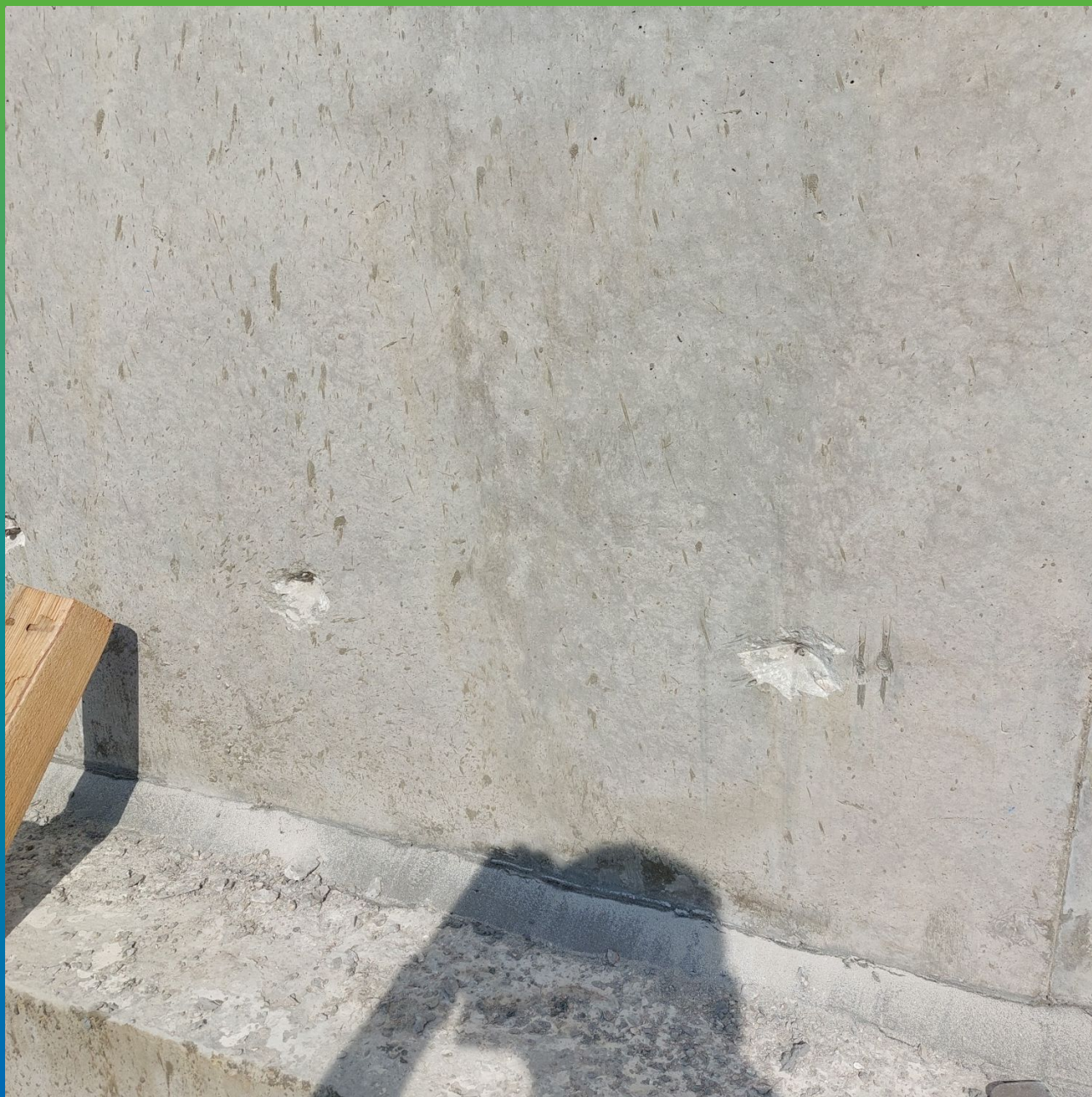
Расшитые отверстия от шпилек опалубки перед чеканкой ремонтным составом
