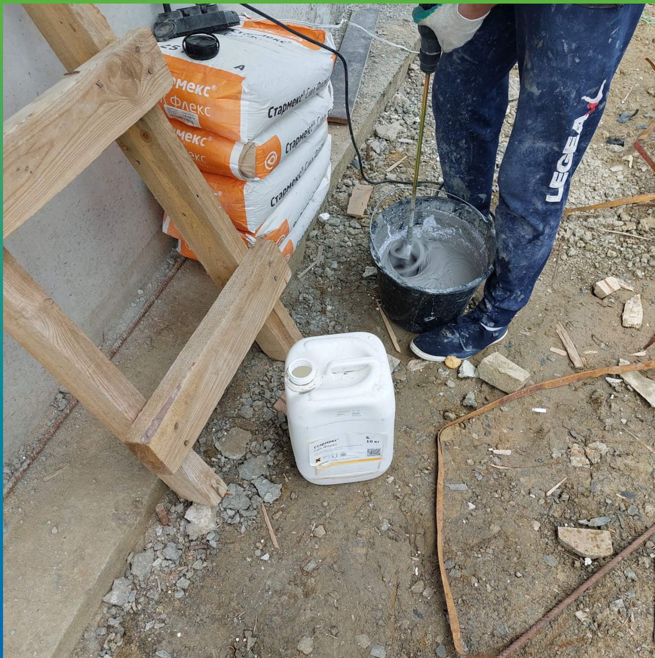
Приготовление эластичной гидроизоляции Стармекс Сил Флекс
