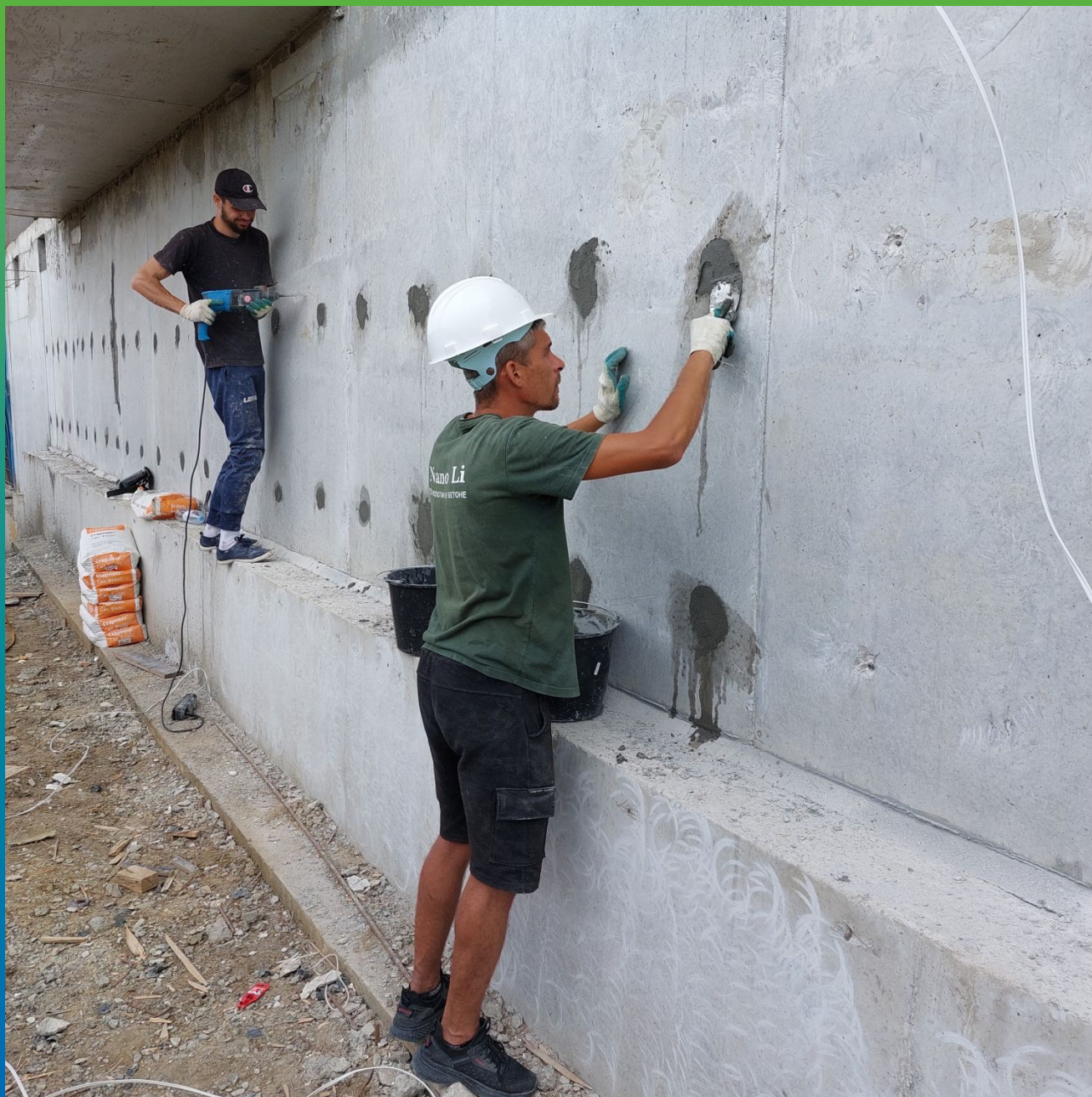
Заделка отверстий от шпилек ремонтным составом Стармекс РМЗ
