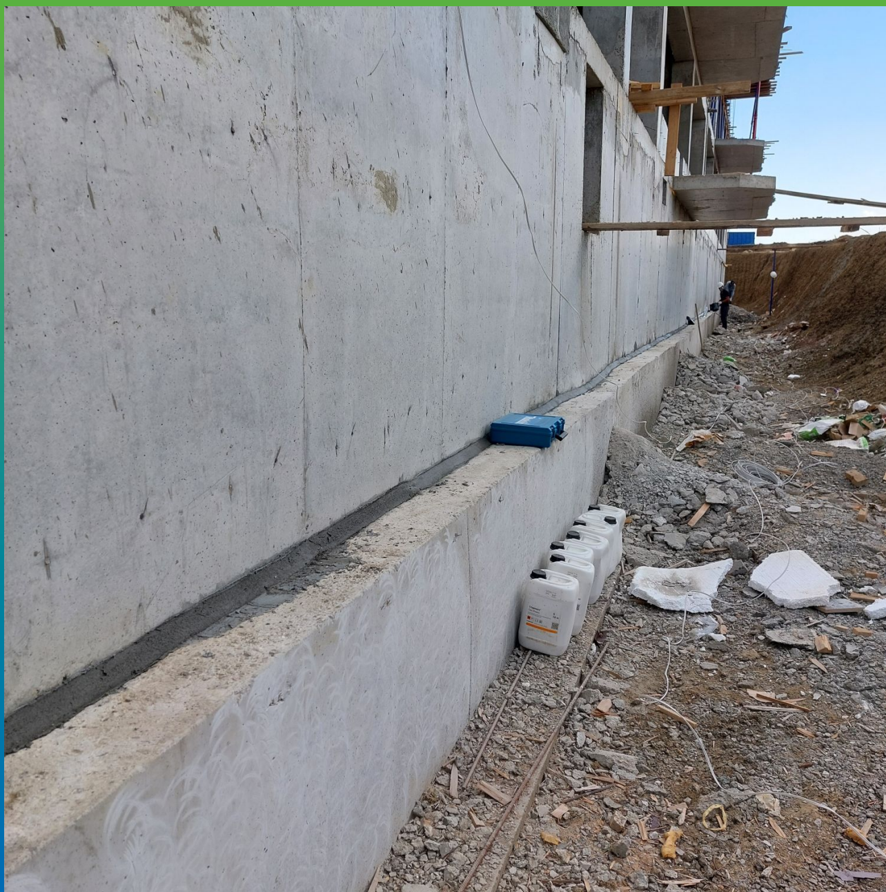
Галтель из ремсостава Стармакс РМЗ на примыкании плита-стена
