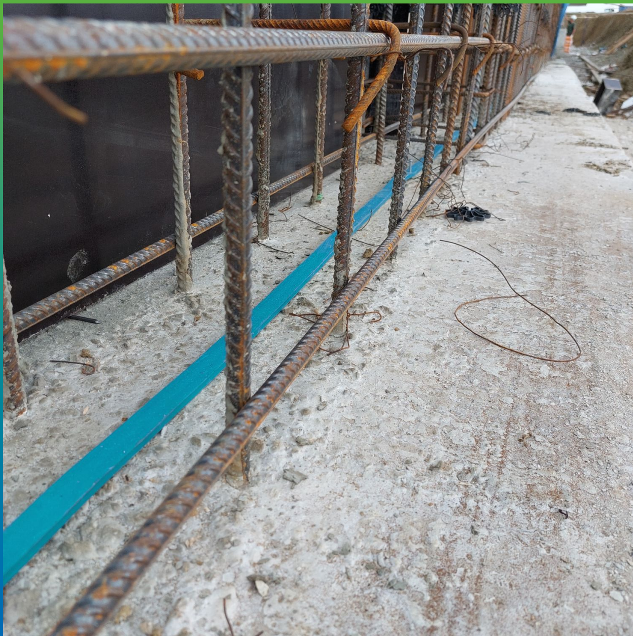
Проложенный гидрофильный шнур Манодил Свелл X-2010 перед заливкой стены
