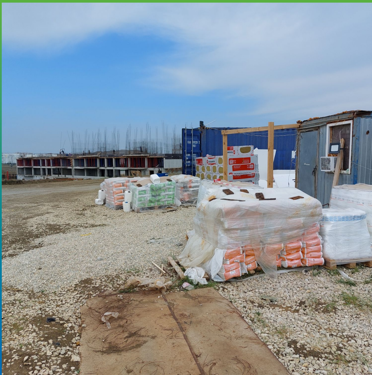
Материалы Гидрозо на объекте
