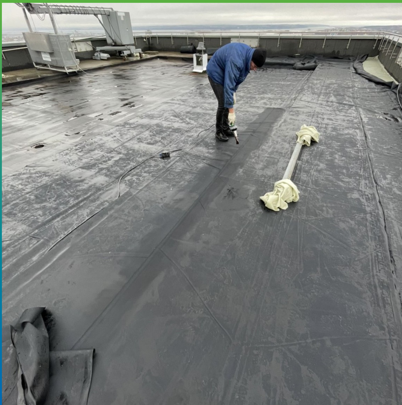
Подготовка полотен мембраны к вулканизации между собой
