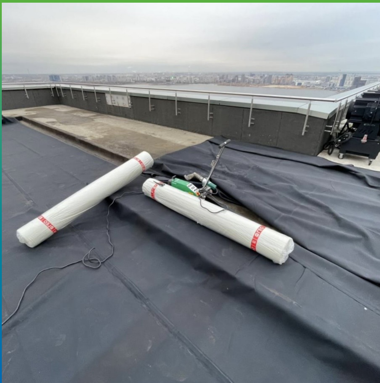
Раскладка полотен мембраны
