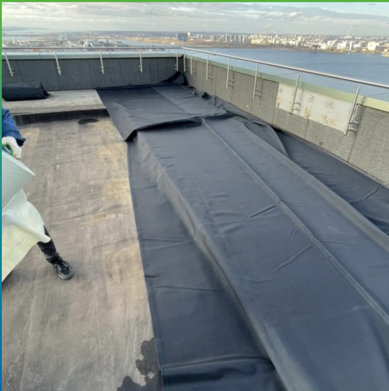
Раскладка полотен мембраны
