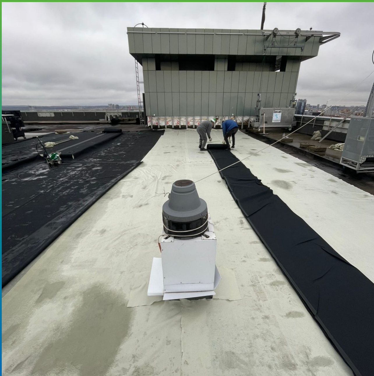
Укладка геотекстиля для последующего монтажа Преласты СТ. Раскладка полотен мембраны
