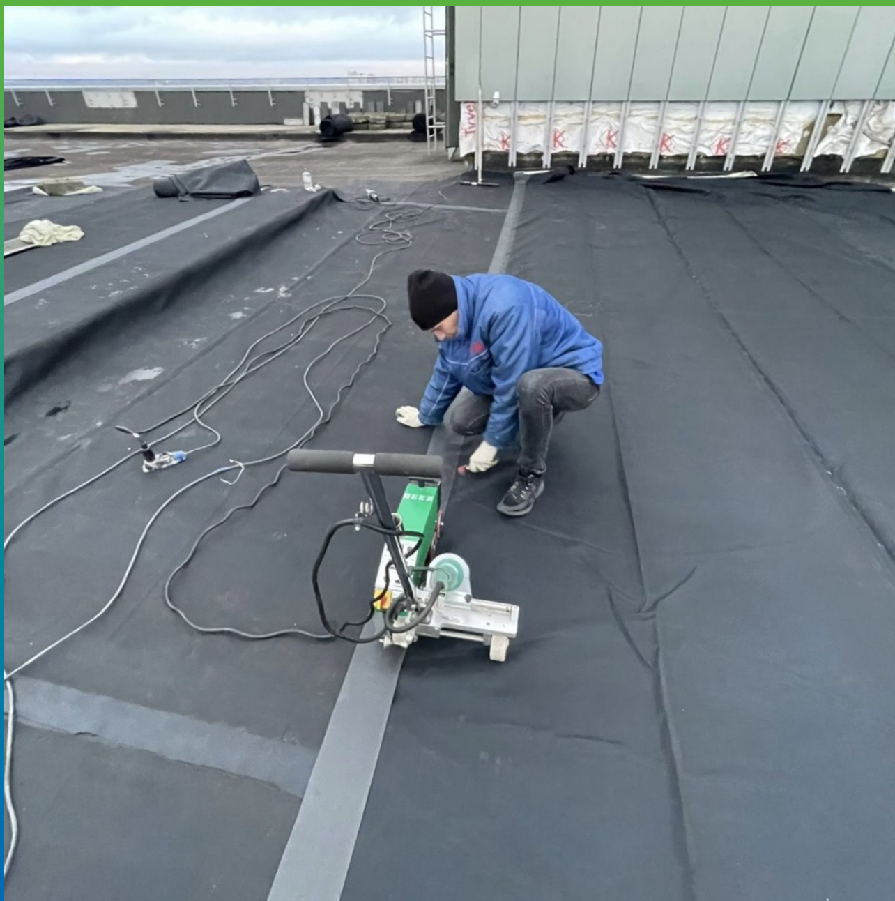
Вулканизация полотен мембраны между собой
