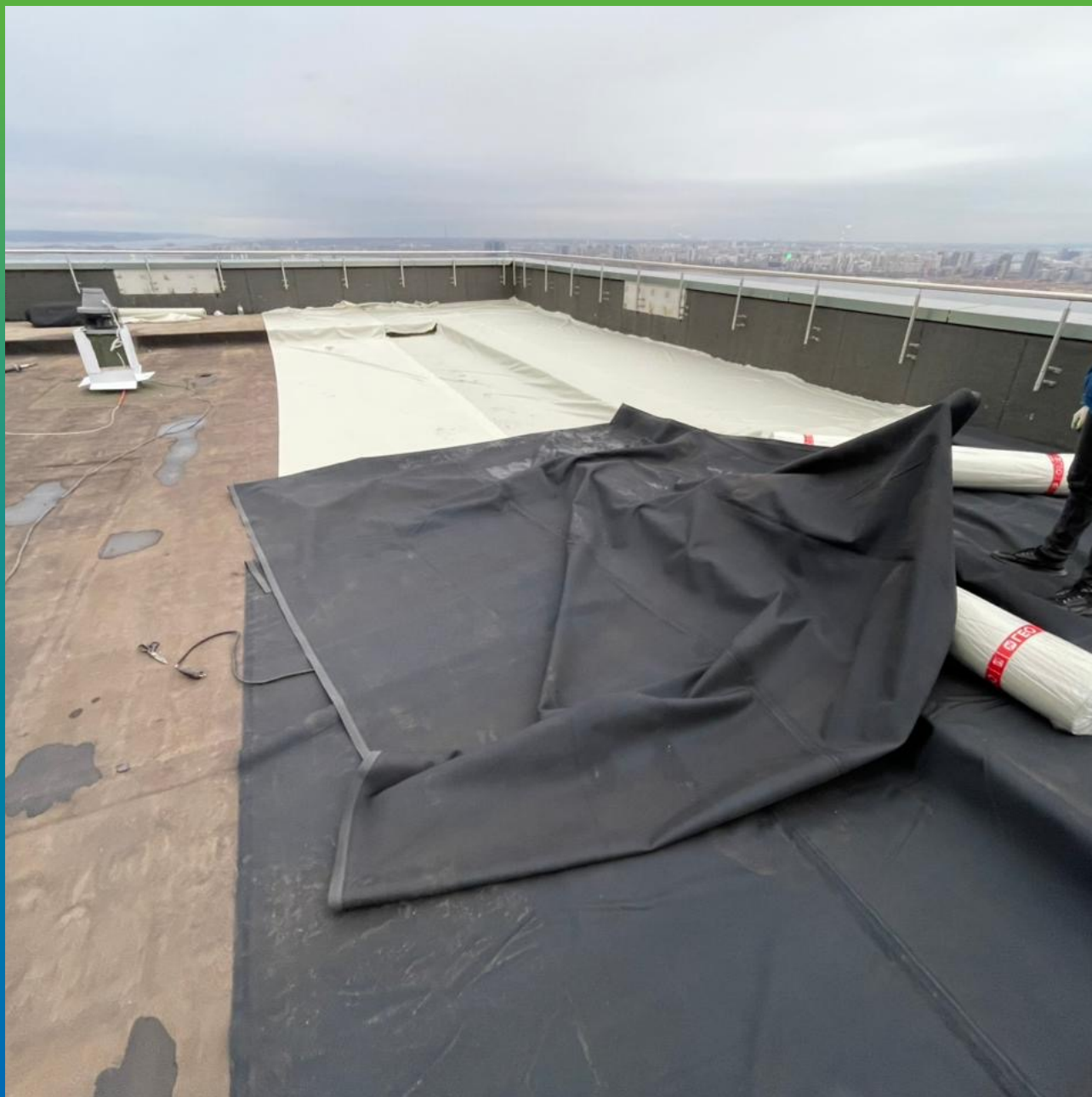
Раскладка полотен мембраны
