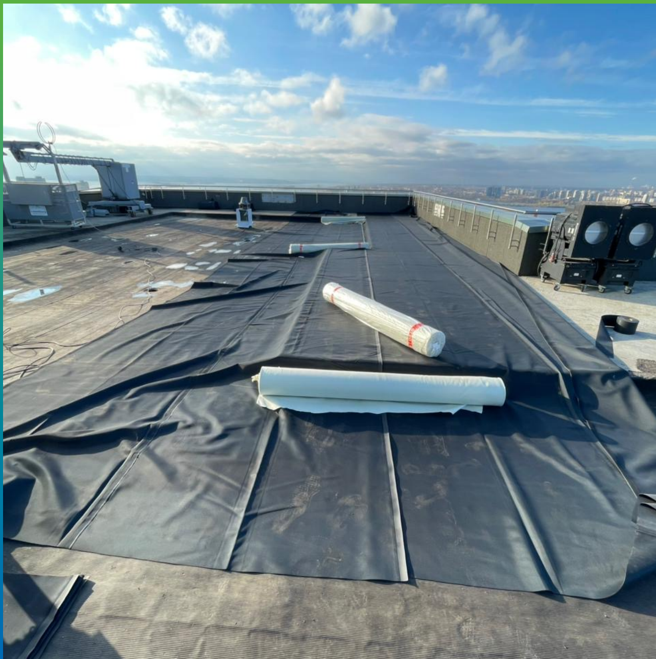
Раскладка полотен мембраны
