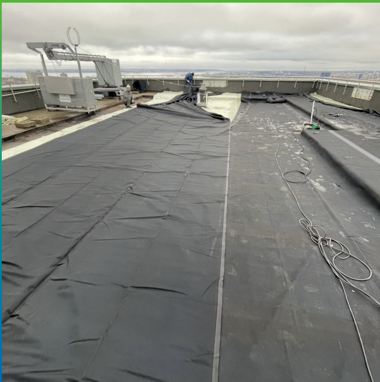
Раскладка полотен мембраны
