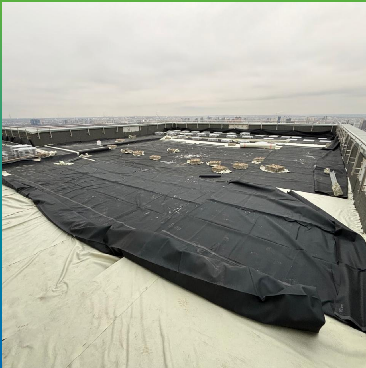
Раскладка полотен мембраны
