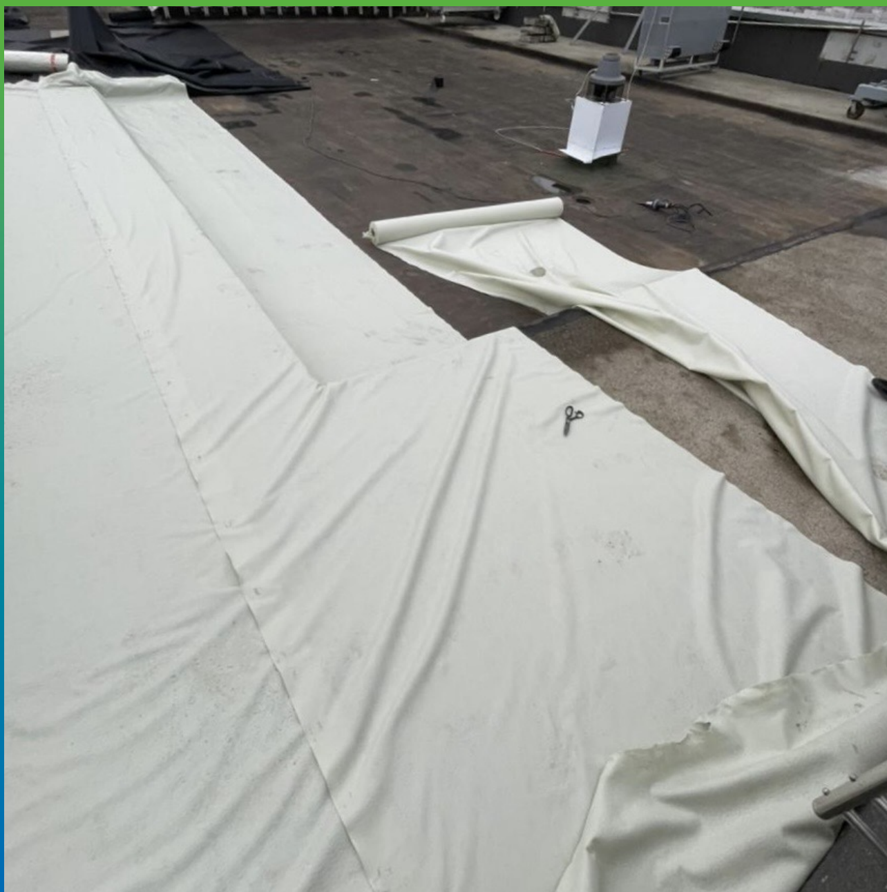
Укладка геотекстиля для последующего монтажа Прелести СТ
