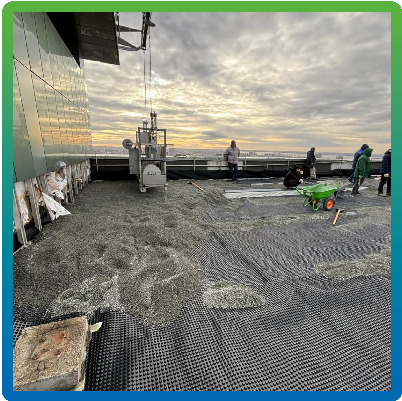
Распределение балласта по кровле
