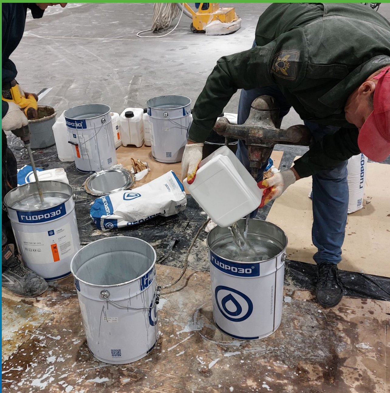
Подготовка наливного эпоксида ДенТоп ЭП 501
