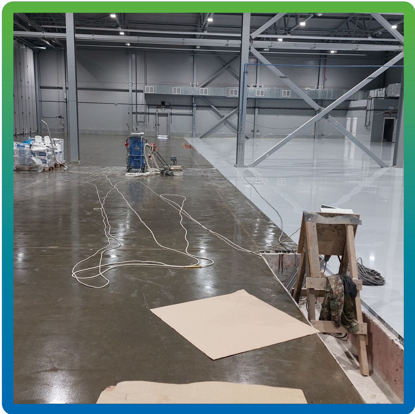
Одна захватка готова, вторая - подготовлена под нанесение
