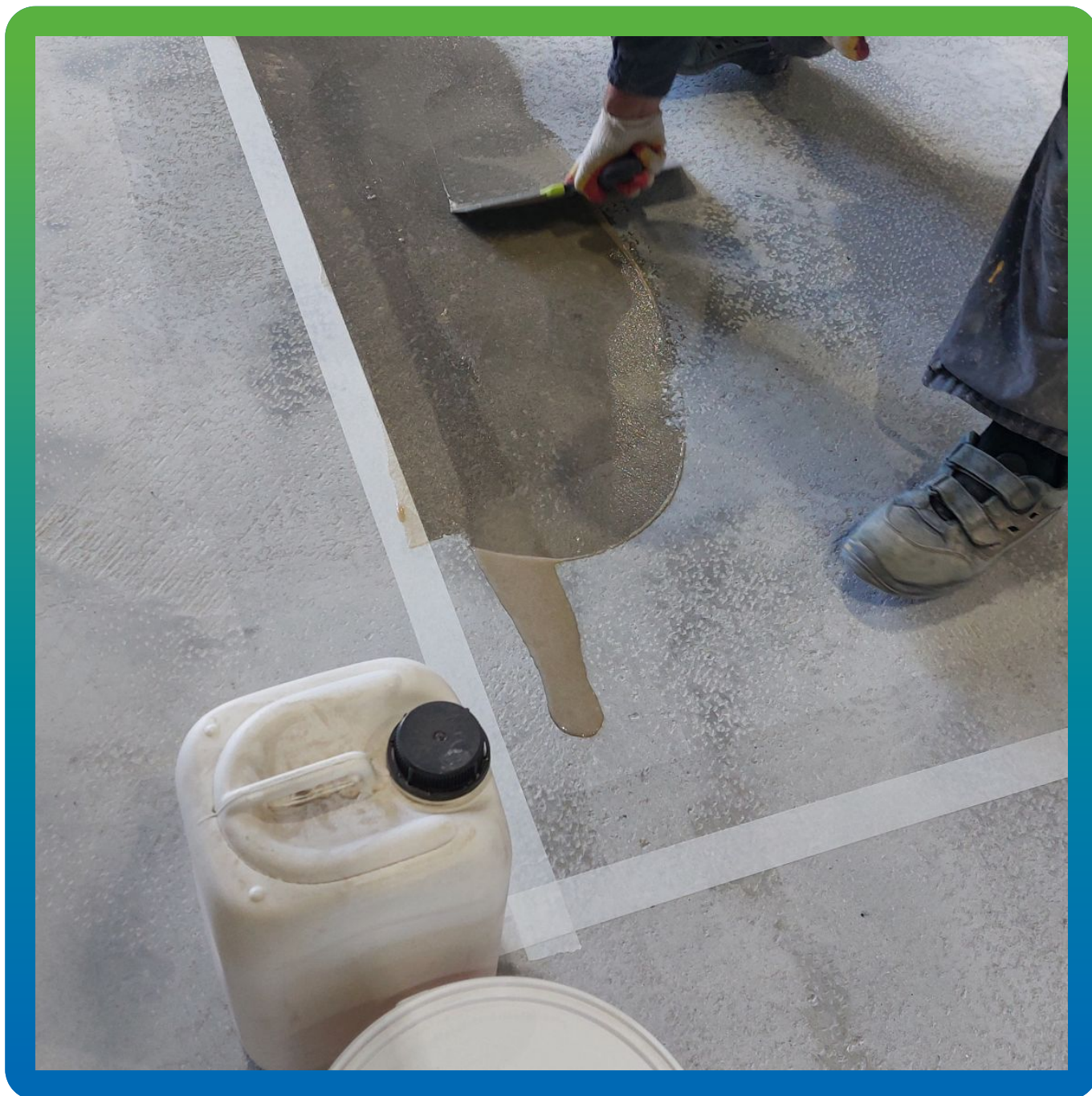
Нанесение грунтовки на тестовом участке с целью определения расхода
