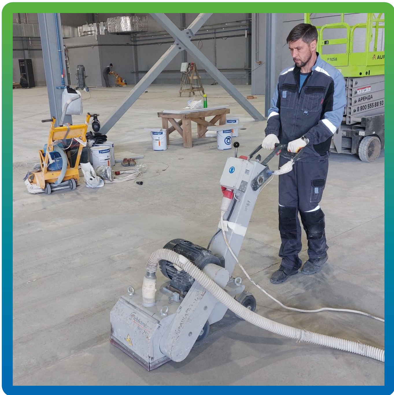
Фрезерование бетонного основания
