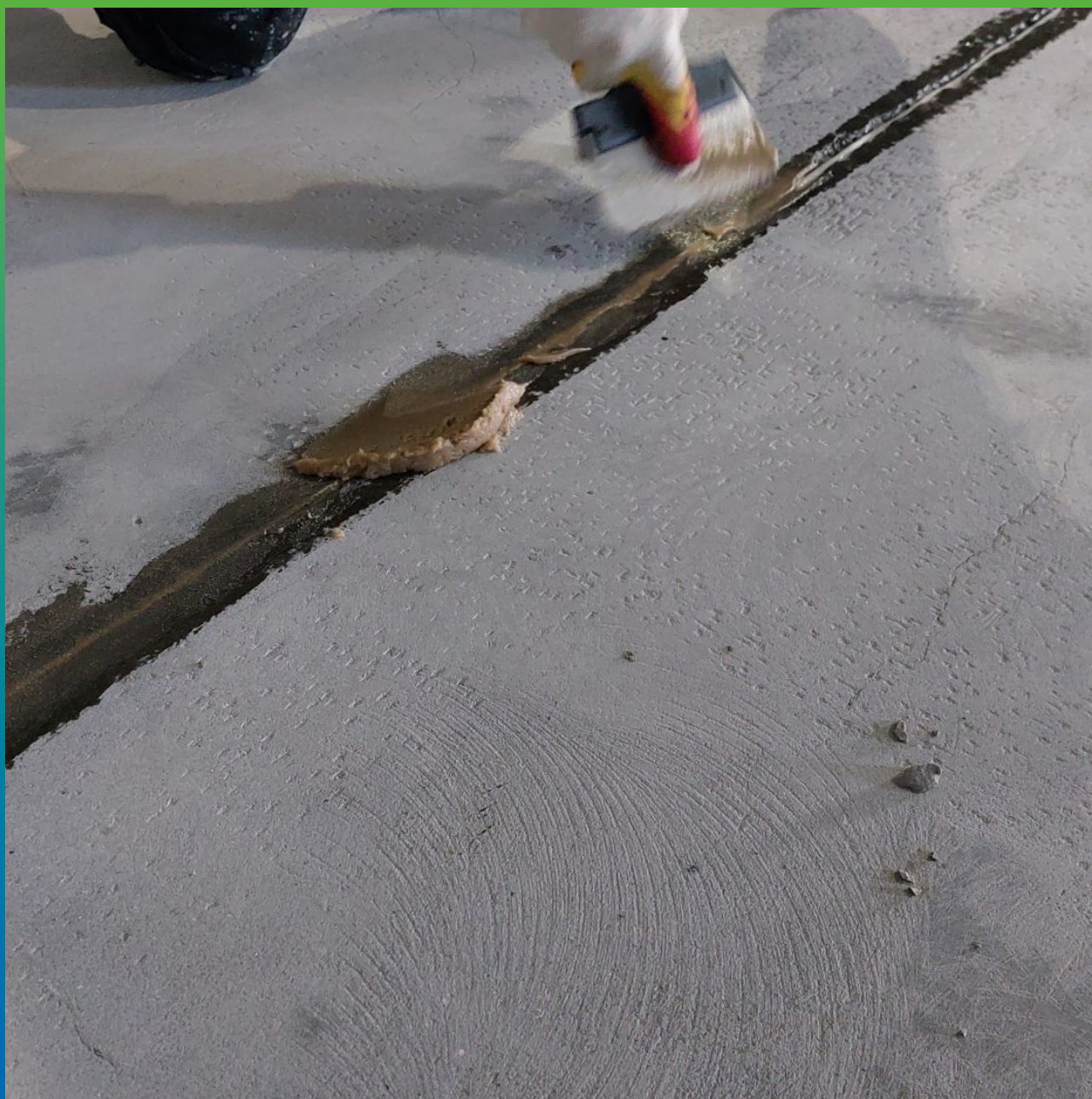
Шпаклевание швов эпоксидно-песчаной смесью
