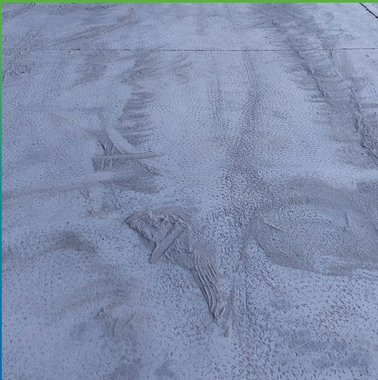
Структура поверхности после бучардирования
