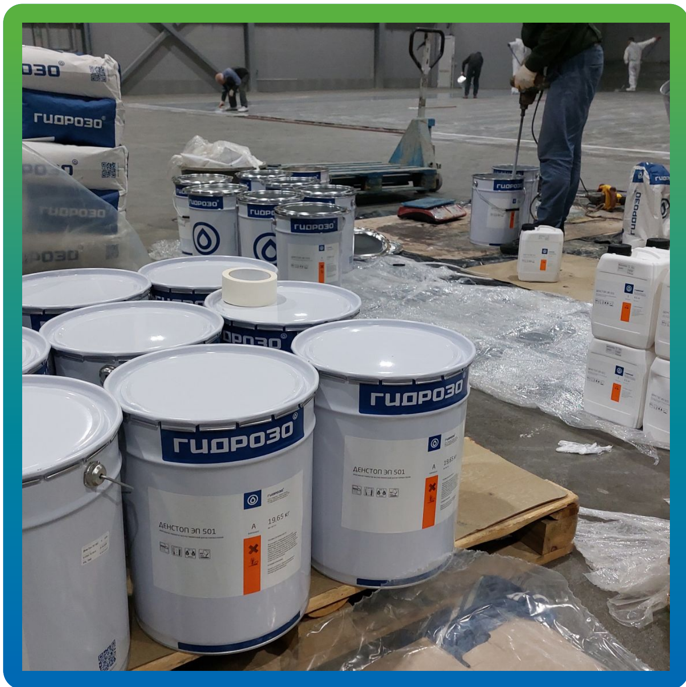
Приготовление базового цветного эпоксидного состава ДенСтон ЭП 501
