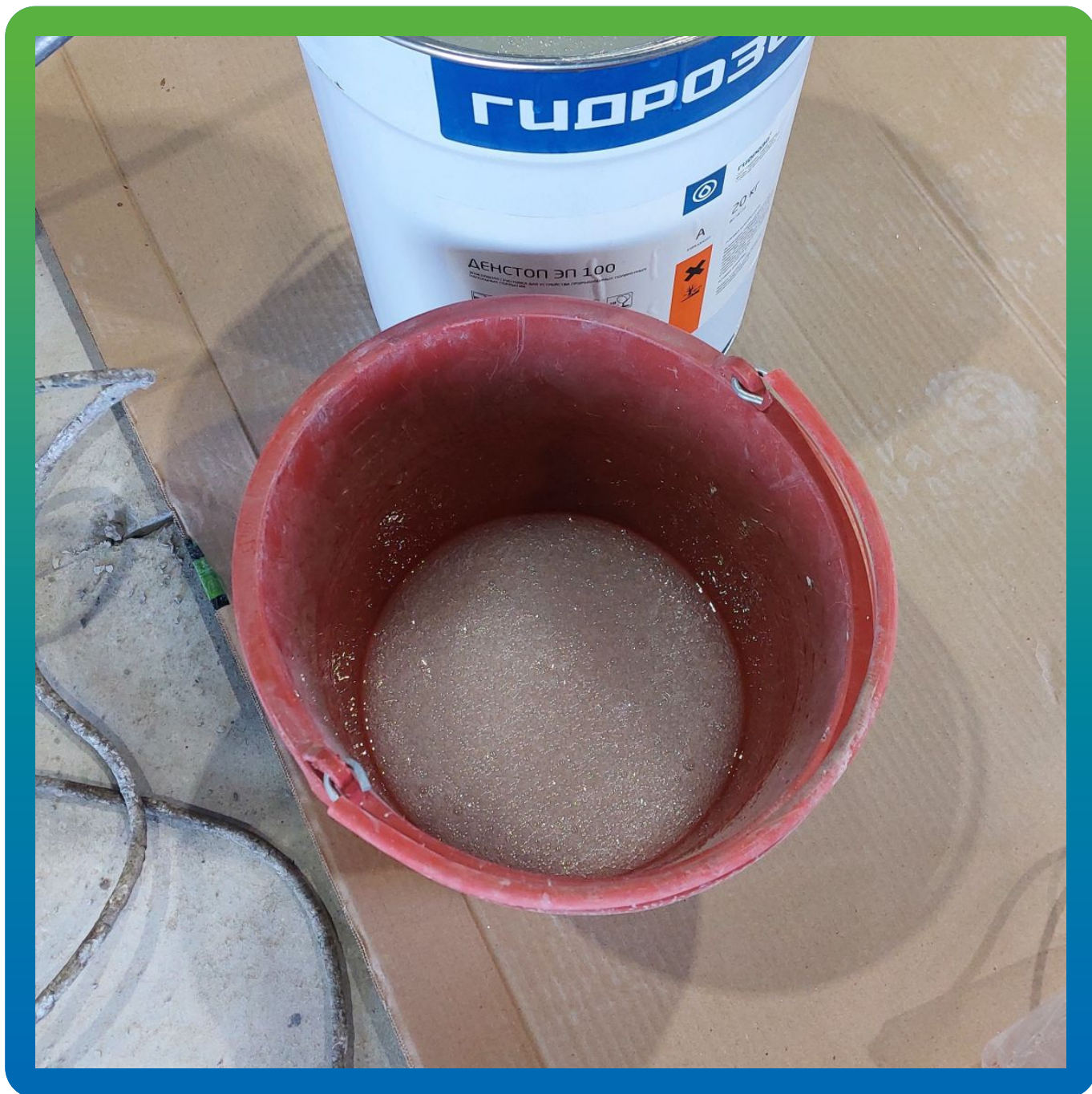
Подготовка эпоксидного грунта ДенСтол ЭП 100 с песком кварцевым
