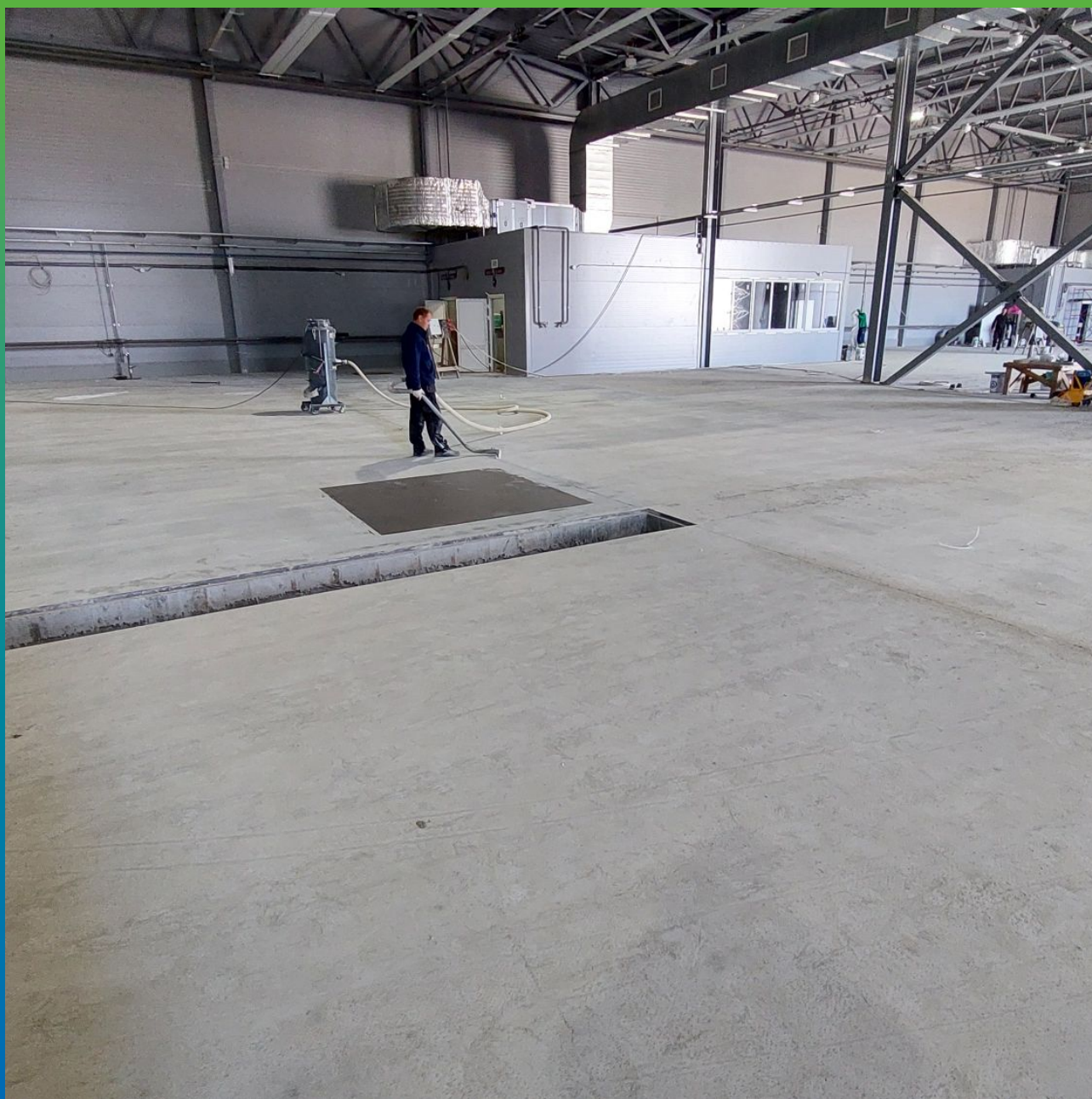
Обеспыливание после обработки бетона
