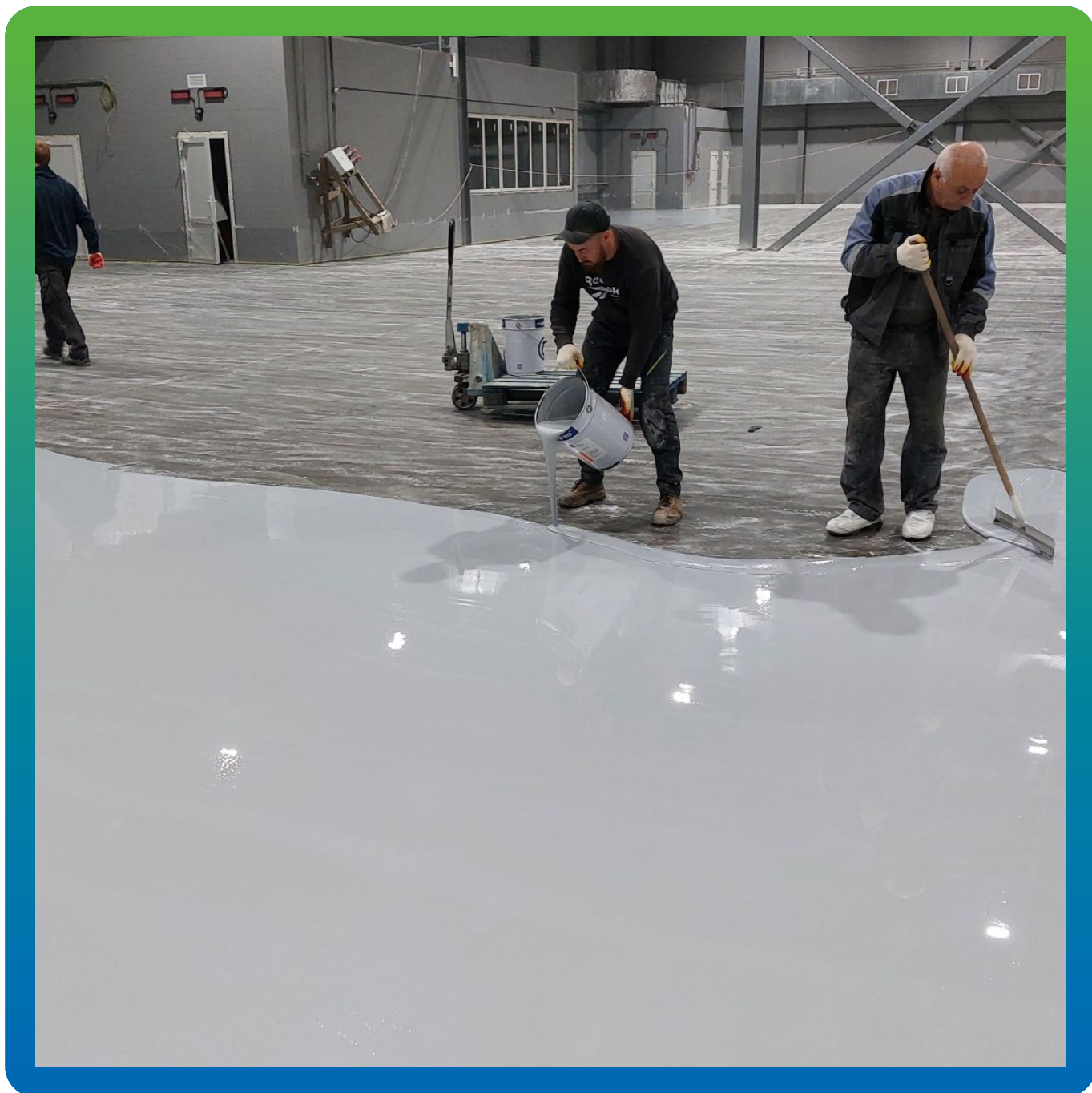
В процессе укладки наливного эпоксида ДенТоп ЭП 501
