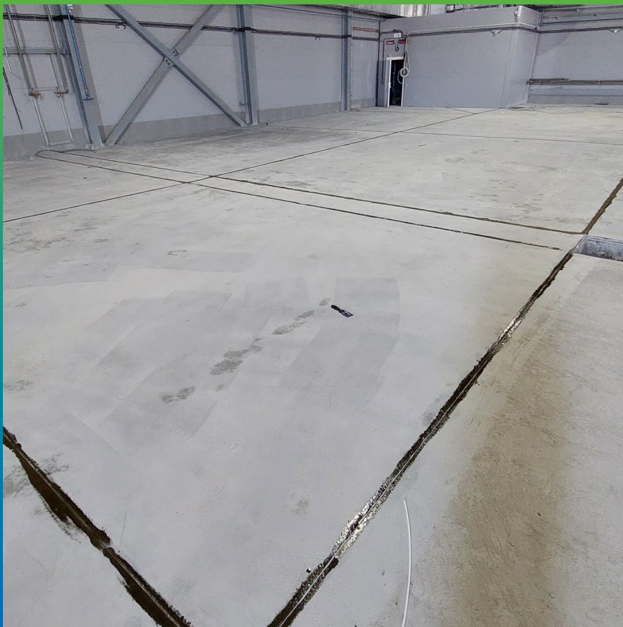
Загрунтованные усадочные швы
