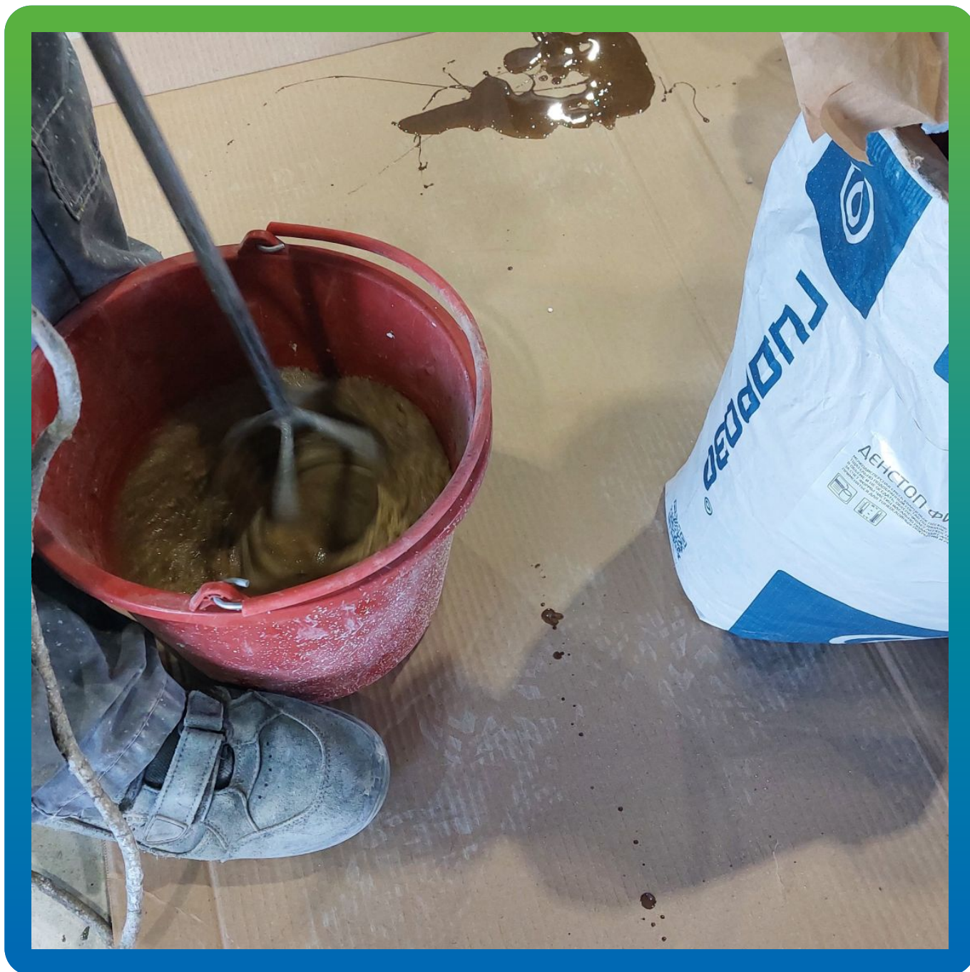
Приготовление шпаклевочной эпоксидно-песчаной массы
