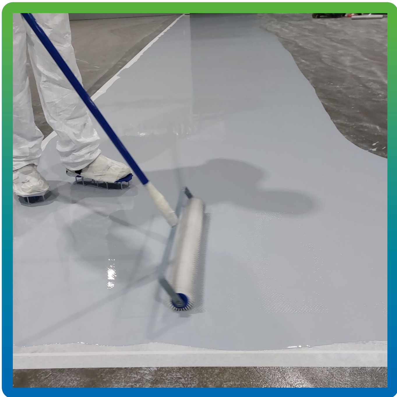
Прокатка эпоксида игольчатым валиком для исключения пузырения
