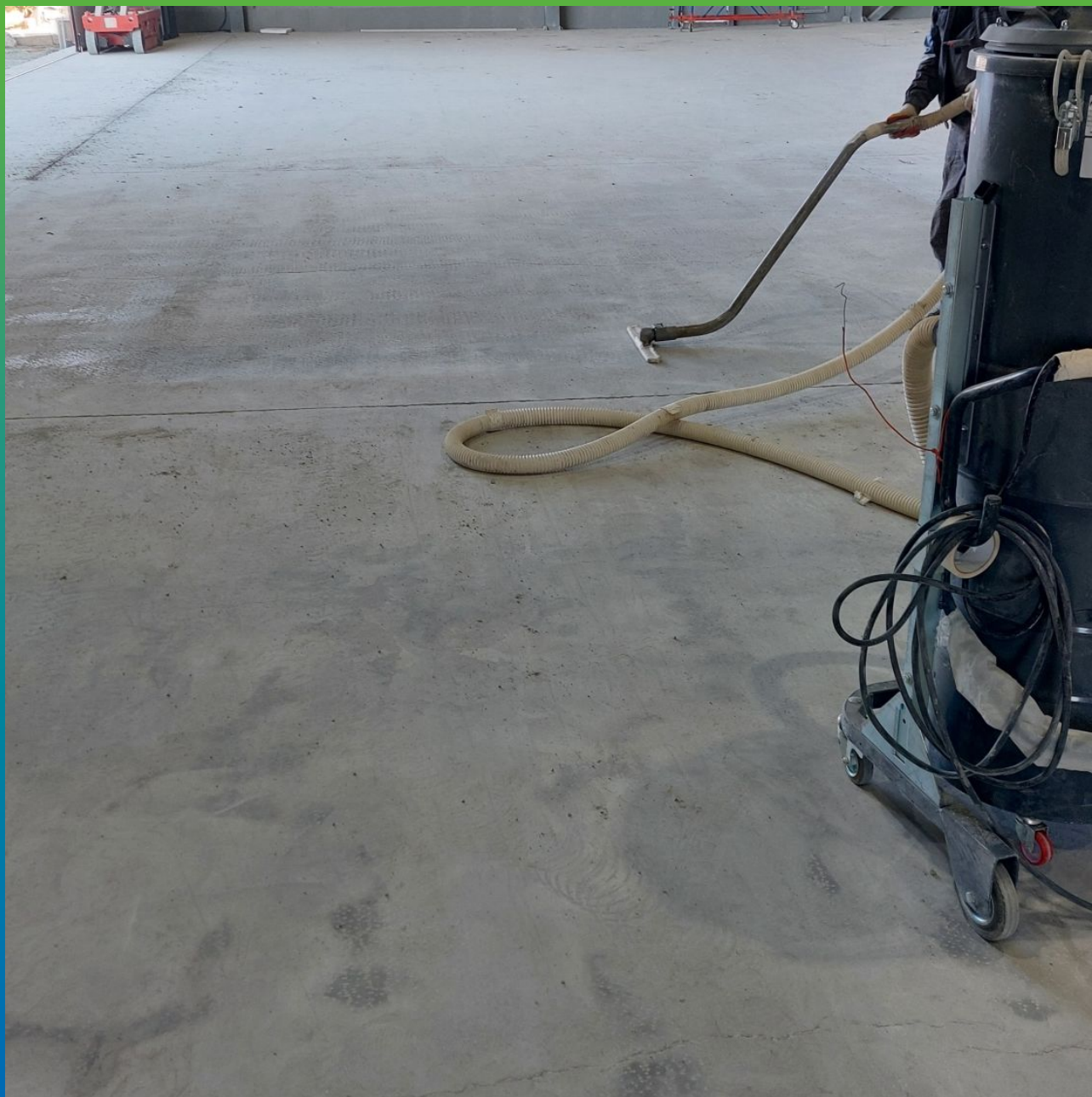
Обеспыливание промышленным пылесосом
