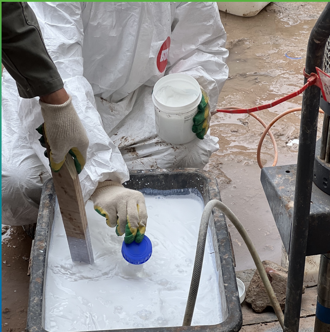
Добавление компонента Б геля
