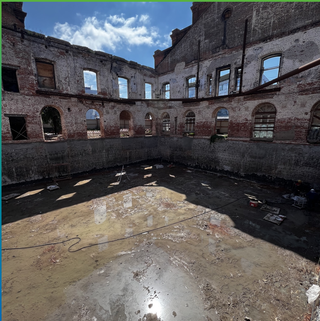
Вид стен с монтированными пакерами до инъектирования Манокрил Гель (общий вид)
