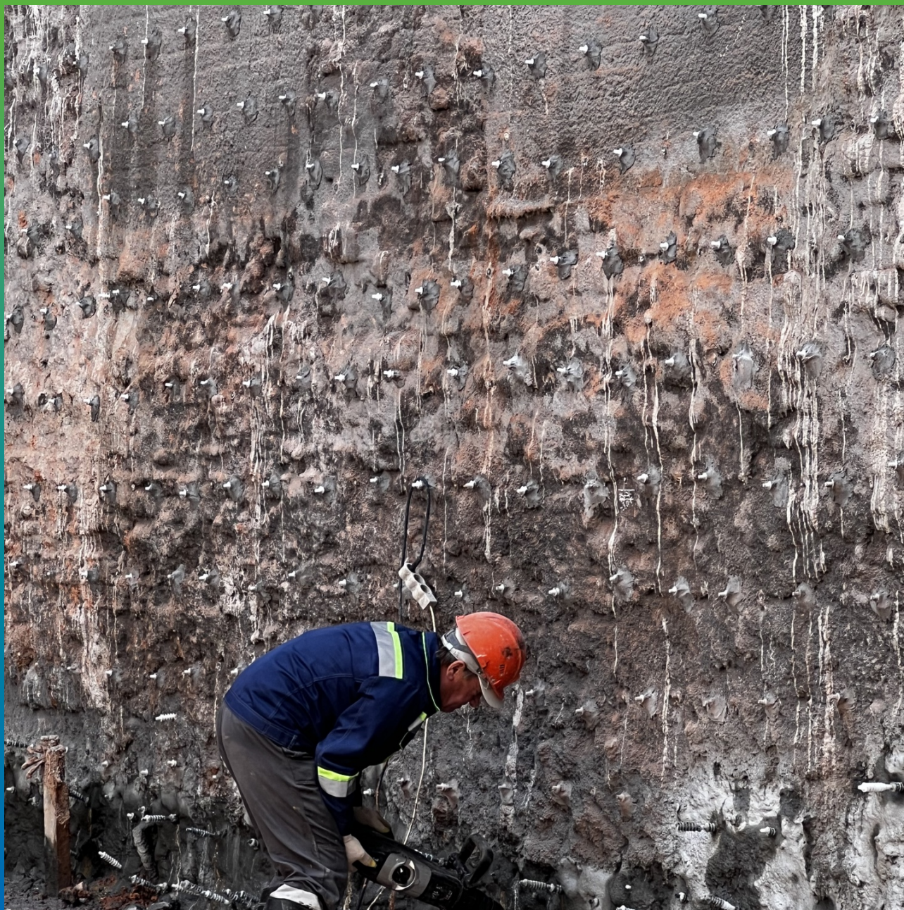
Бурение дополнительного ряда шпуров в зоне повышенного водопритока
