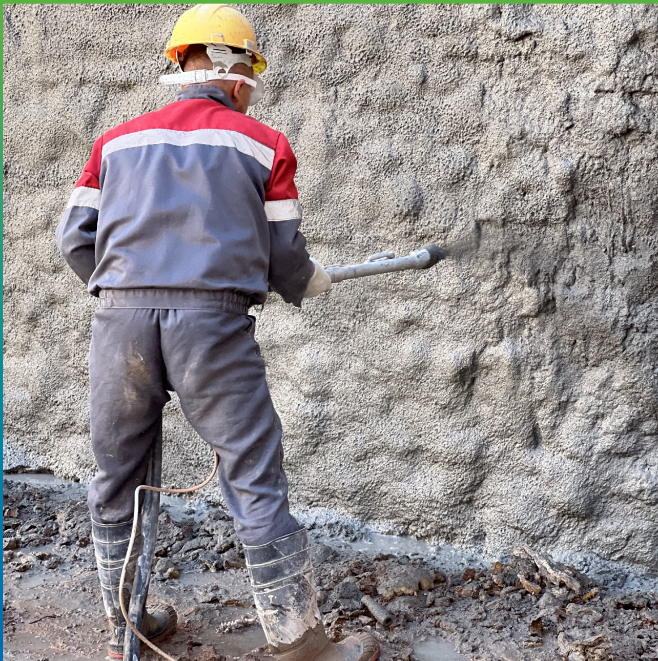
Нанесение основного слоя Стармекс Лайм С методом торкретирования
