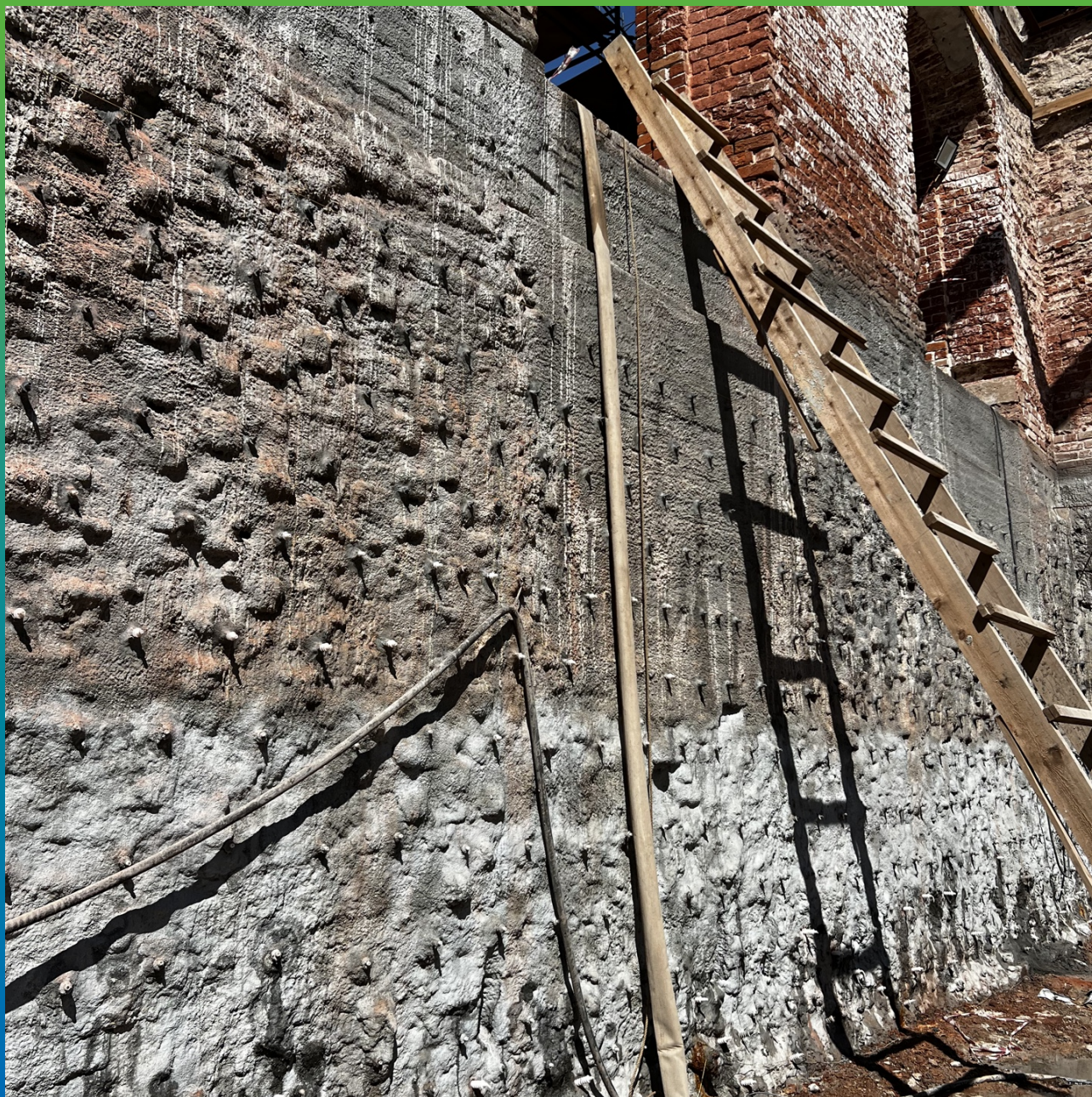
Вид стены до инъектирования Манокрил Гель
