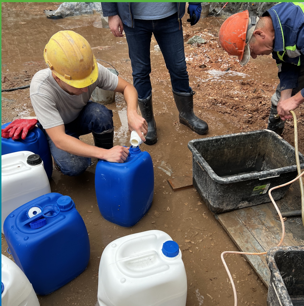
Подготовка материала и оборудования (БМ 1425) для инъецирования
