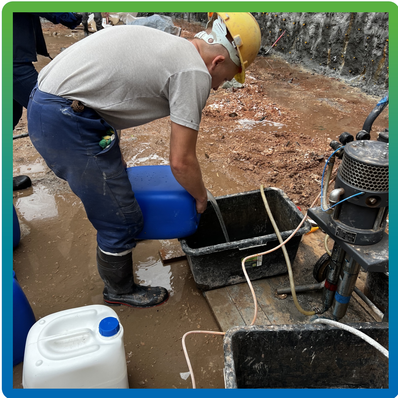
Подготовка материала и оборудования (БМ 1425) для инъектирования
