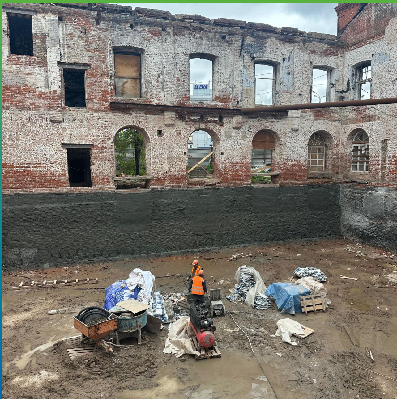
Стена, покрытая составом Стармекс Лайм С
