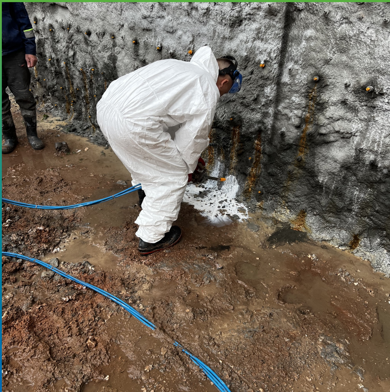
Процесс инъектирования акрилатного геля
