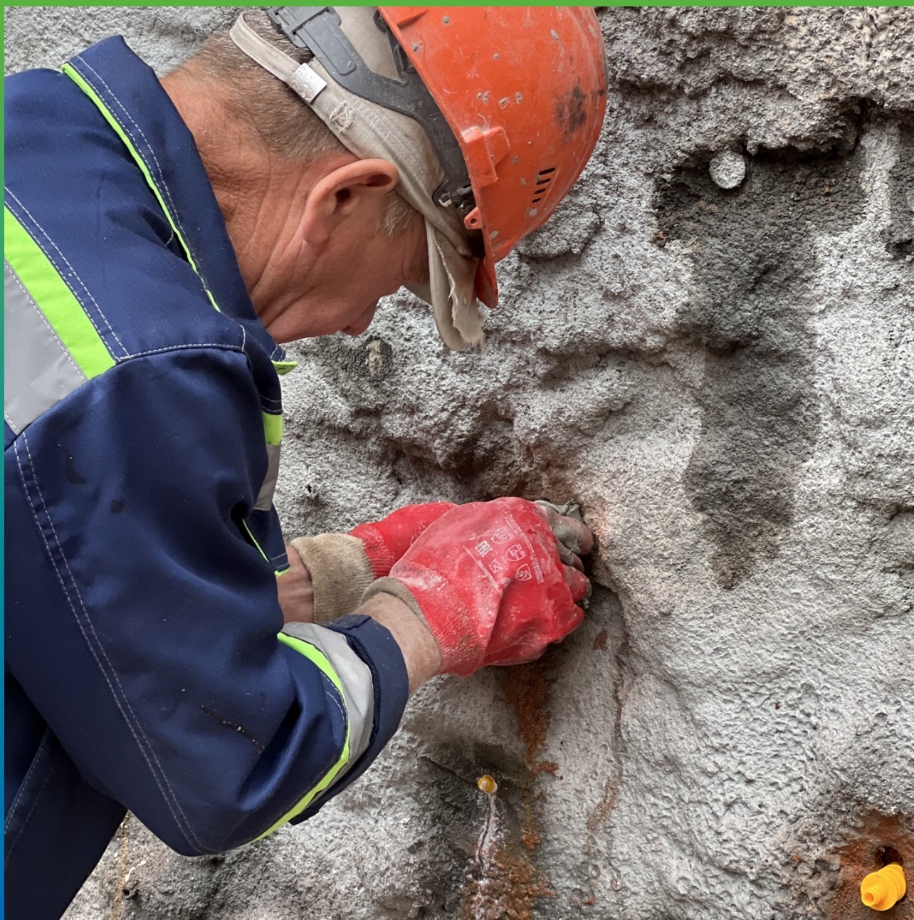
Заполнение шпуров составом Стармекс Плаг после демонтажа пакеров
