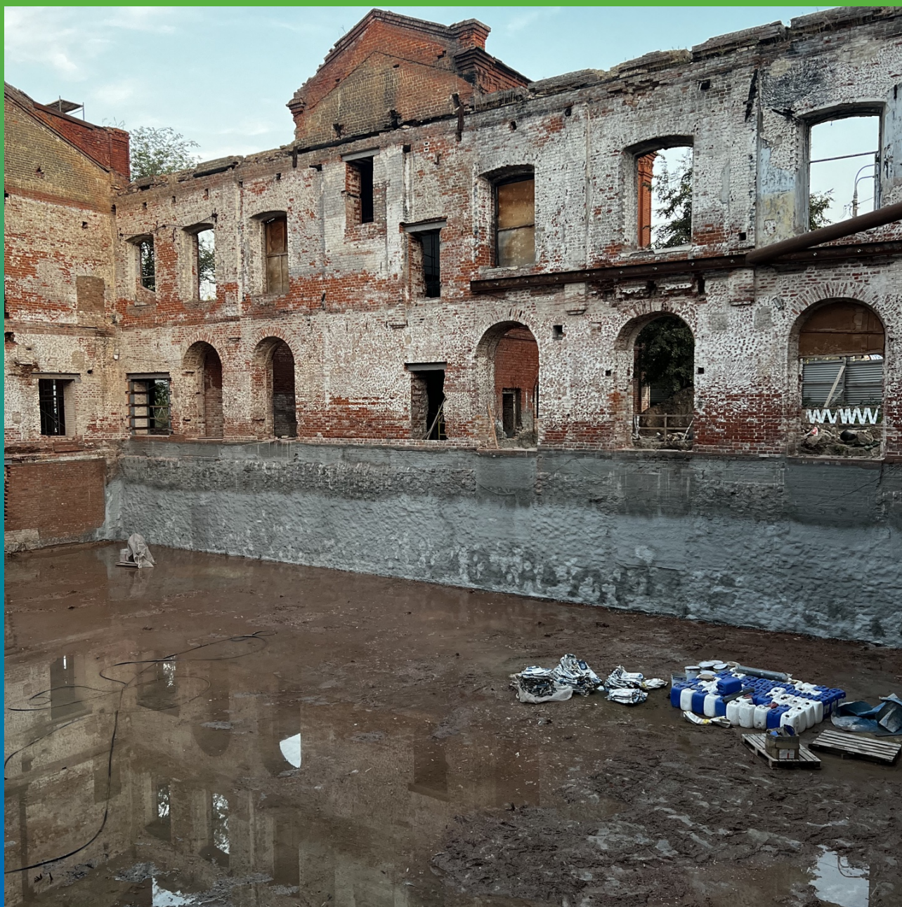
Общий вид после проведения работ
