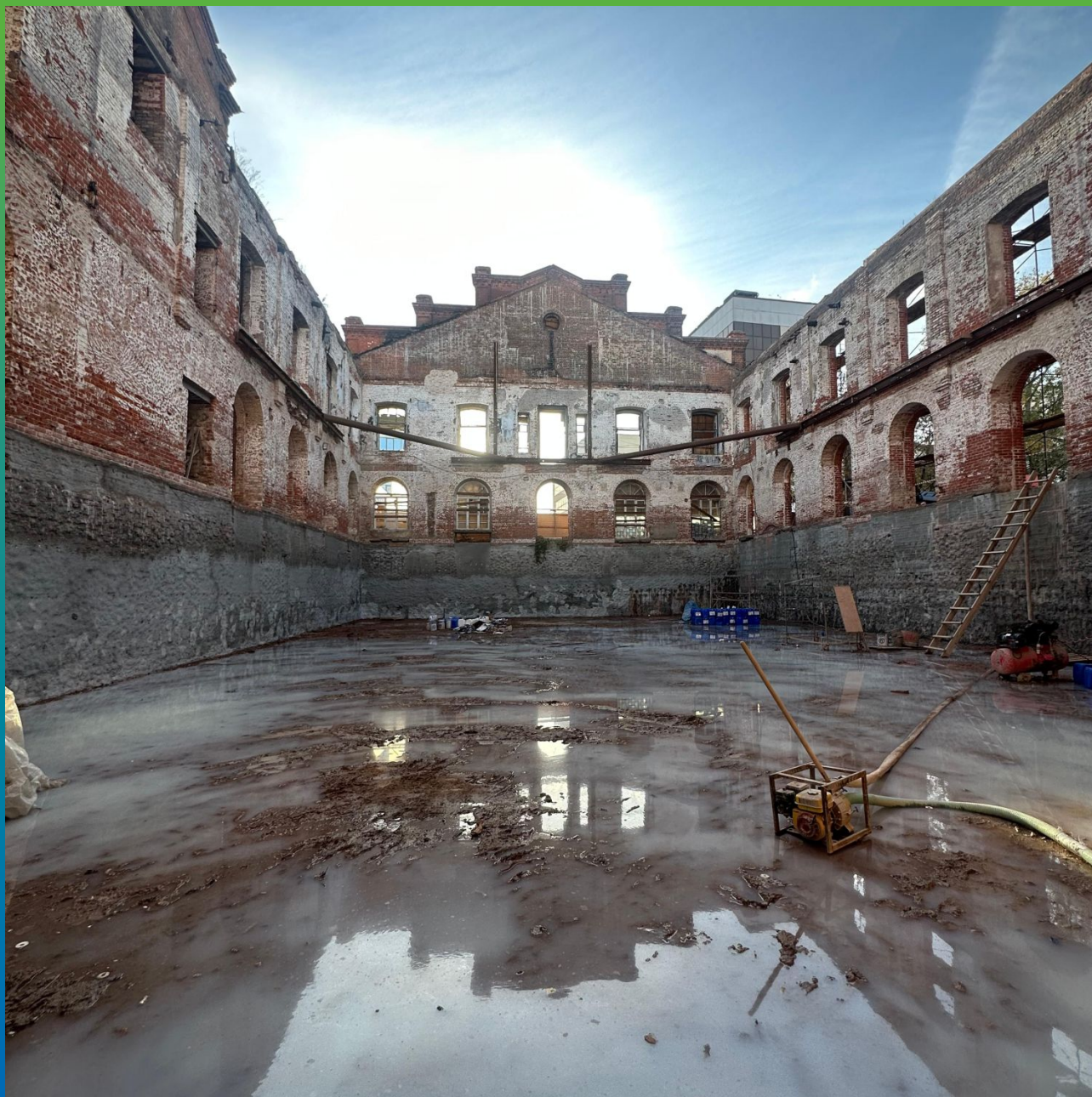
Общий вид после проведения работ
