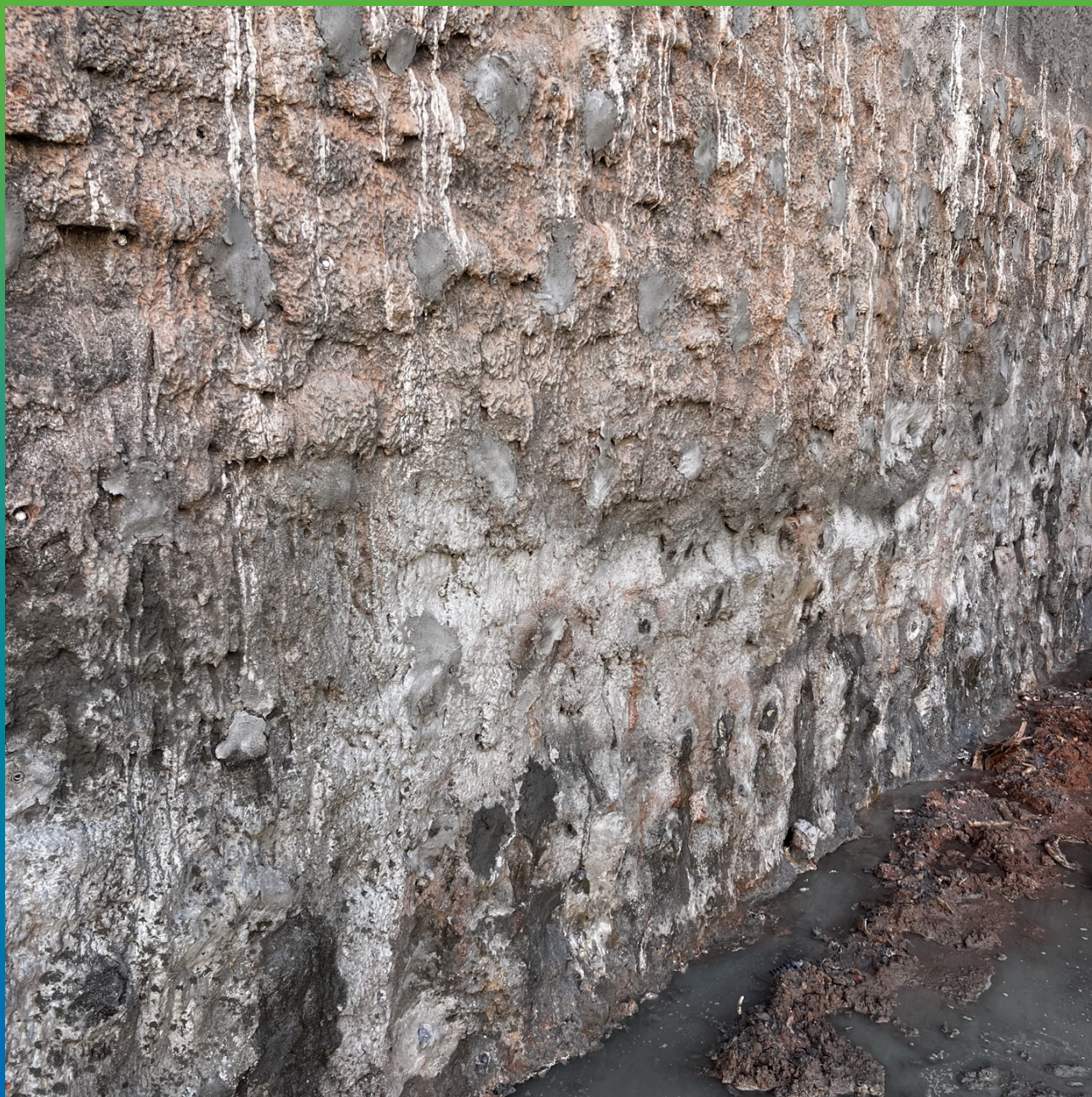
Вид стены после инъектирования Манокрил Гель и удаления пакеров
