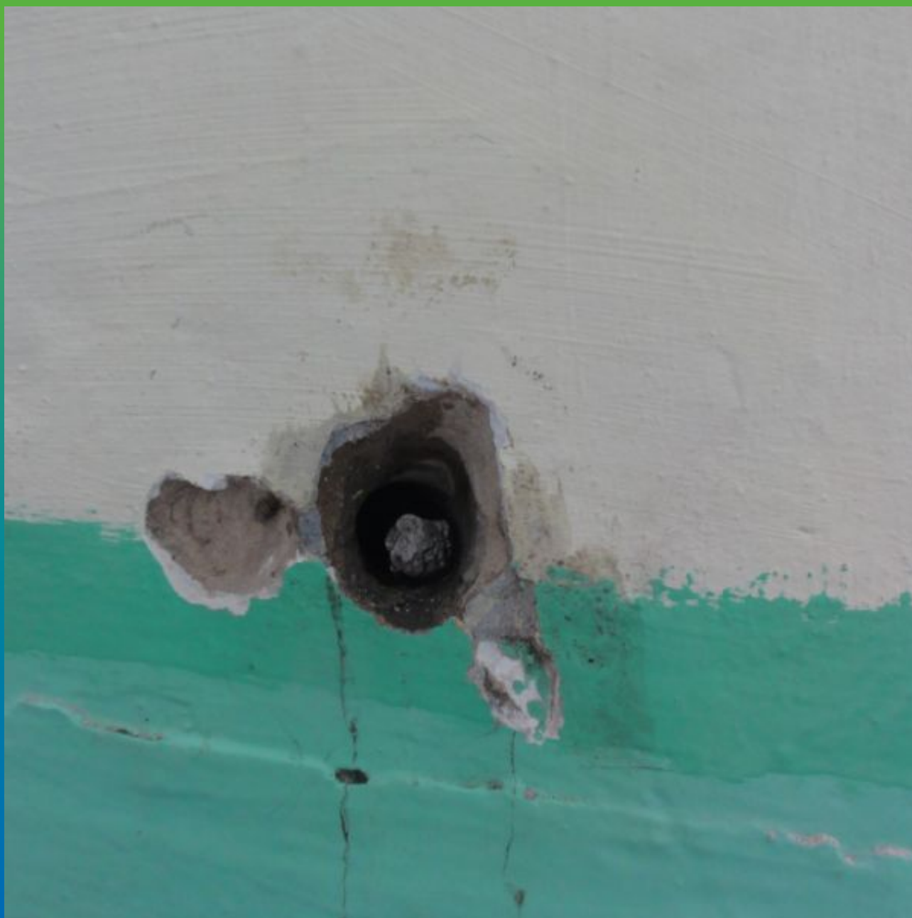
Установка арматурного стержня в шпур и дальнейшая фиксация его на Манопокс 352 ЛВ
