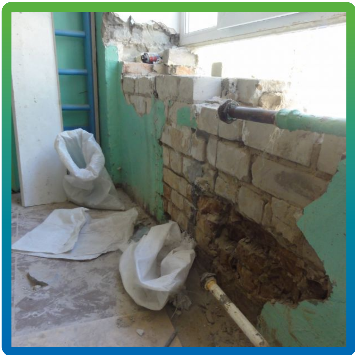
Состояние кладки до производства работ
