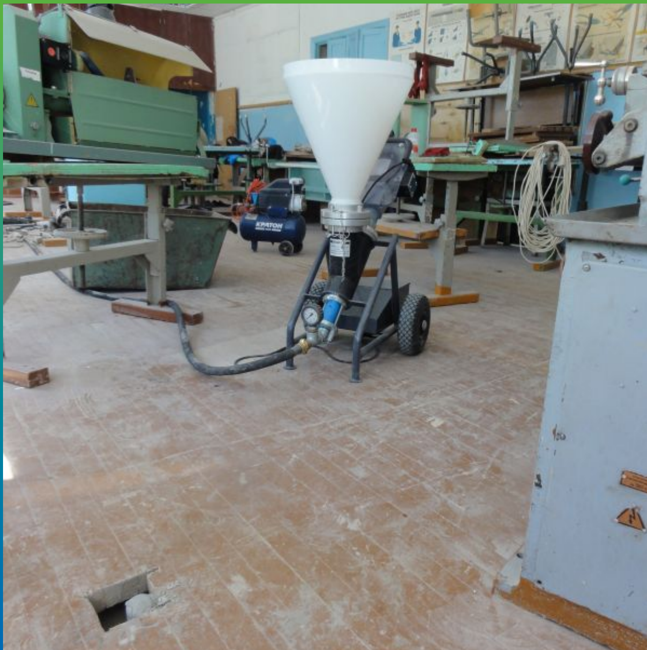
Насос БМП 6, используемый для производства работ на объекте
