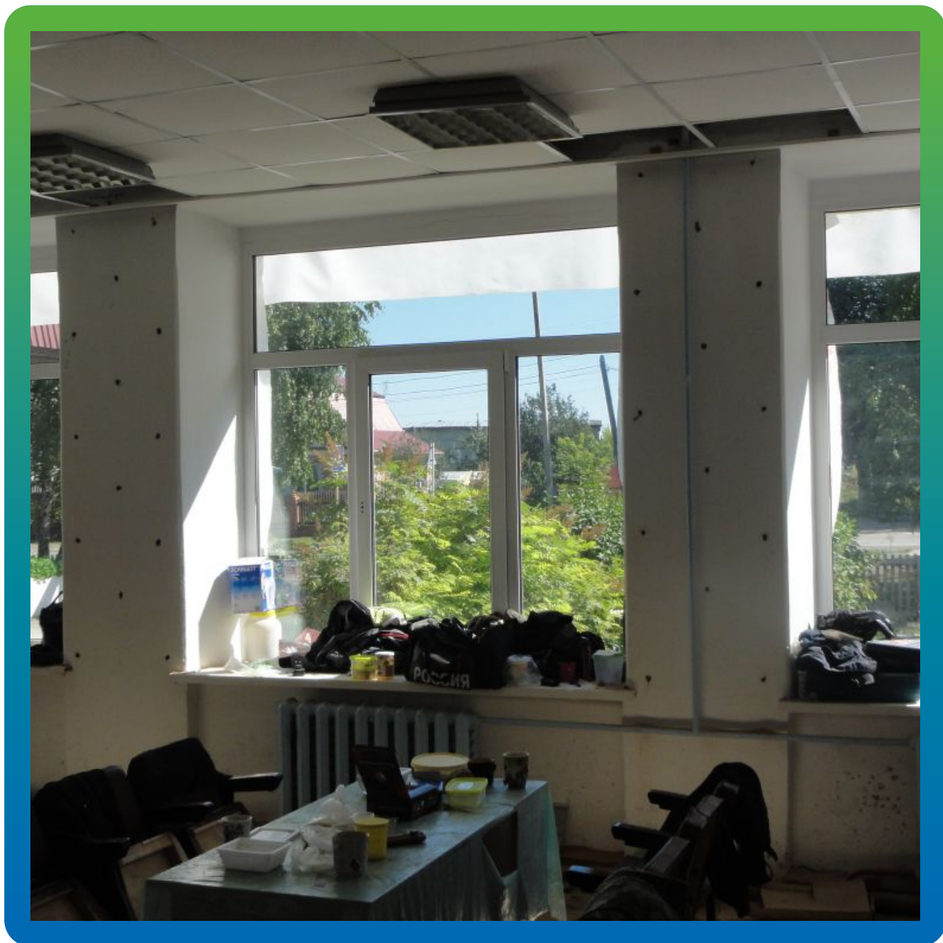
Сетка инъекционных шпуров
