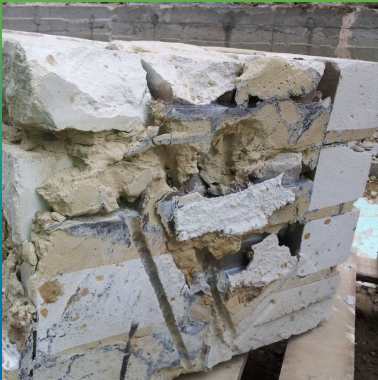
Распространение Манопокс 352 ЛВ внутри кирпичной кладки
