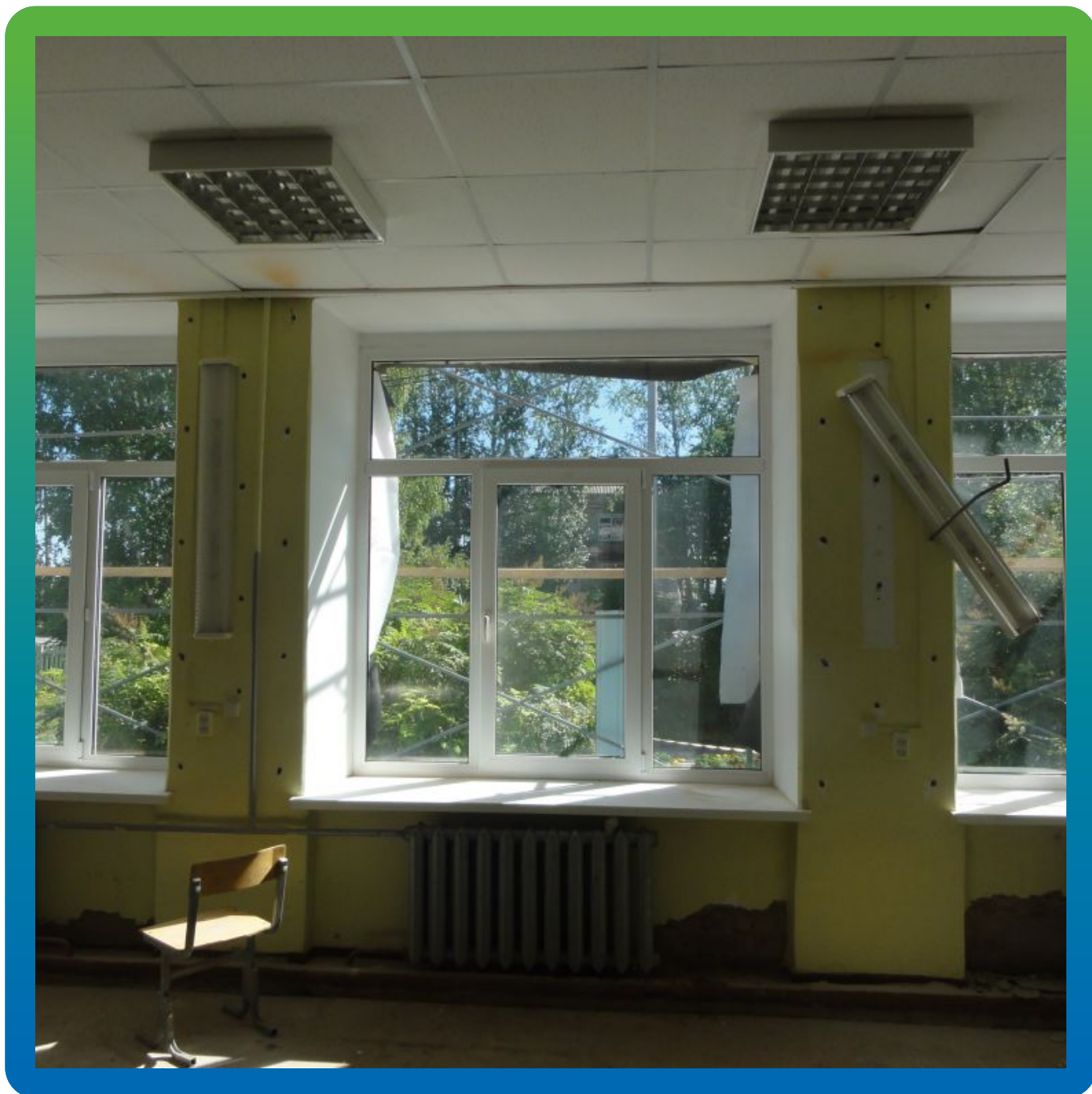
Бурение шпуров под инъекционные пакера
