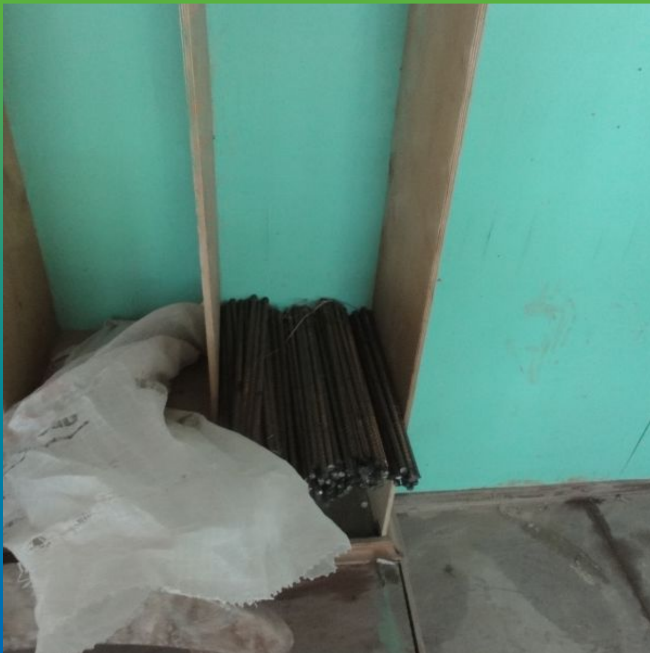
Арматурные стержни используемые для дополнительного армирования конструкции
