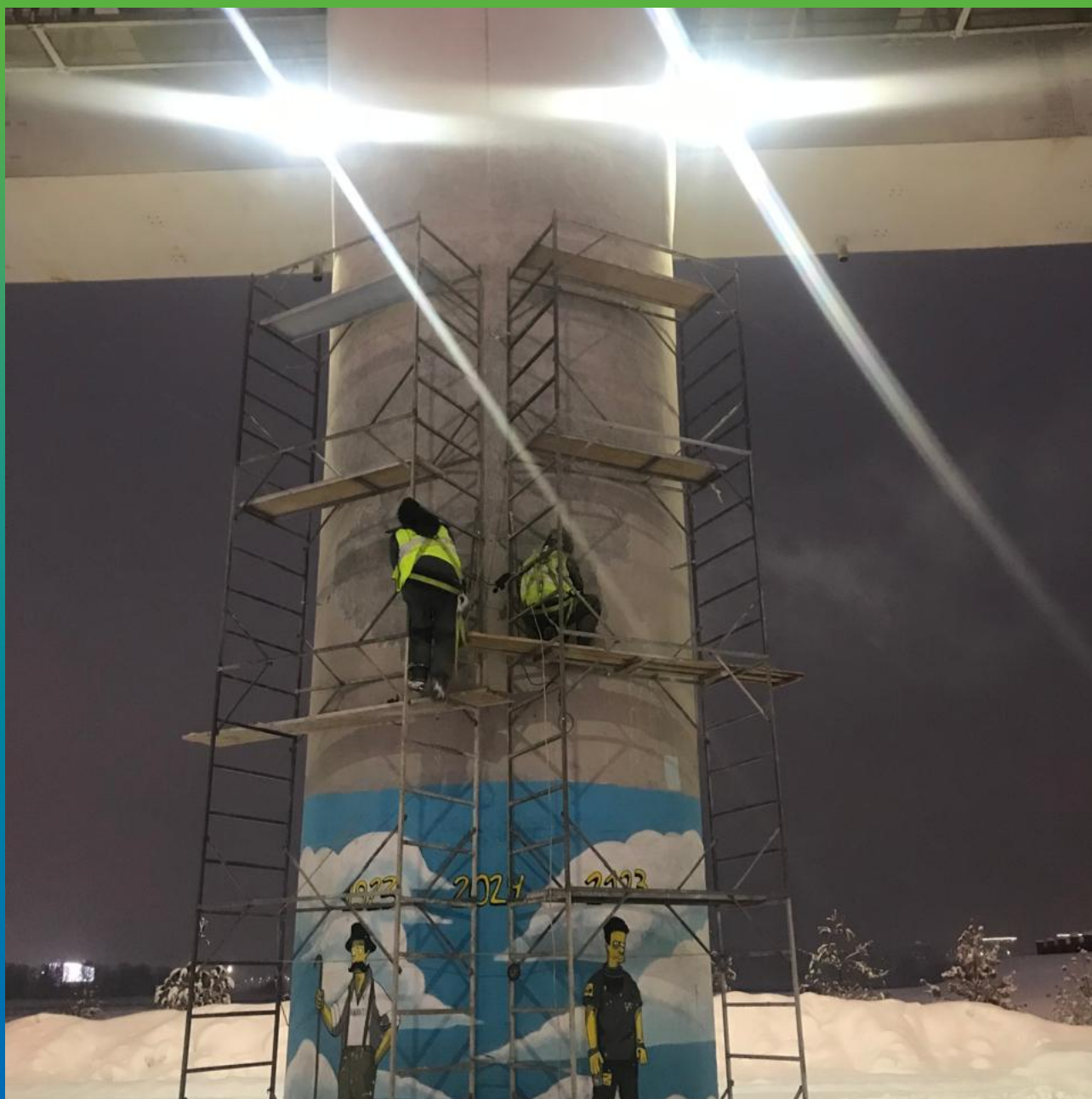
Очистка опор моста от старого покрытия методом шлифования.
