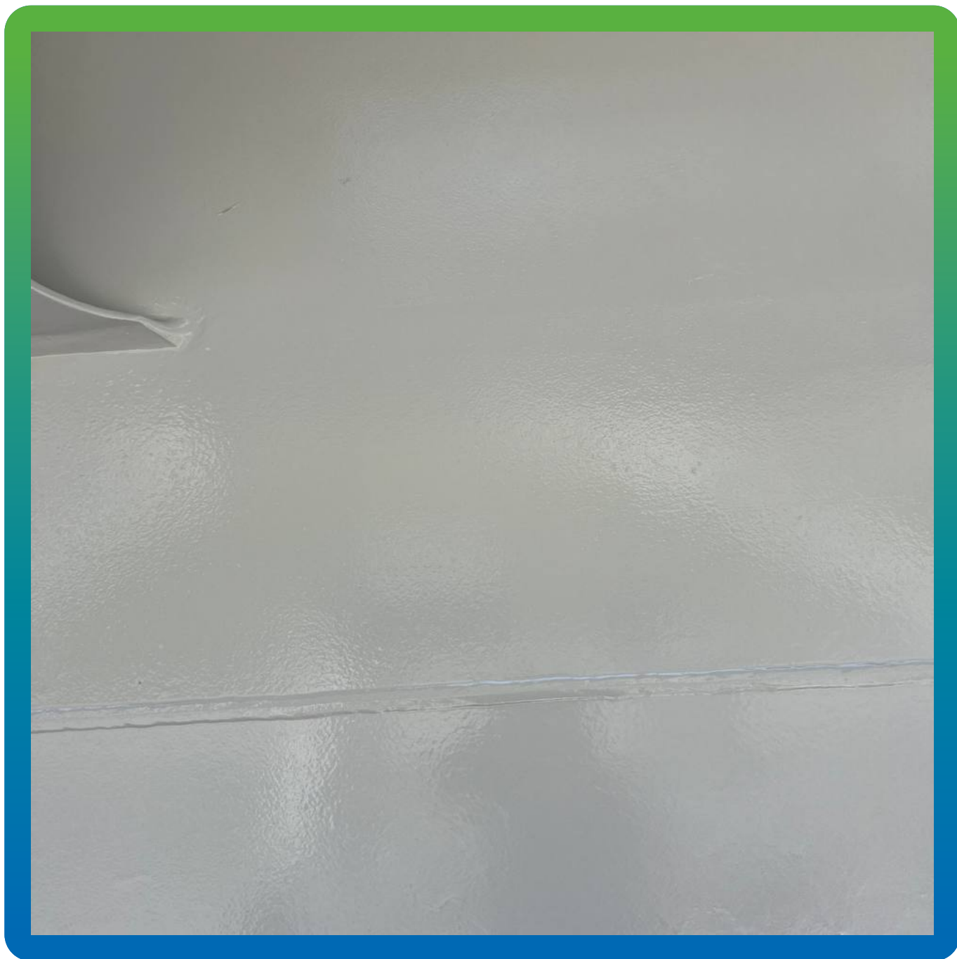
Участок с нанесенным ДенТоп ПУ 302 крупным планом
