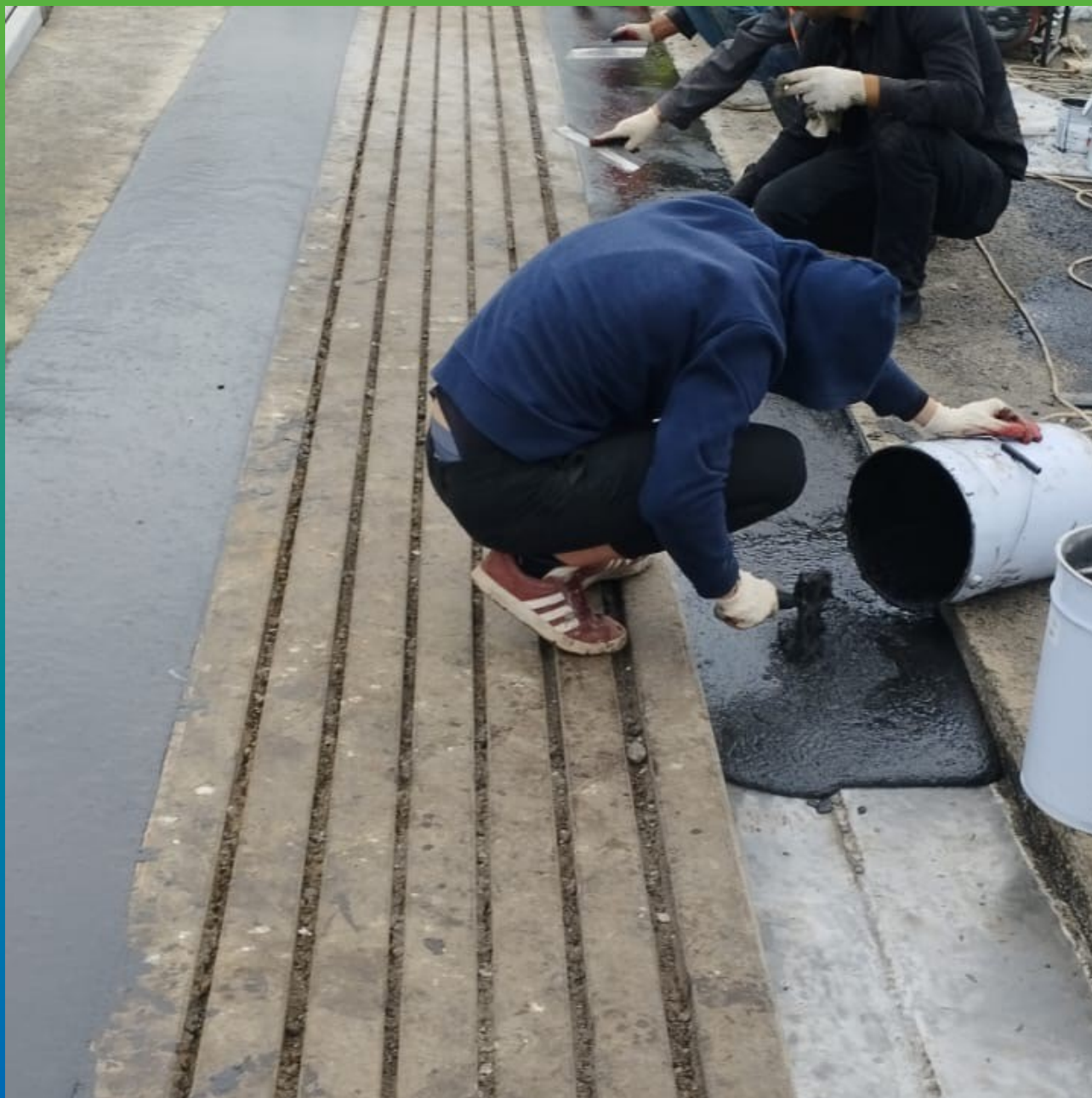
Укладка состава Манопур 336 в очищенную, обеспыленную и обезжиренную штрабу
