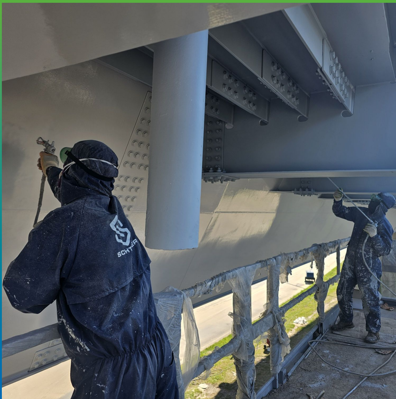
Нанесение двухкомпонентного УФ-стойкого полиуретанового покрытия ДенсТоп ПУ 302
