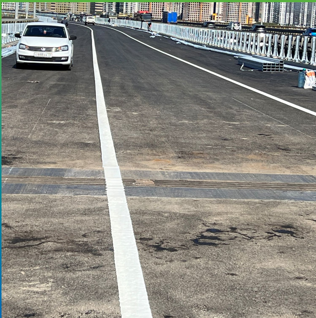
Переходная зона деформационного шва перед сдачей
