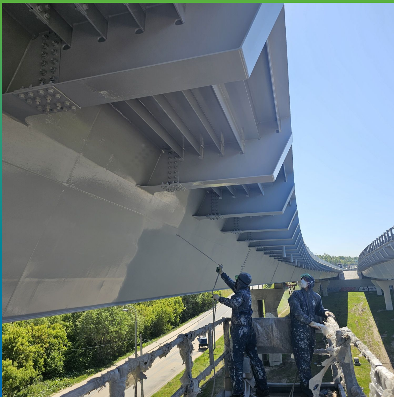
Безвоздушное нанесение финишного покрытия
