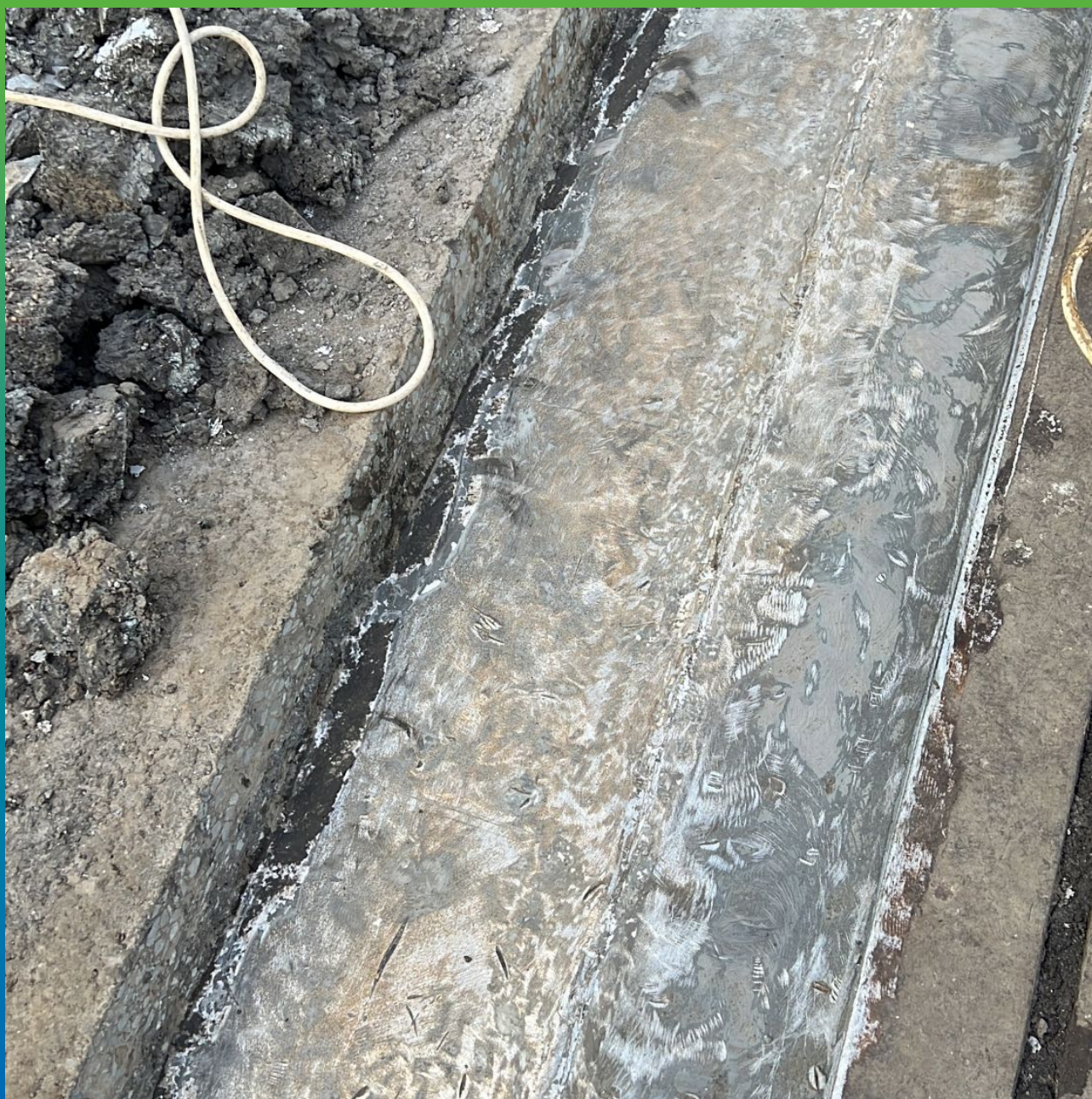
Демонтированная полость шва
