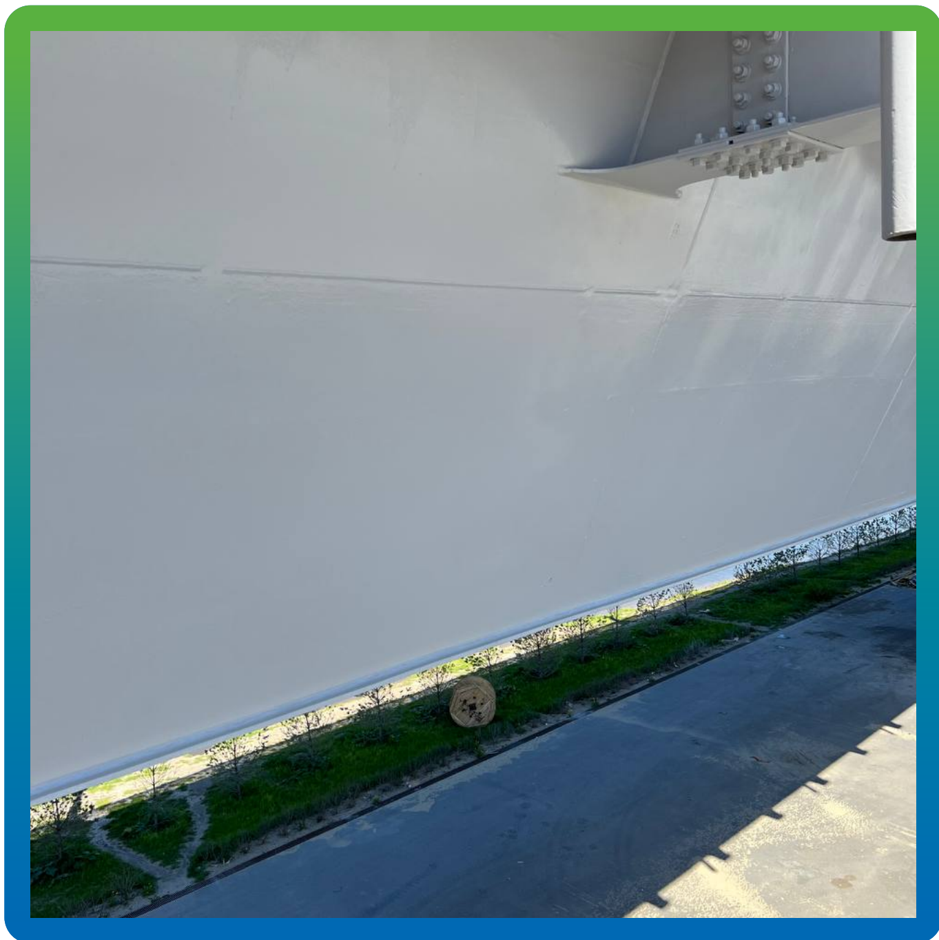
Внешний вид сооружения после выполнения работ по антикоррозионной защите
