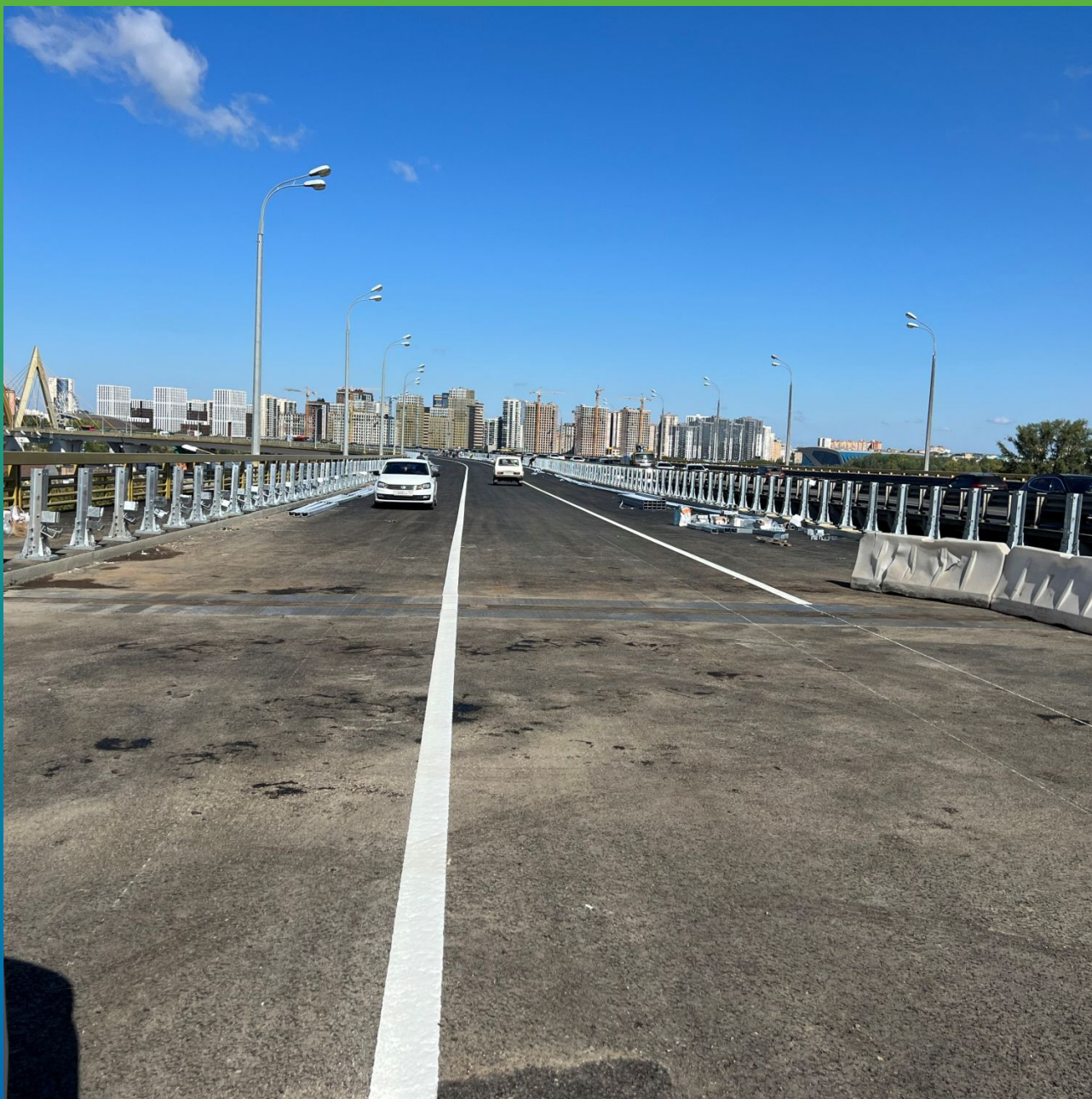
Введенный в эксплуатацию участок моста
