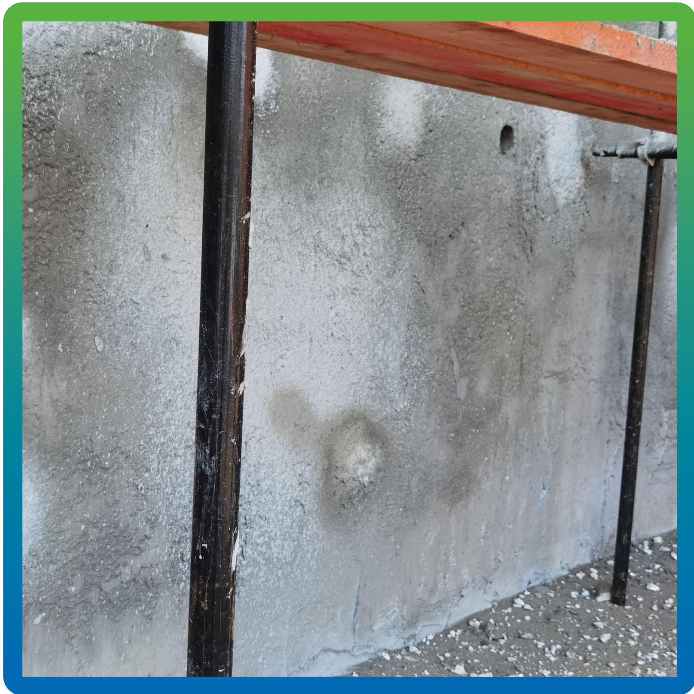
Вид объекта после ремонта
