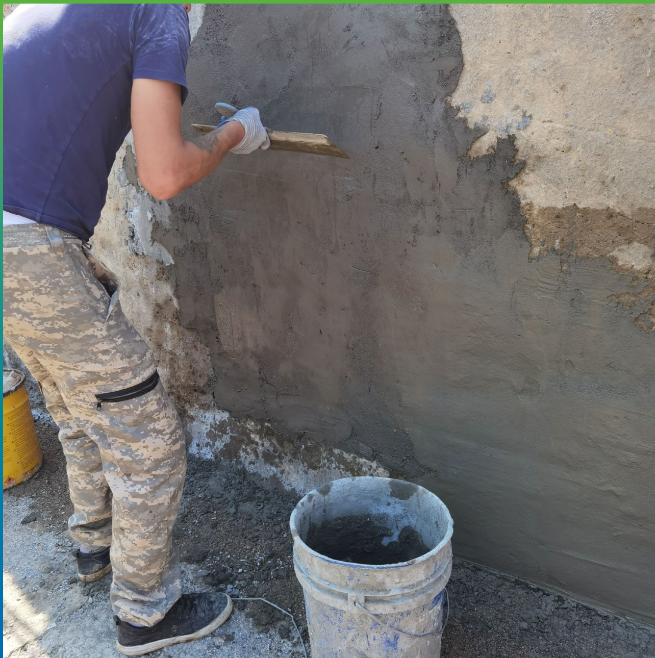
Локальный ремонт Стамрекс РМЗ
