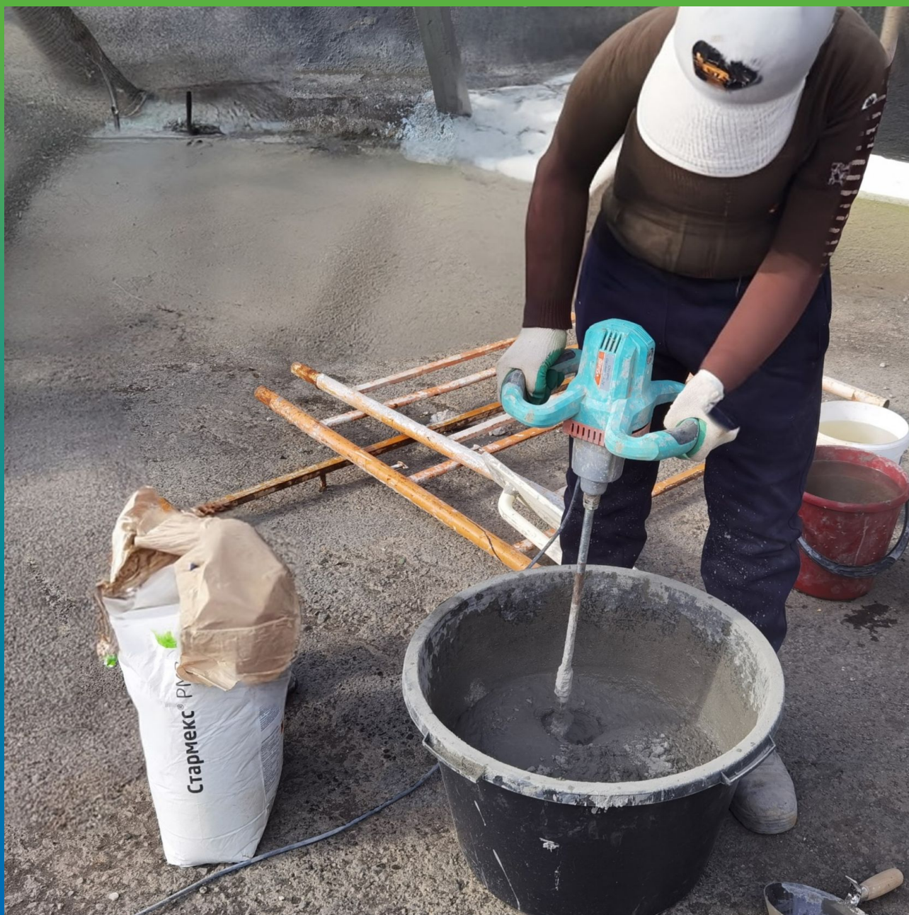
Подготовка к нанесению Стармекс РМЗ
