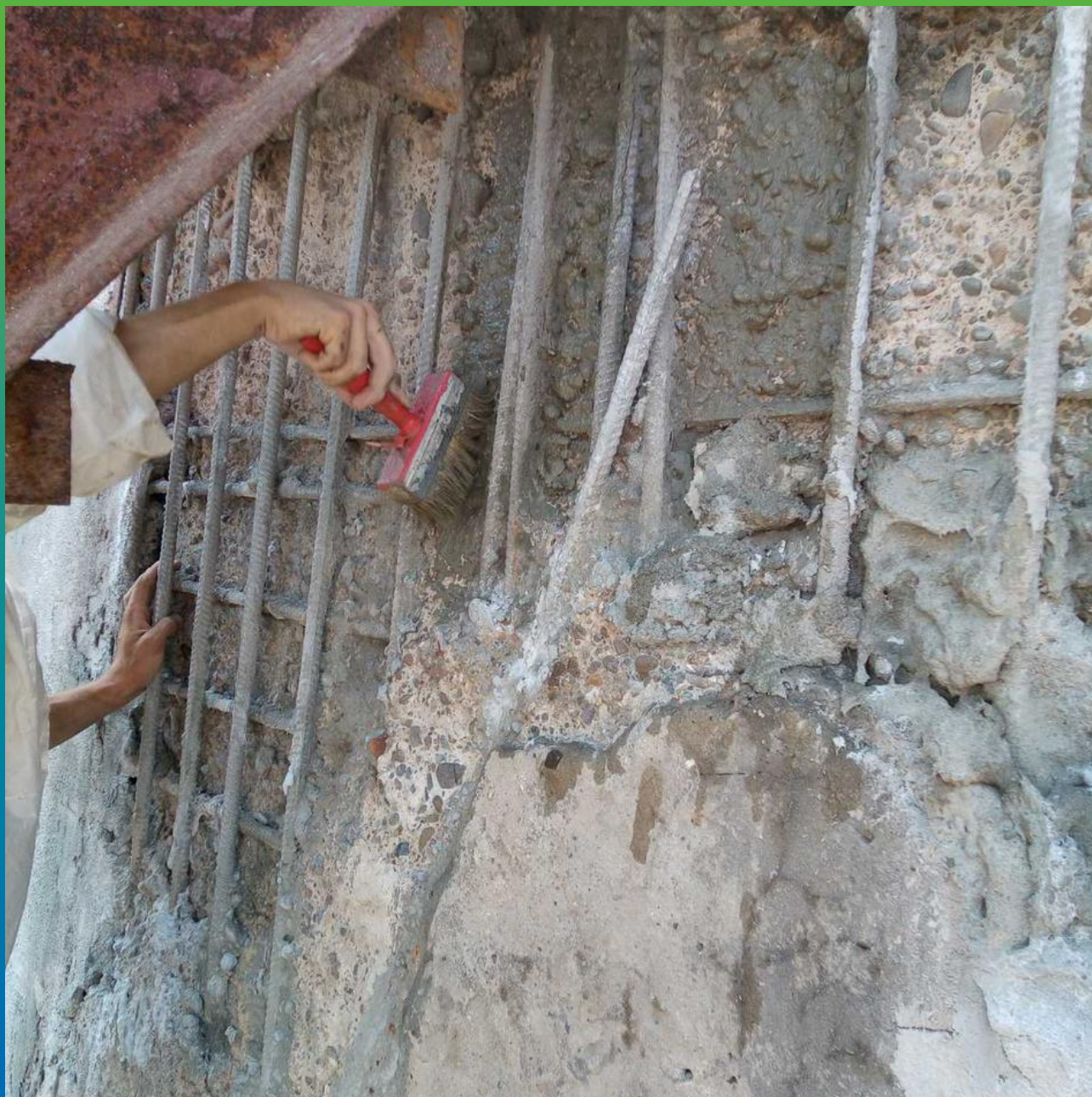
Обработка арматуры и нанесение адгезионного слоя составом Стармекс МКП
