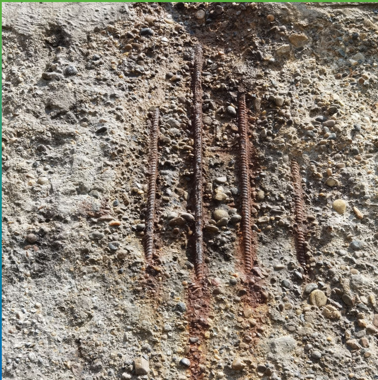
Вид объекта до ремонта
