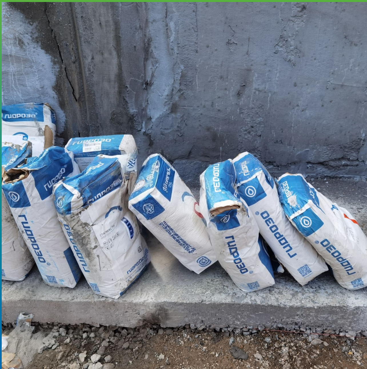
Материалы производства "Гидрозо" на объекте
