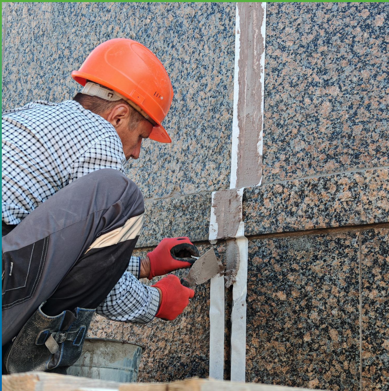
Нанесение герметика Манодил Цем в подготовленный шов.
