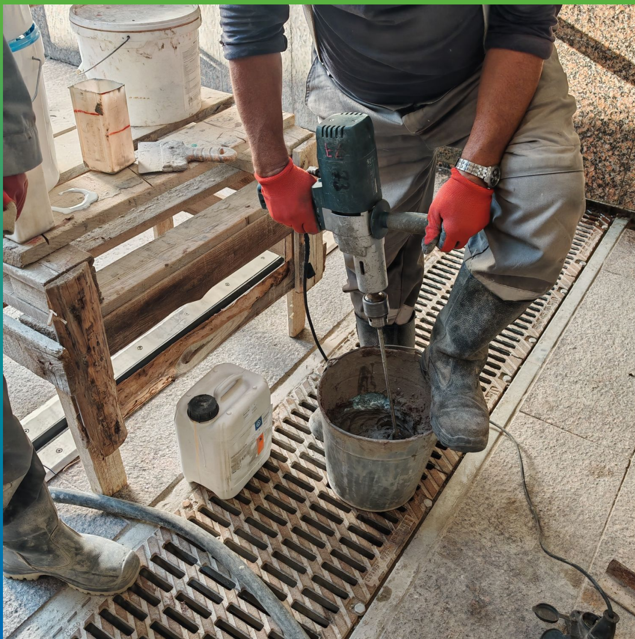
Приготовление двухкомпонентного состава для швов Манодил Цем.
