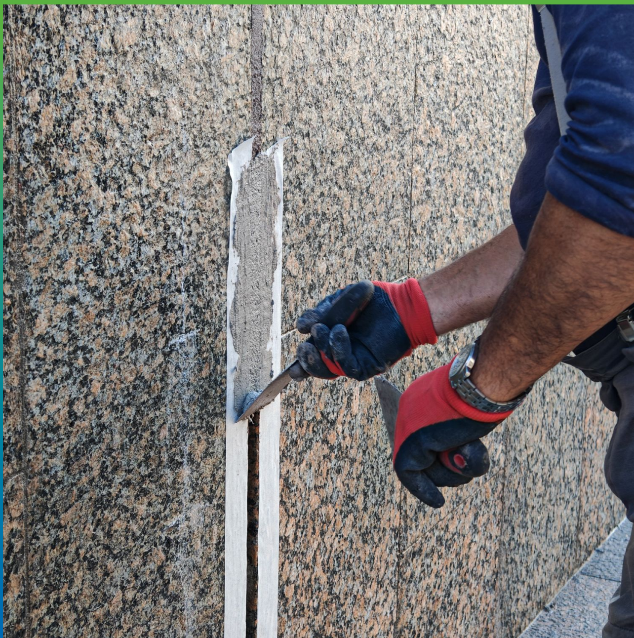
Нанесение герметика Манодил Цем в подготовленный шов.
