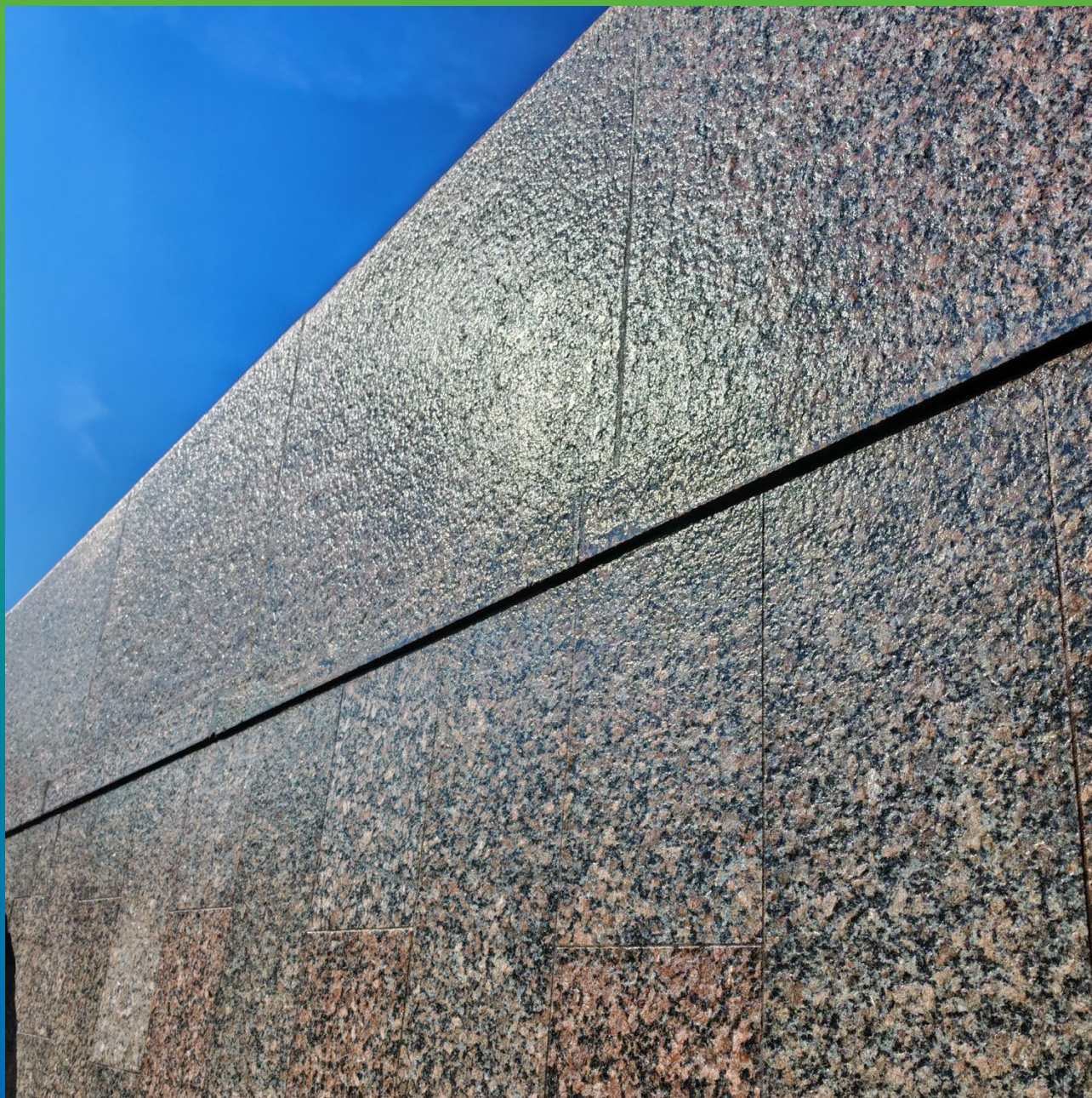
Вид нанесенного покрытия Маногард АГФ.
