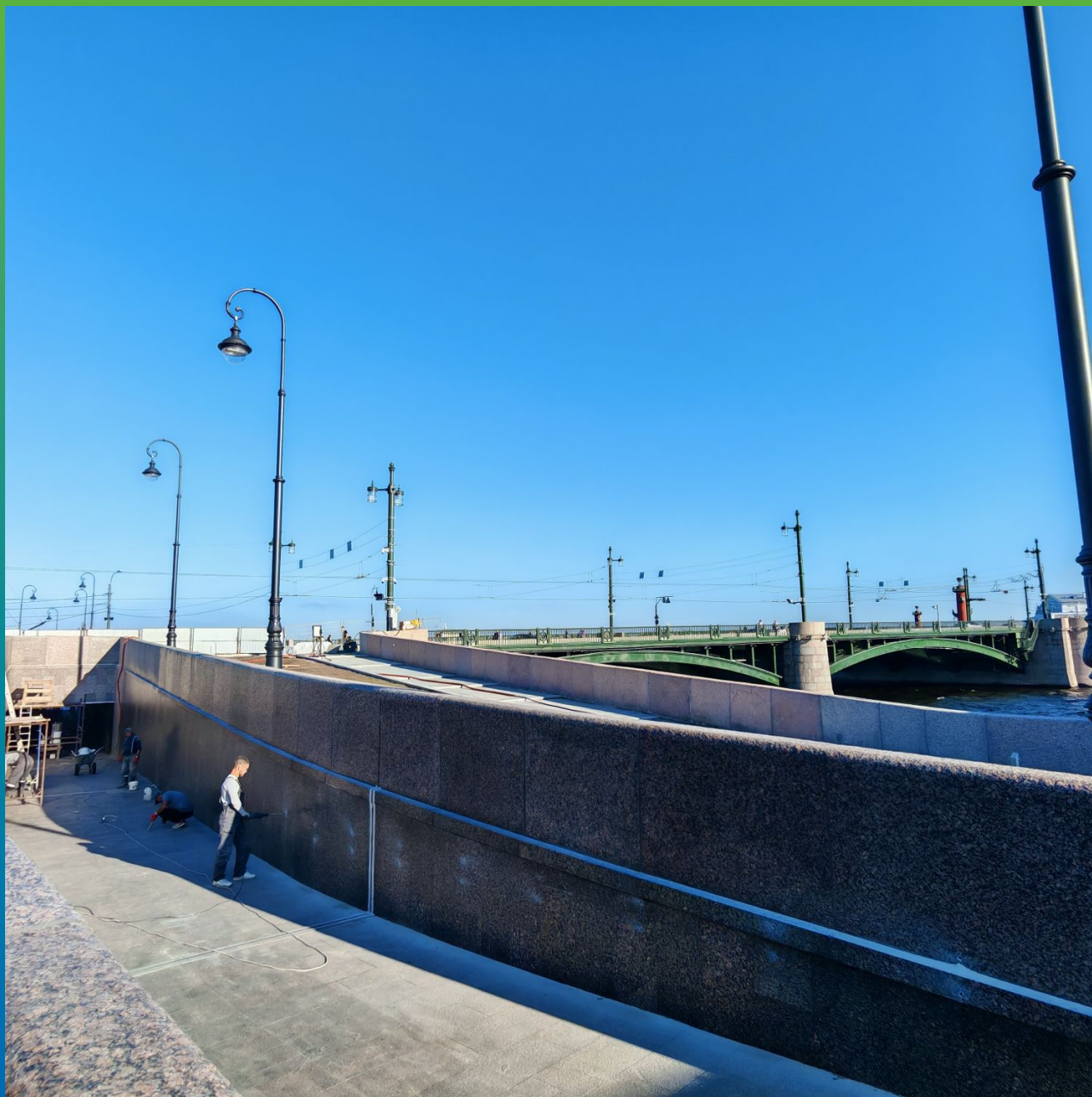
Установка поручней по завершению работ.
