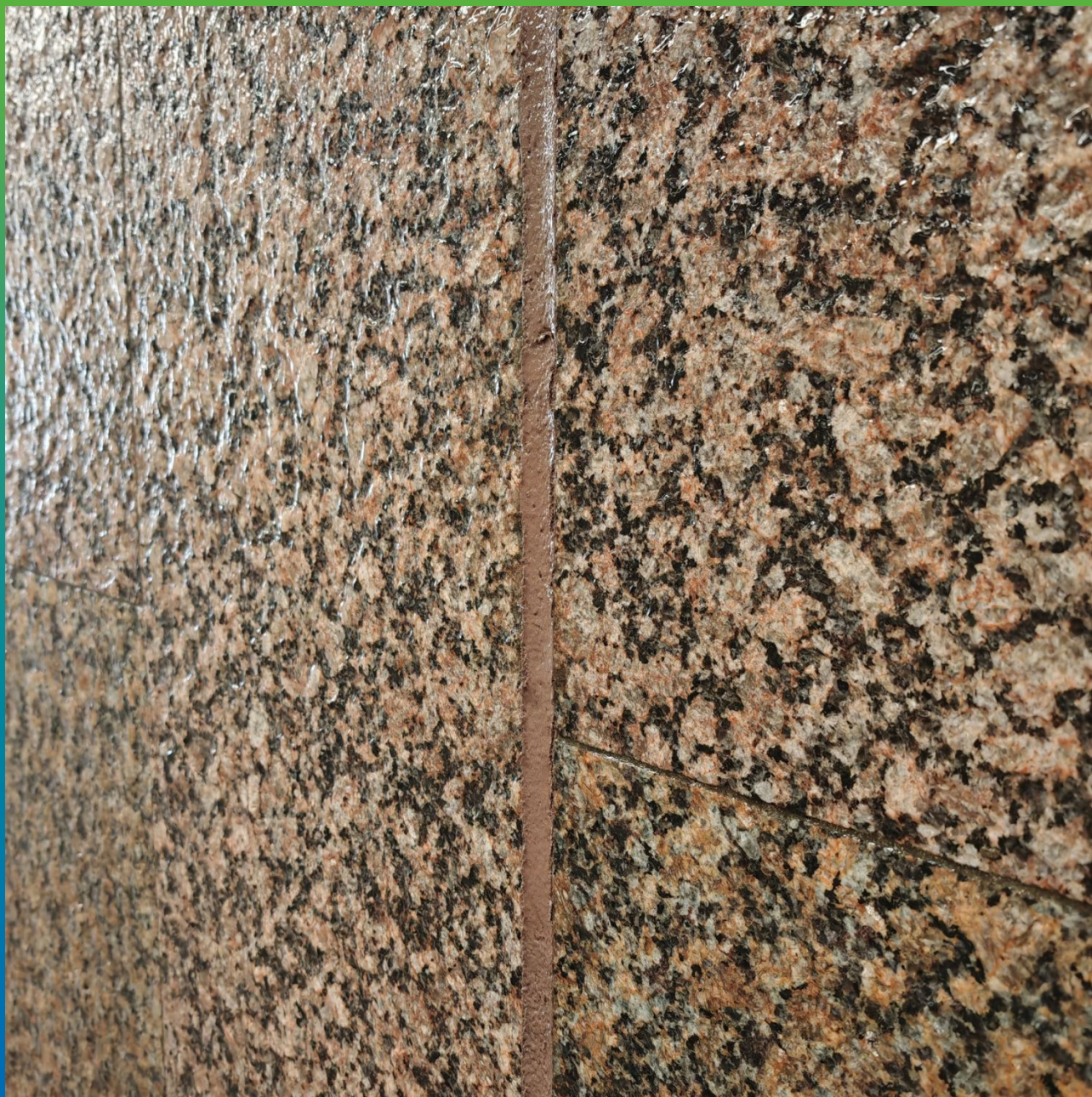
Шов с герметиком Манодил Цем после нанесения антивандального покрытия Маногард АГФ.
