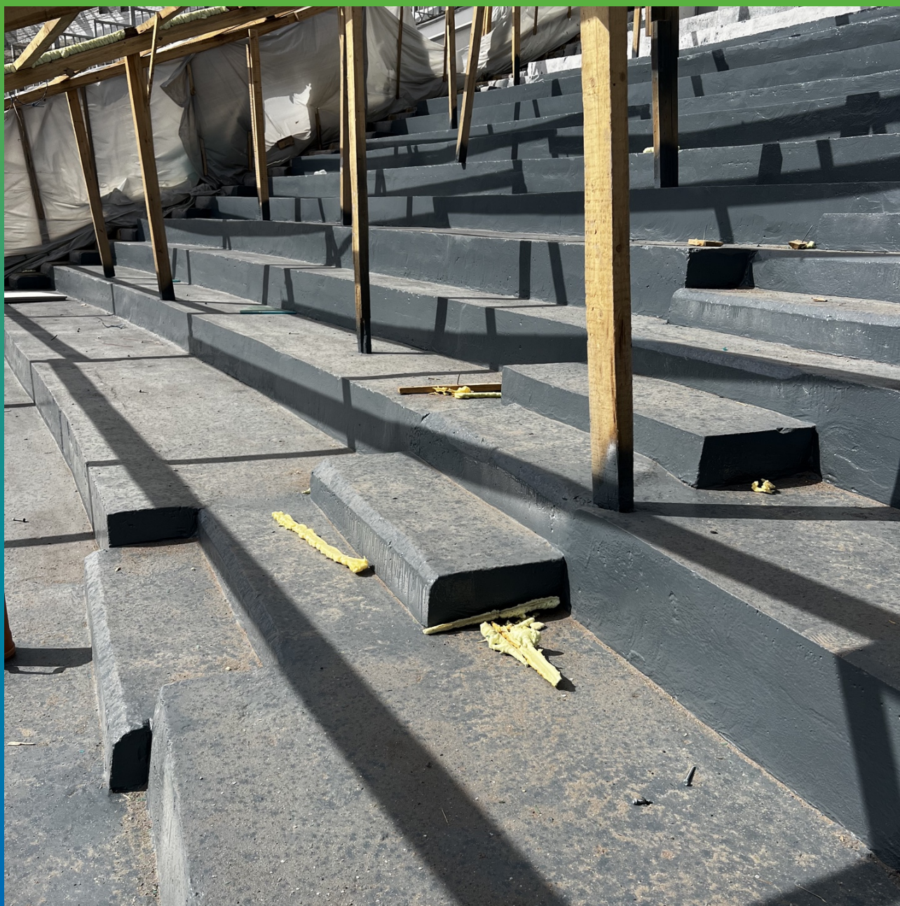
Финишный вид покрытия с нанесенным слоем УФ защитного материала ДенсТоп ПУ 302
