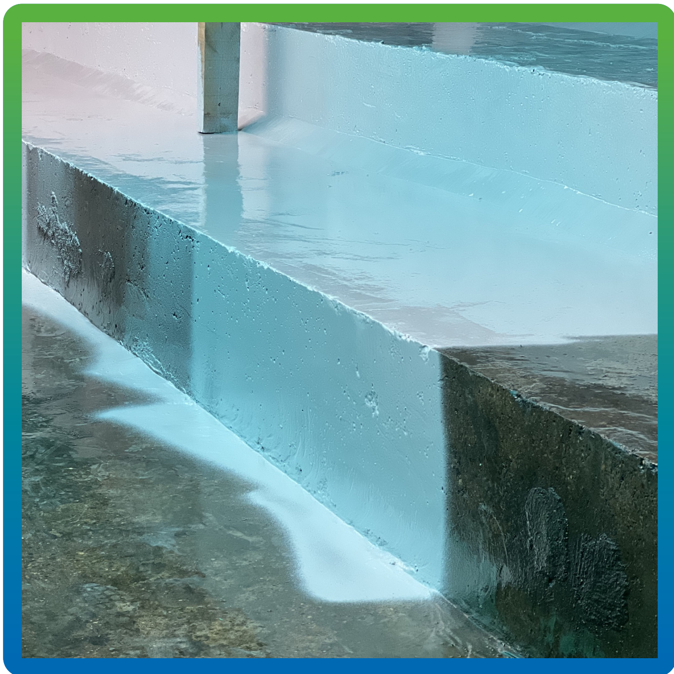
Нанесение ДенТоп ПУ 227 Эластик
