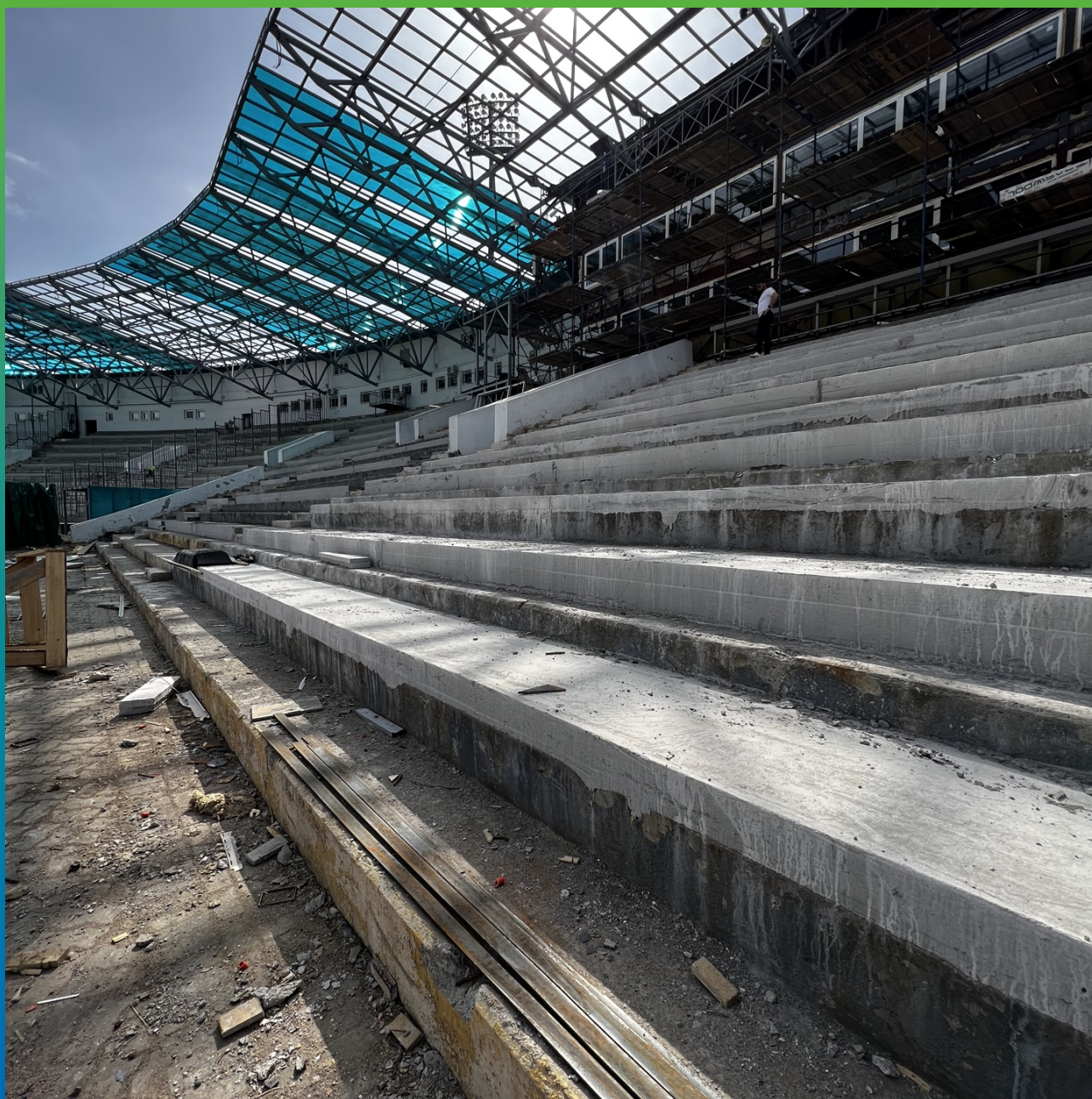
Вид трибун после ремонта составом Стармекс ФМ7
