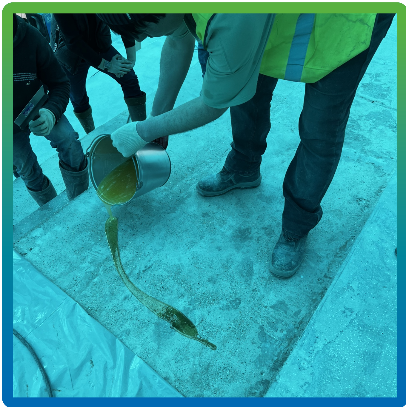
Нанесение грунтовочного состава на поверхность
