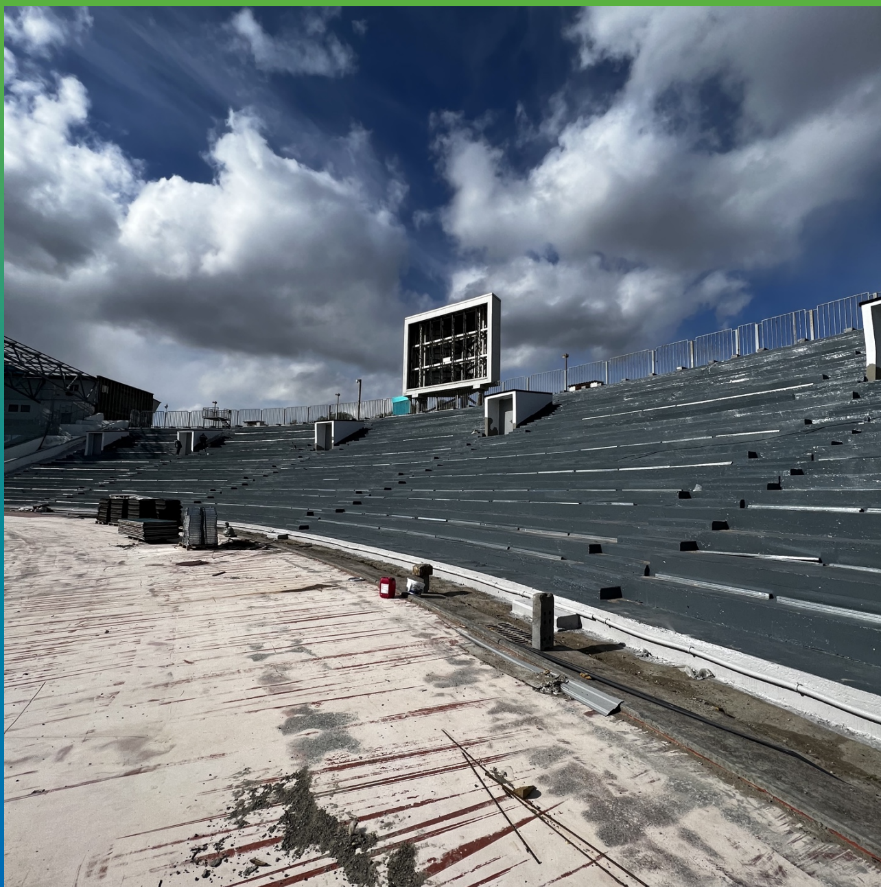
Подготовка к установке сидений
