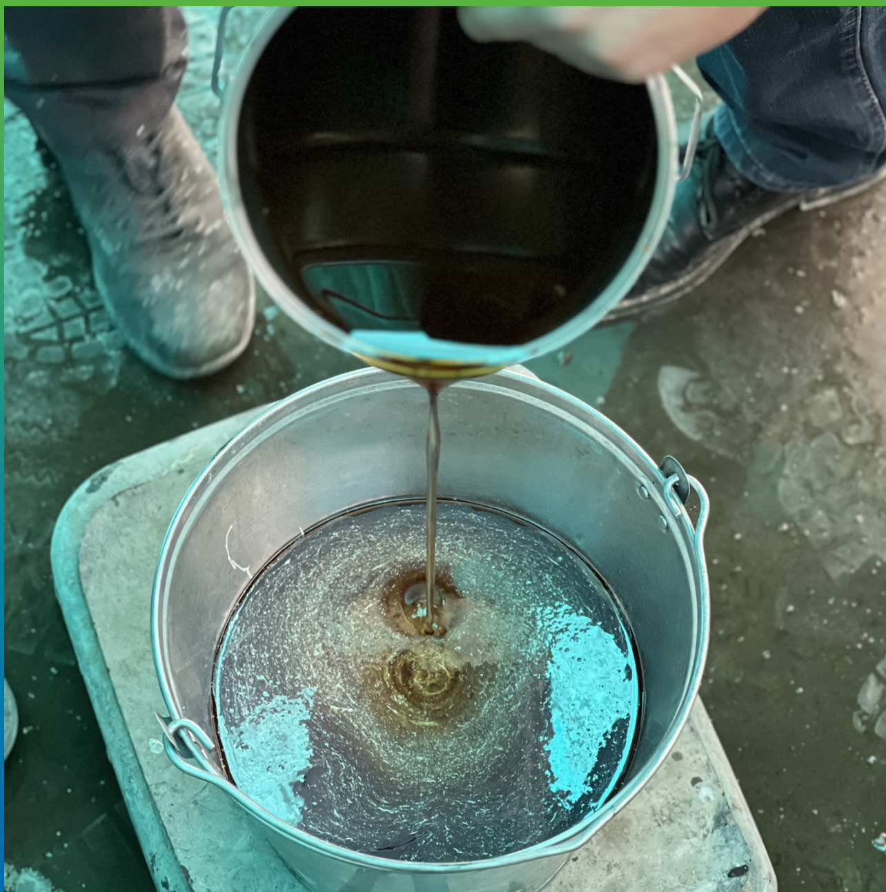
Замешивание состава ДенсТоп ПУ 227 Эластик
