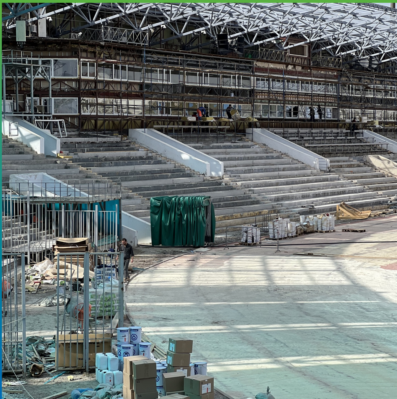
Трибуны, подготовленные для нанесения ДенСтоп ЭП 106
