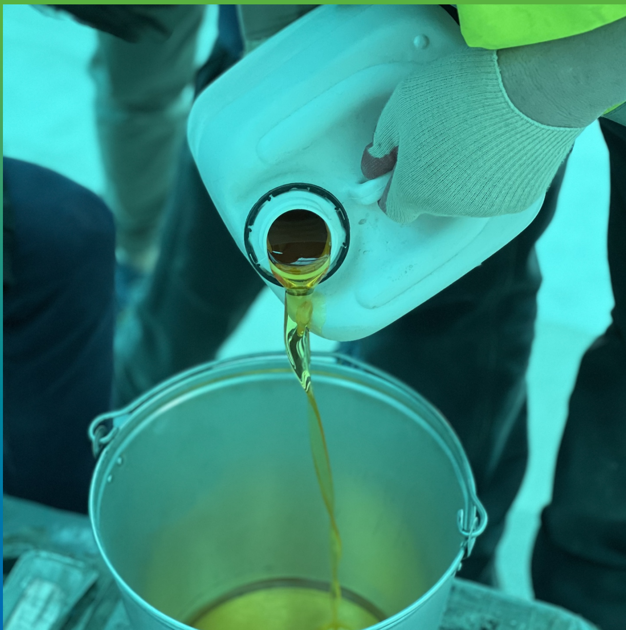
Подготовка состава ДенсТоп ЭП 106
