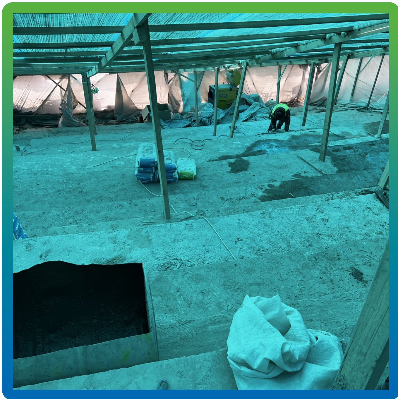
Ремонт ж/б поверхности и шлифовка
