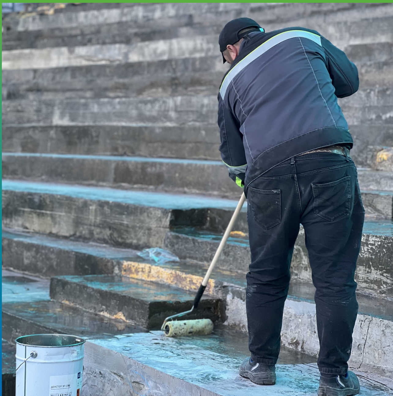
Нанесение грунтовочного состава ДенСтон ЭП 106
