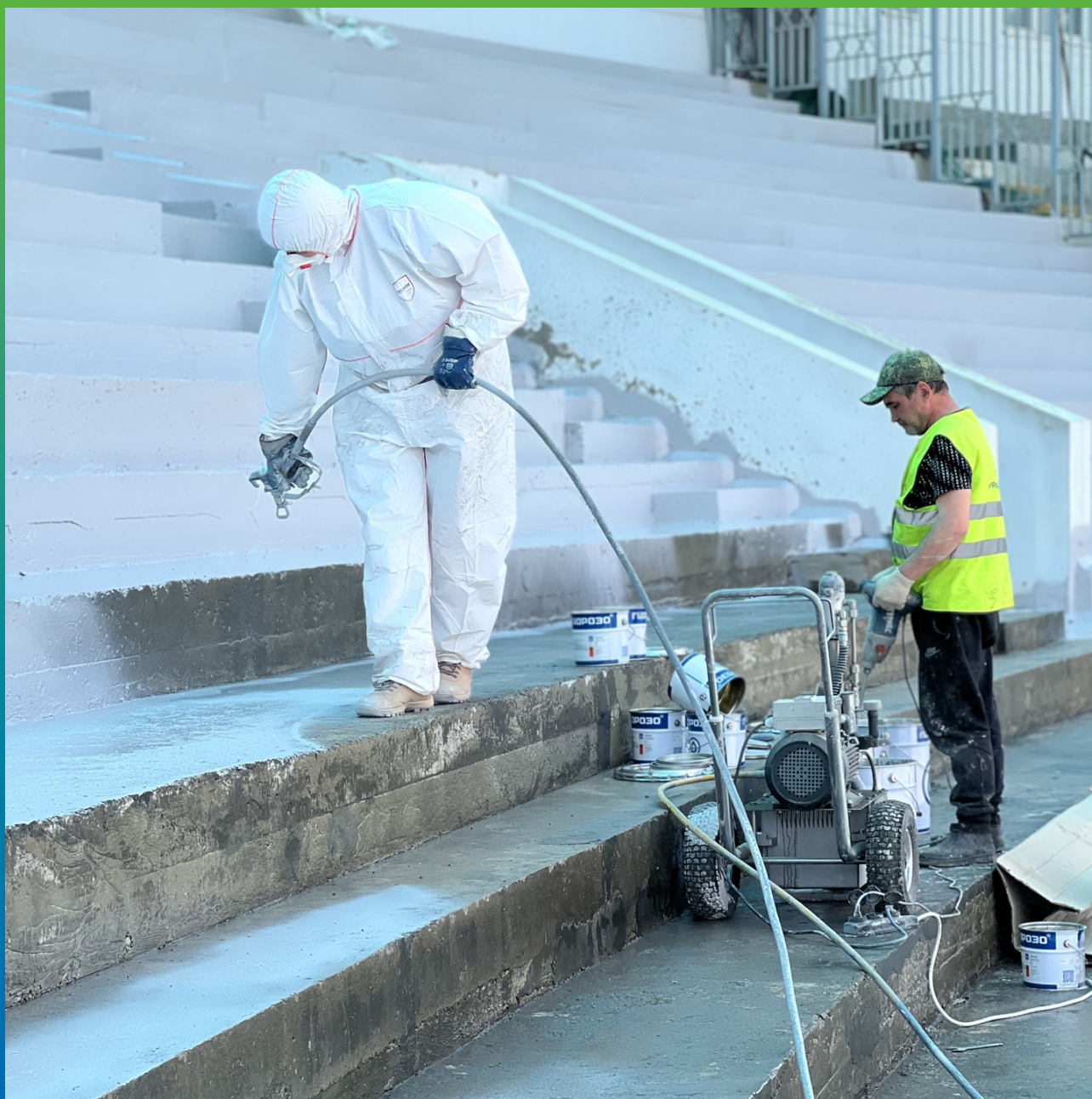
Нанесение ДенТоп ПУ 227 Эластик
