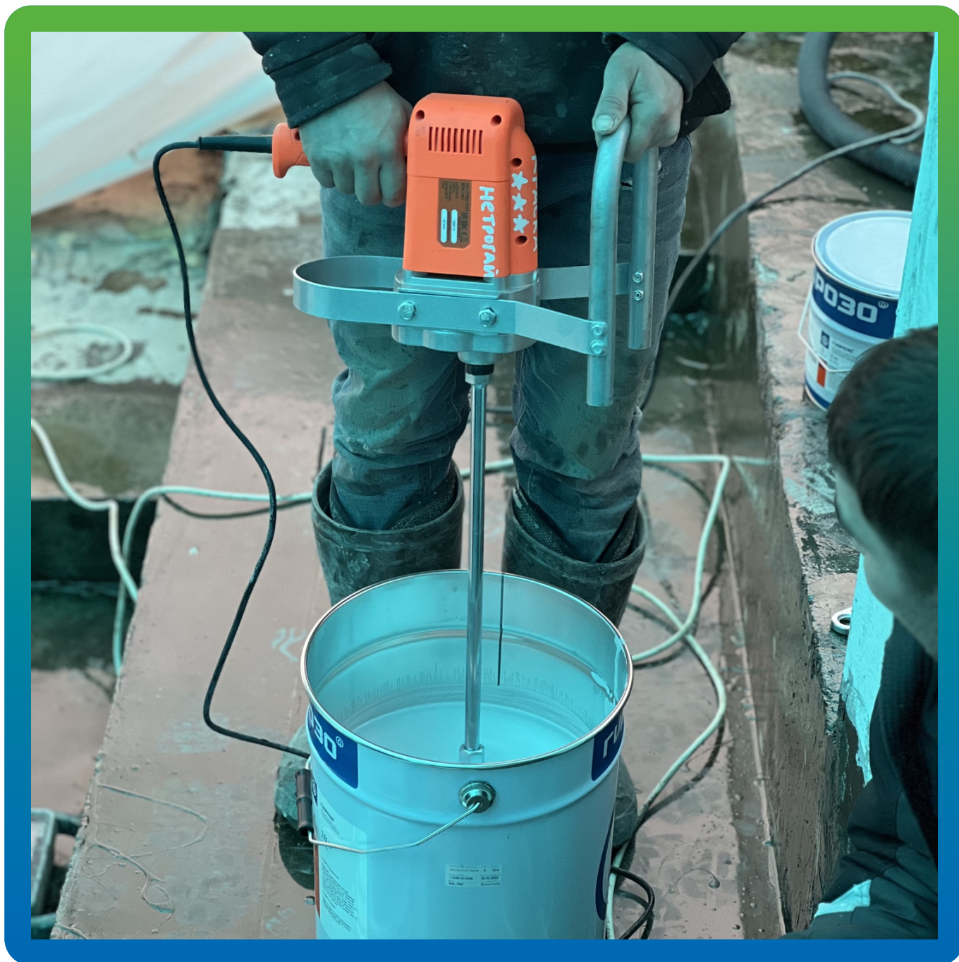
Перемешивание компонентов ДенТоп ПУ 227 Эластик
