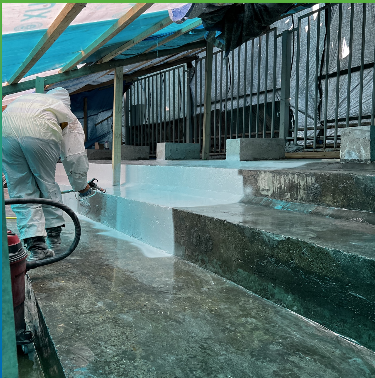
Нанесение ДенсТоп ПУ 227 Эластик
