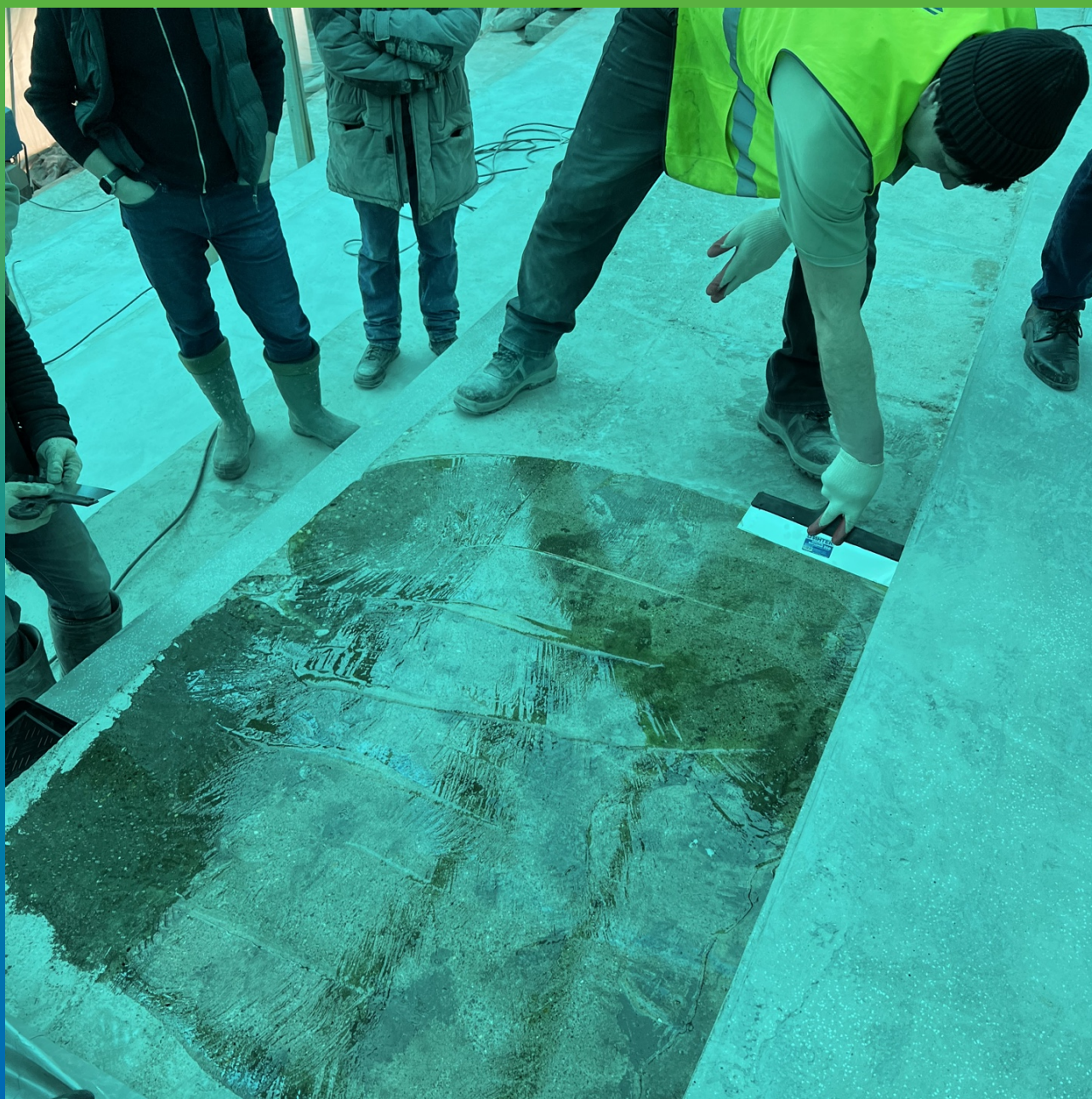
Нанесение грунтовочного состава на поверхность
