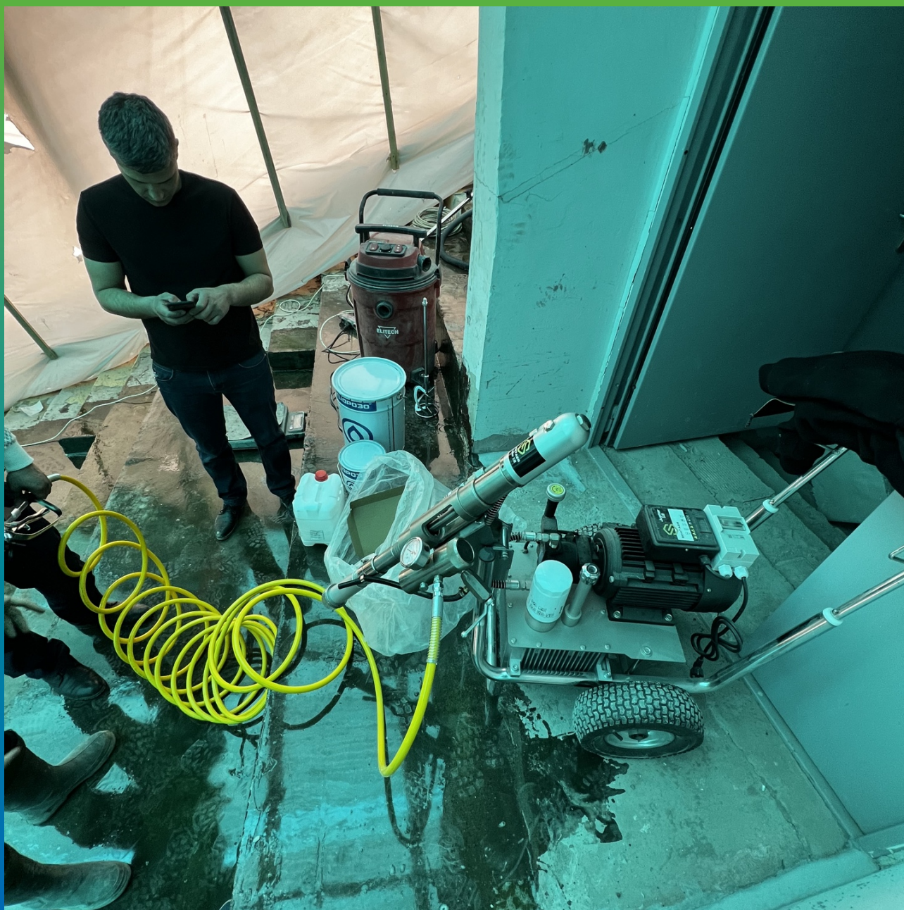
Подготовка оборудования для безвоздушного нанесения состава ДенсТоп ПУ 227 Эластик
