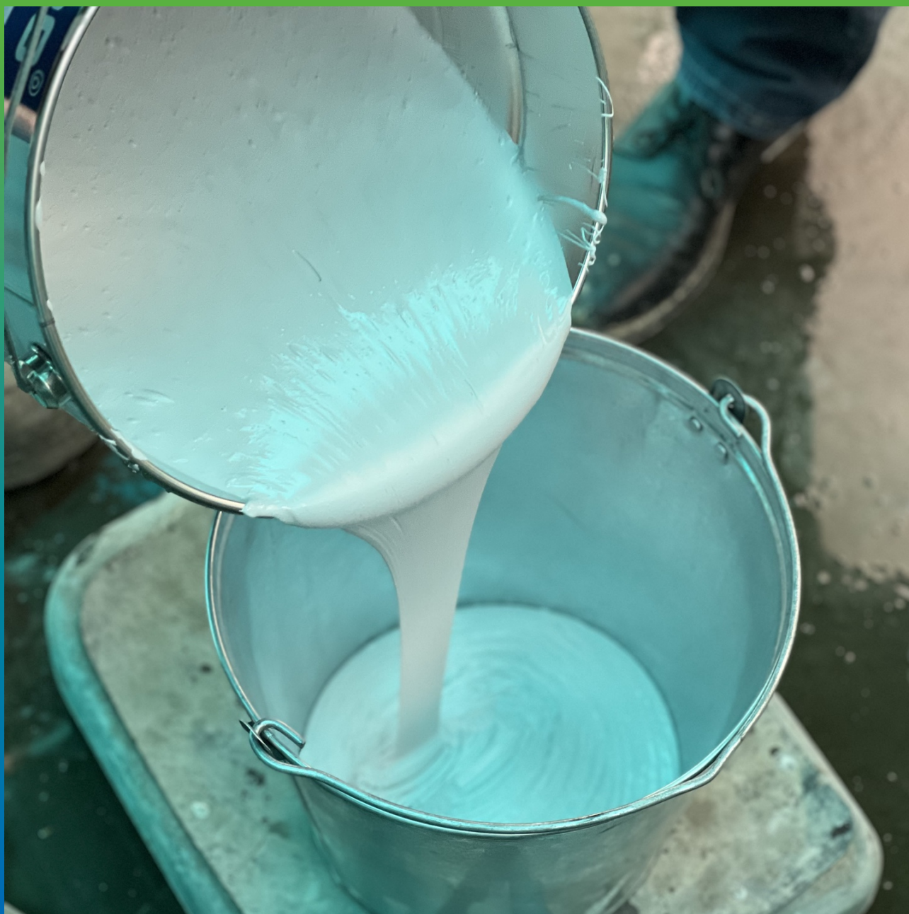
Замешивание состава ДенсТоп ПУ 227 Эластик
