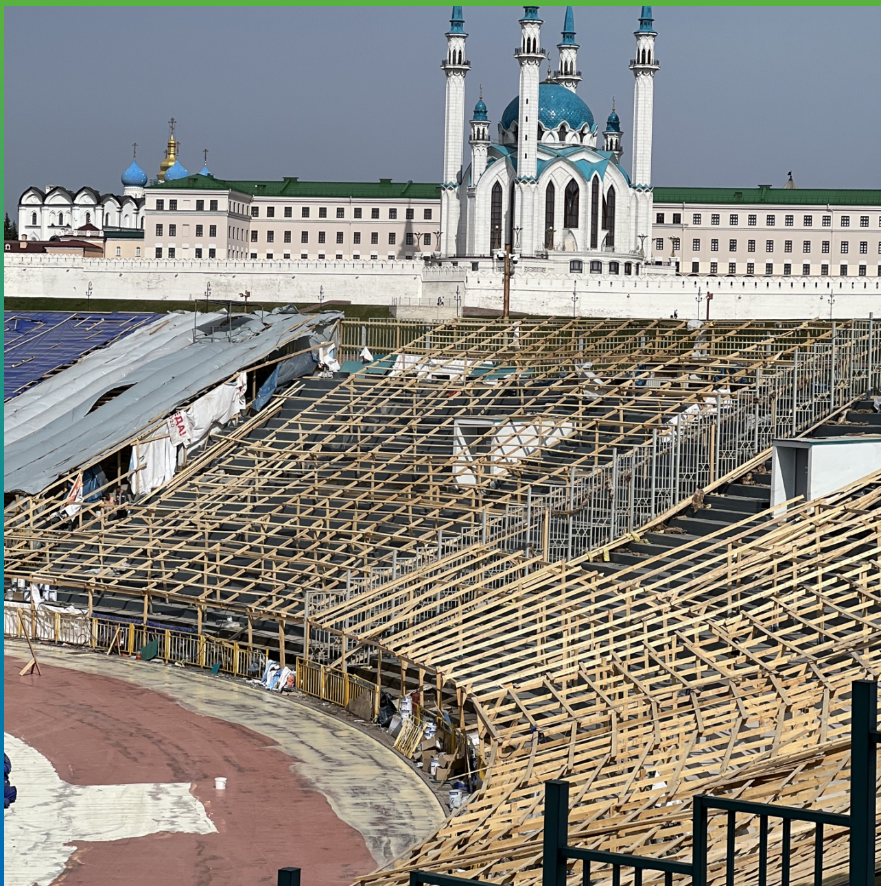
Демонтаж теплового контура
