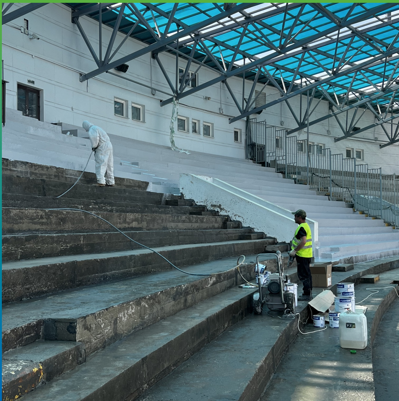
Нанесение ДенТоп ПУ 227 Эластик
