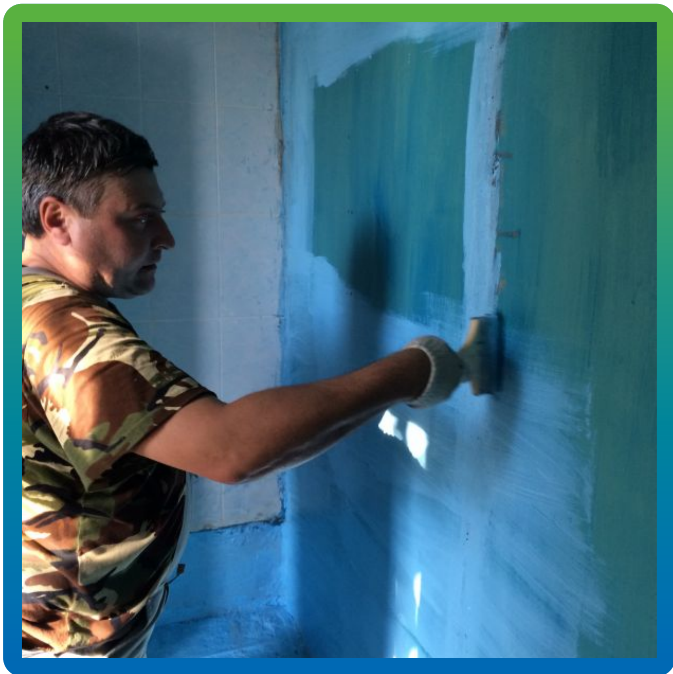
Нанесение второго слоя гидроизоляции
