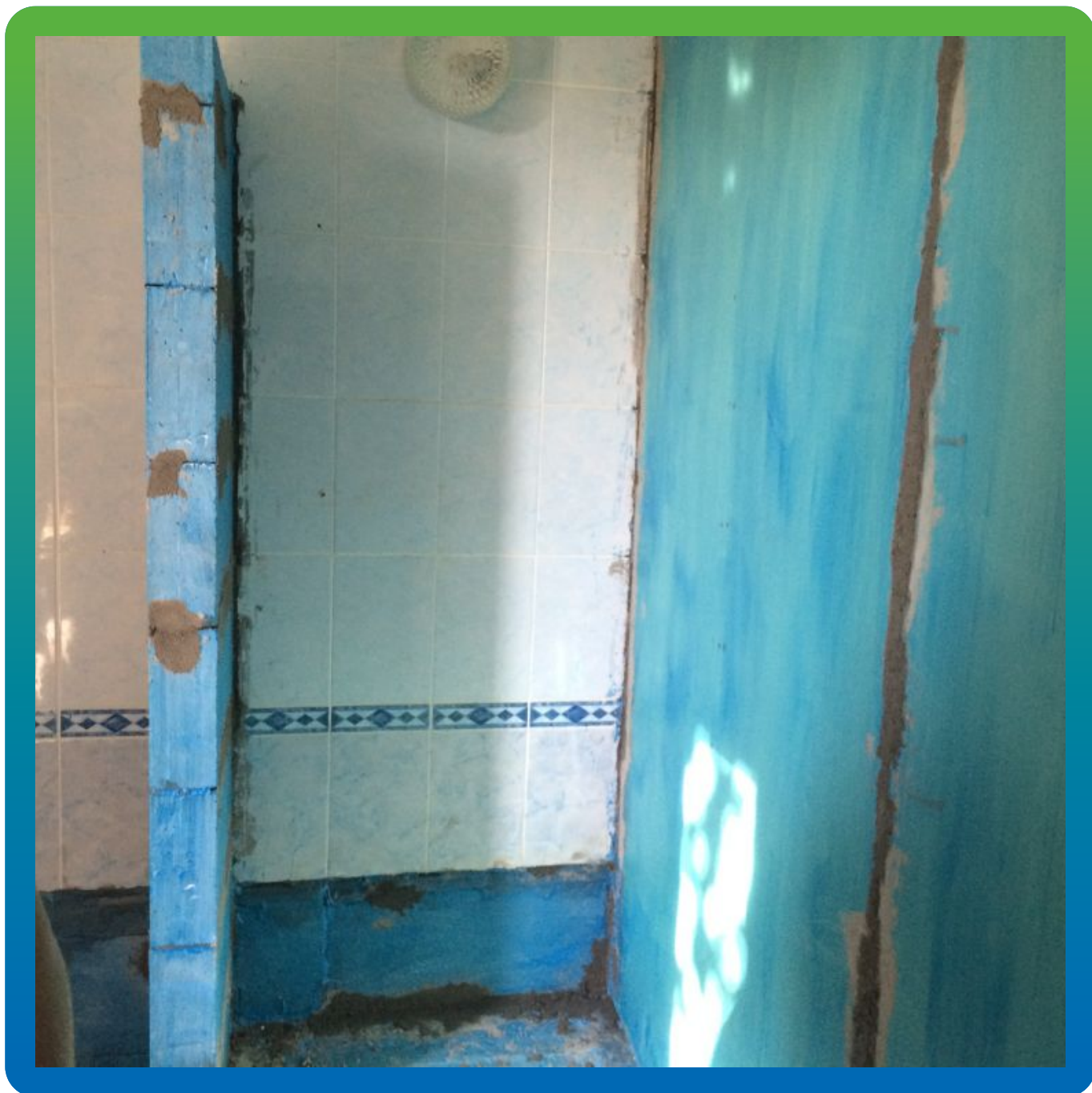
Первый слой гидроизоляции
