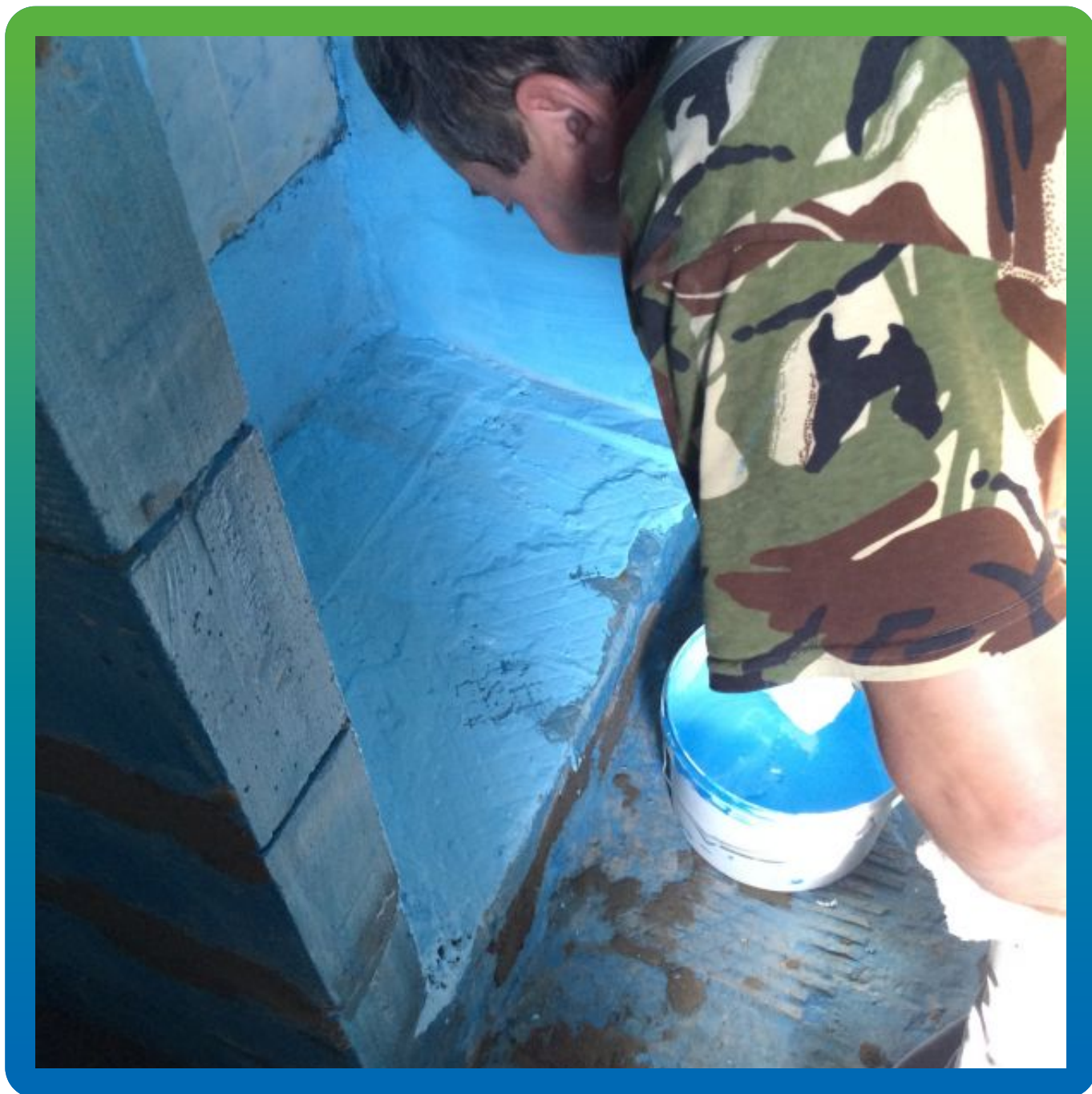
Нанесении первого слоя гидроизоляции
