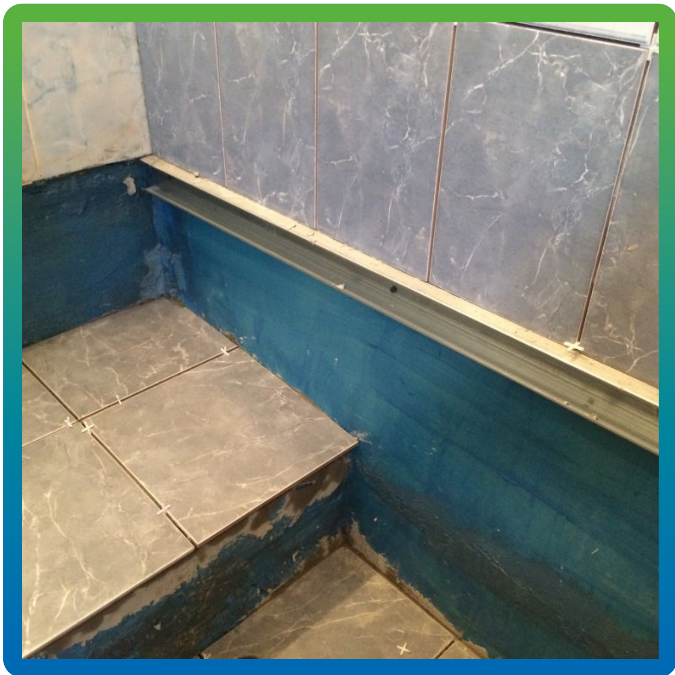
Укладка плитки на клей
