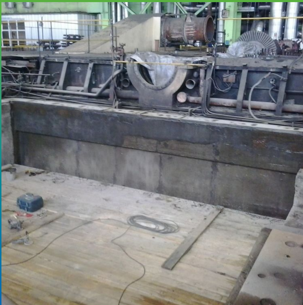
Чеканка шпуров ремонтным составом Максрайт 500 после демонтажа пакеров
