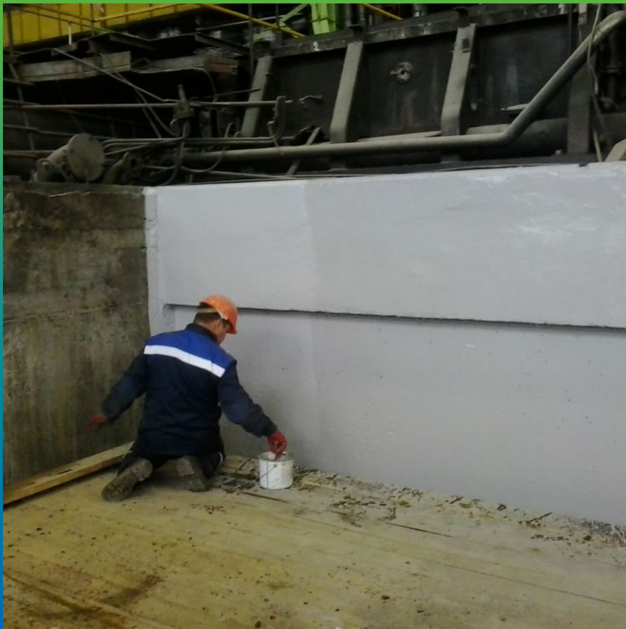
Нанесение защитного эпоксидного состава Максэпокс флекс на первый слой
