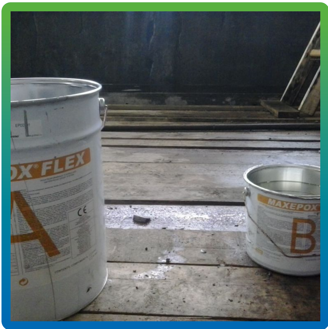
Замес двухкомпонентного защитного эпоксидного состава Максэпокс Флекс
