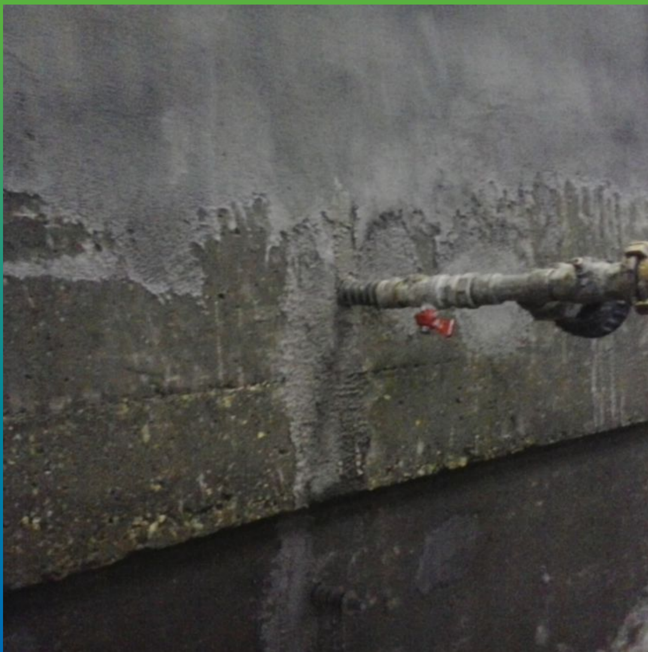
Инъектирование микроцемента Максгруут инжекшн в трещину через пакеры
