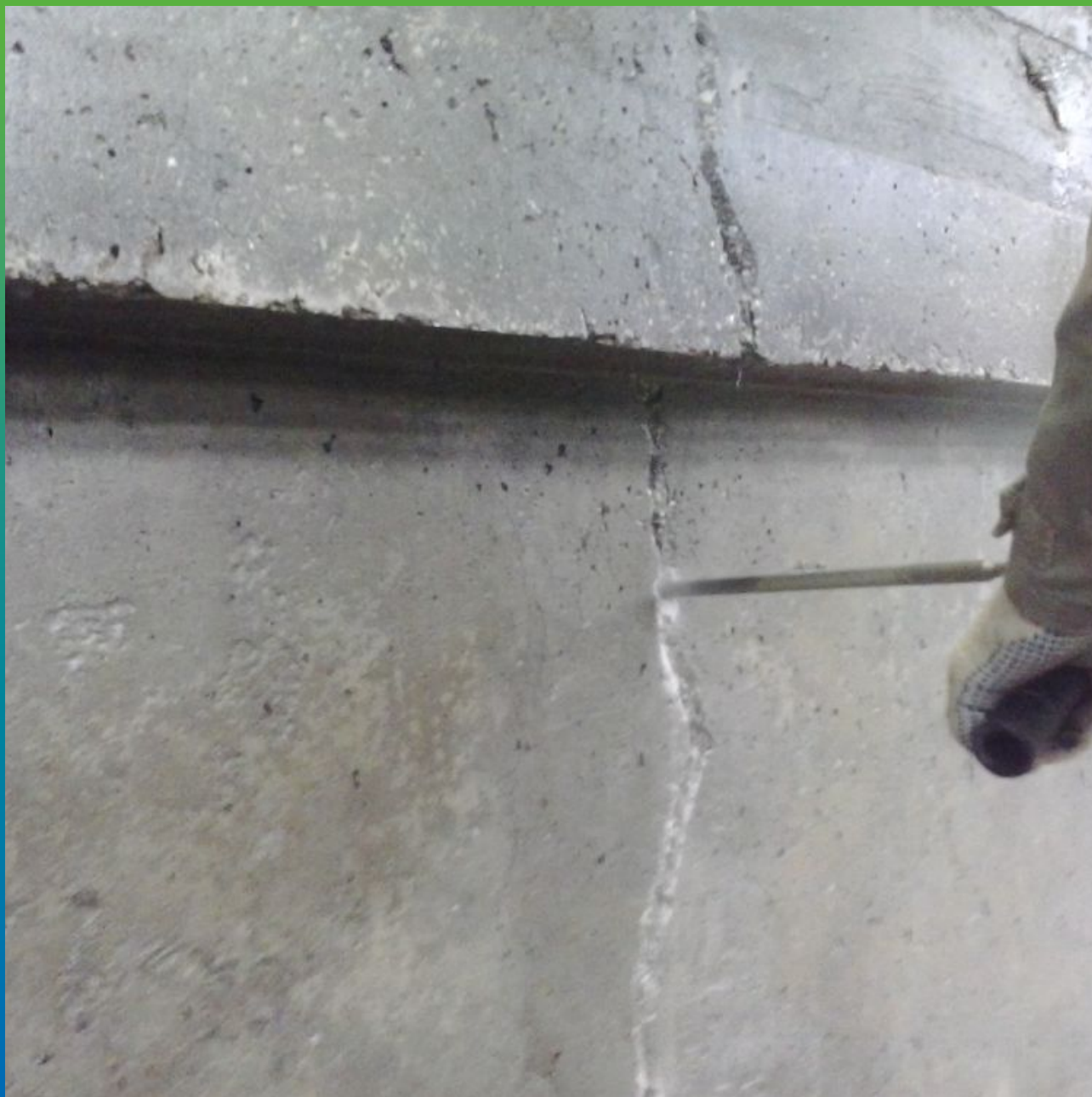
Расшивка швов трещин
