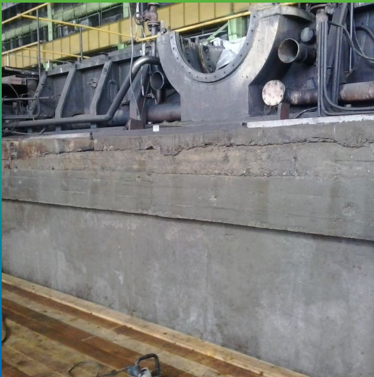
Общий вид жб фундамента турбогенератора до проведения работ
