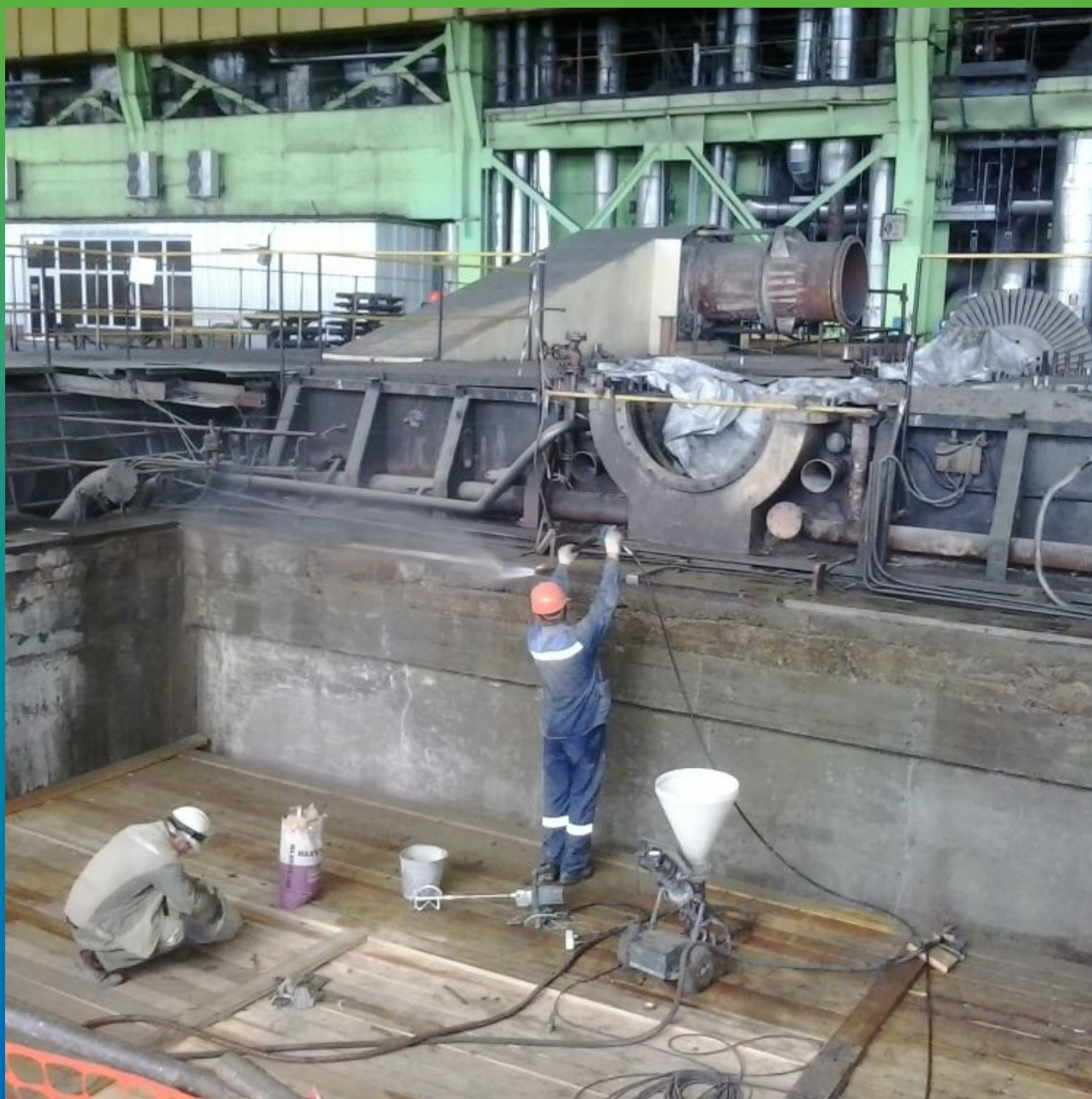
Подготовка и проверка инъекционного шнекового насоса БМП 6
