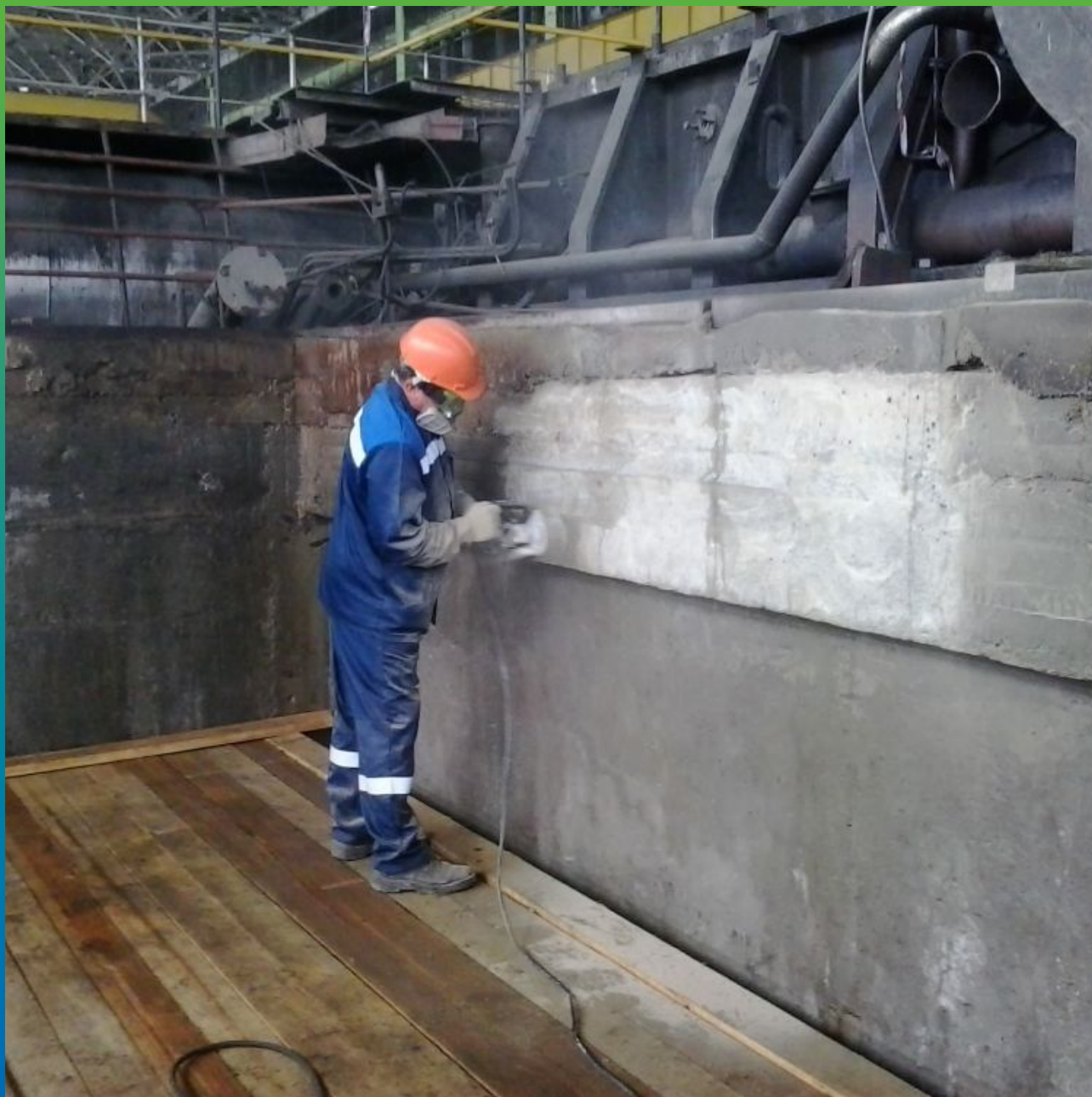
Механическая обработка жб, снятие структурно не прочного слоя
