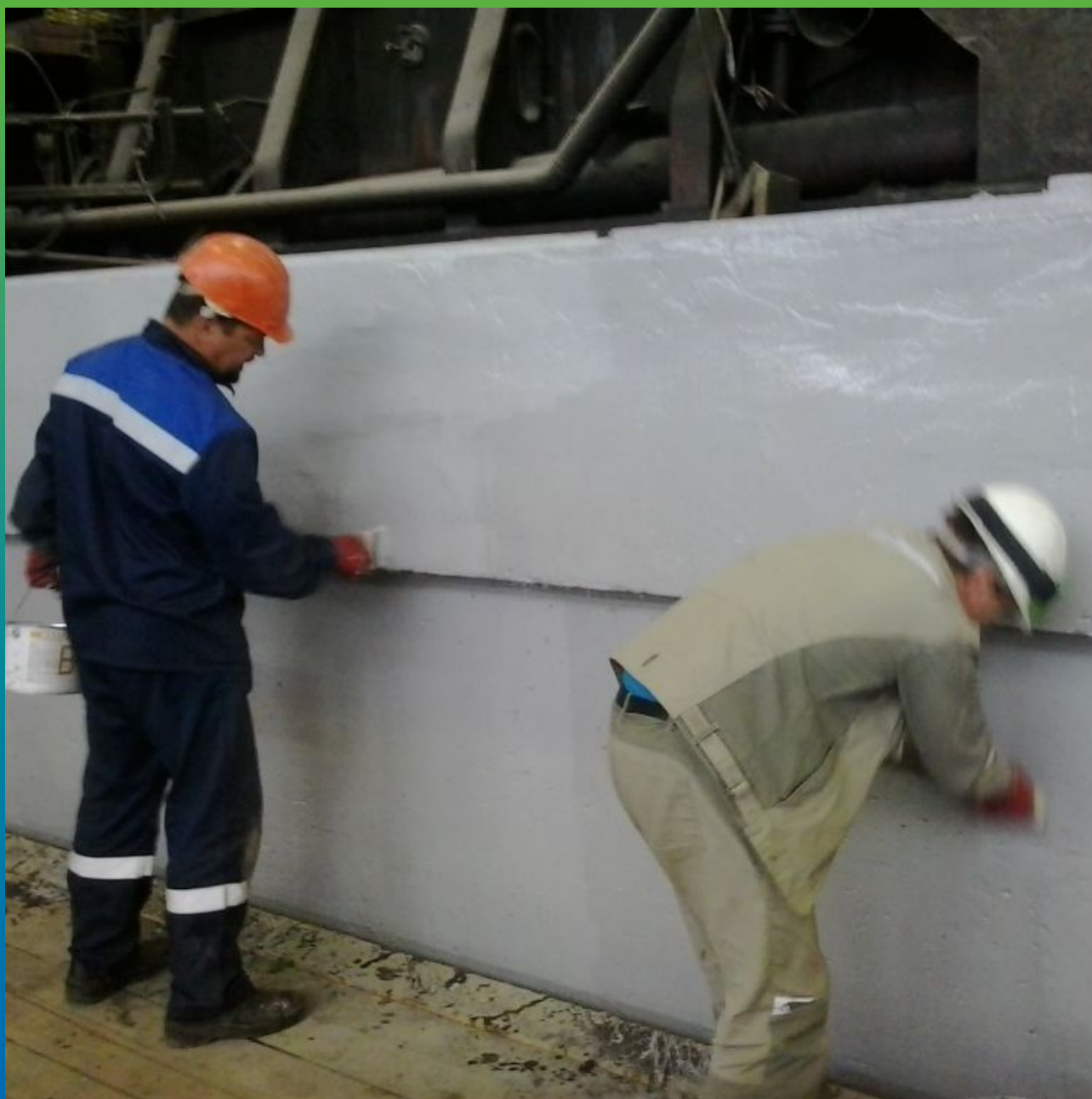
Нанесение защитного эпоксидного состава Максэпокс флекс на второй слой
