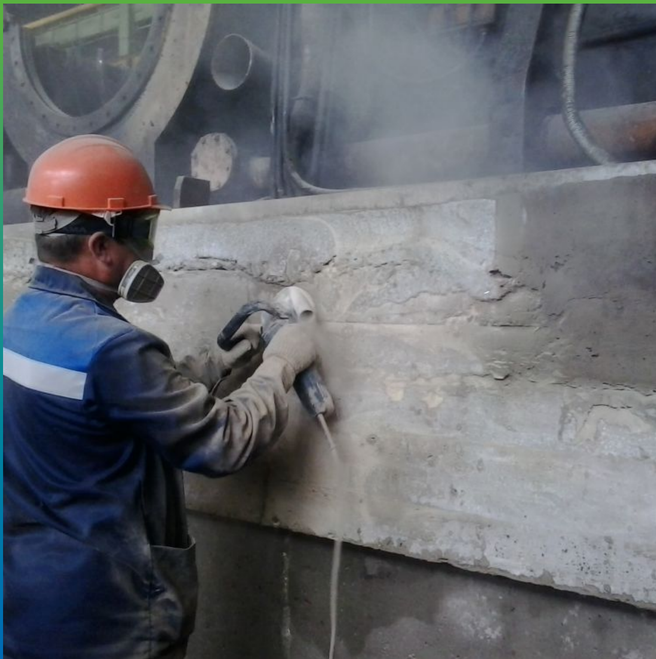
Механическая обработка основания, выравнивание основания
