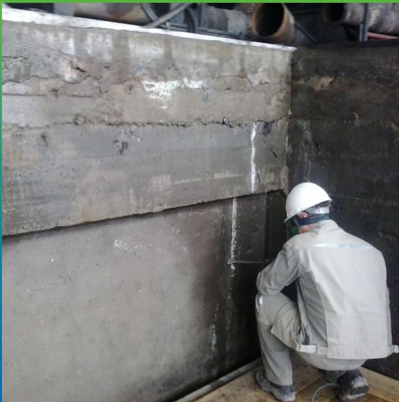
Расшивка швов трещин общий вид
