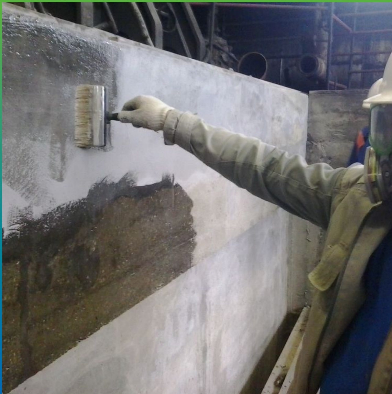
Нанесение эпоксидной грунтовки для влажных и промасленных оснований ДенСТОП ЭП 106
