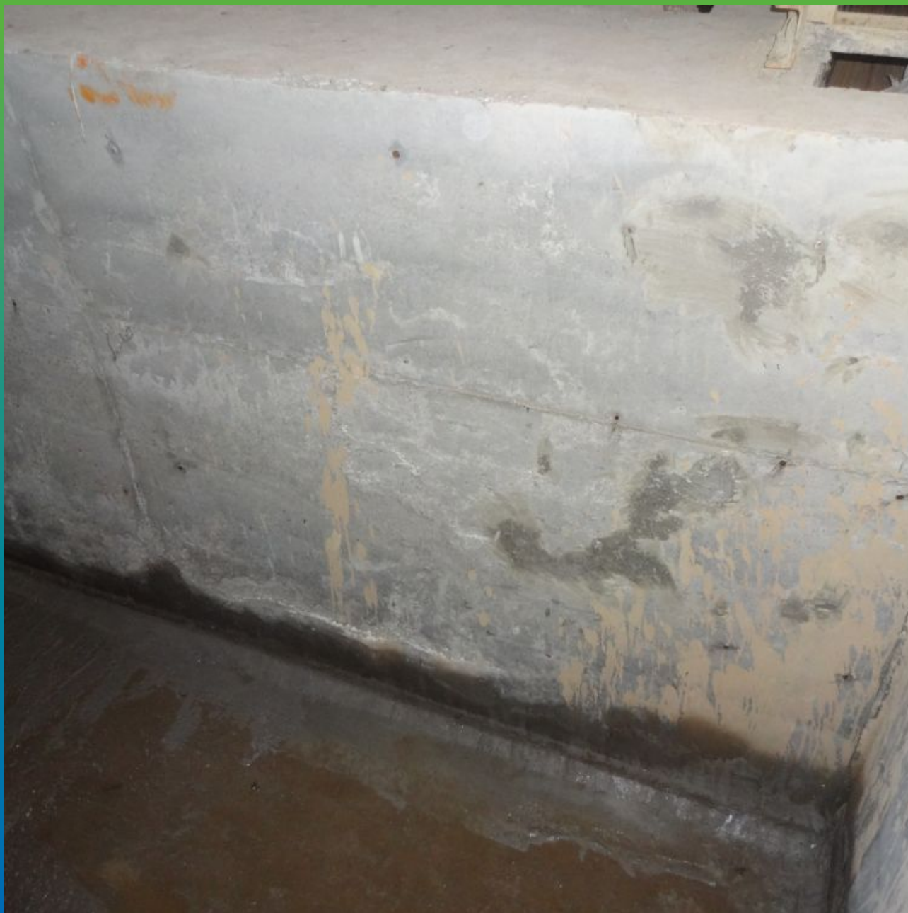
Нанесение гидроизолирующего покрытия Стармекс Сил Флекс
