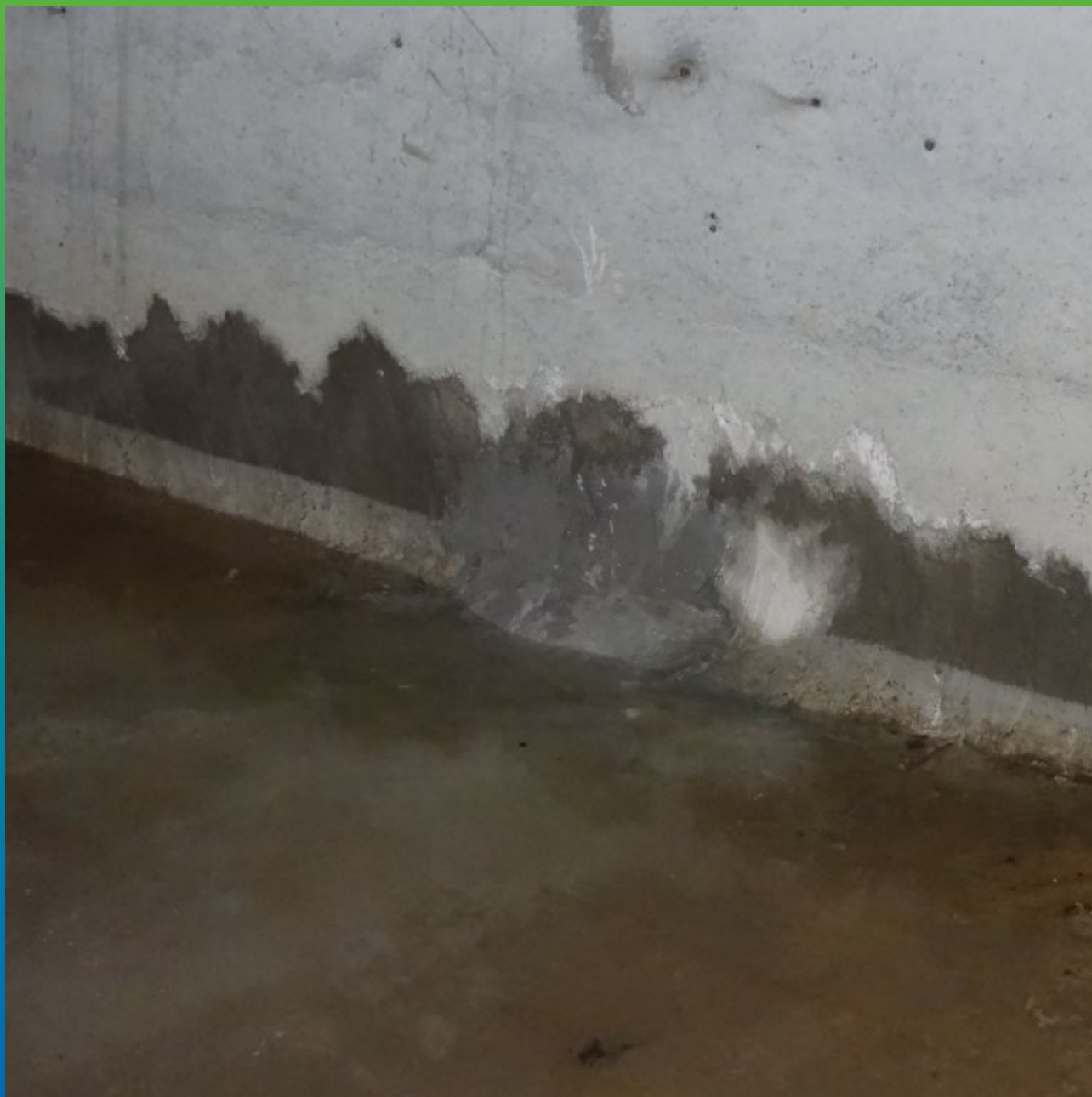
Устранение активных течи воды с помощью гидропломбы Максплаг
