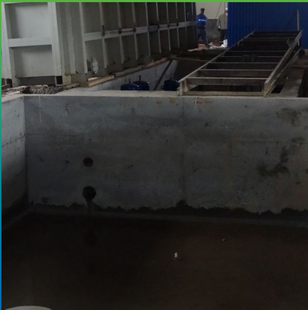
Объект после проведения работ по гидроизоляции и ремонту
