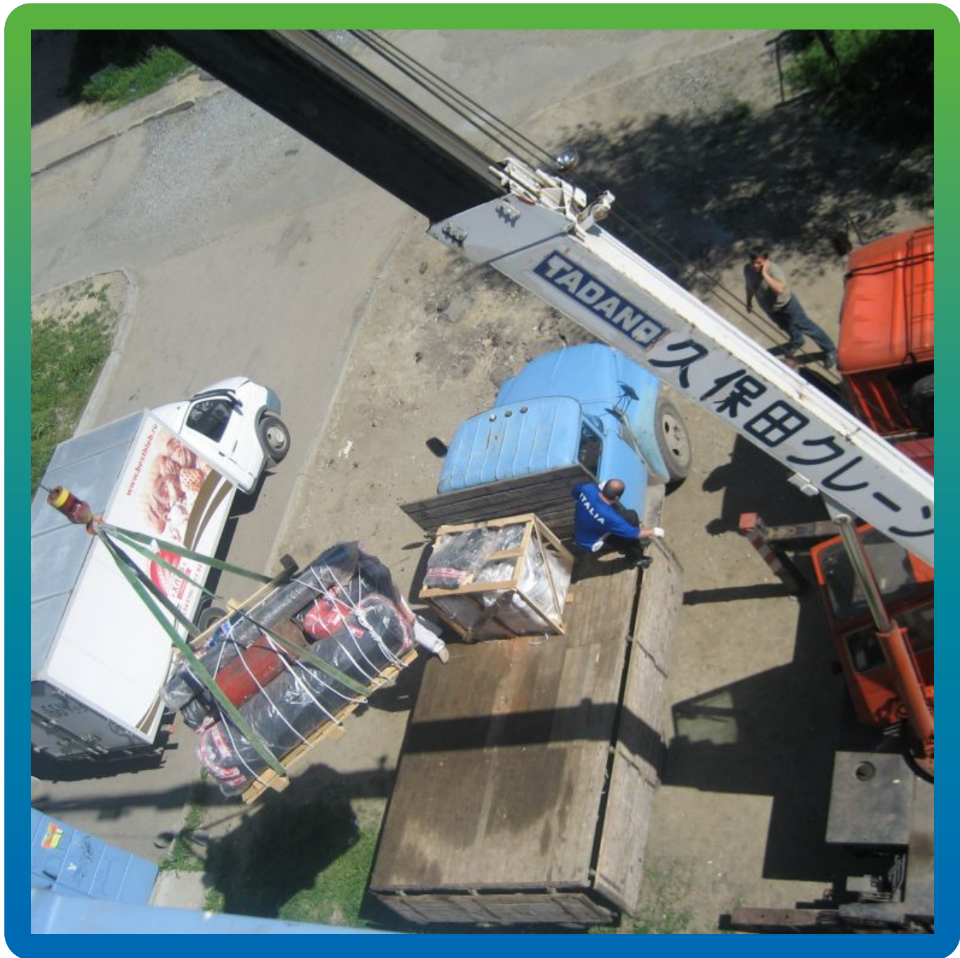
Подъем ЭПДМ мембраны на кровлю
