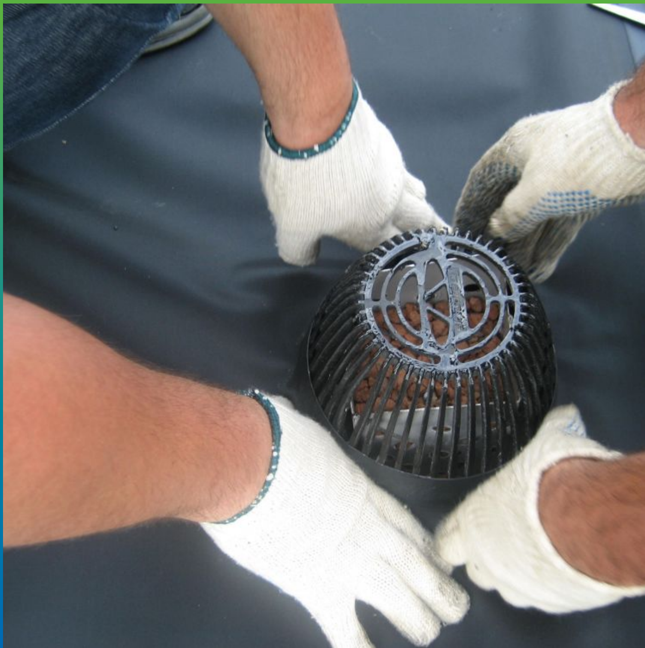
Устройство аэратора
