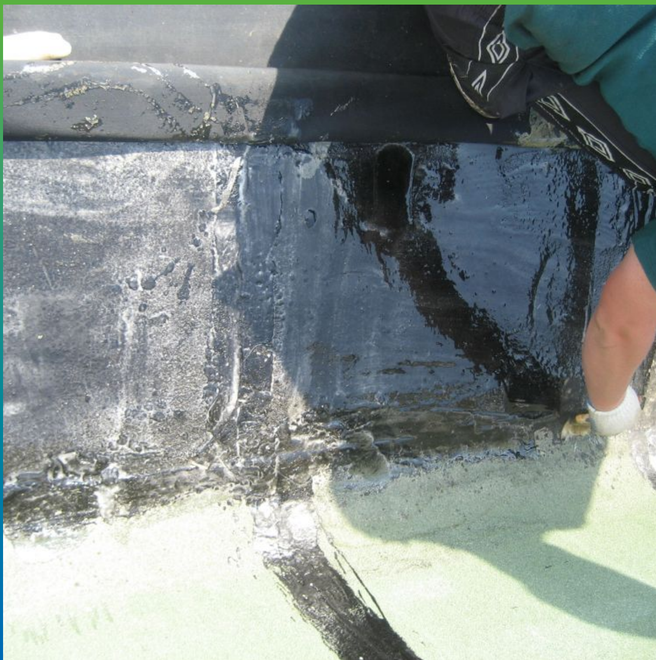
Нанесение адгезива П400 на основание
