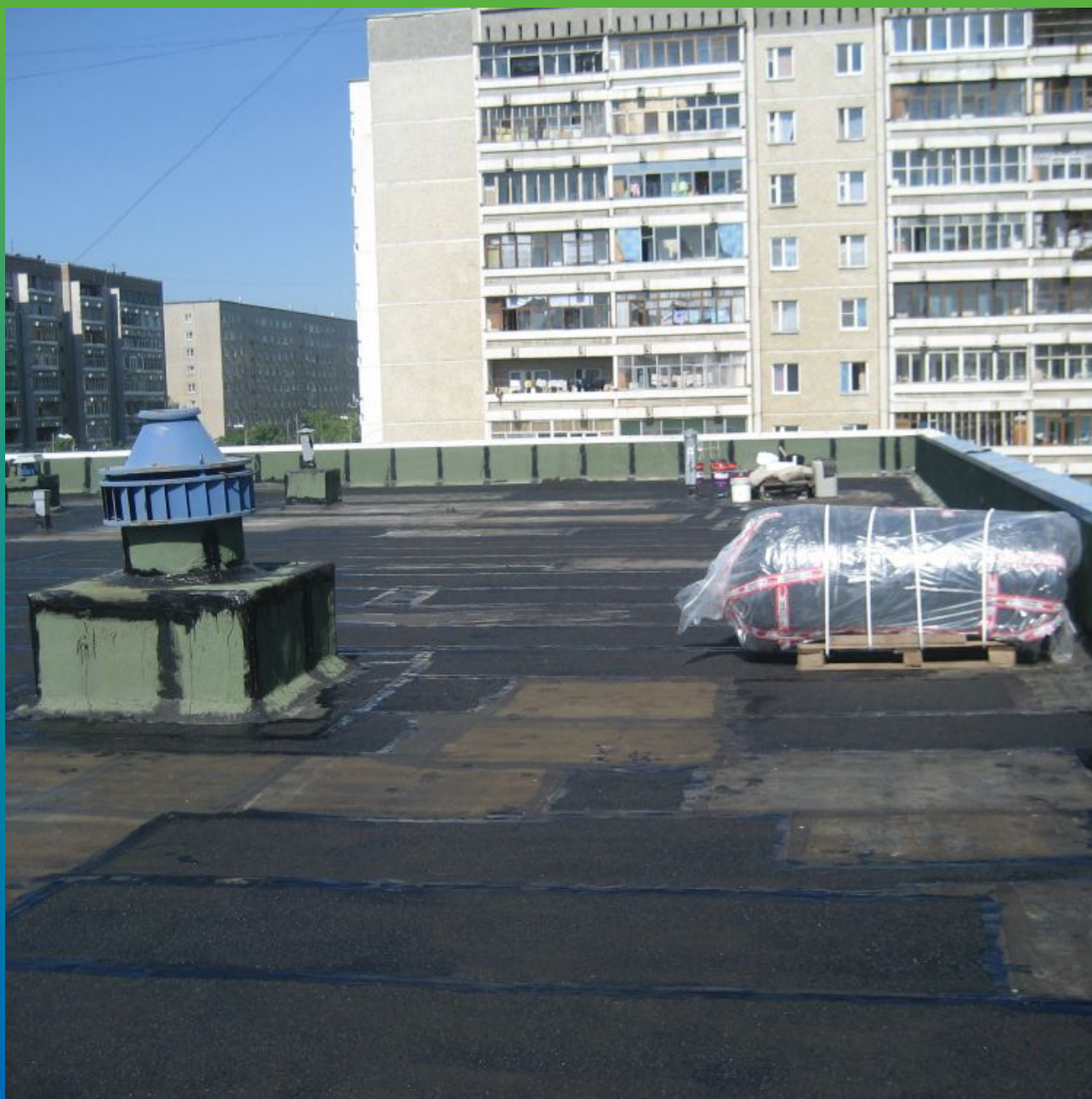
Вид материала на объекте
