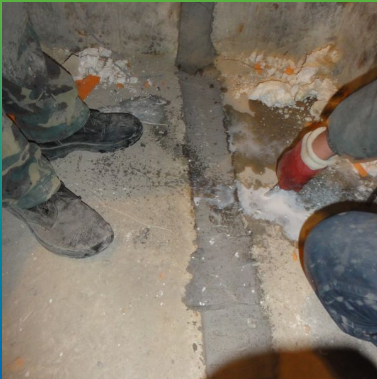
Инъектирование Манокрил Гель Р с присадкой Манокрил Флекс
