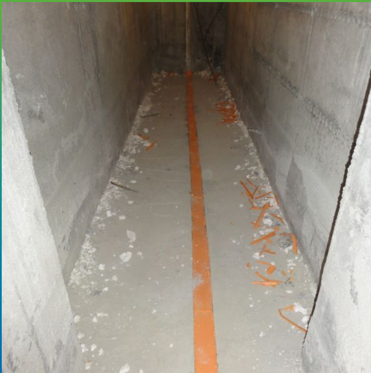
Подготовка шва перед инъектированием
