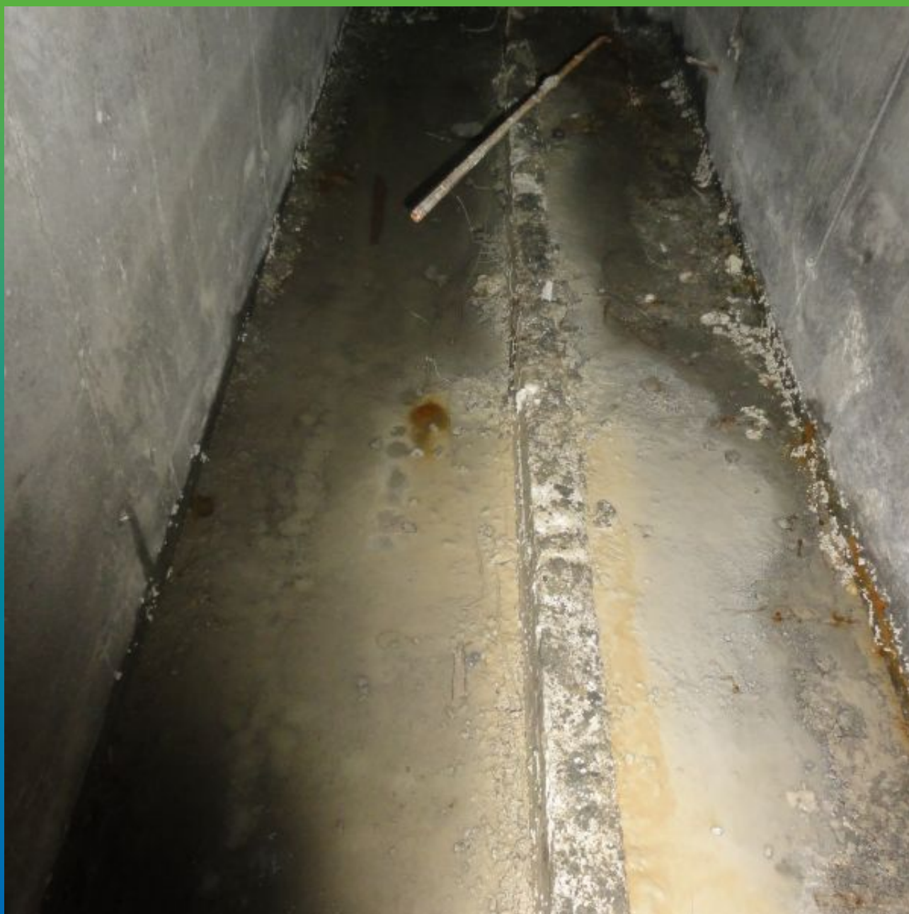
Вид деформационного шва до начала работ
