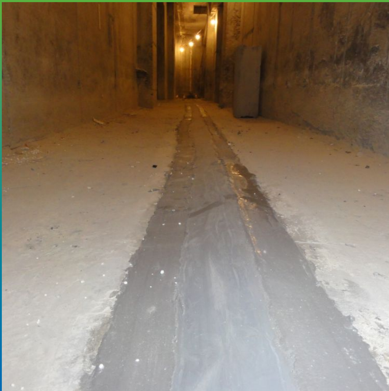
Финальный вид шва с наклеенной лентой Манодил Про на адгезив Манопокс 331
