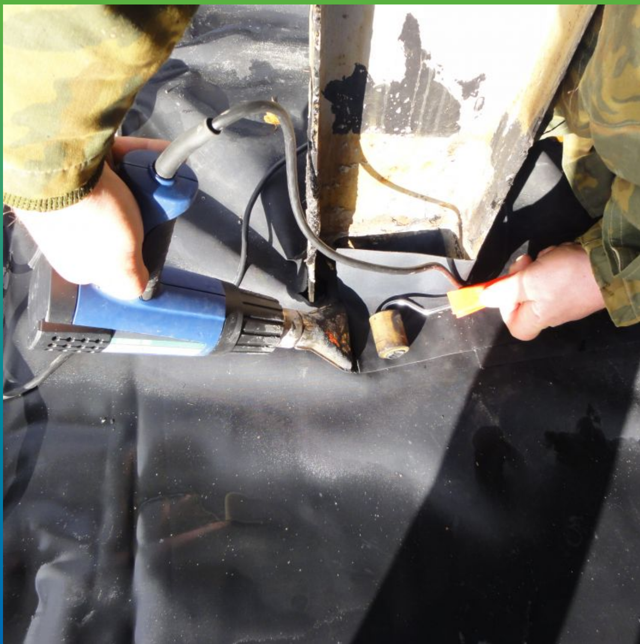
Проварка закладных деталей с помощью ленты Термобонд
