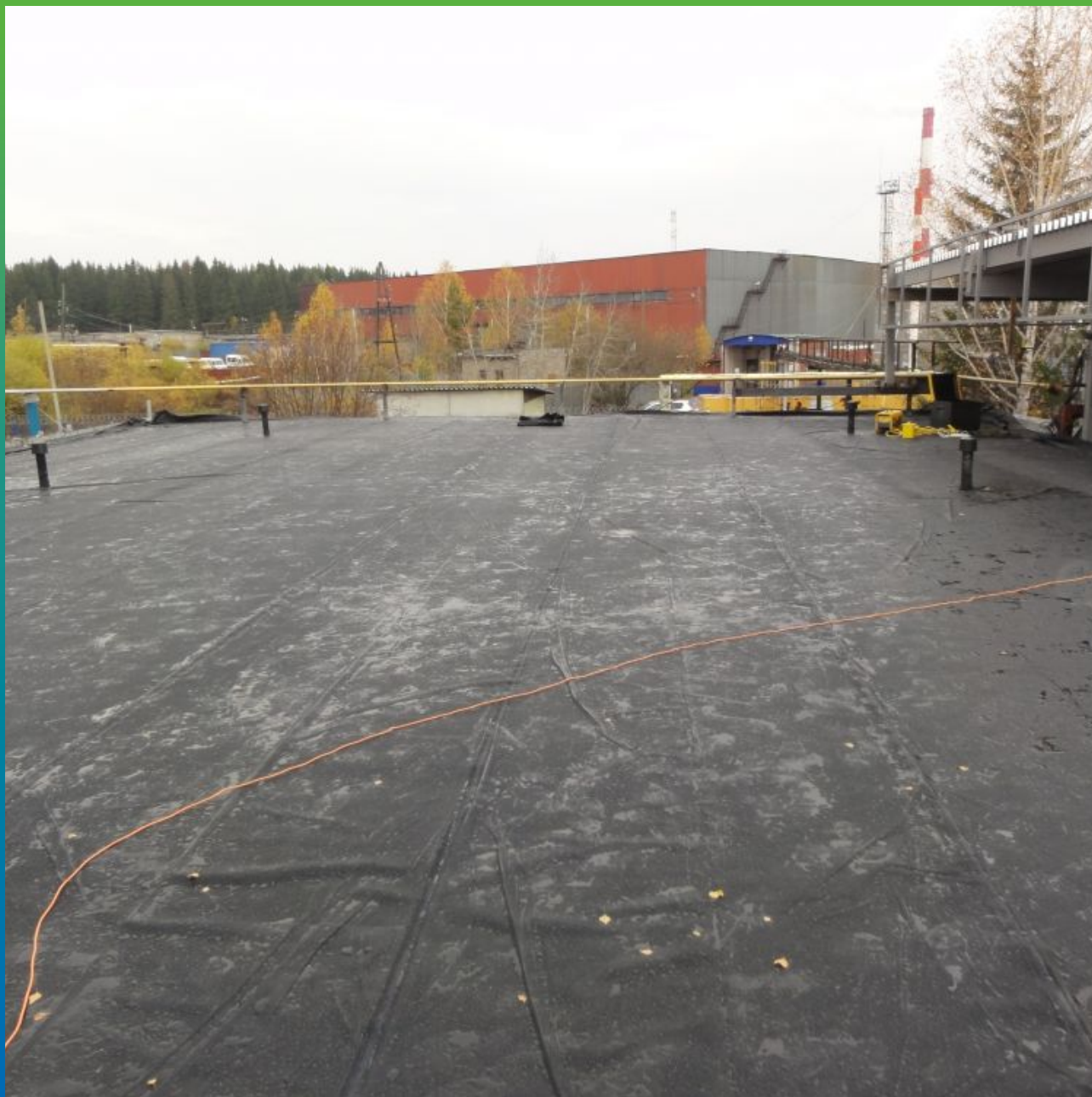
Вид уложенной ЭПДМ мембраны (нижняя кровля)
