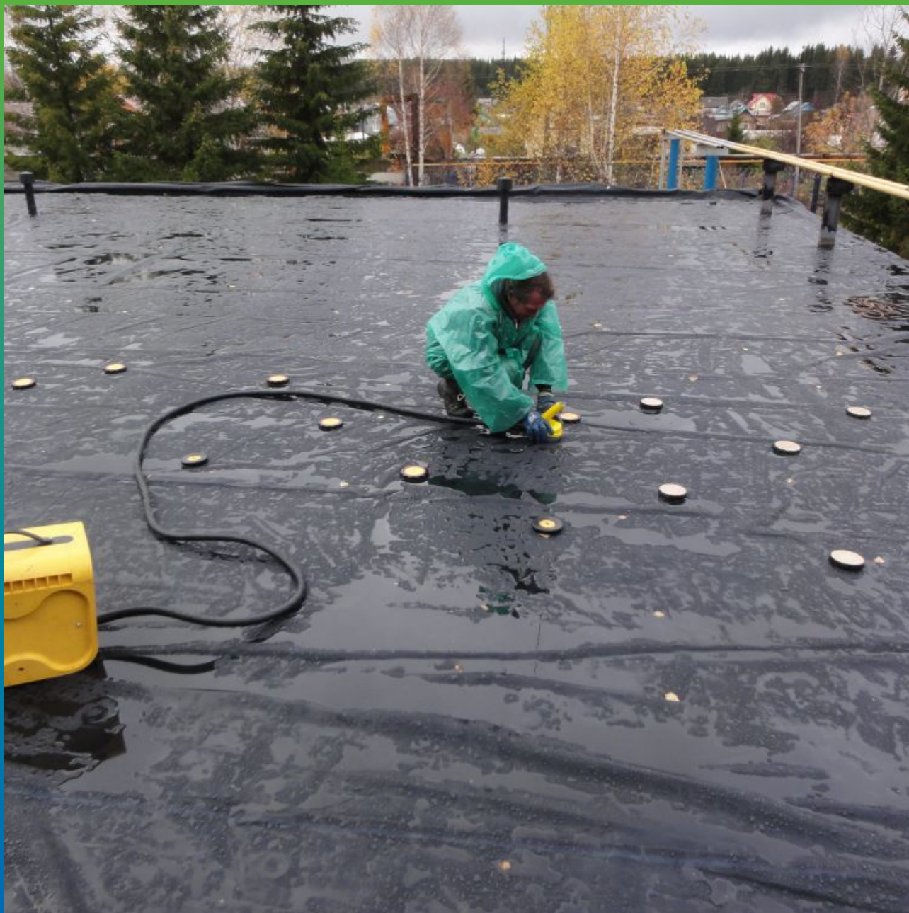
Крепление ЭПДМ мембраны по системе Центрикс
