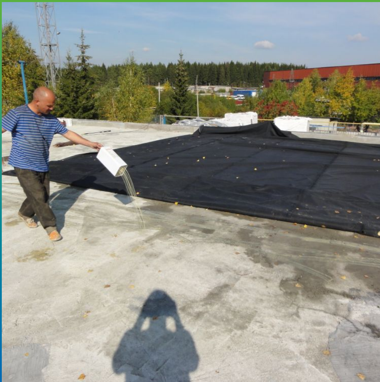
Нанесение адгезива П400 на основание
