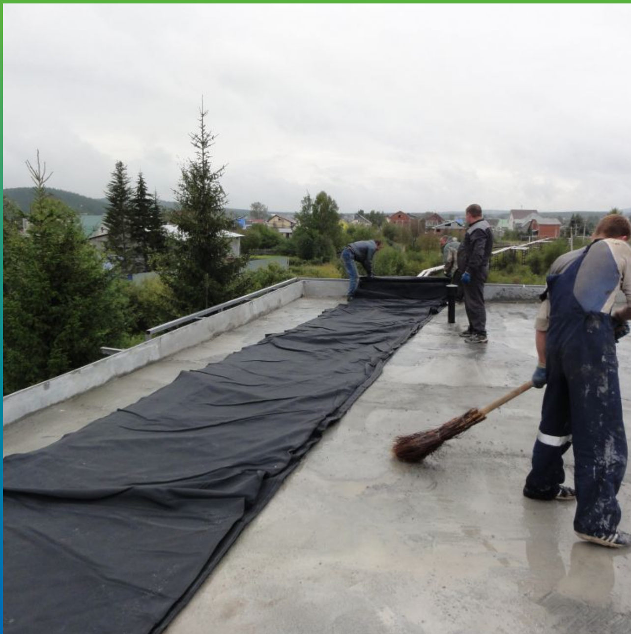
Уборка основания, укладка ЭПДМ мембраны
