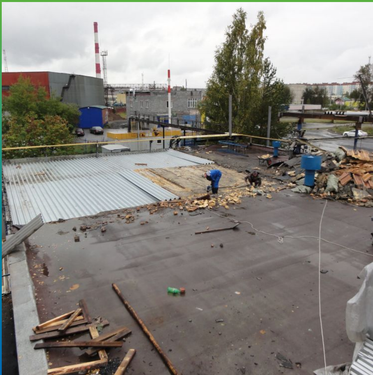
Демонтаж и замена старого кровельного пирога (нижняя кровля)
