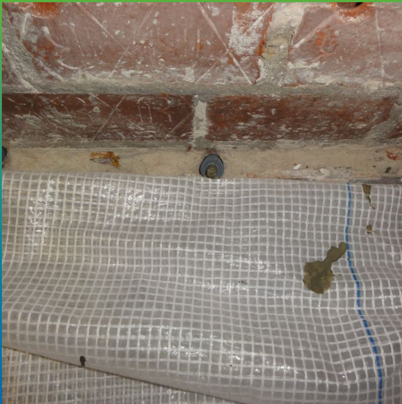
Инъектирование микроцементом Максгрут Инжекшн
