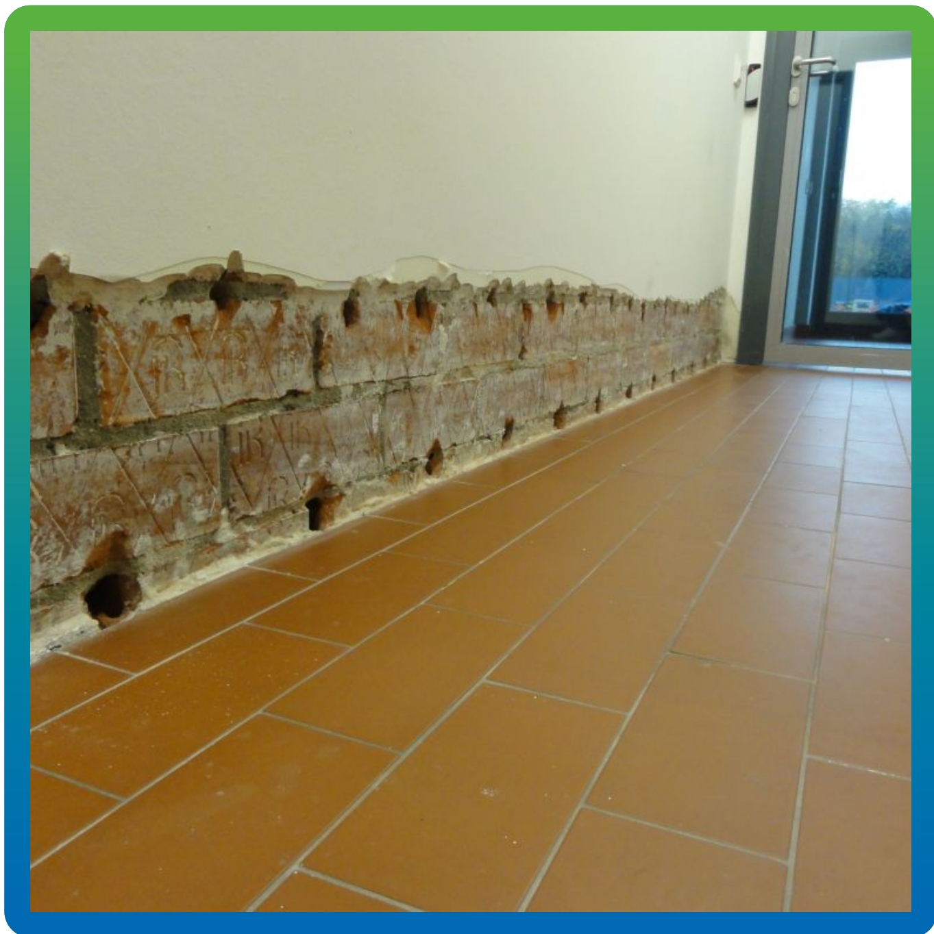
Устройство шпуров перед инъектированием
