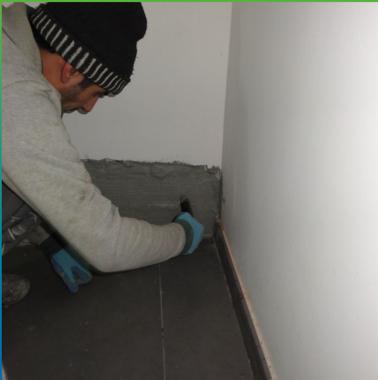
Нанесение полимерцементного состава Максил Флекс
