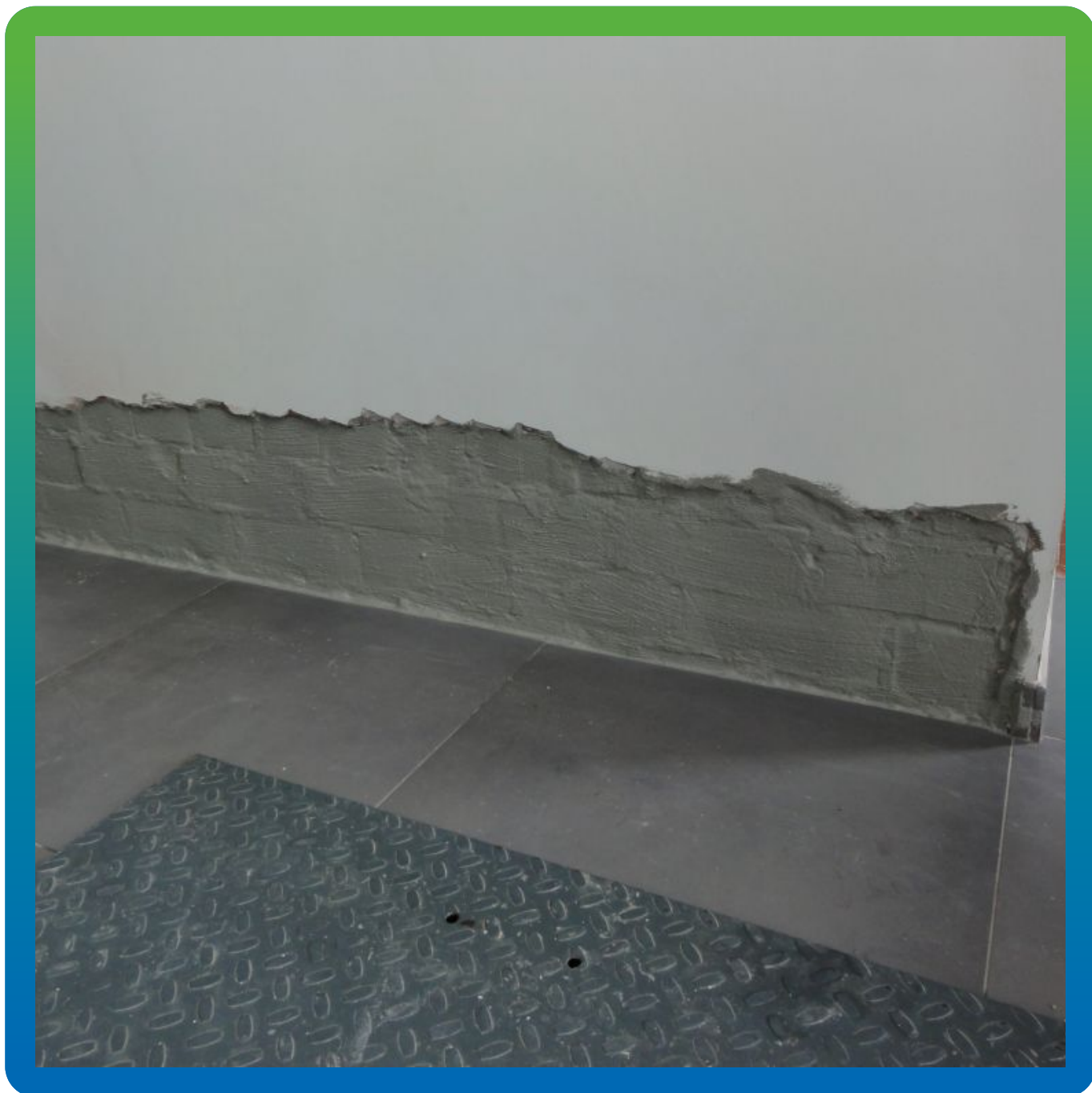
Финальный вид проблемного участка после проведения работ
