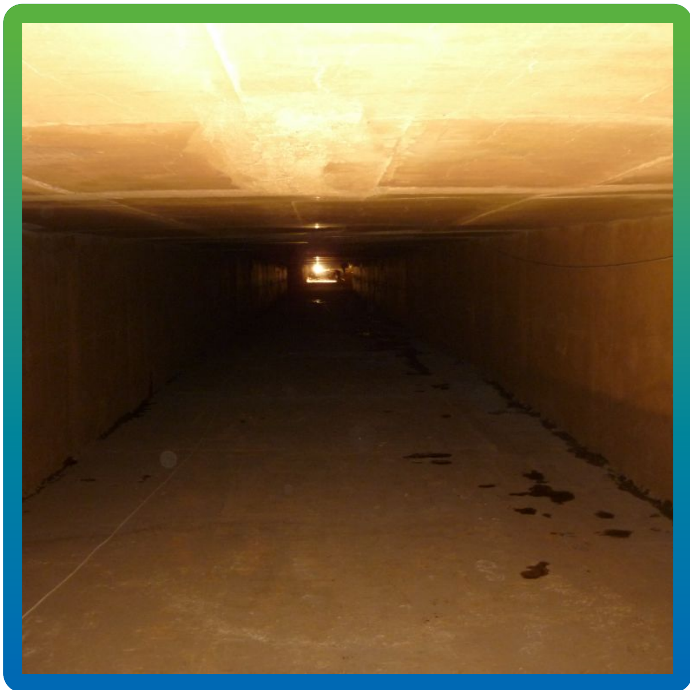
Вид водоотводящего лотка градирни
