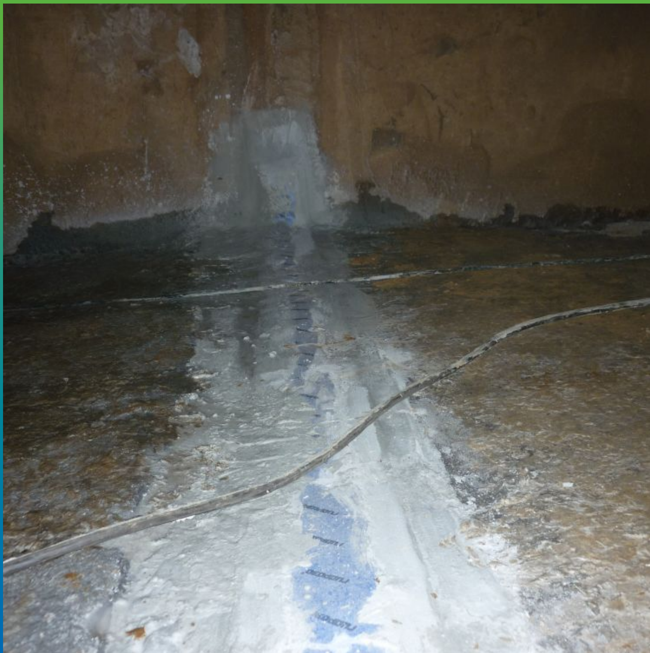
Герметизация деформационного шва гидроизоляционной лентой Манодил Гео 180
