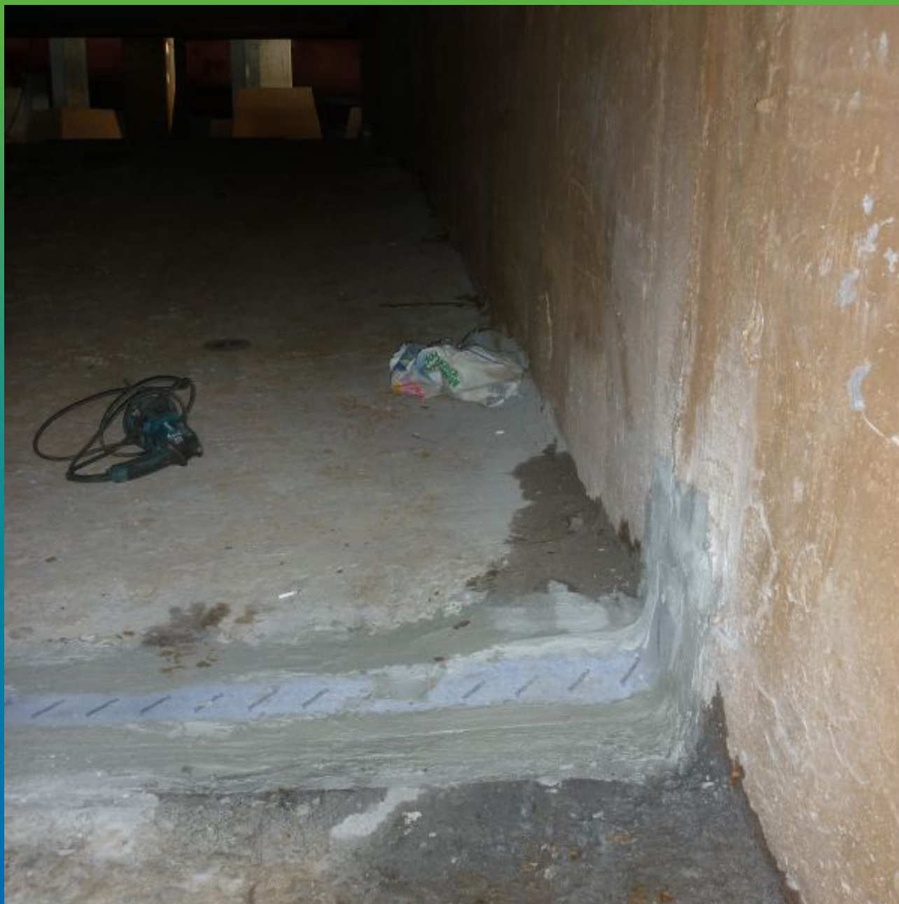
Герметизация деформационного шва гидроизоляционной лентой Манодил Гео 180
