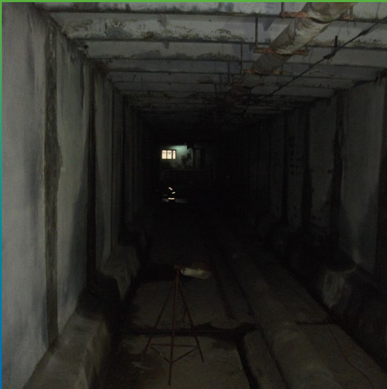
Вид аэротенка изнутри
