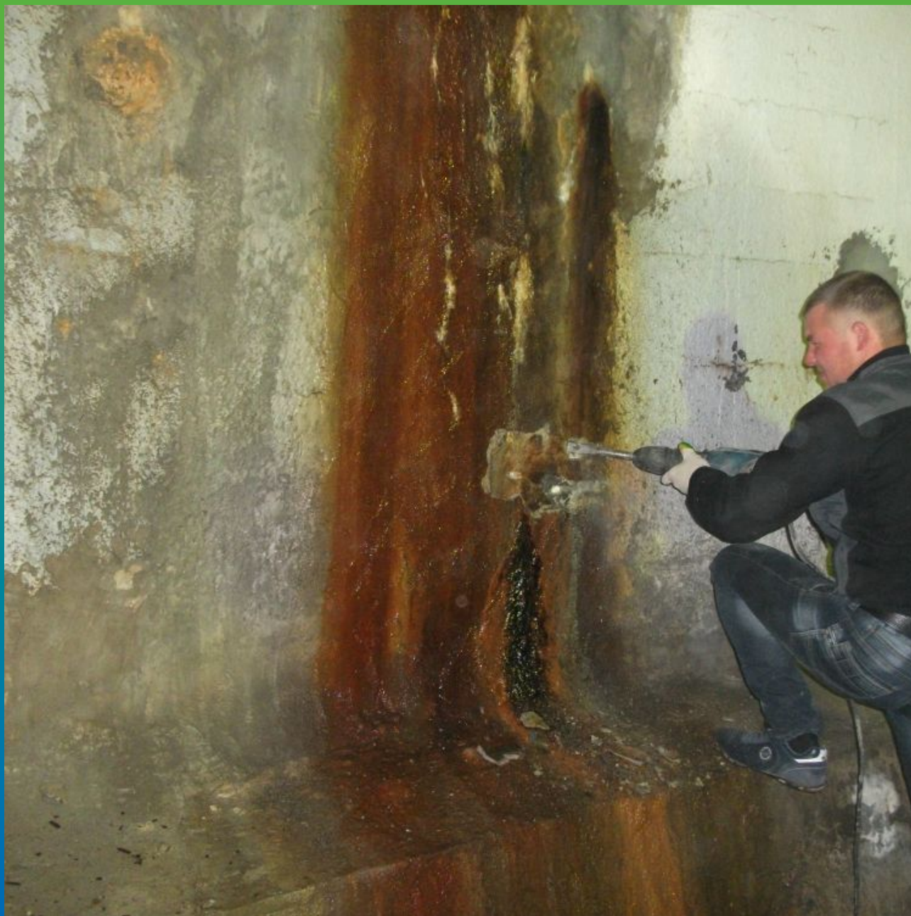
Подготовка шва перед инъектированием Манопур С
