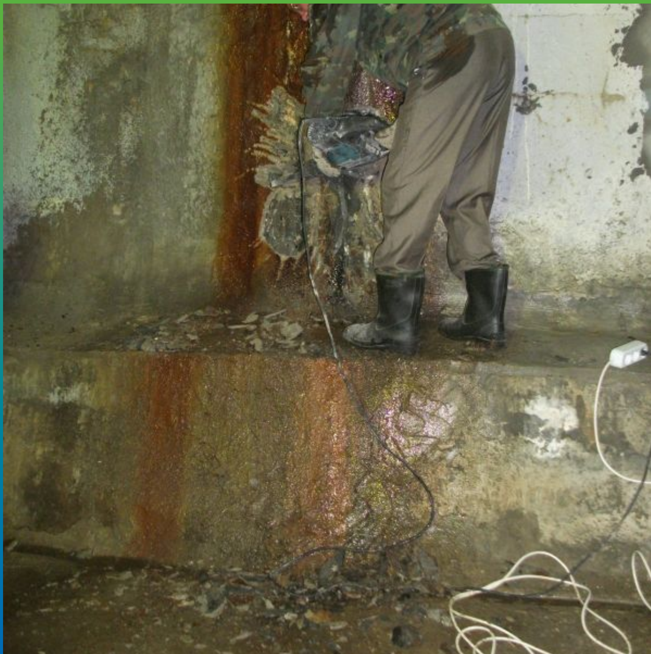
Подготовка шва перед нанесение Макслага
