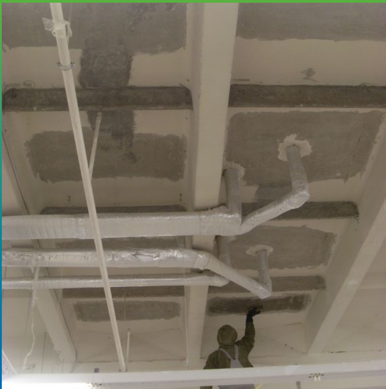
Грунтование поверхности
