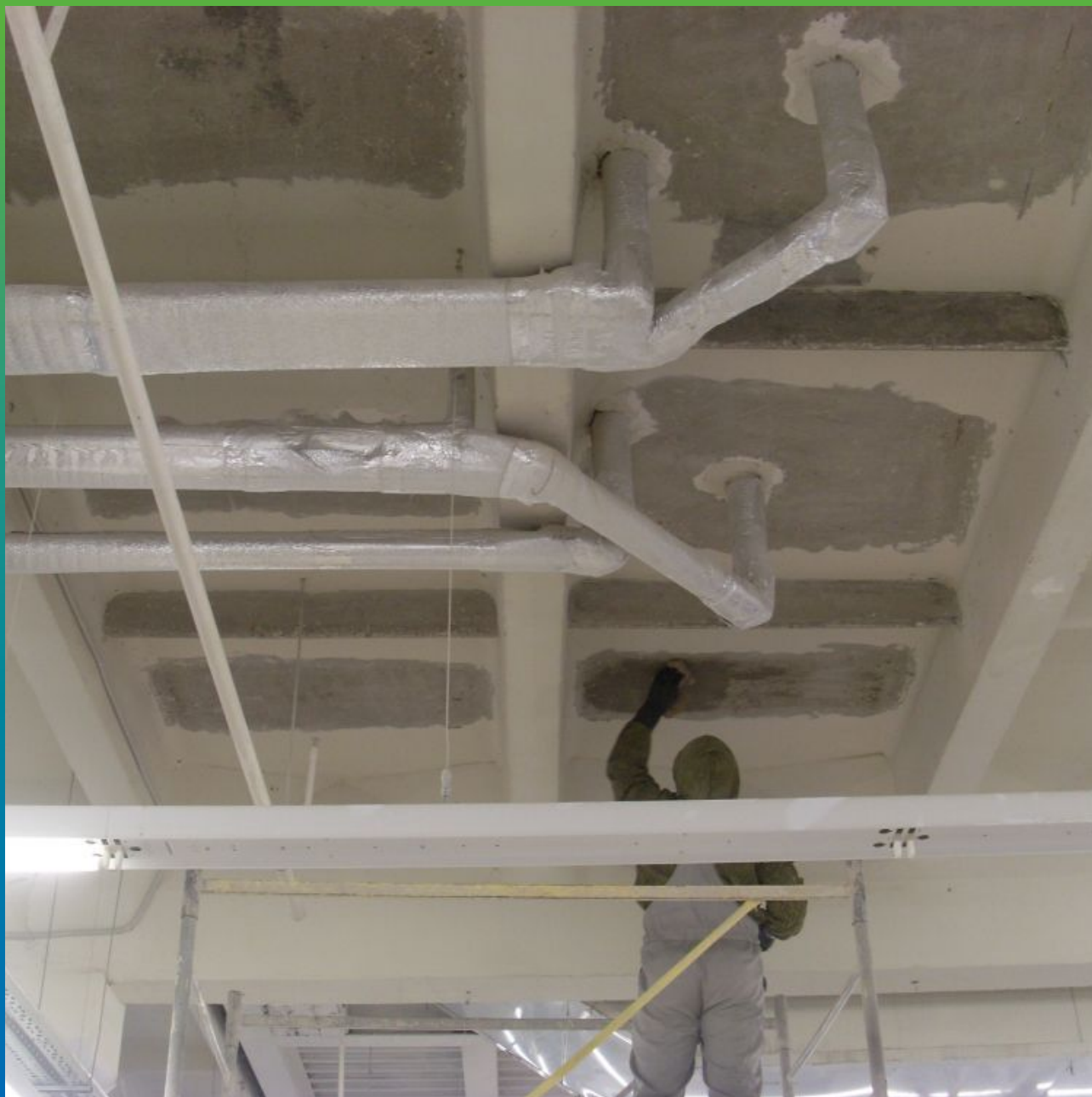
Грунтование поверхности
