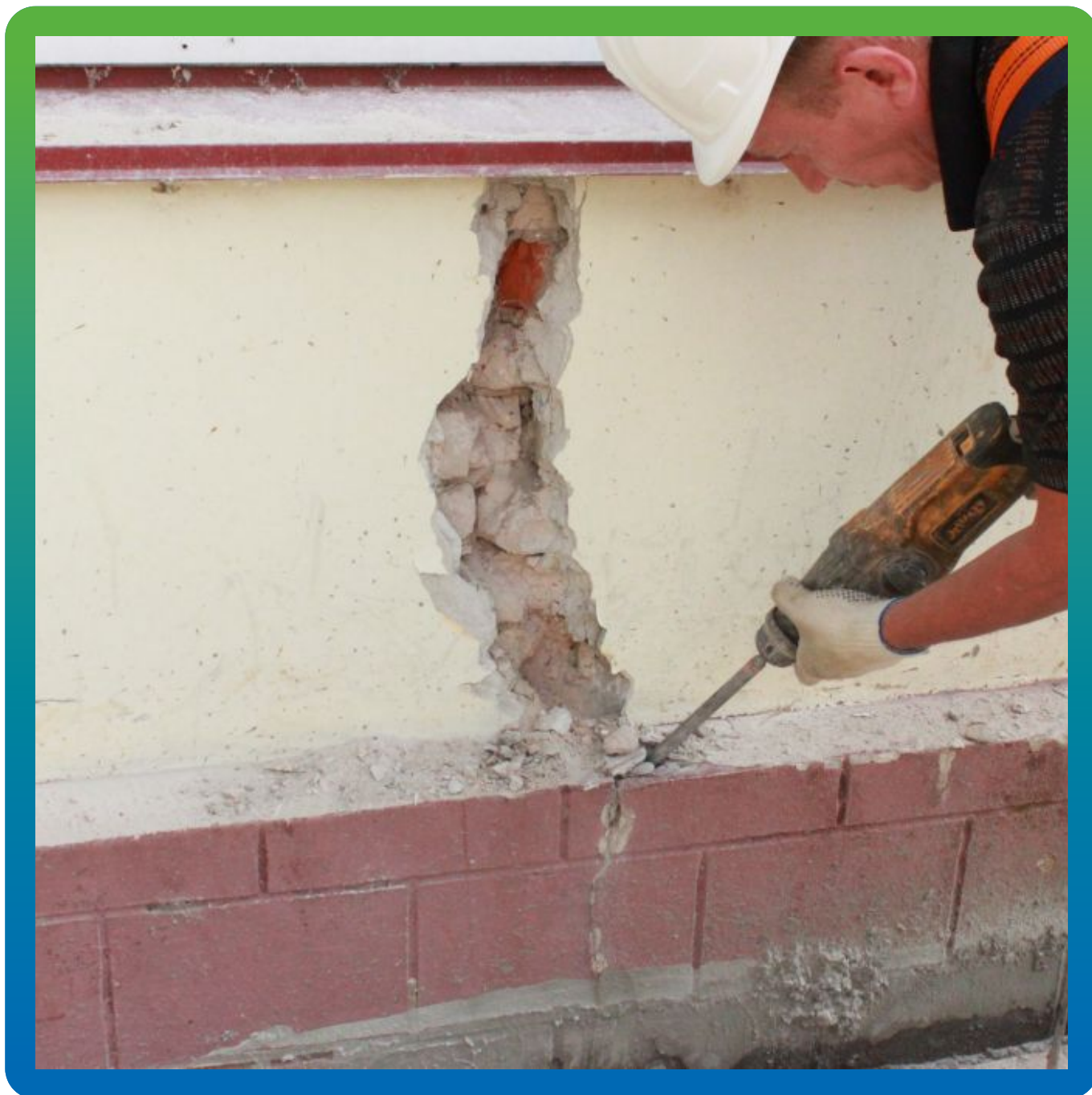
Демонтаж штукатурки и расшивка трещины
