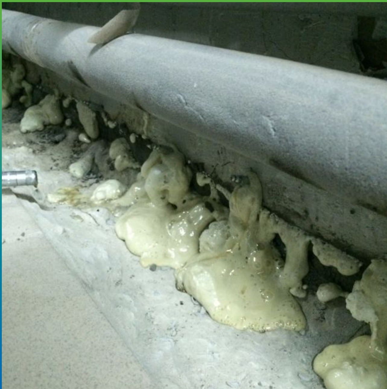
Шов бетонирования после инъектирования Манопура У
