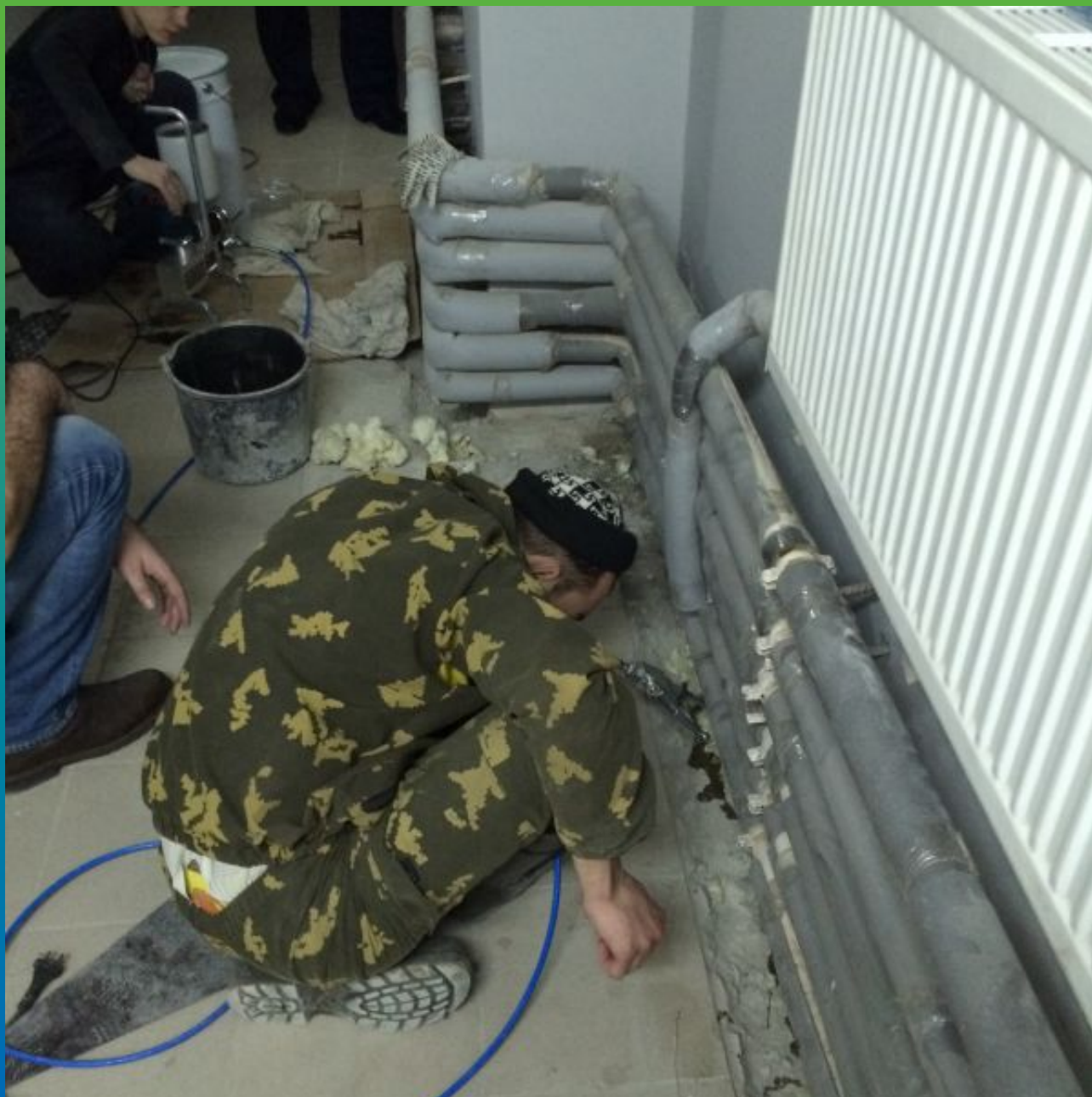
Вторая стадия инъектирования низковязкой смолы Манопур 143
