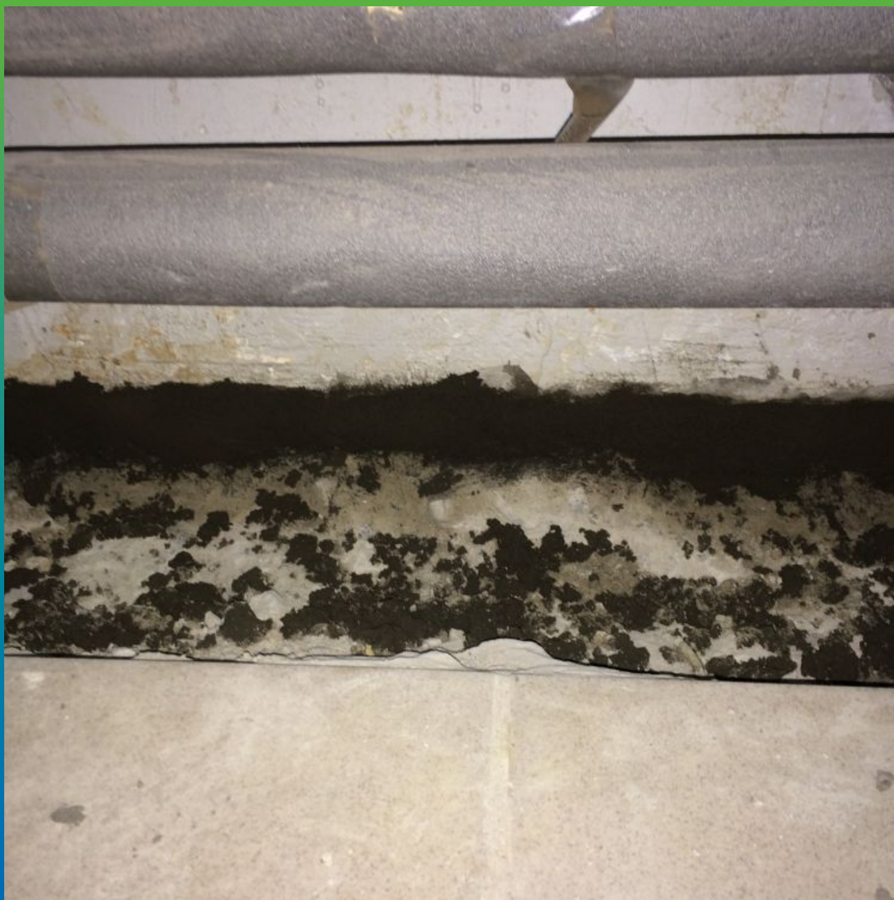
Выполненная галтель материалом Максрест
