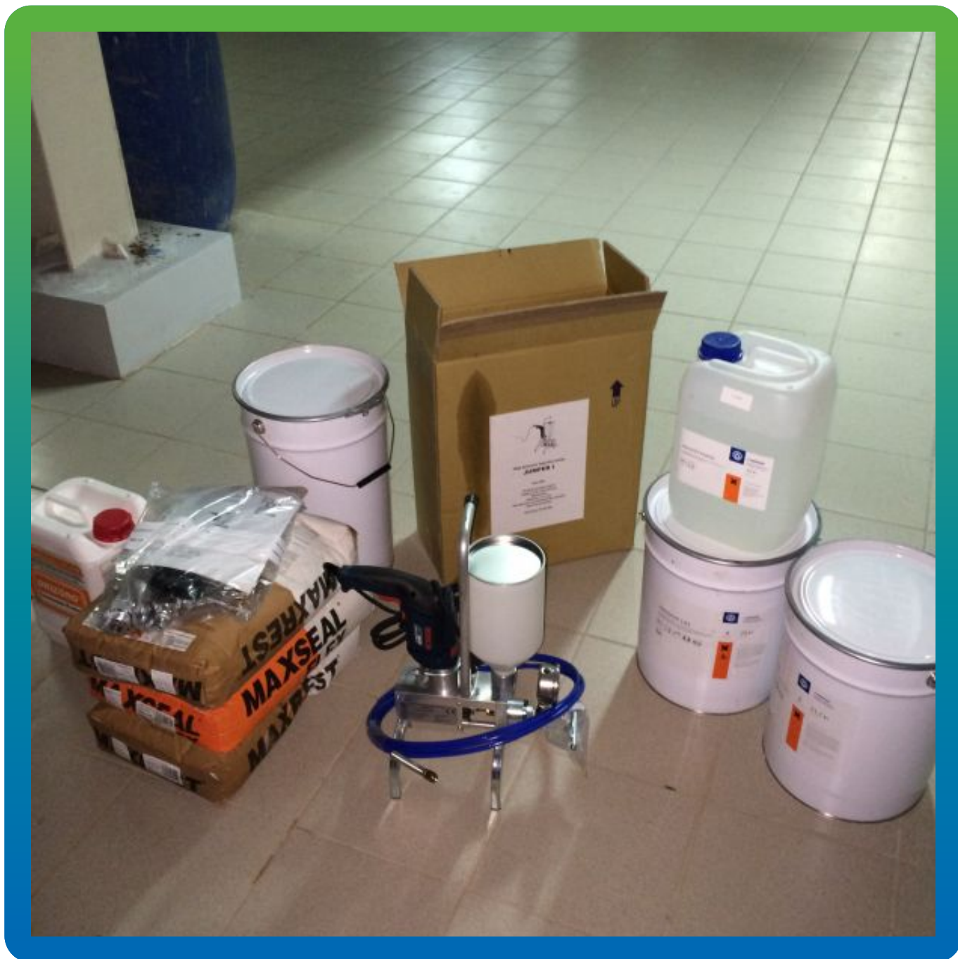
Материалы и оборудование на объекте
