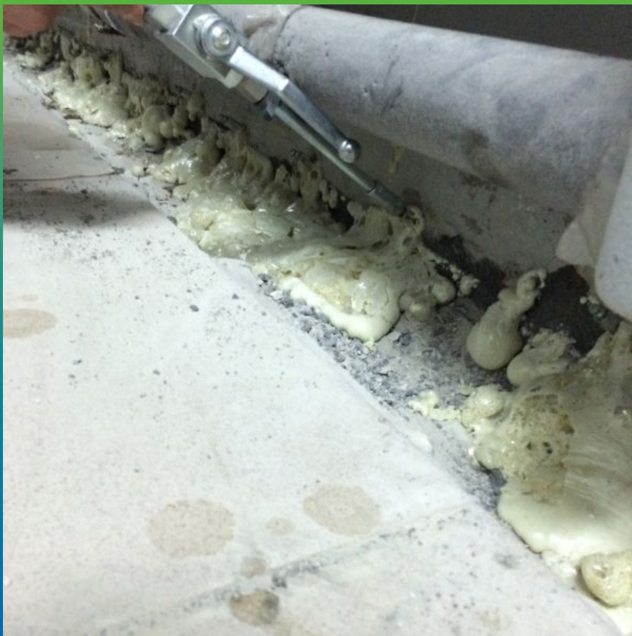
Вторая стадия инъектирования низковязкой смолы Манопур 143
