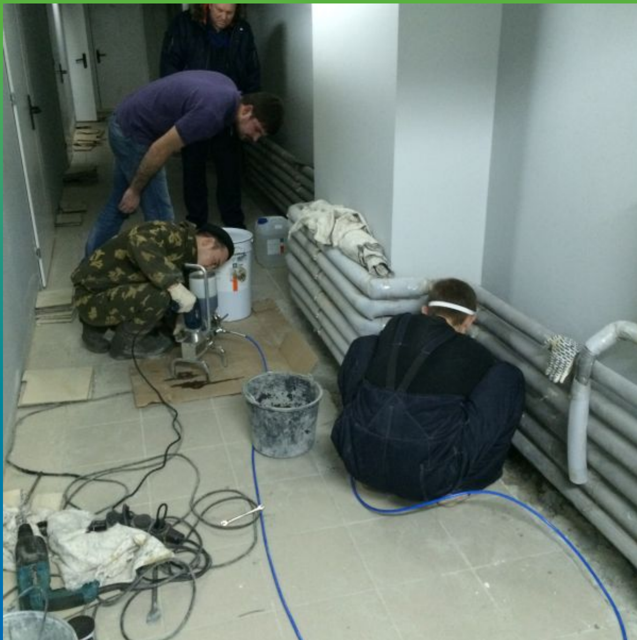
Первая стадия инъектирования полиуретановой пены Манопур У (водоподавление)
