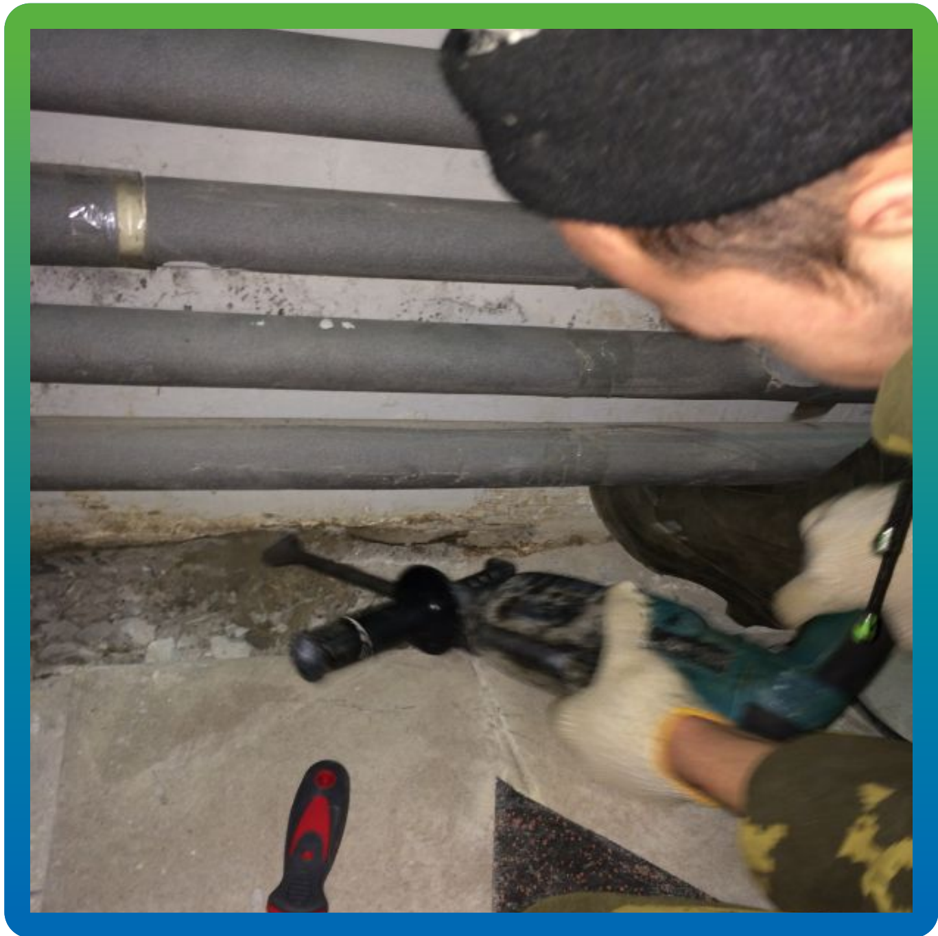
Устройство штрабы по шву
