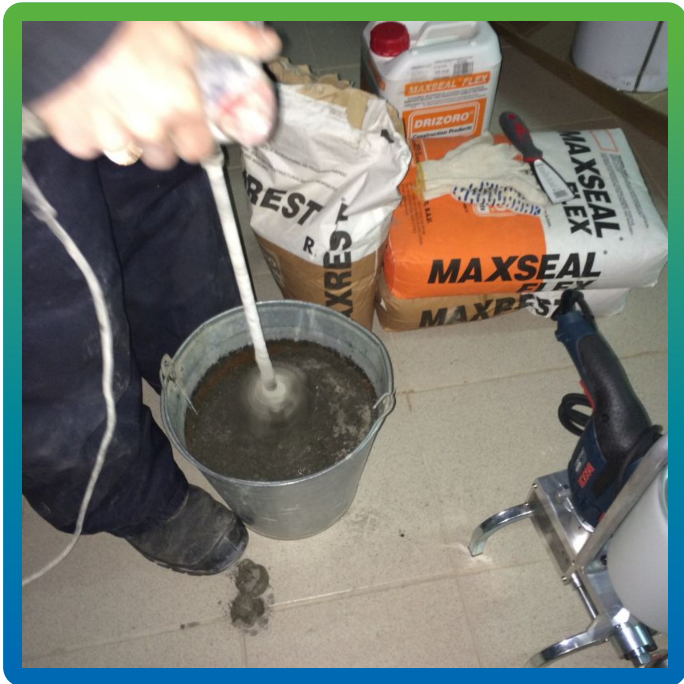
Приготовление ремонтного состава Макрест
