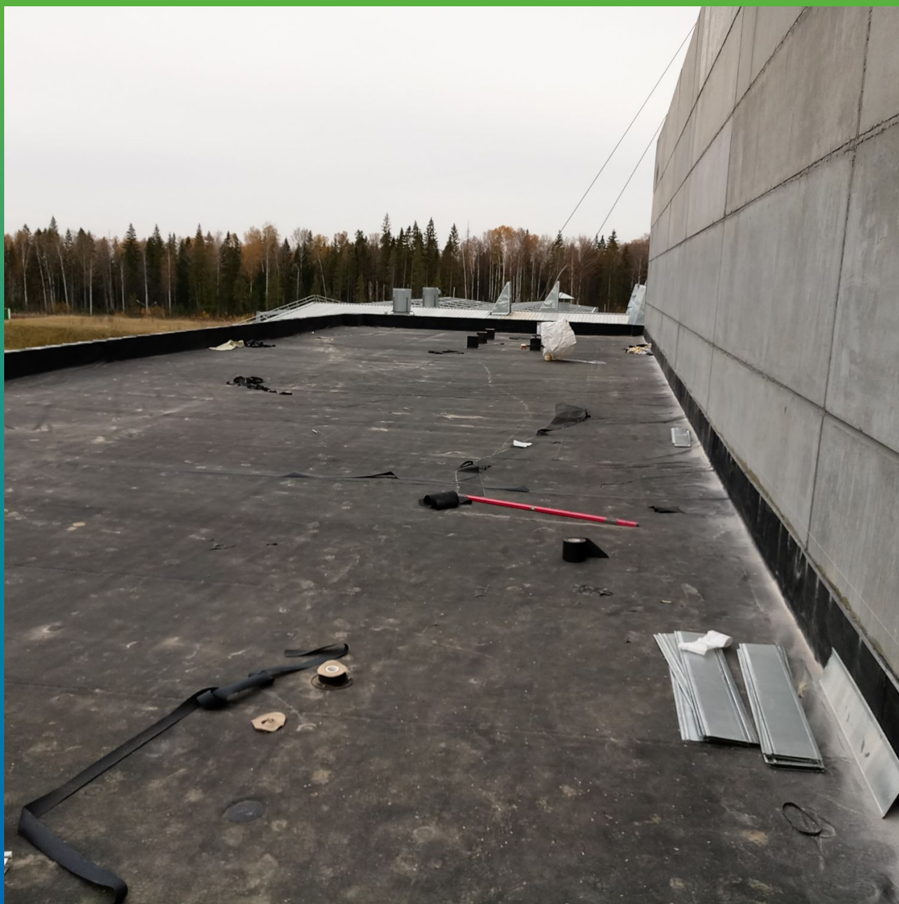
Нижний участок кровли после производства работ
