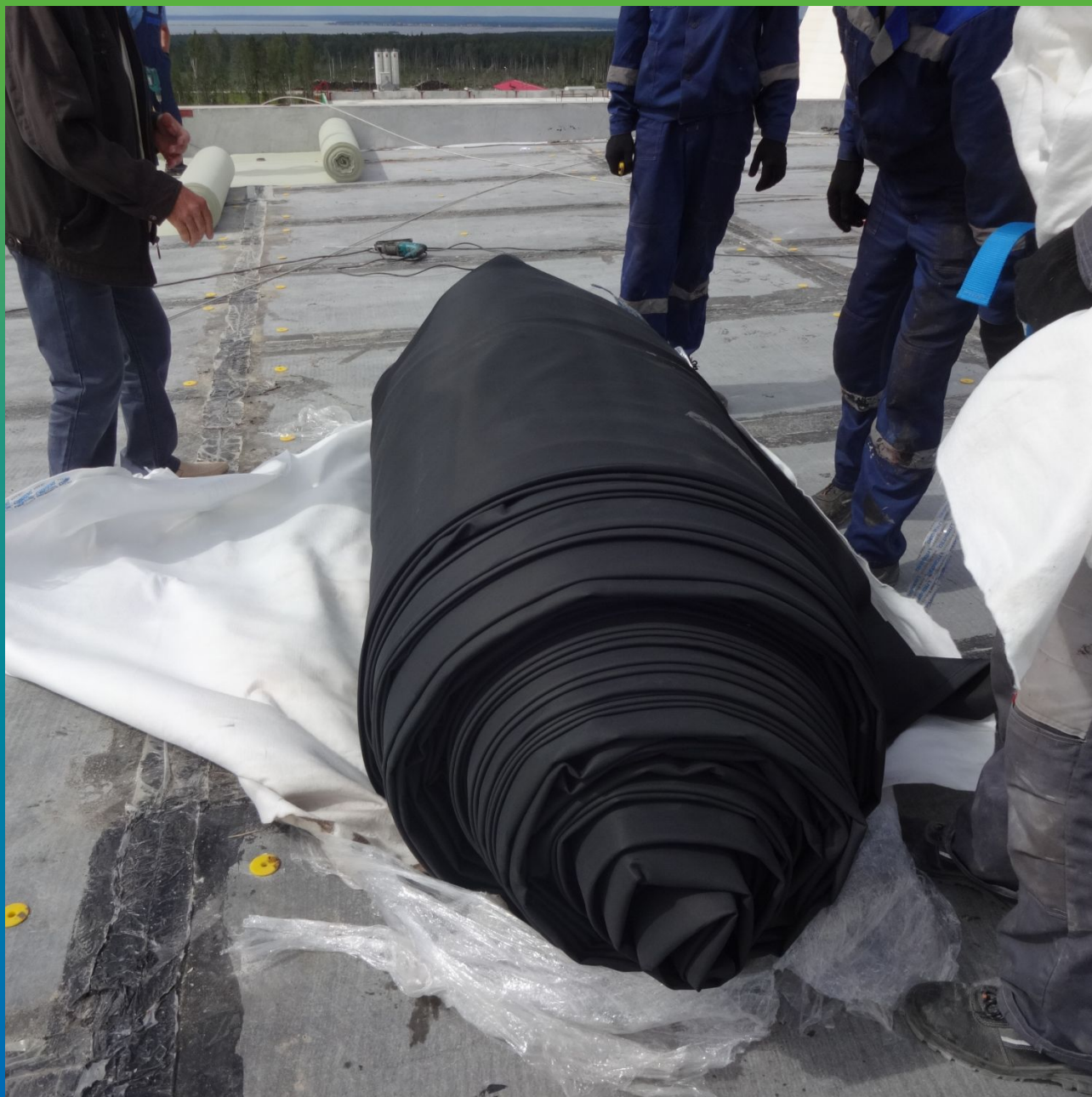
Распаковка сваренной в карты ЭПДМ-Мембраны
