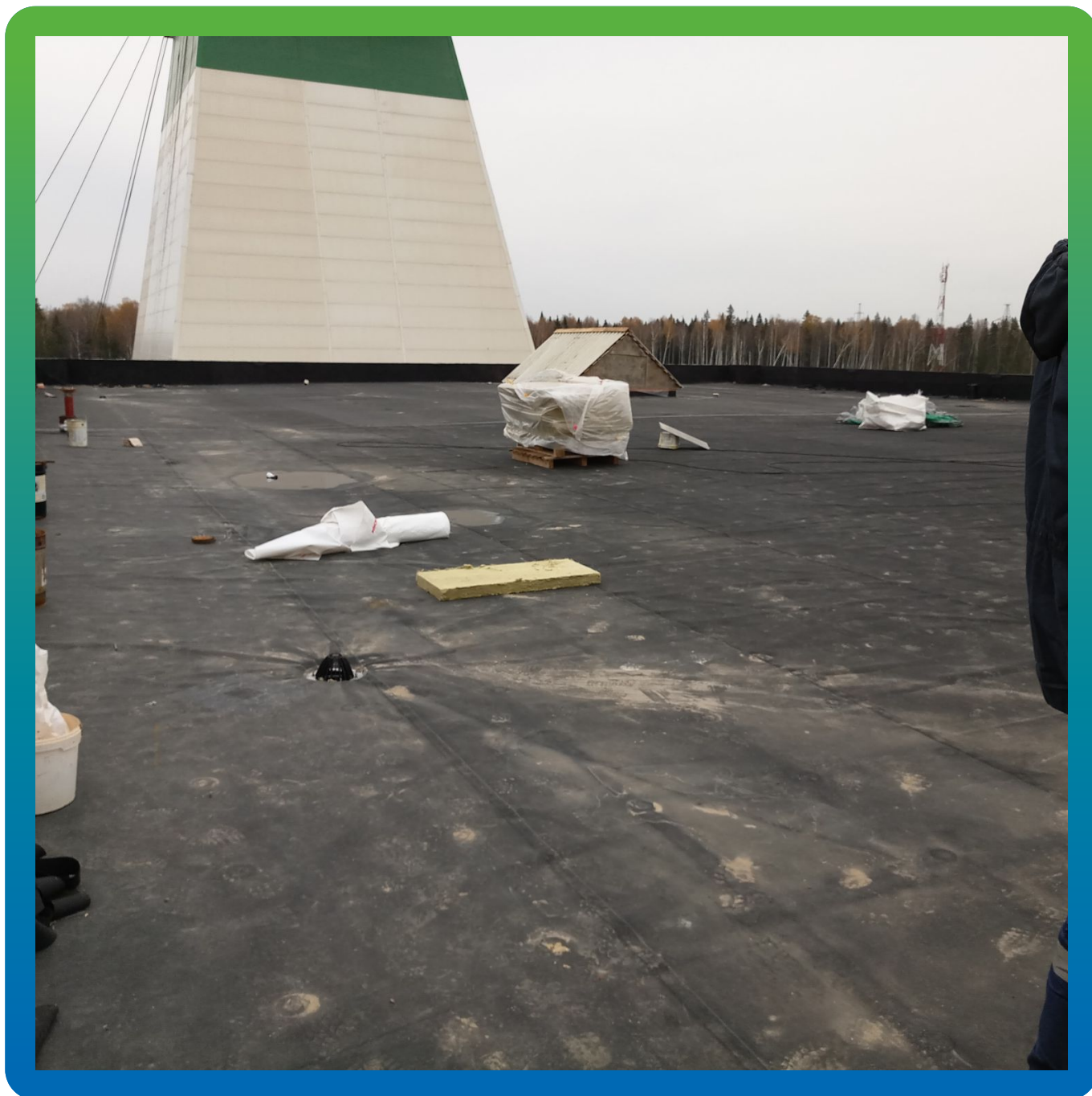
Верхний участок кровли после производства работ
