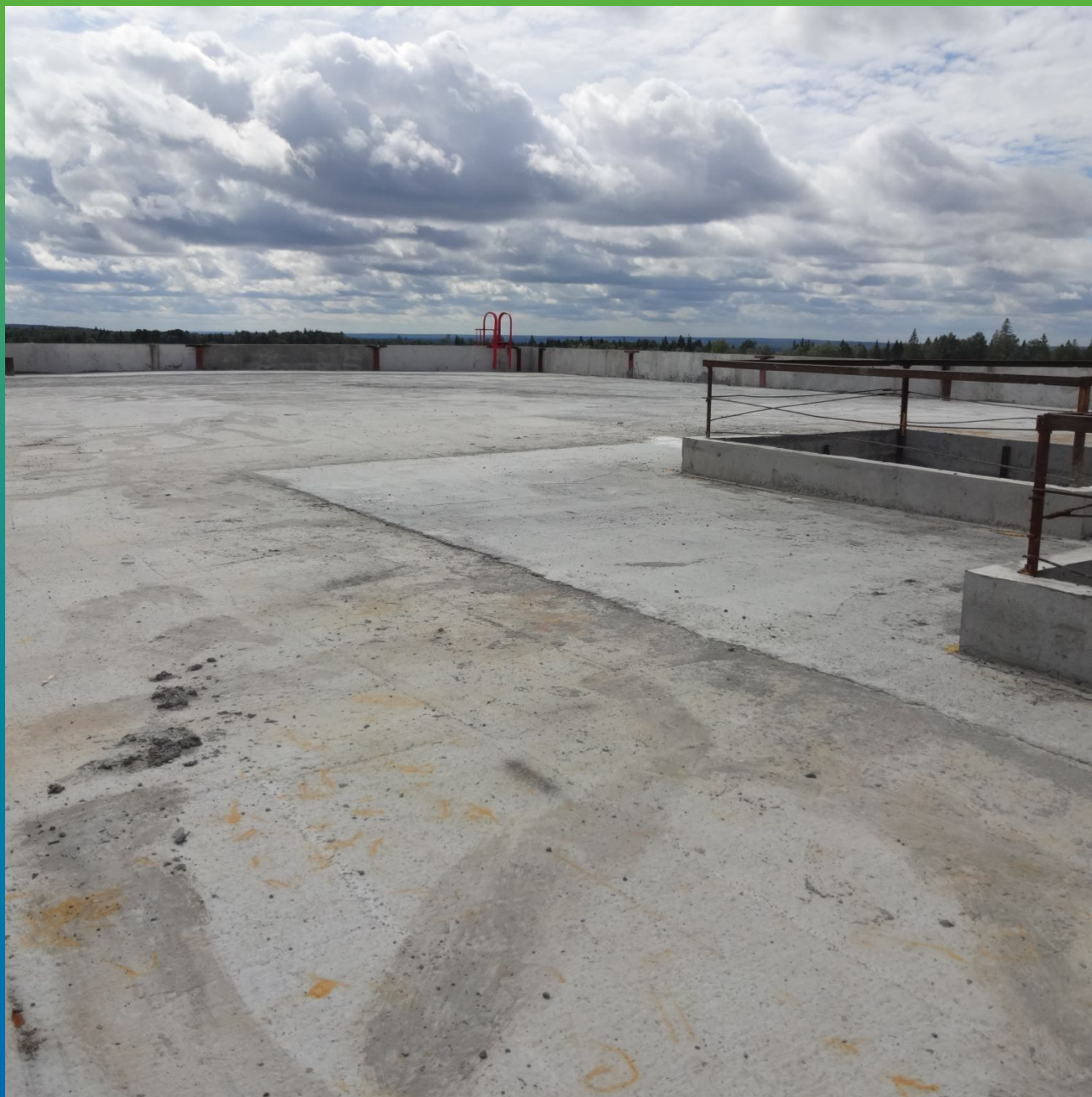
Общий вид объекта кровли верхней части
