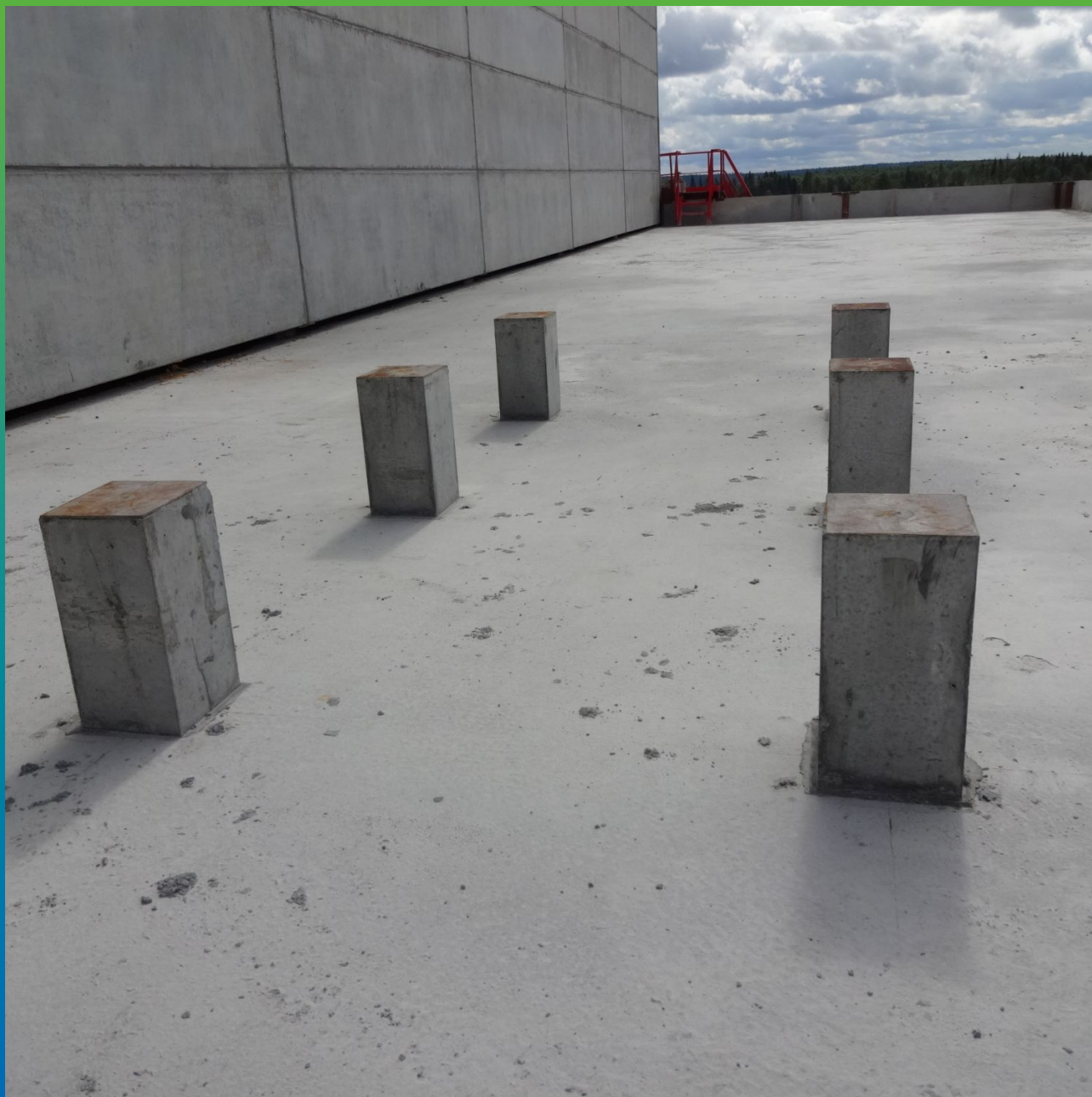
Общий вид объекта кровли нижней части
