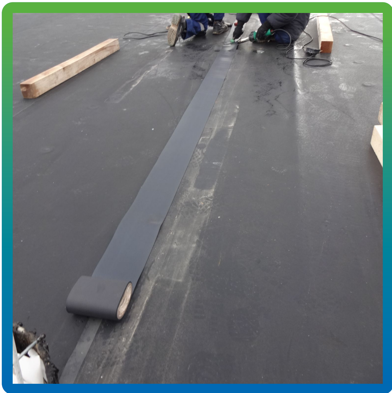
Стыковка карт между собой горячим воздухом через систему Термобонд
