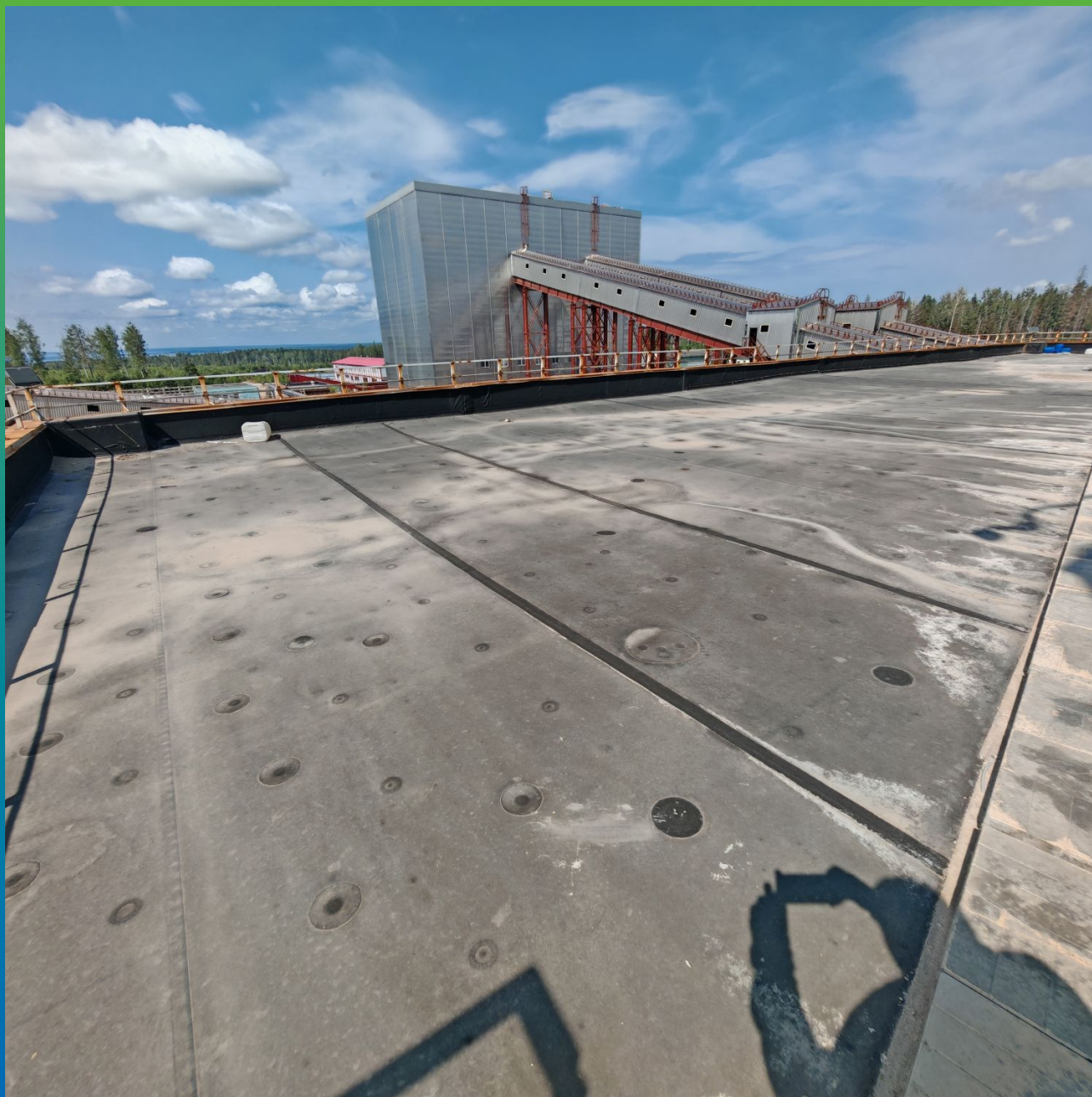
Состояние кровли через 7 лет
