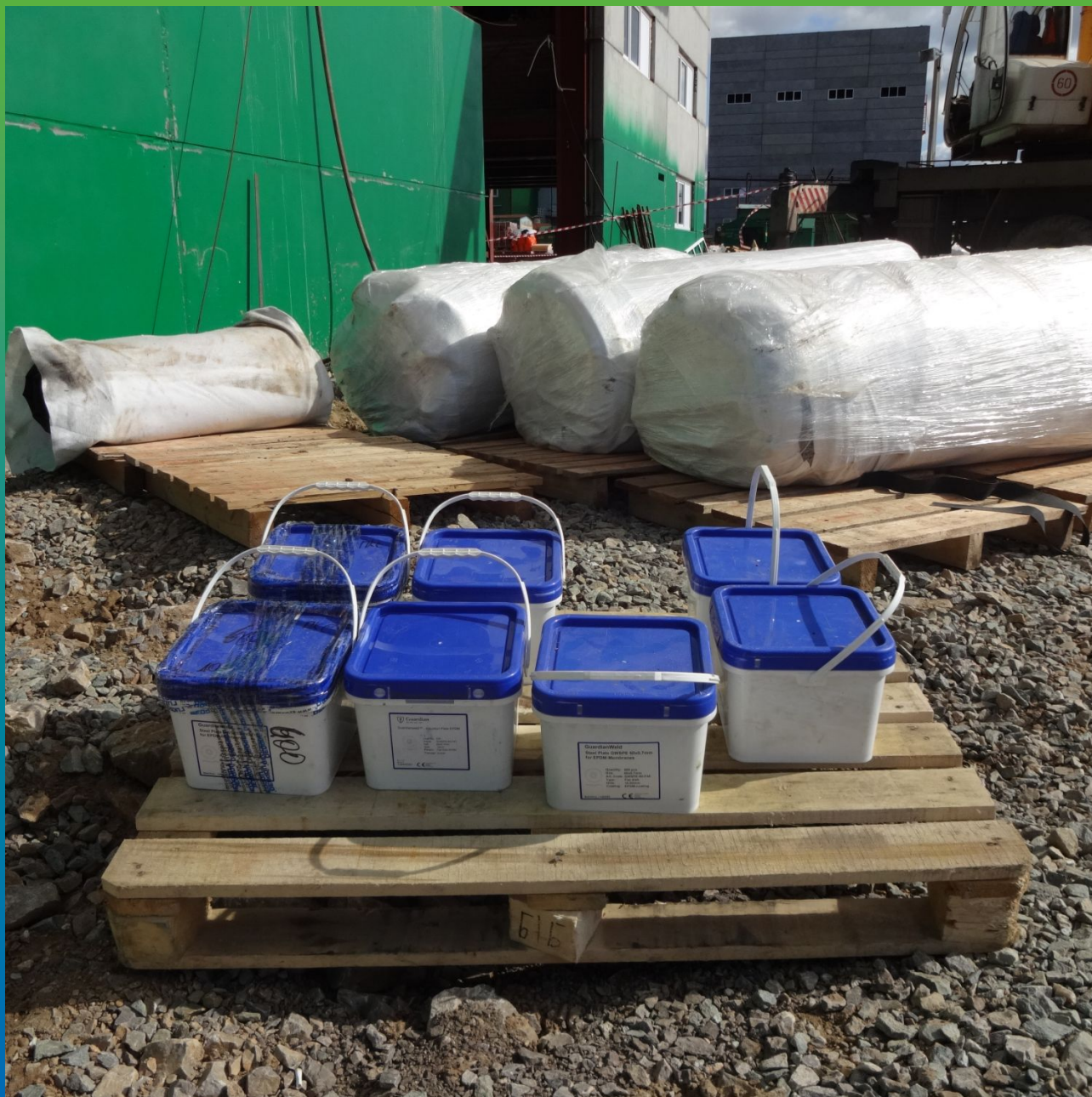
Материалы для монтажа кровли перед подъемкой на объект
