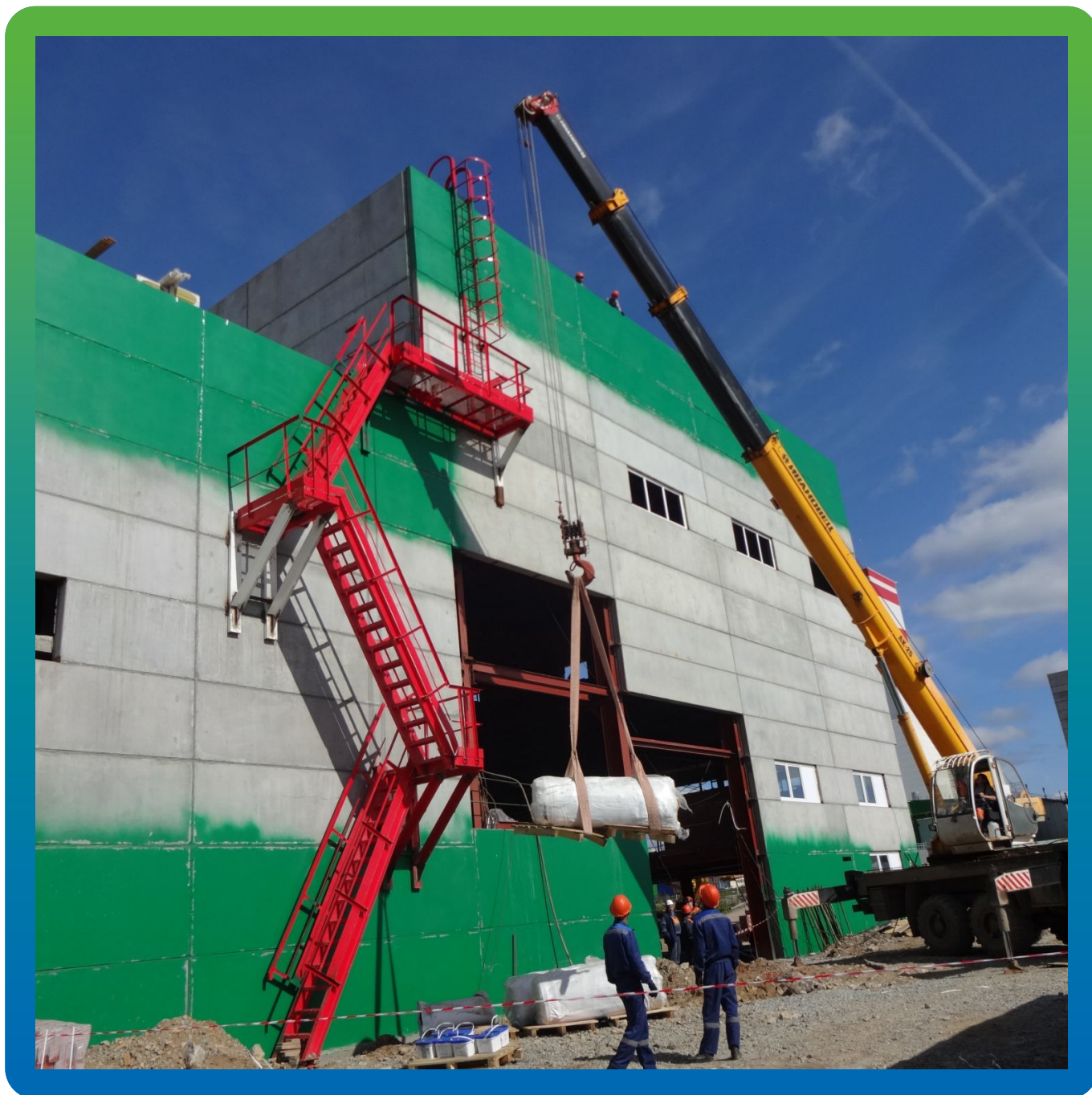
Подъем материалов на кровлю
