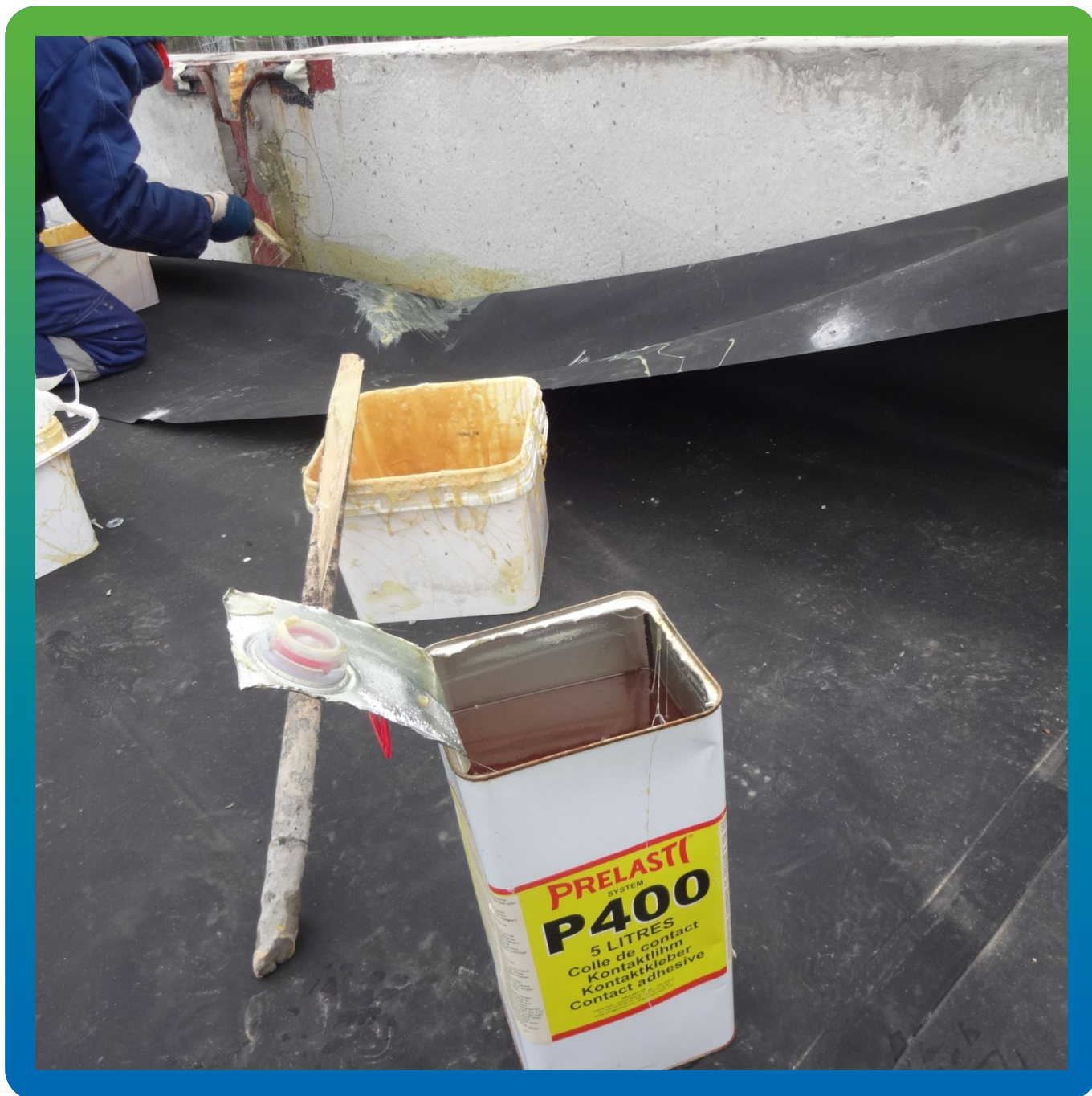
Монтаж мембраны к парапетам на клей П400
