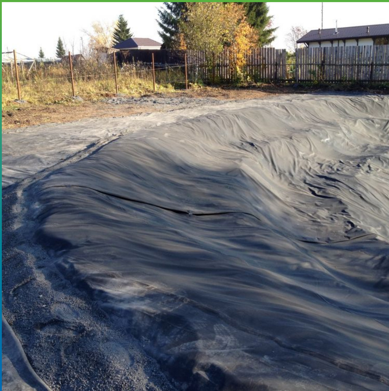
Вид крепления мембраны к откосу водоема
