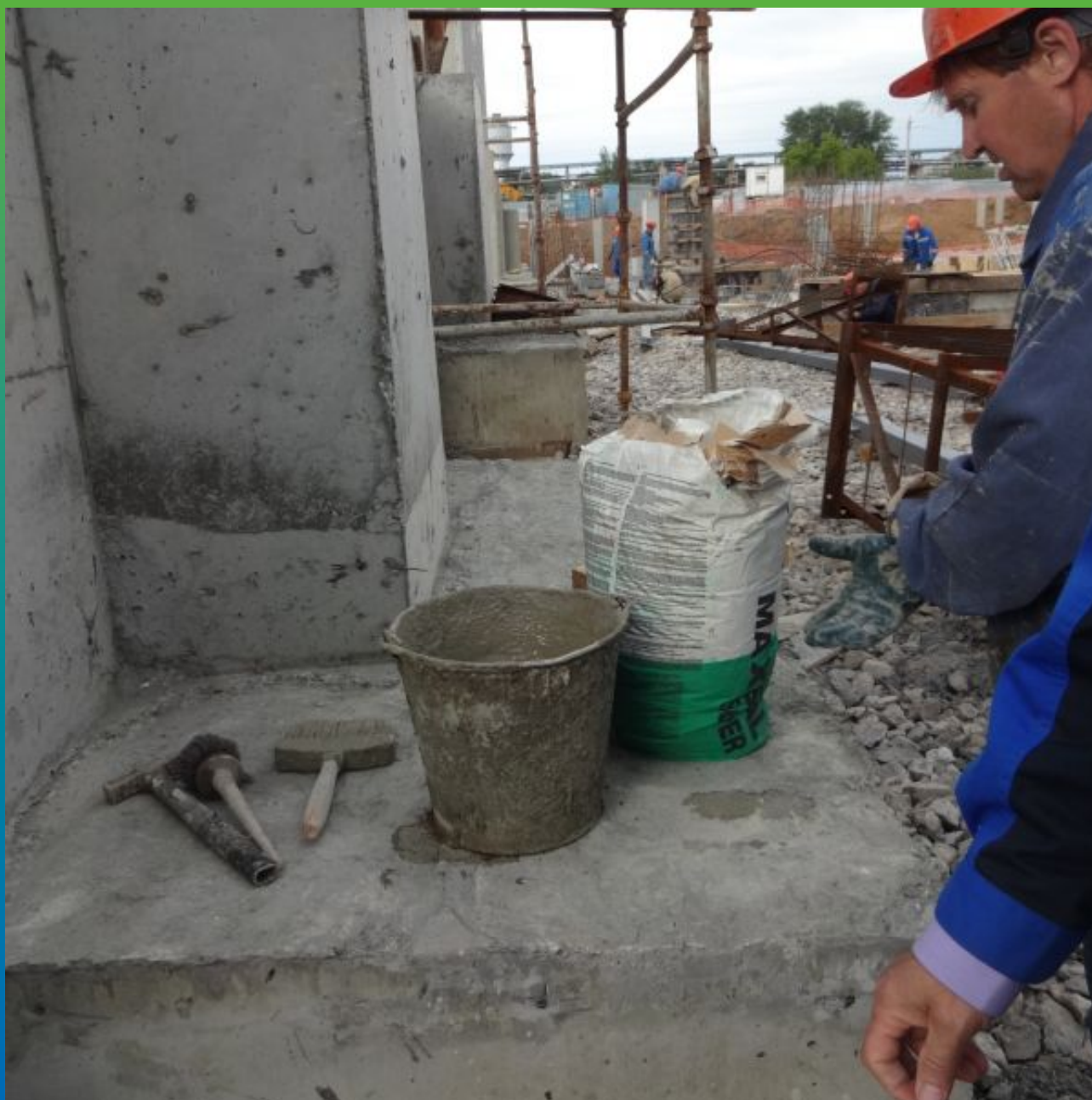
Подготовка гидроизолируемой поверхности ростверка перед нанесением Максил Супер
