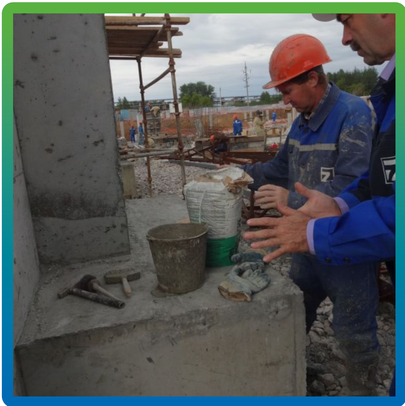
Вводный инструктаж перед нанесением Максил Супер методом обмазки
