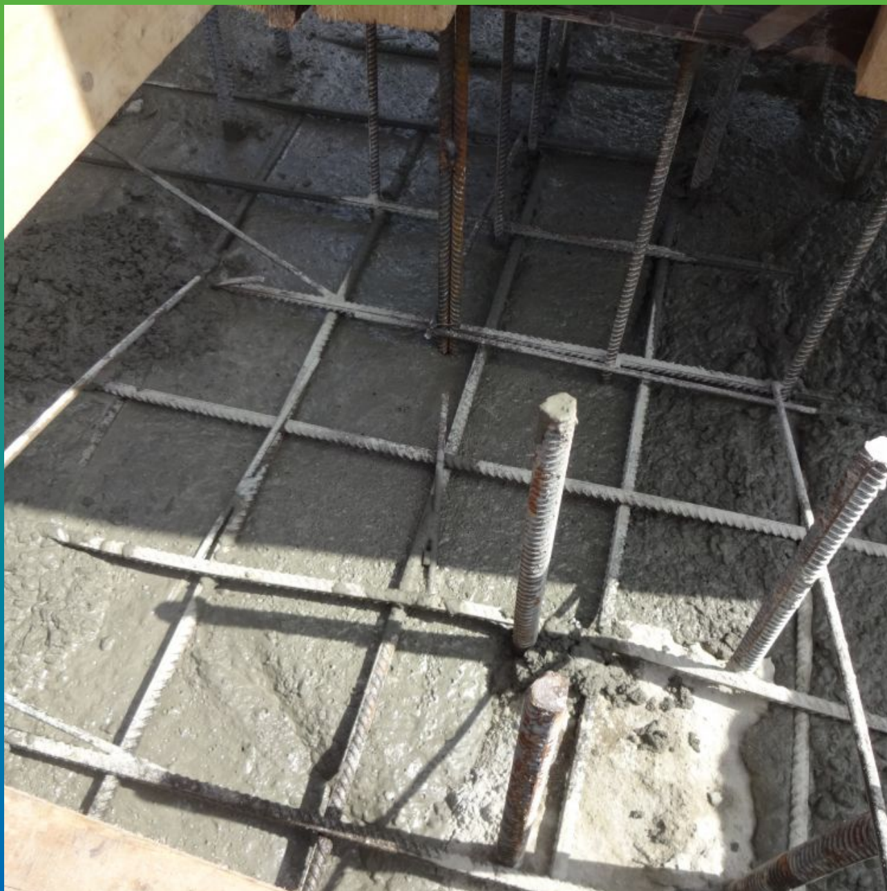
Заливка ростверка
