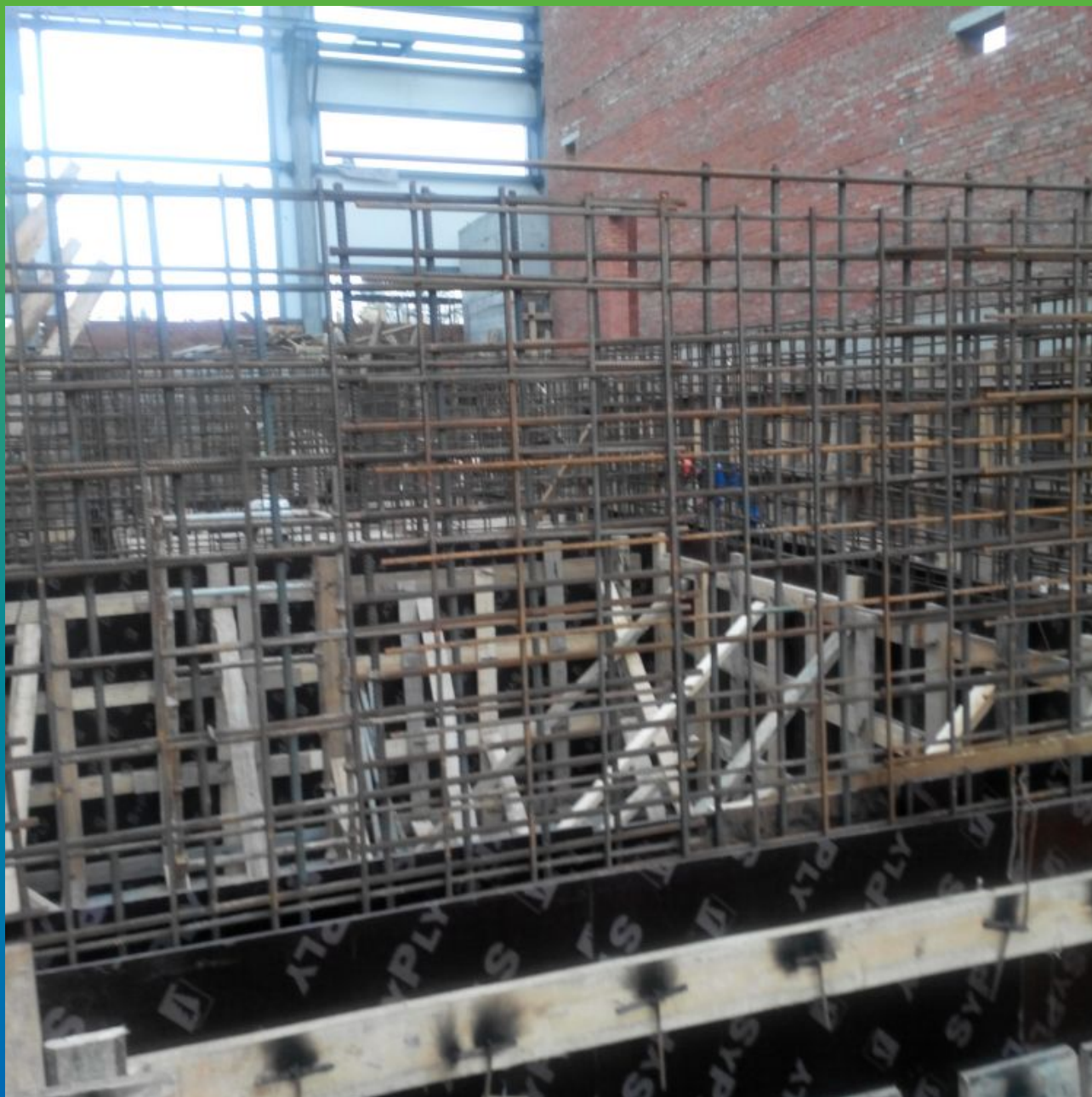
Установка арматурного каркаса плиты основания пола и гидроизоляция методом просыпки Макссил Супер
