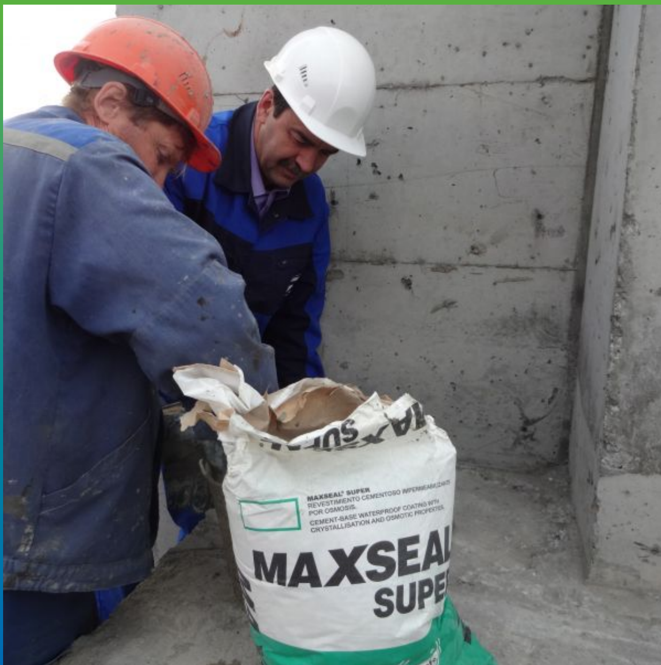
Приготовление смеси Макссил Супер с водой
