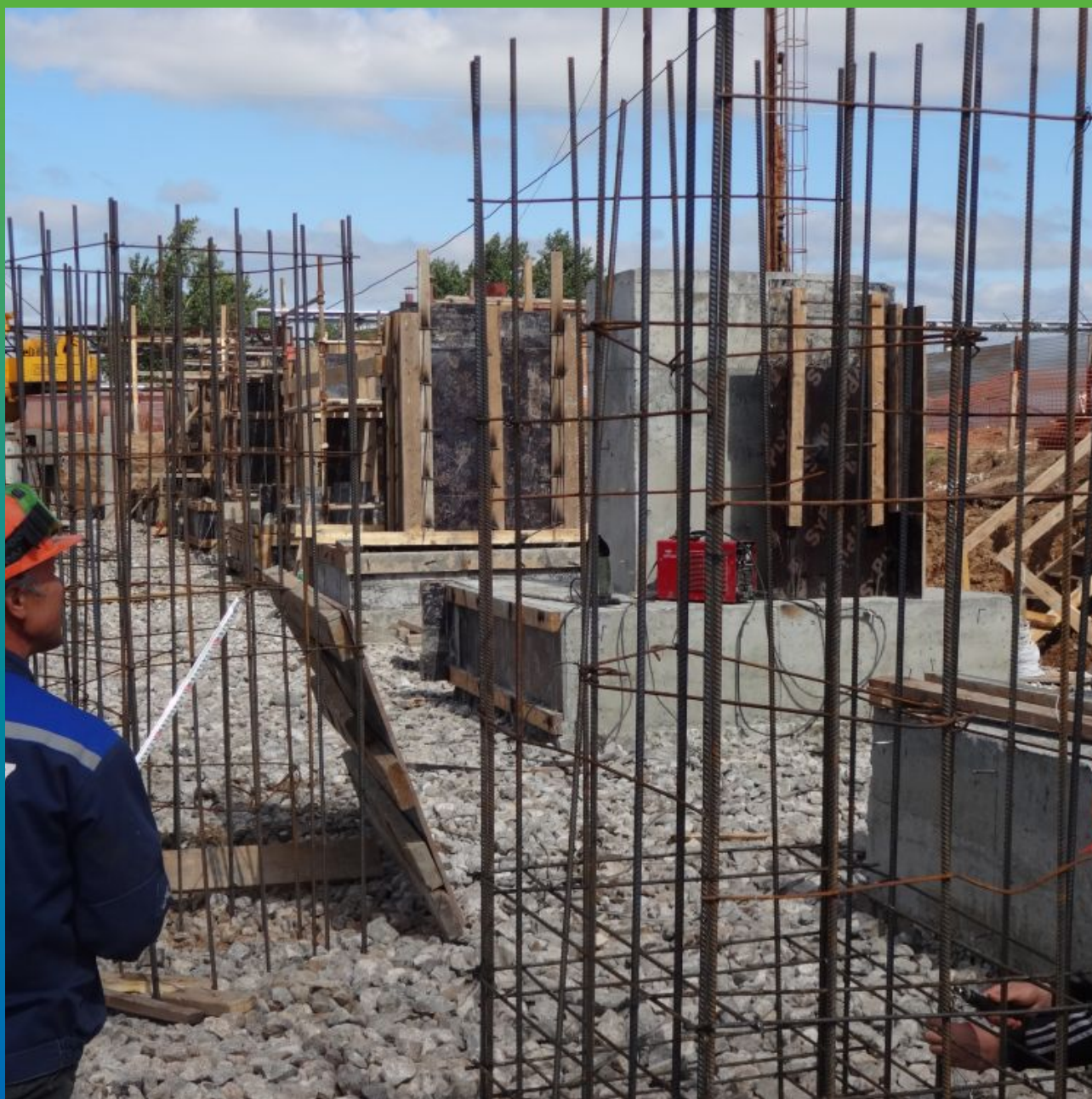
Вязка арматурного каркаса
