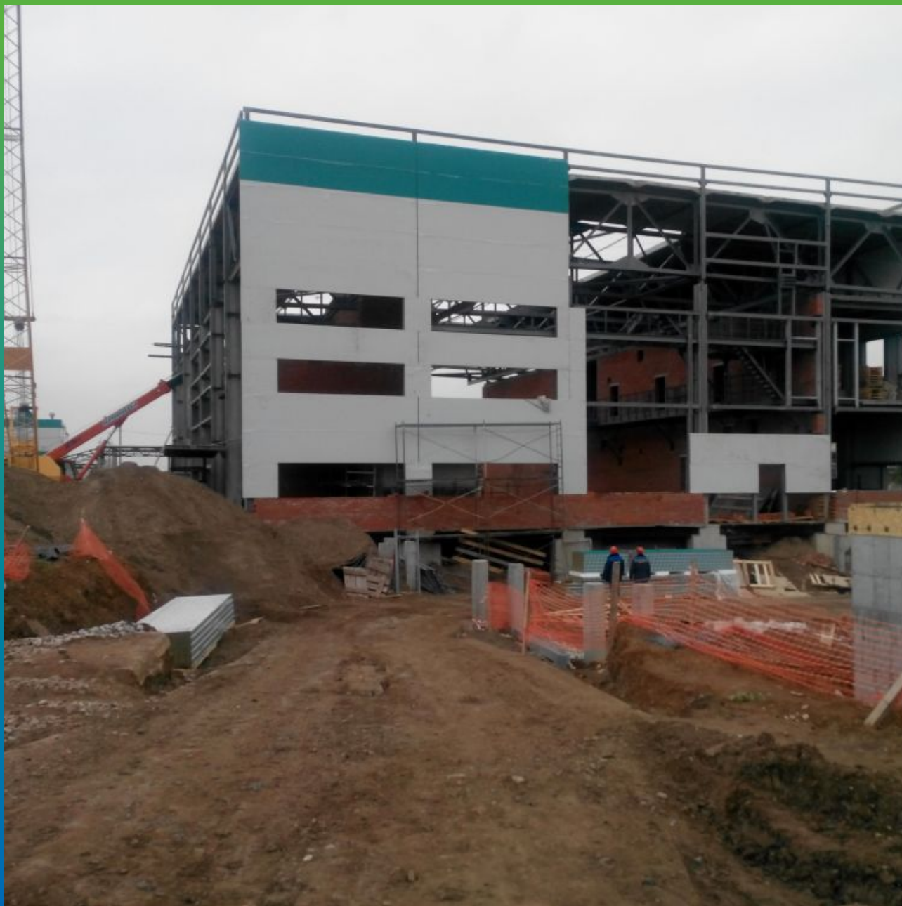
Гидроизоляция плиты основания производственного корпуса методом просыпки Максил Супер
