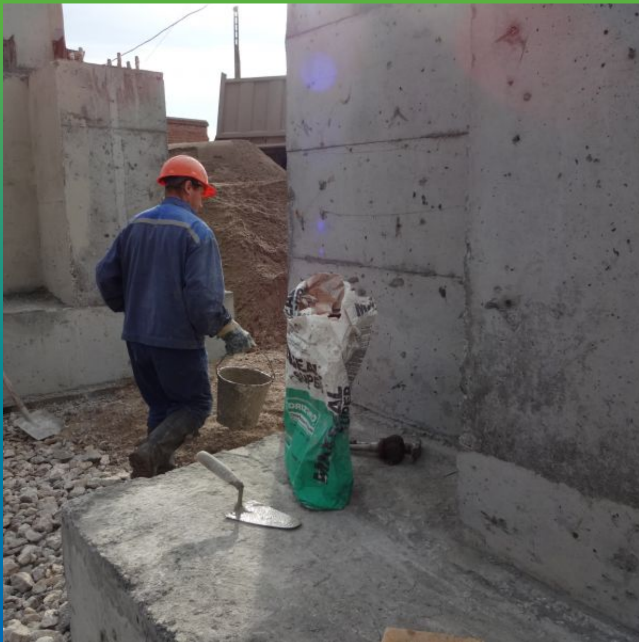
Нанесение гидроизолирующего состава Максил Супер на поверхность ростверка методом обмазки
