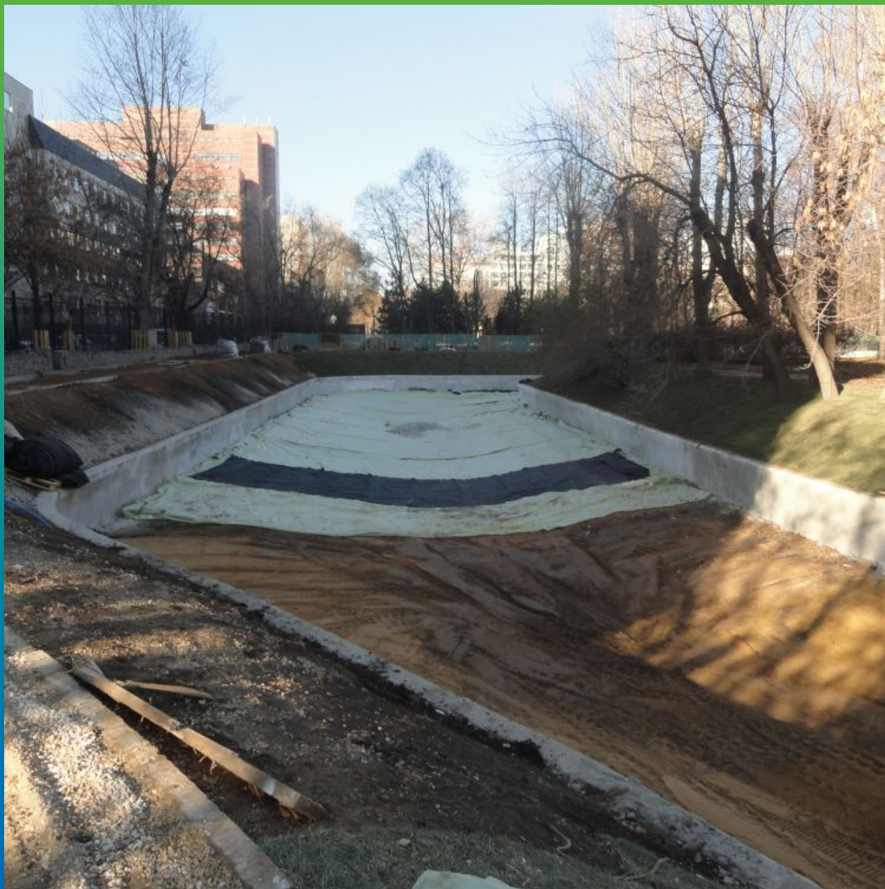
Укладка мембраны Эластосил Т через геотекстиль
