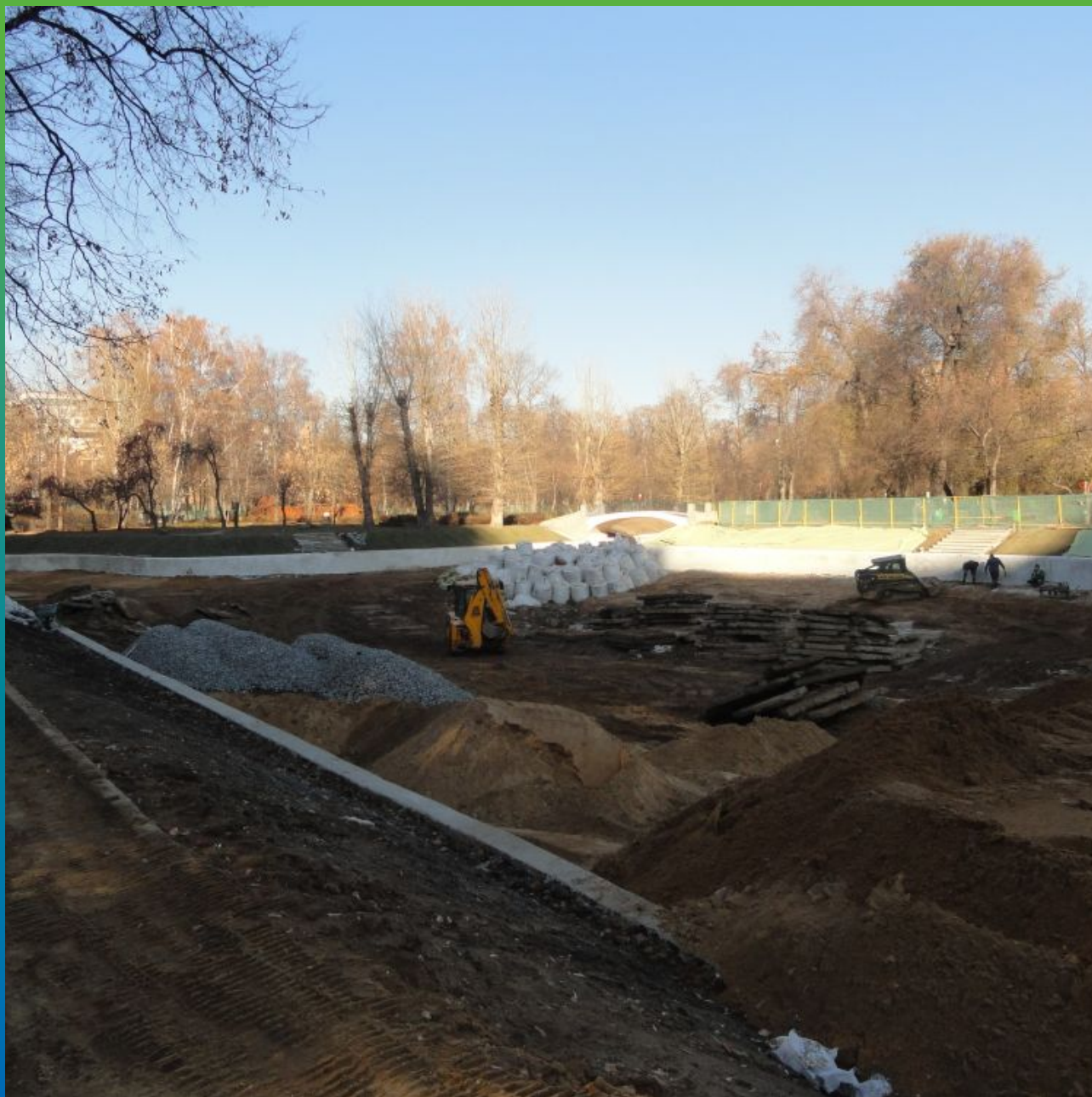
Демонтаж старого основания водоема
