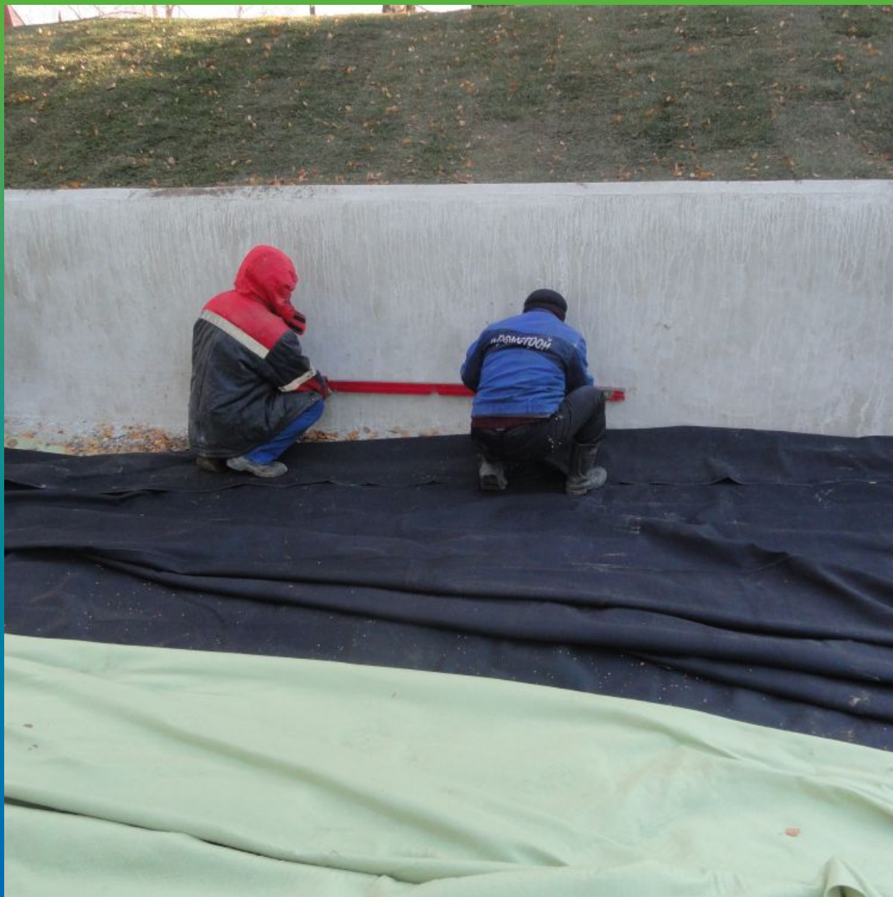
Монтаж примыканий
