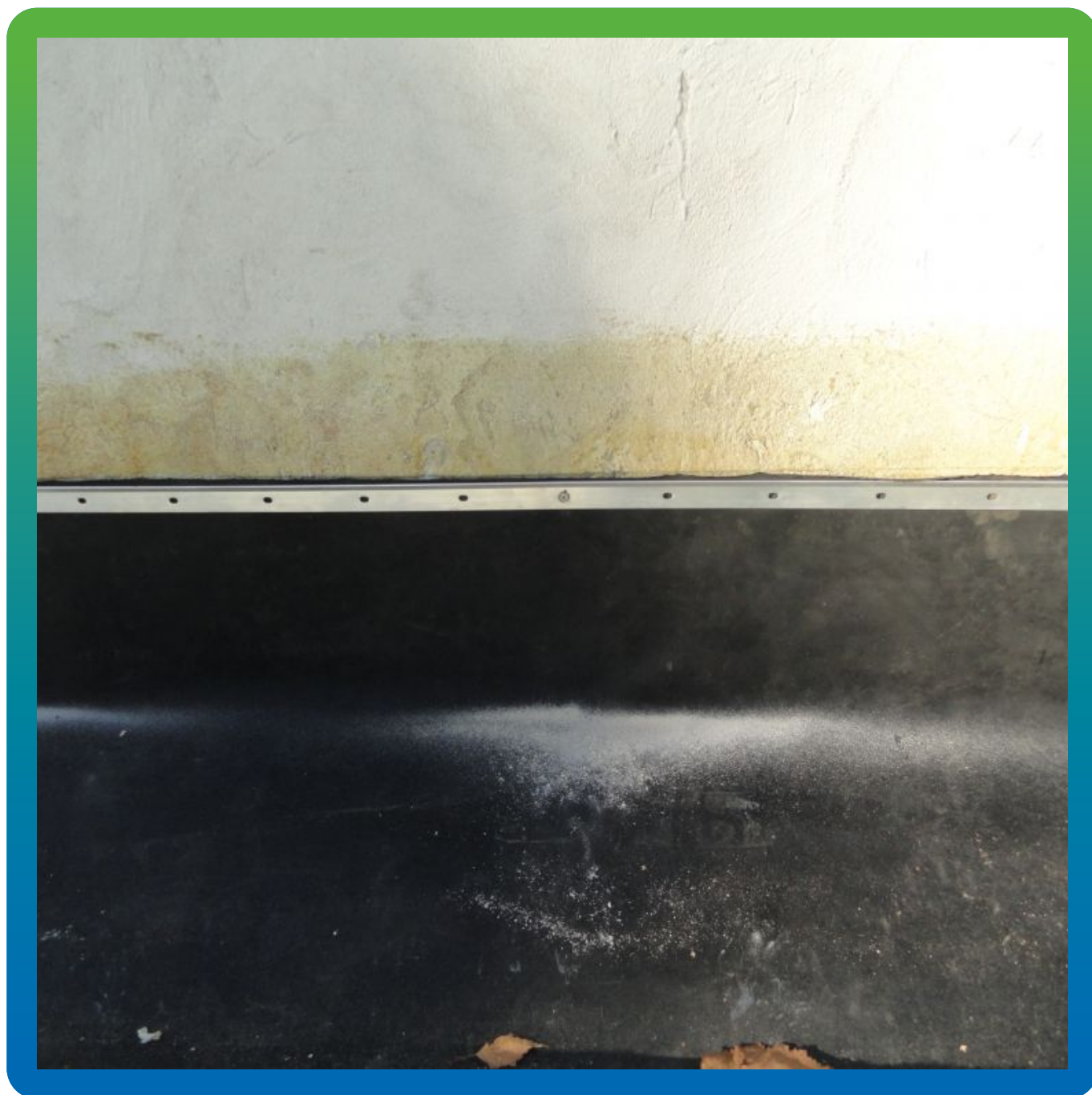
Монтаж примыканий
