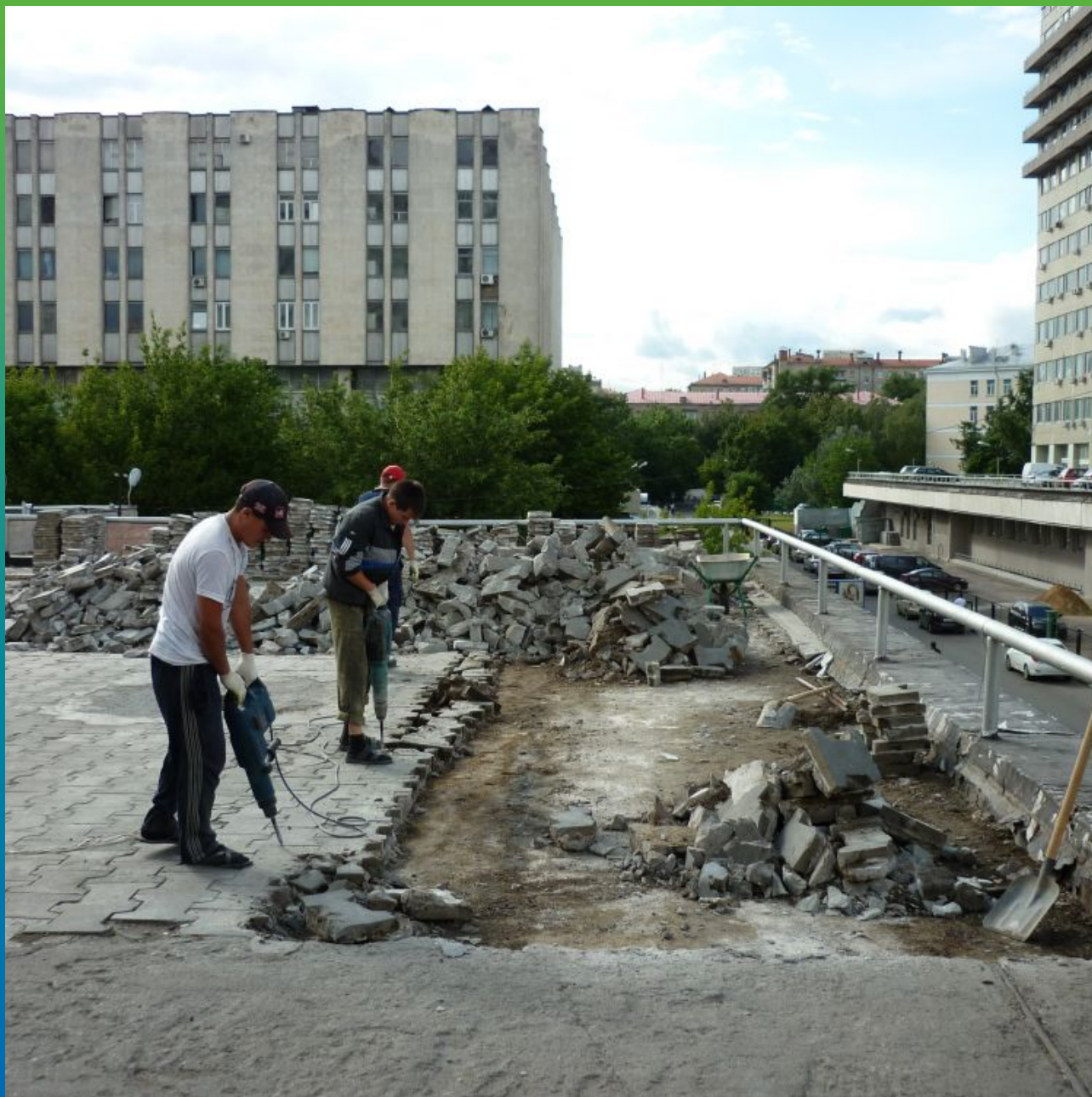
Демонтаж существующего покрытия
