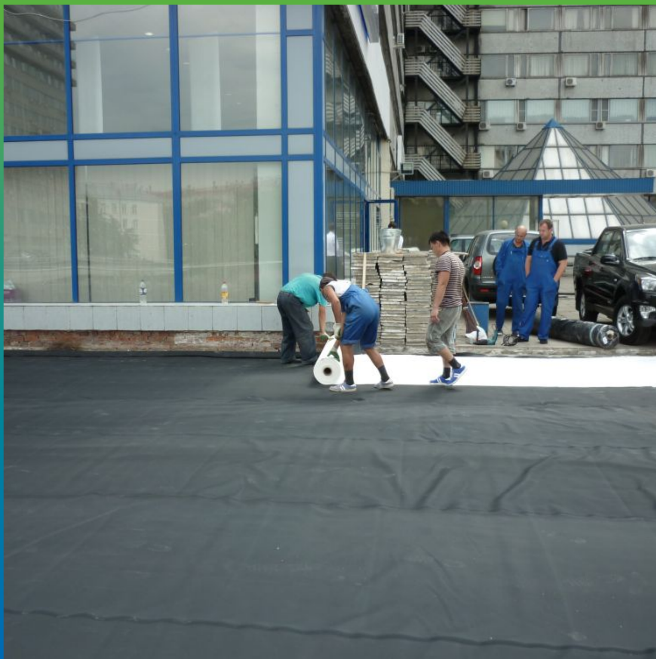
Укладка защитного слоя из геотекстиля 350 гр/кв.м поверх мембраны
