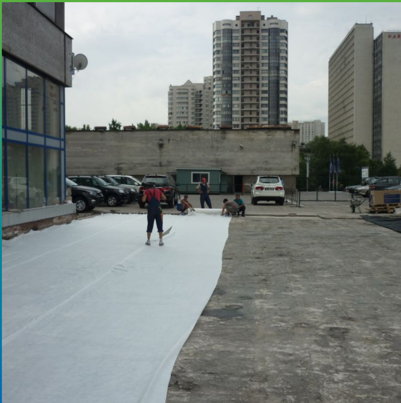
Укладка защитного слоя из геотекстиля 350 гр/кв.м под мембрану
