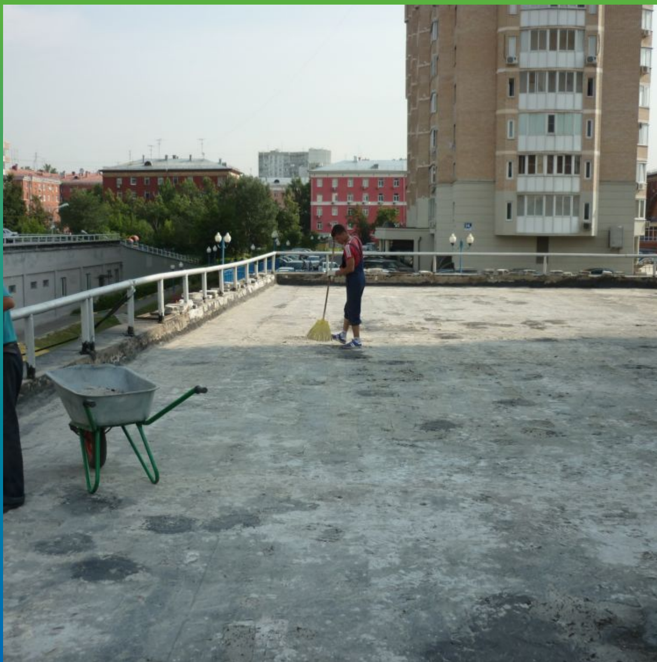
Подготовка основания перед укладкой гидроизоляционного полотна из ЭПДМ мембраны Эластосил Т 1,2 мм
