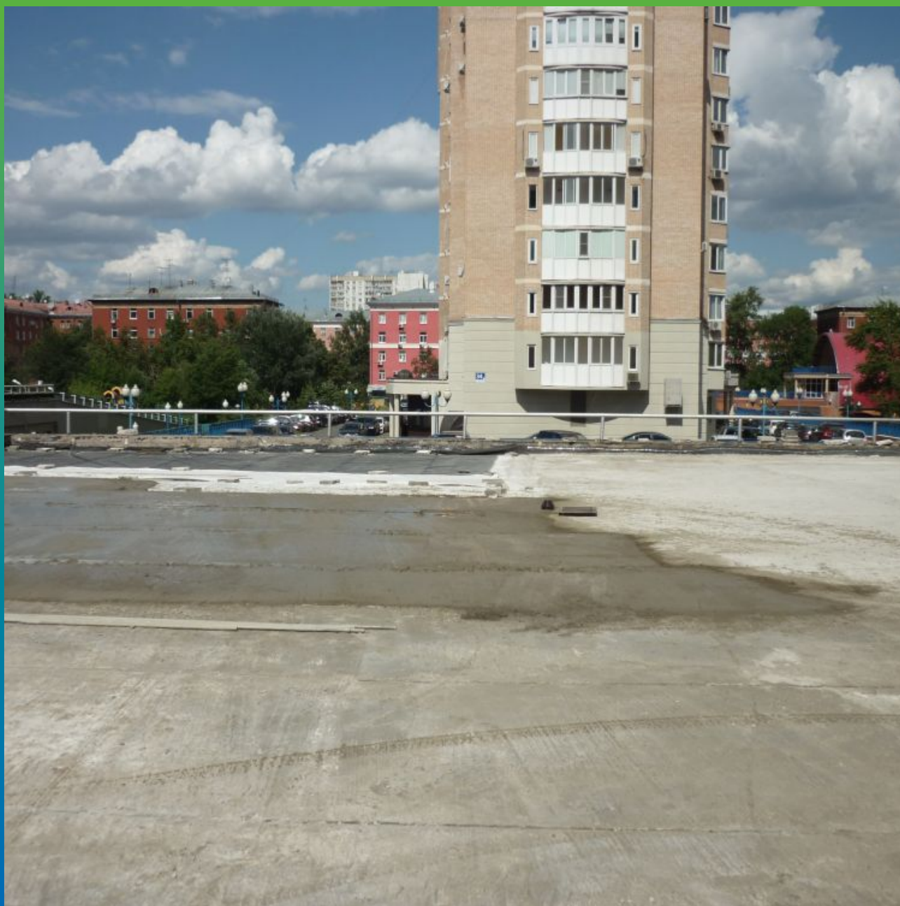
Устройство стяжки с разуклоном в сторону воронок
