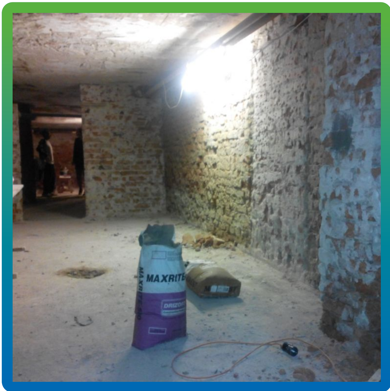
Грунтовка и ремонт сложных участков Максрайт 500
