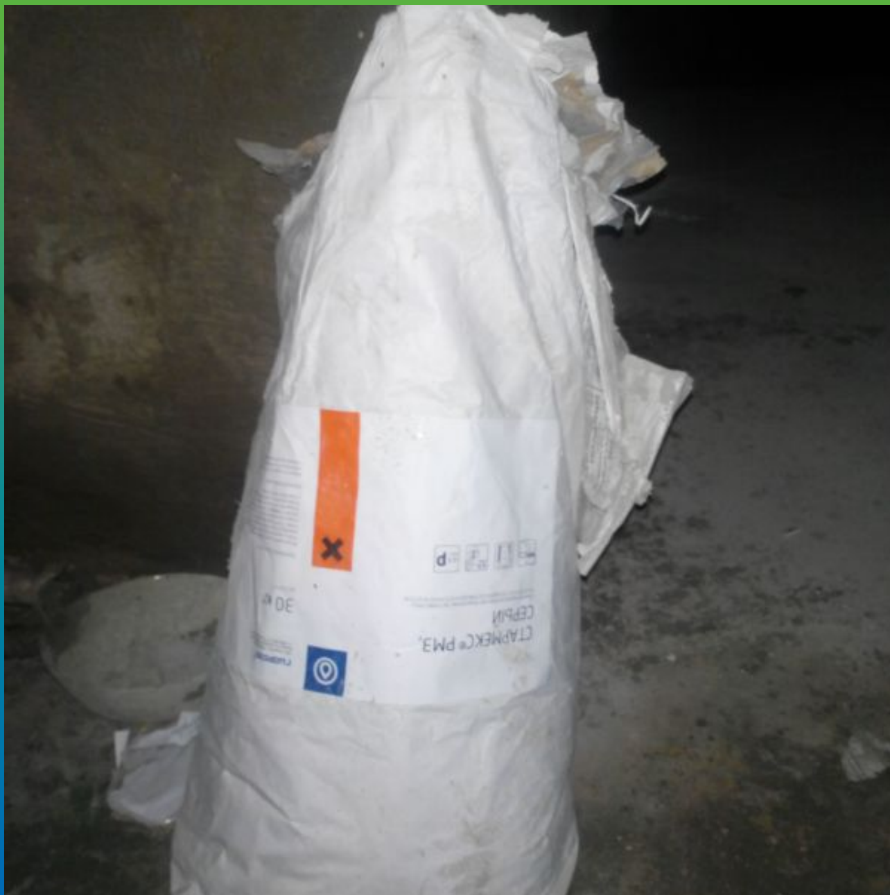
Восстановление геометрии ремонтным-штукатурным составом Стармекс РМ 3
