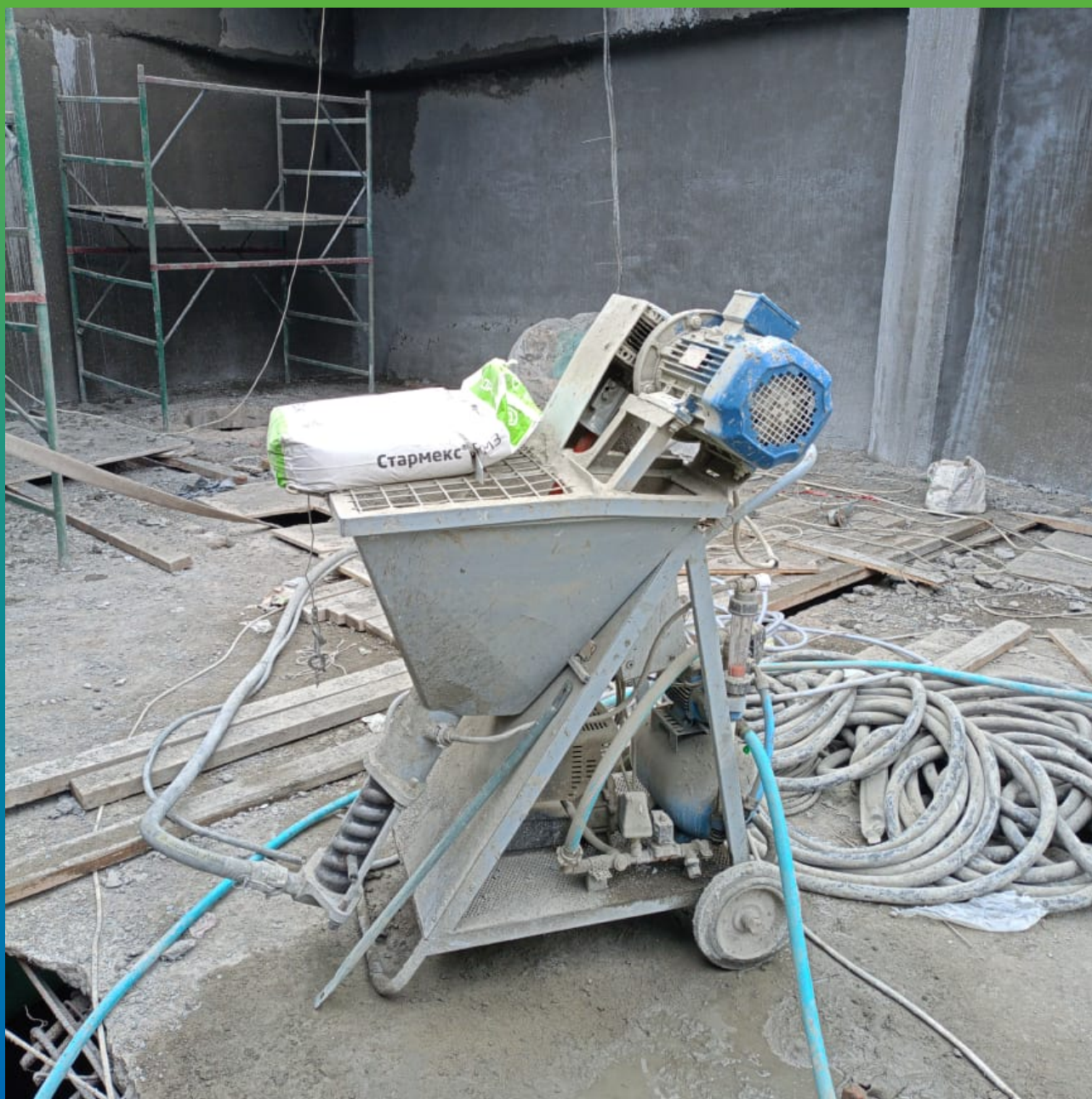
Механический способ нанесения состава Стармекс РМЗ
