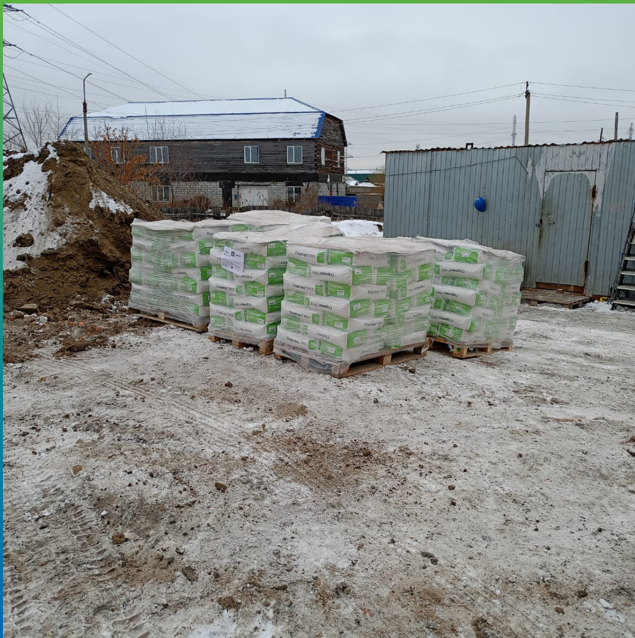
Ремонтный состав Стармекс РМЗ на объекте
