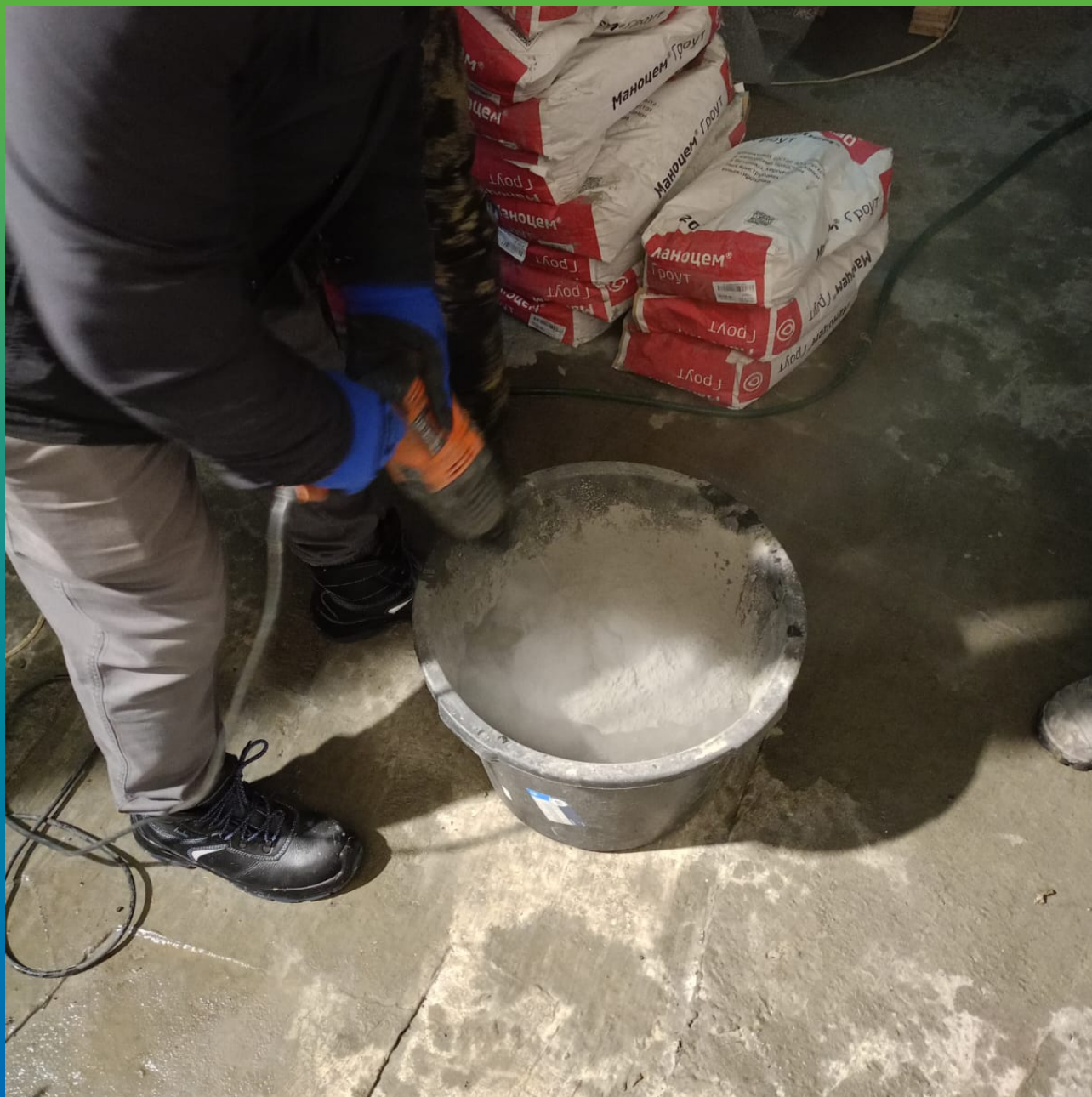
Процесс затворения состава Манцем Гроут
