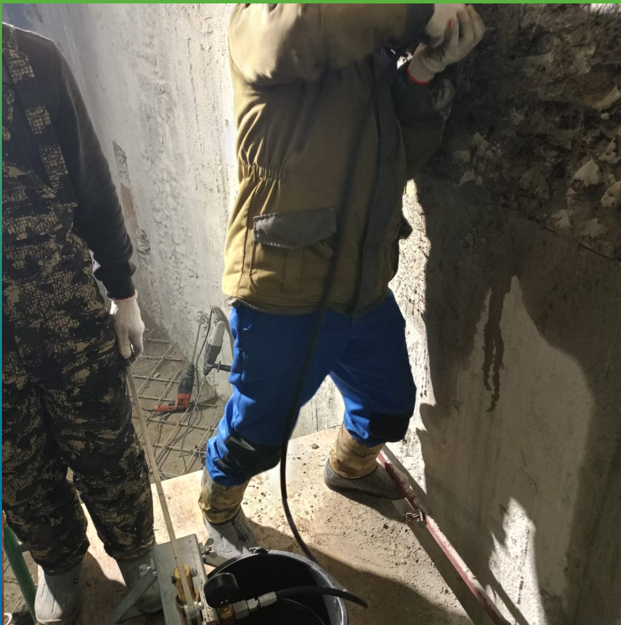
Процесс инъектирования материалом Манопур 144
