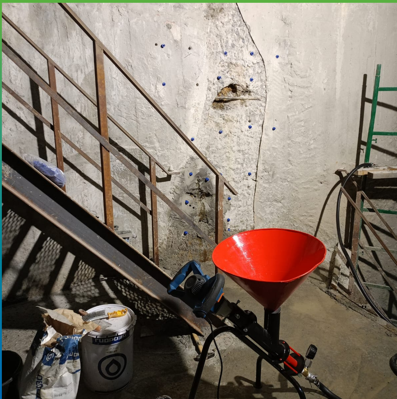
Процесс инъецирования пустот в теле бетона составом Маноцем Грут
