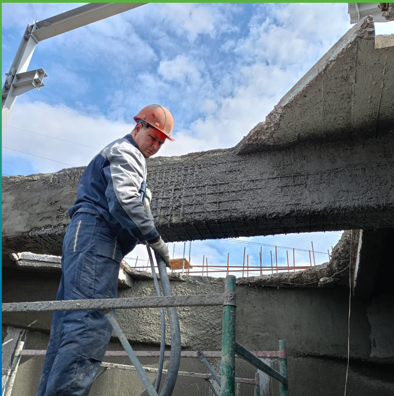
Процесс нанесения состава Стармекс РМЗ
