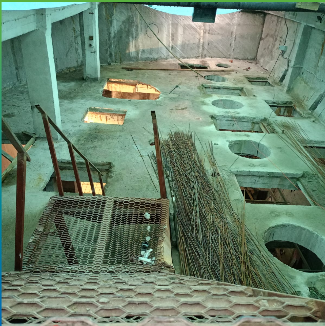
Объект до начала реконструкции
