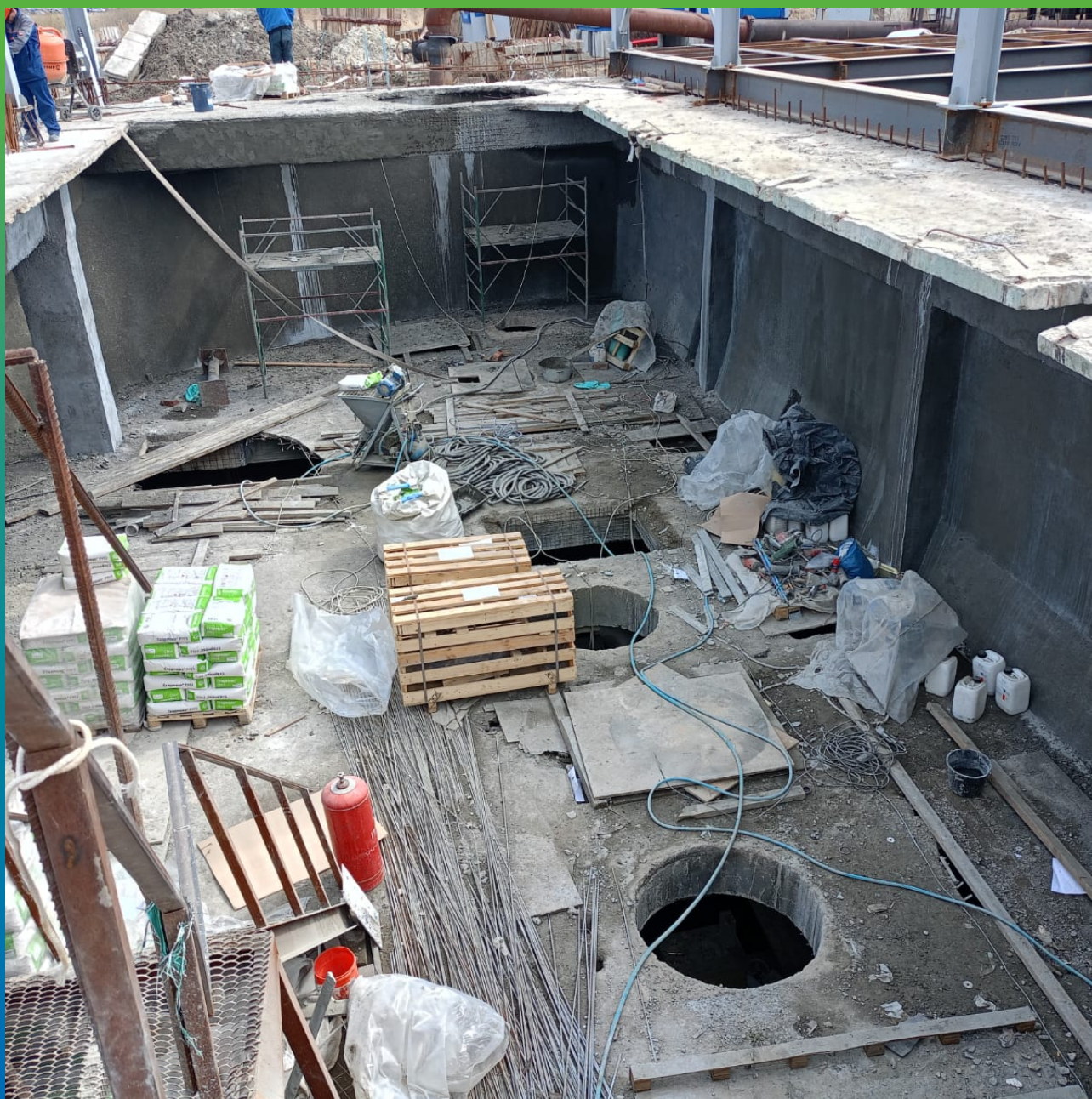
Выполненный участок материалами Гидрозо
