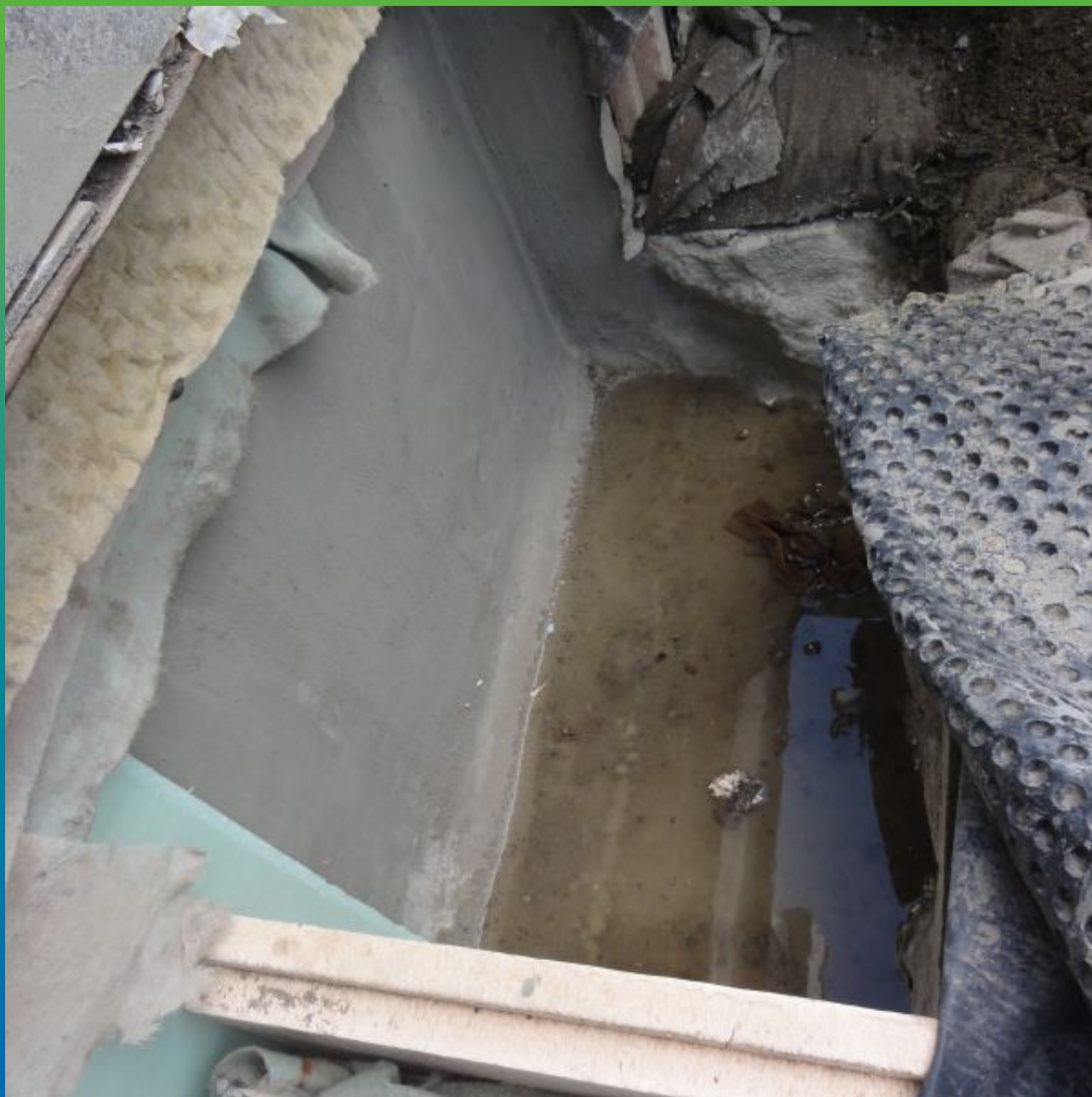
Финальный вид перед восстановлением благоустройства
