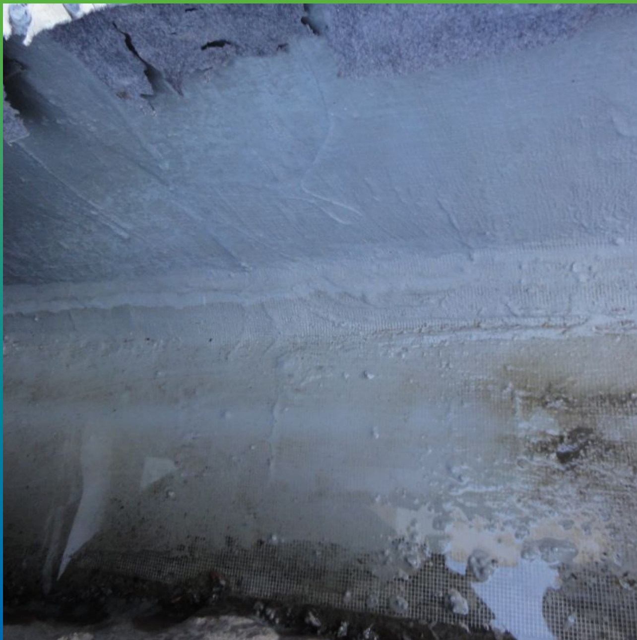
Пробное нанесение Максил Флекс через стеклосетку
