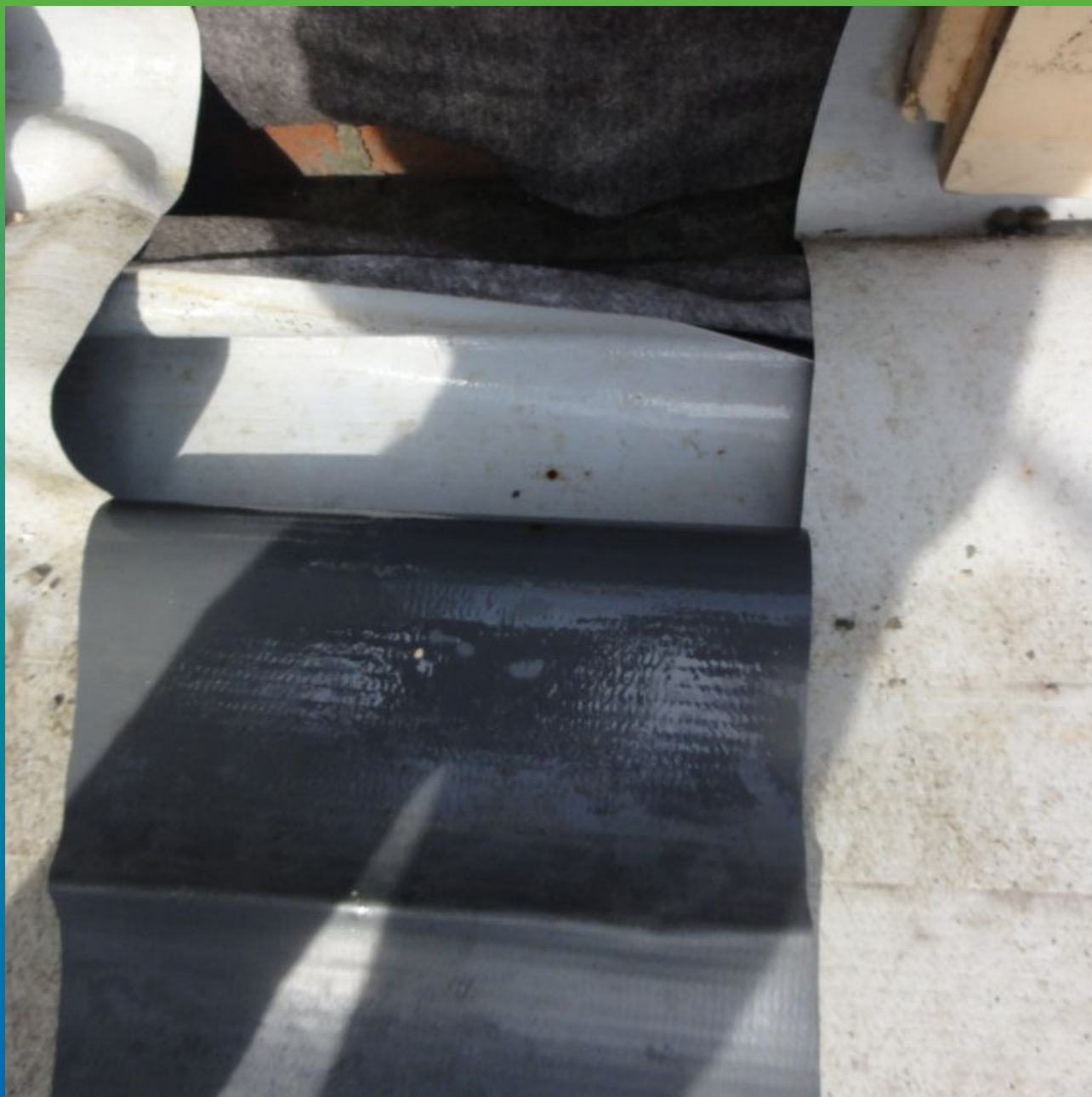
Вскрытие ПВХ мембраны
