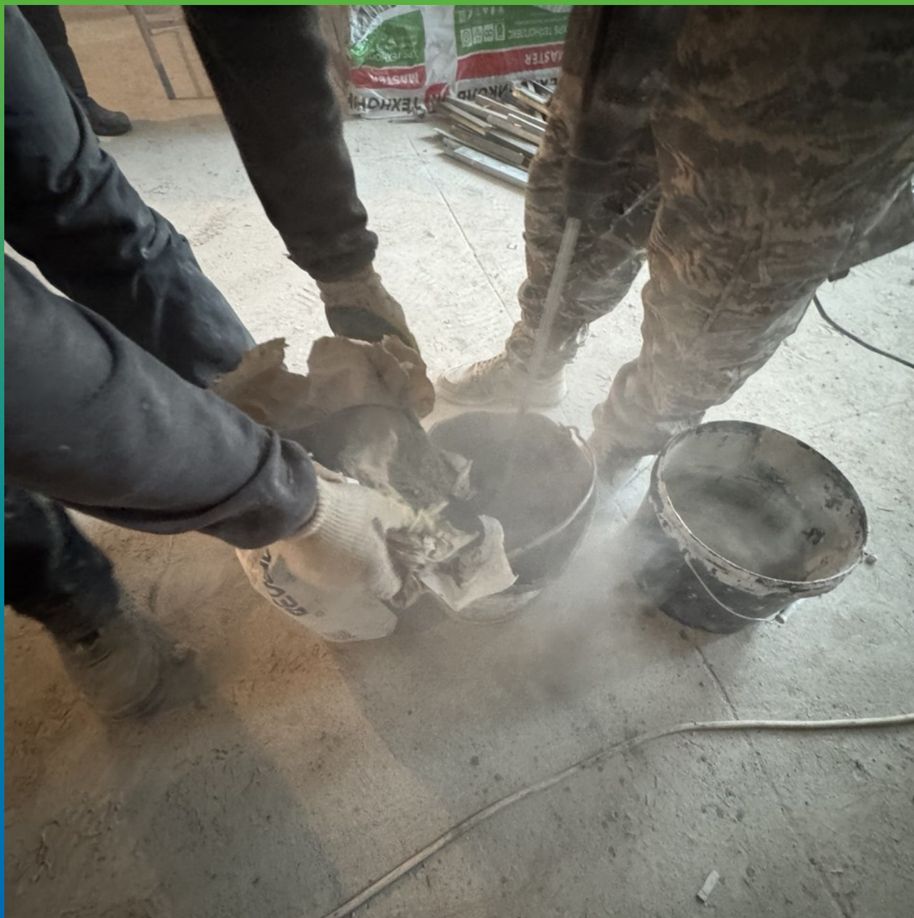
Замешивание состава Стармекс РМ Супер с водой в соотношении согласно ТО
