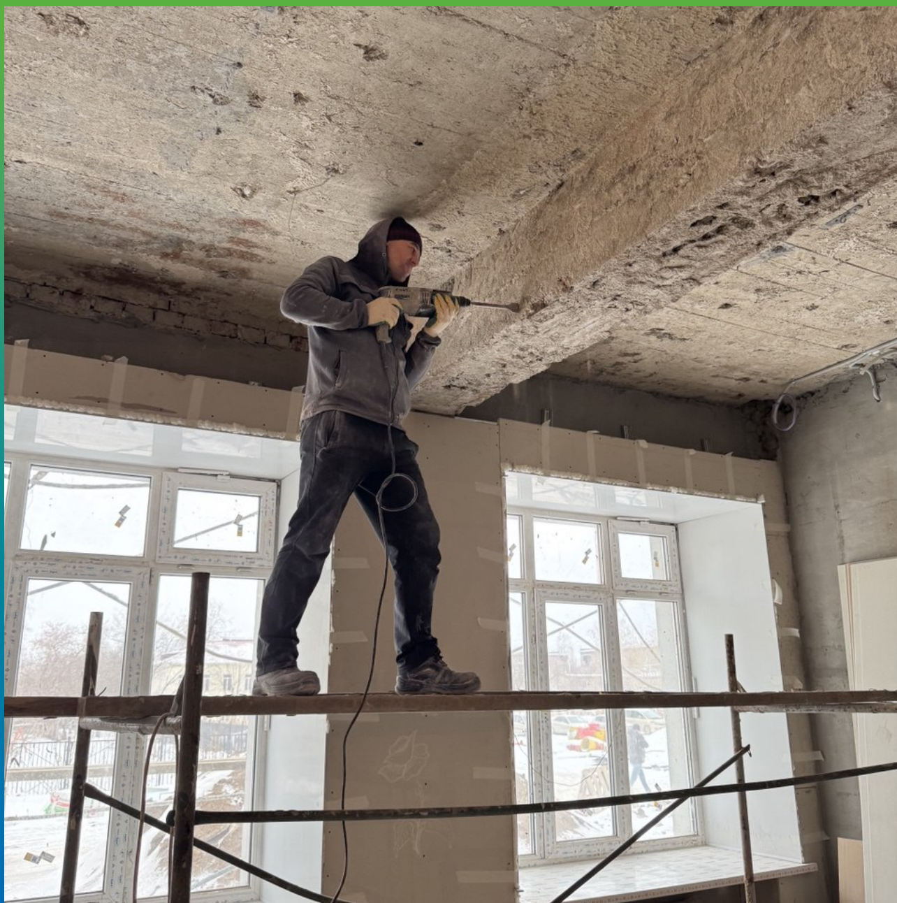
Зачистка конструкции от структурно не прочного основания
