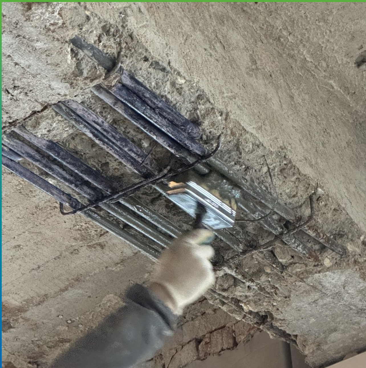
Обеспыливание и грунтование Маногард 133 Фер
