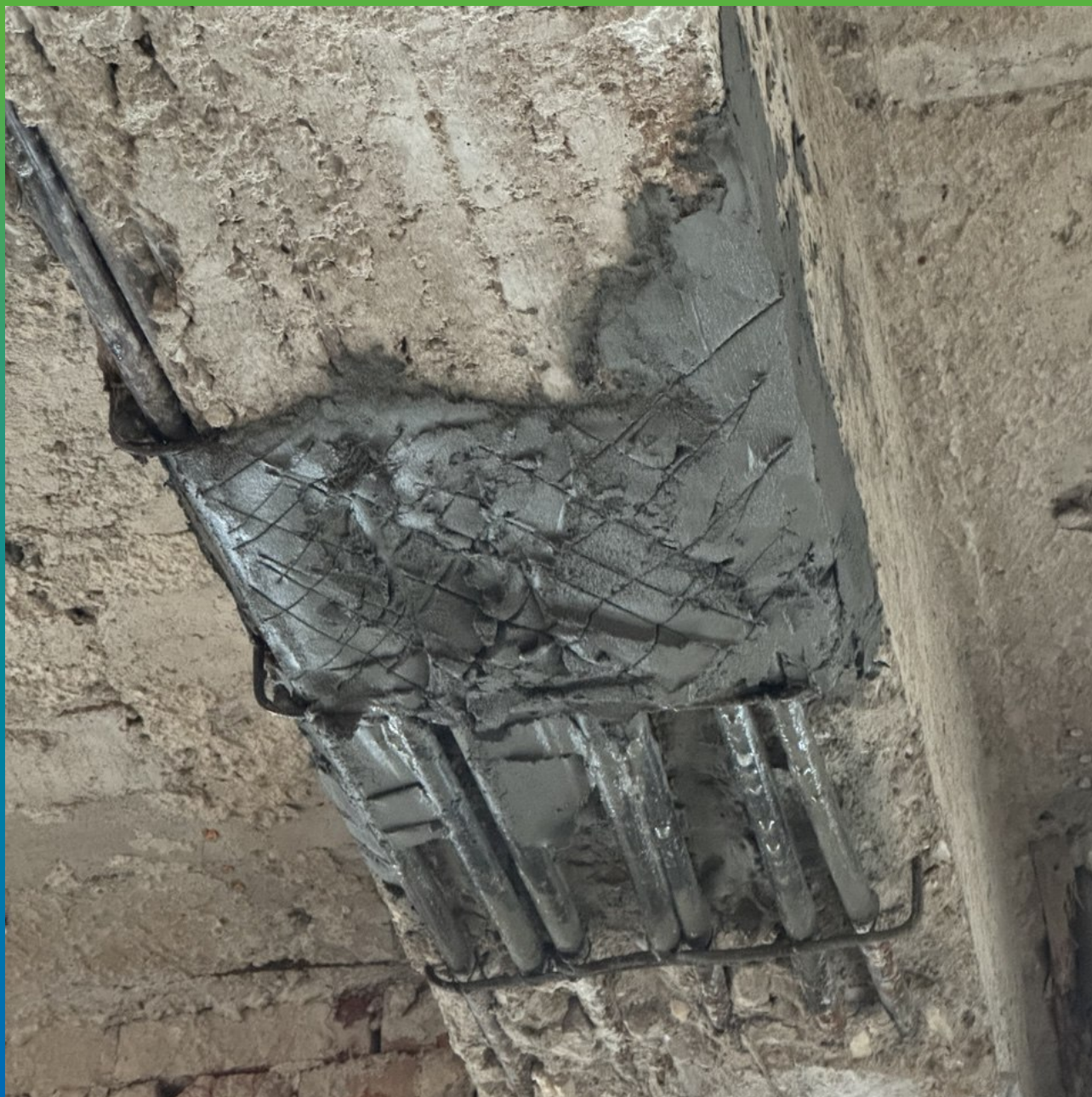
Нанесение насечек перед следующим слоем ремонтного состава
