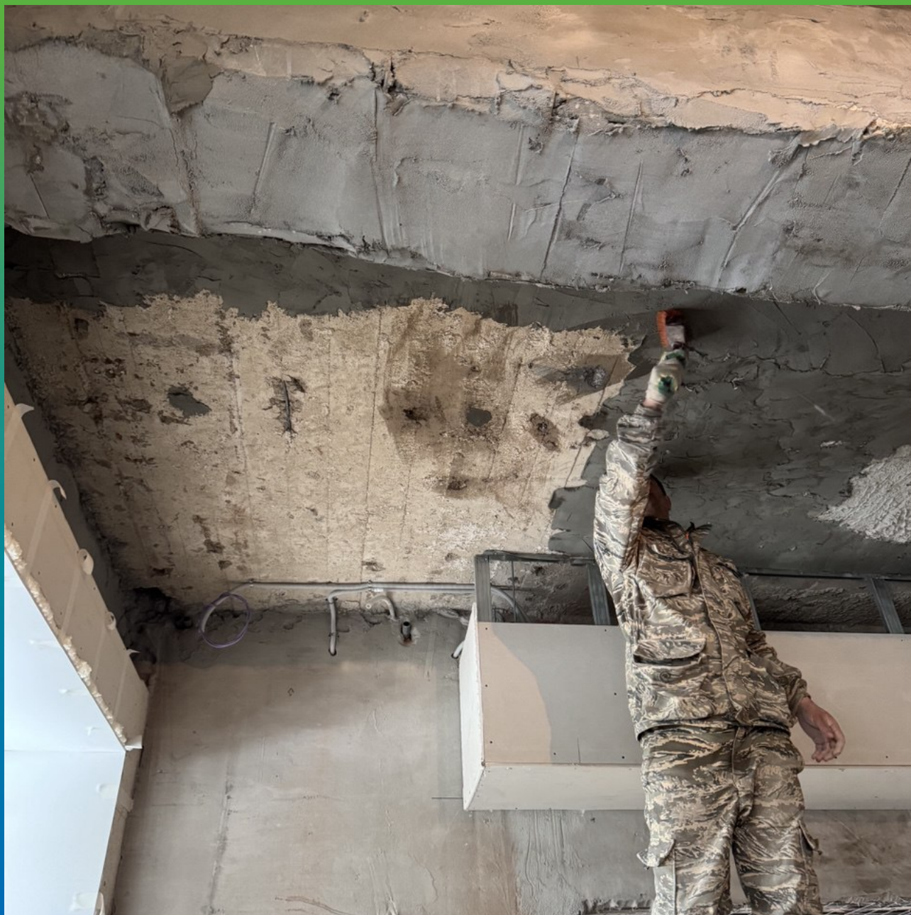
Нанесение ремонтного состава Стармекс РМ Супер на площадь плит перекрытия
