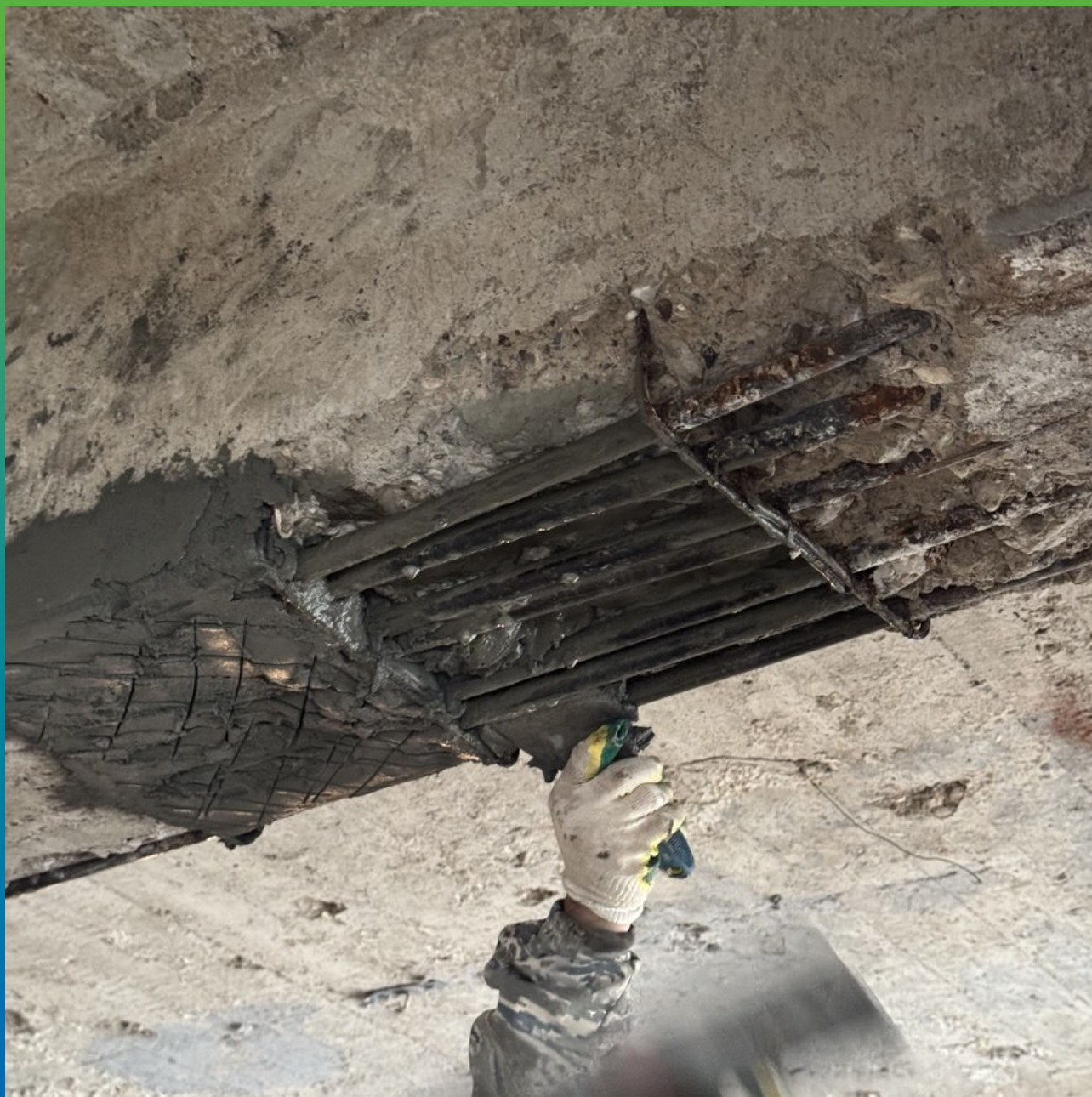
Нанесение смеси Стармекс РМ Супер на вертикальный участок (восстановление геометрии балки)
