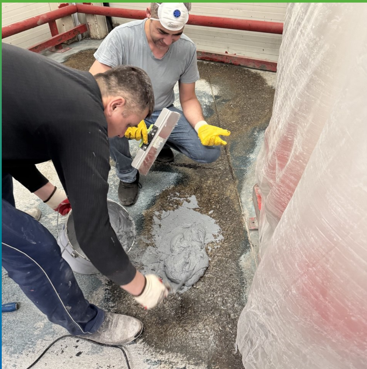
Укладка Манопокс 331 на ремонтируемые участки
