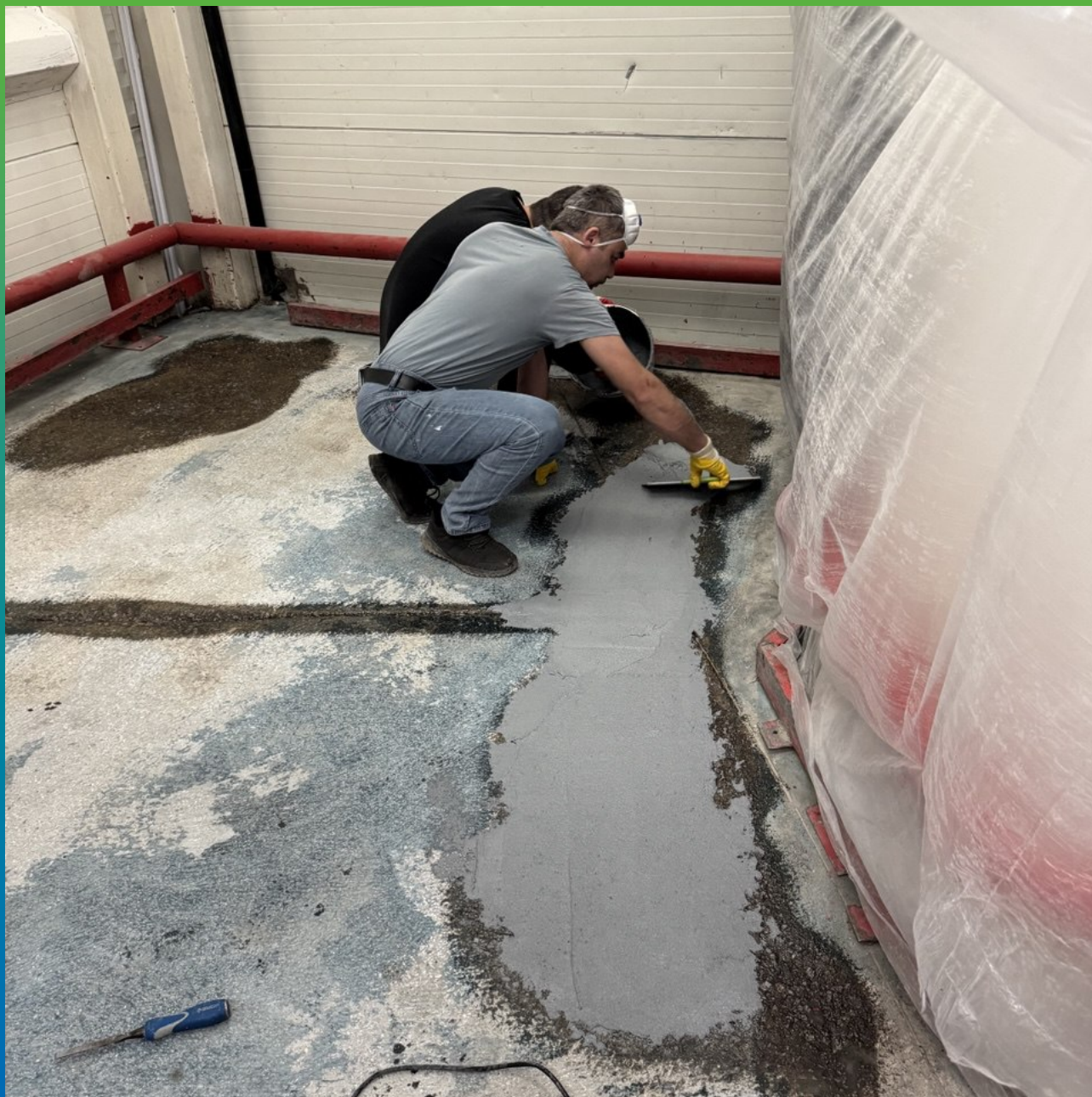
Распределение и выравнивание состава Манопокс 331 по площади ремонта. Общий вид
