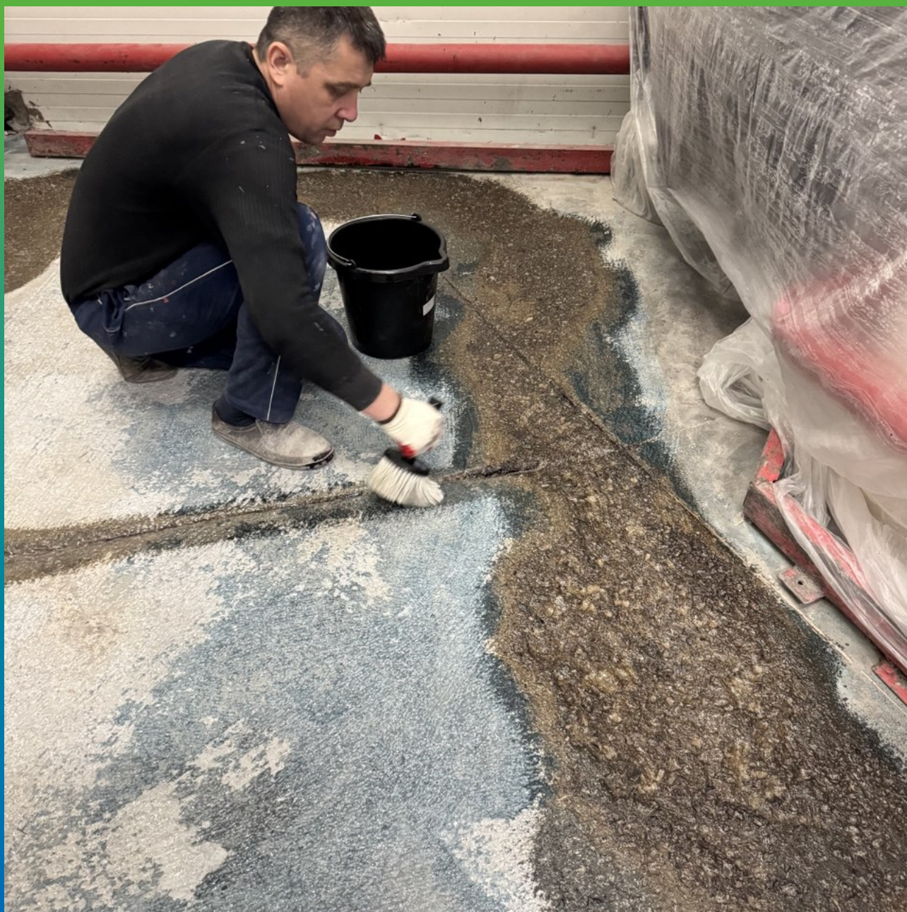
Нанесение грунта Денстоп ЭП 106 на ремонтируемое основание. Другой ракурс
