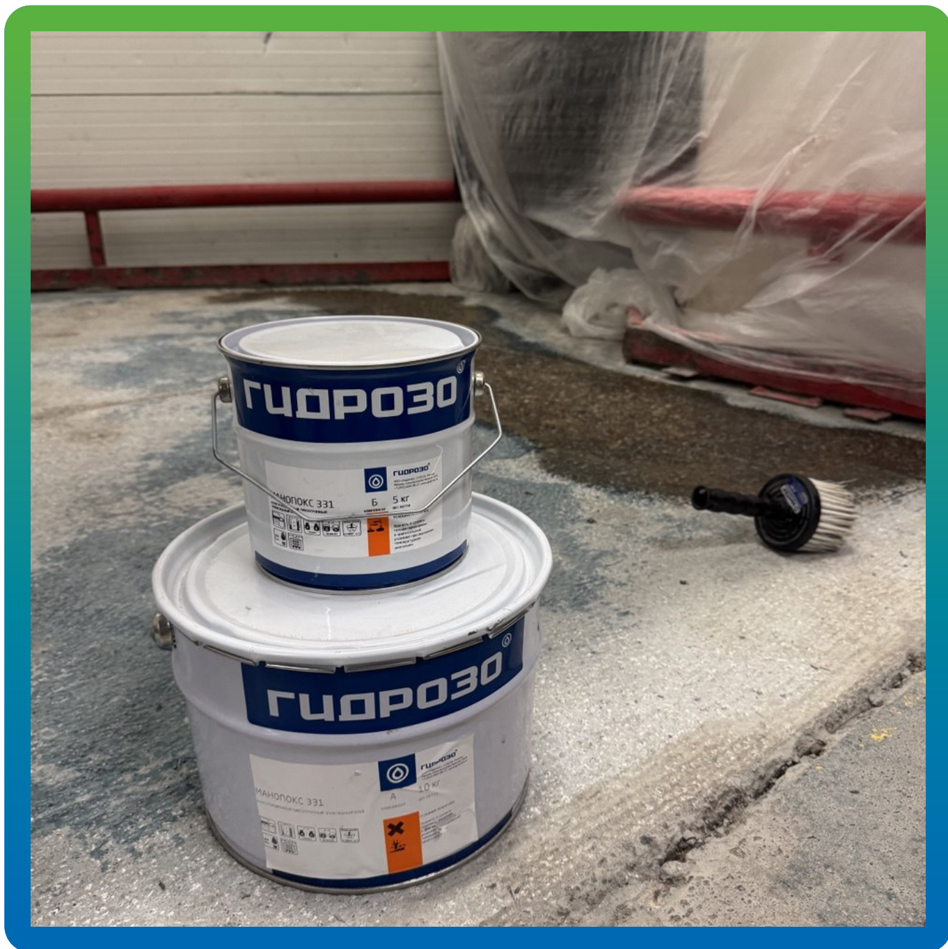
Материал Манопокс 331 на площадке
