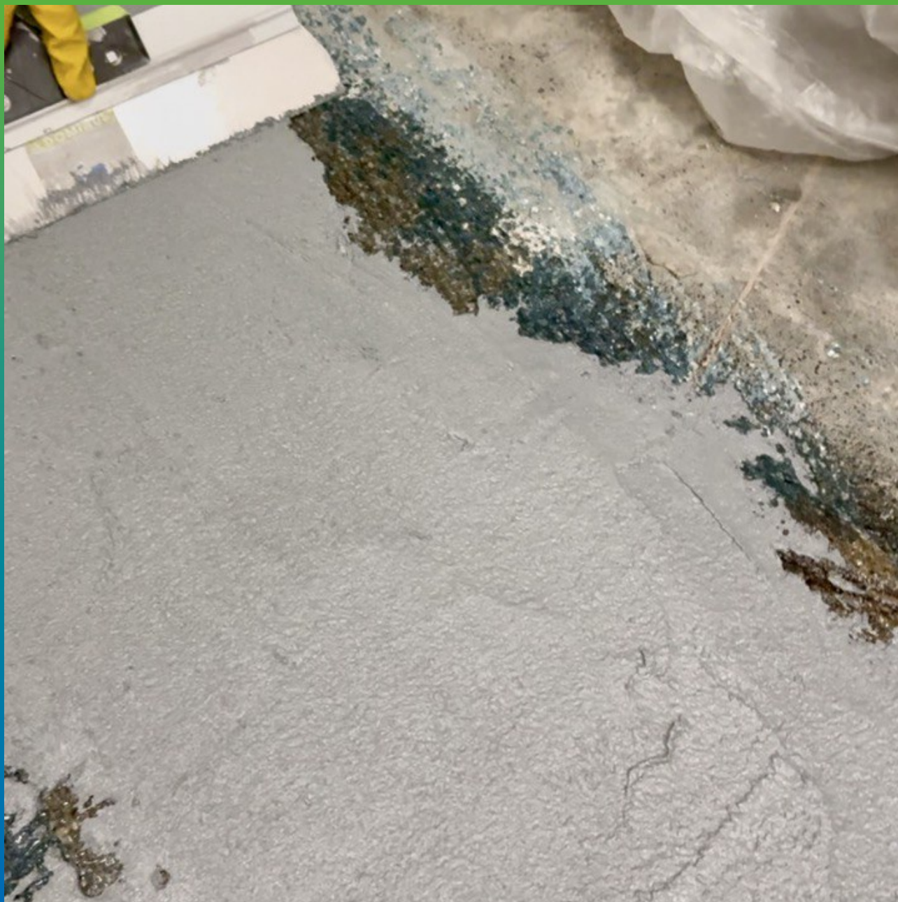
Распределение и выравнивание состава Манопокс 331 по площади ремонта
