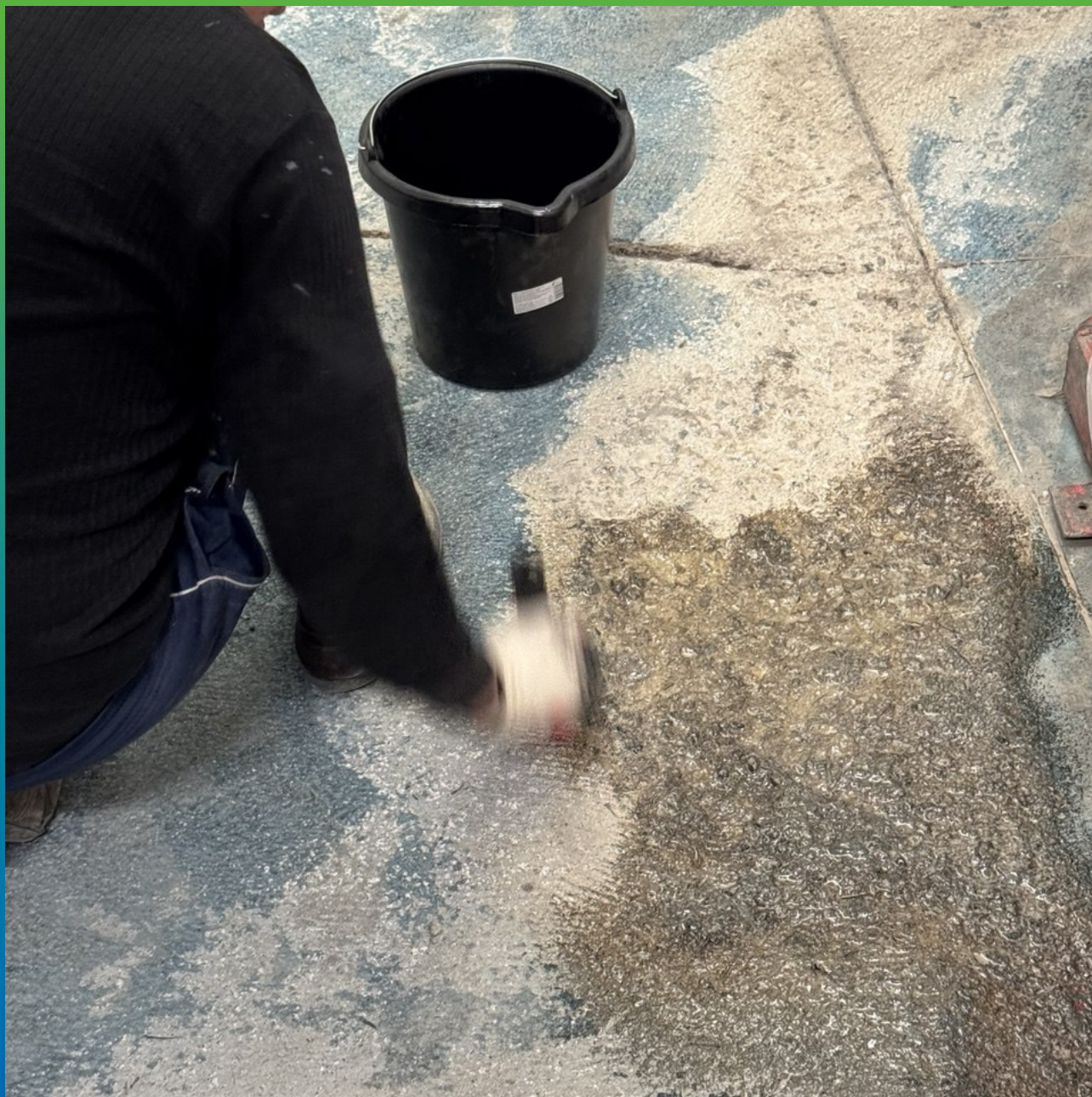
Нанесение грунта Денстоп ЭП 106 на ремонтируемое основание
