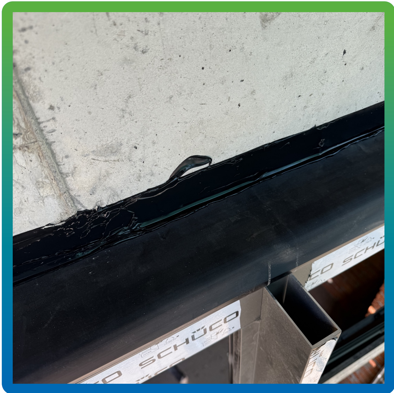
ЭПДМ мембрана, приклеенная к основанию герметиком Манодил Бонд Ф
