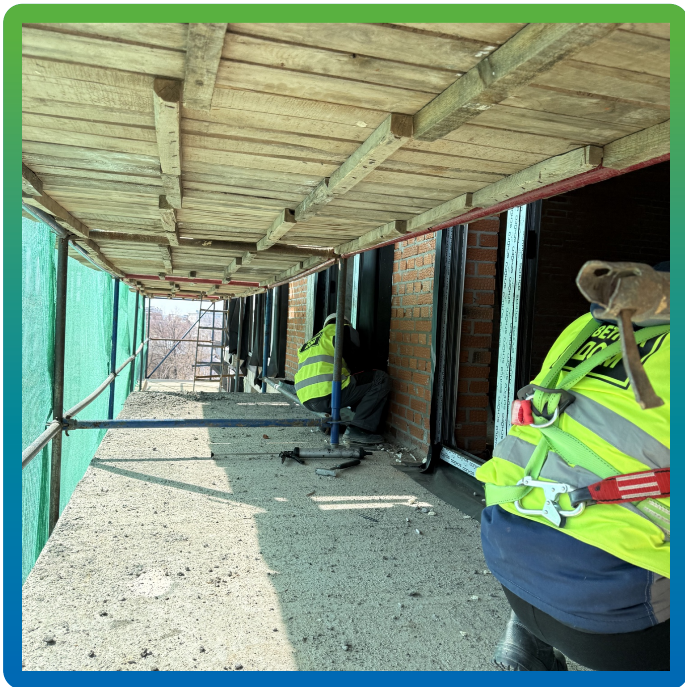
Процесс нанесения герметика Манодил Бонд Ф
