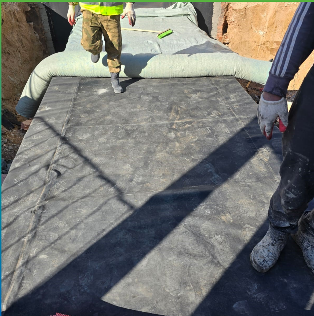
Защита уложенной мембраны геотекстилем
