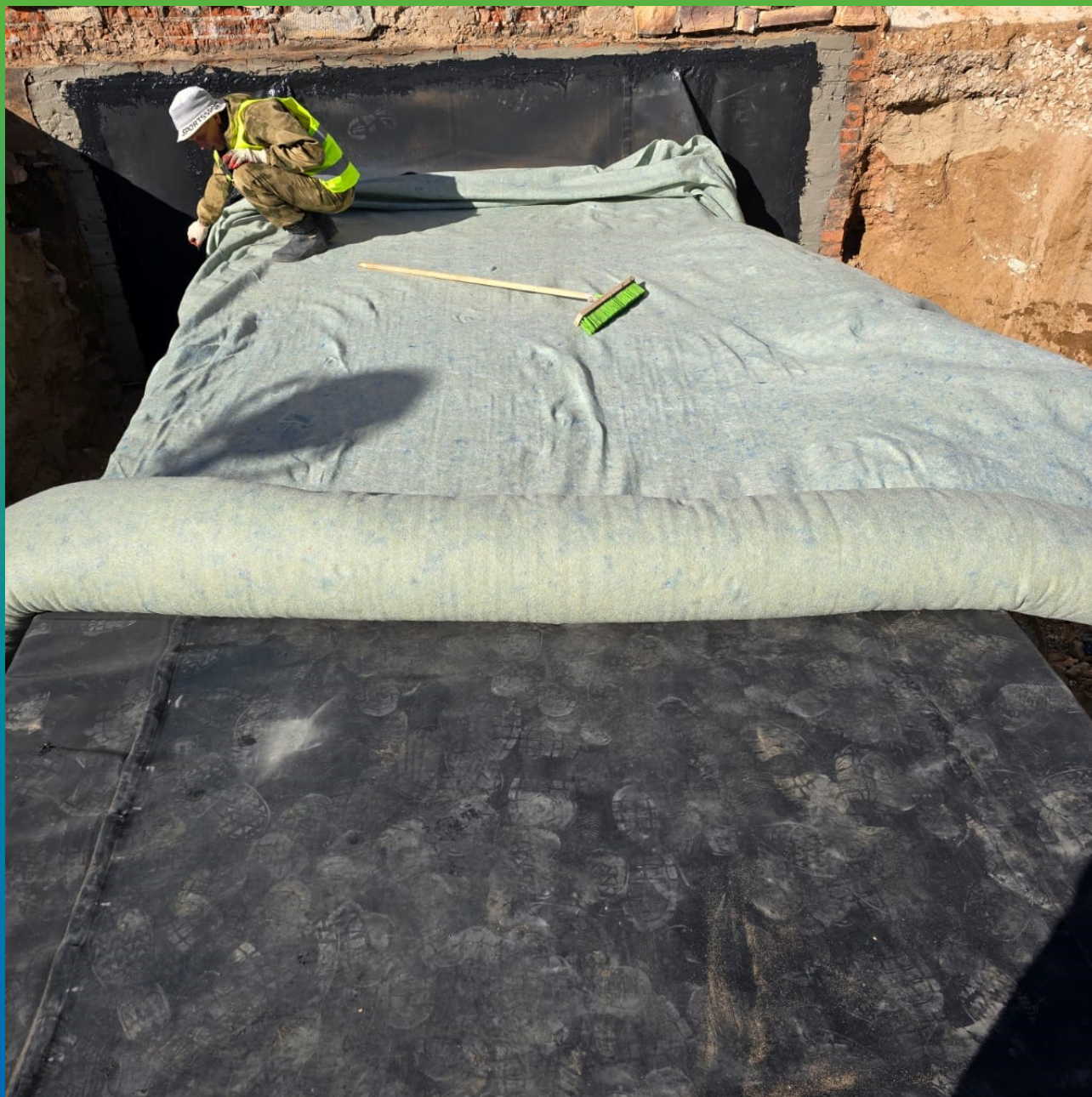
Защита уложенной мембраны геотекстилем
