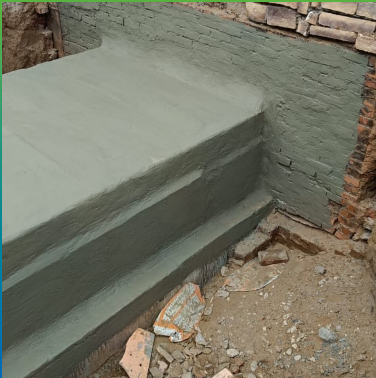
Обмазка гидроизоляционным составом Стармекс Сил Флекс
