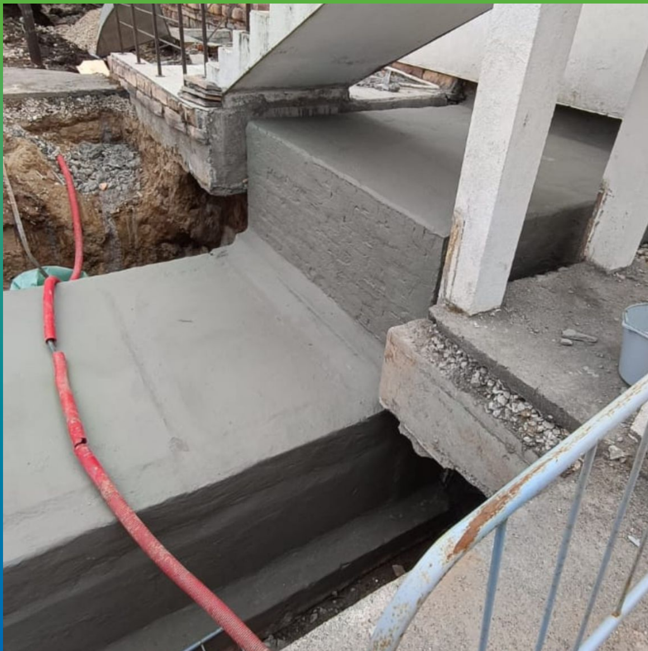
Обмазка гидроизоляционным составом Стармекс Сил Флекс в 2 слоя
